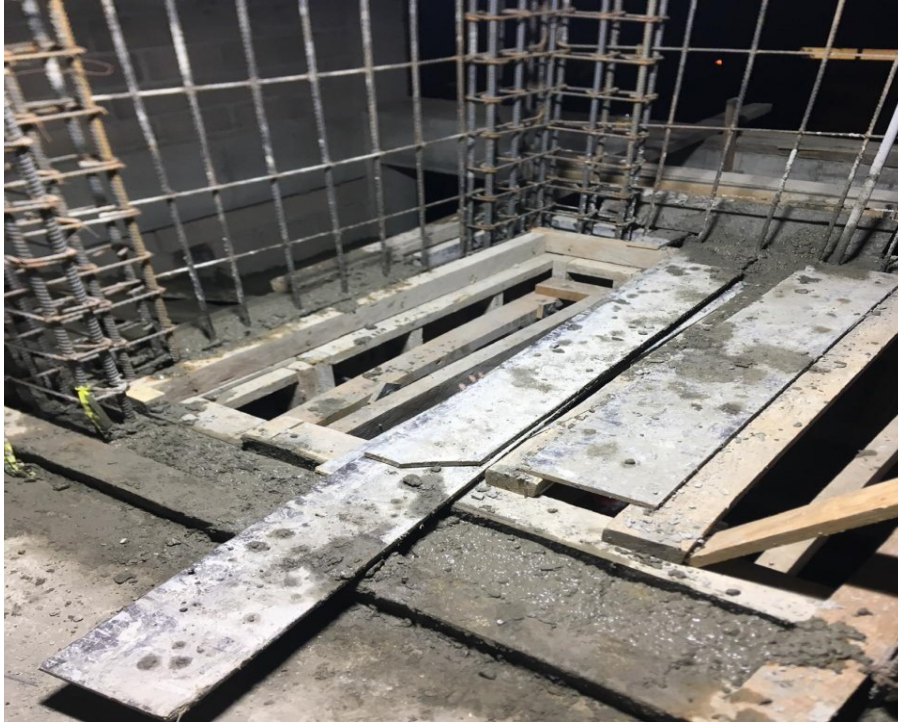
Ilustración 10: Armado de hierro listo para encofrar
