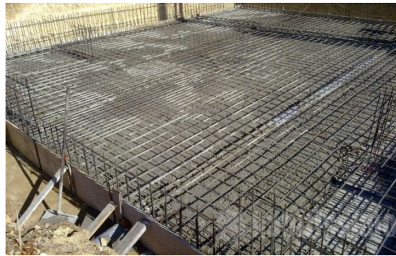
Ilustración 6: Losa de cimentación - Elemento plano
