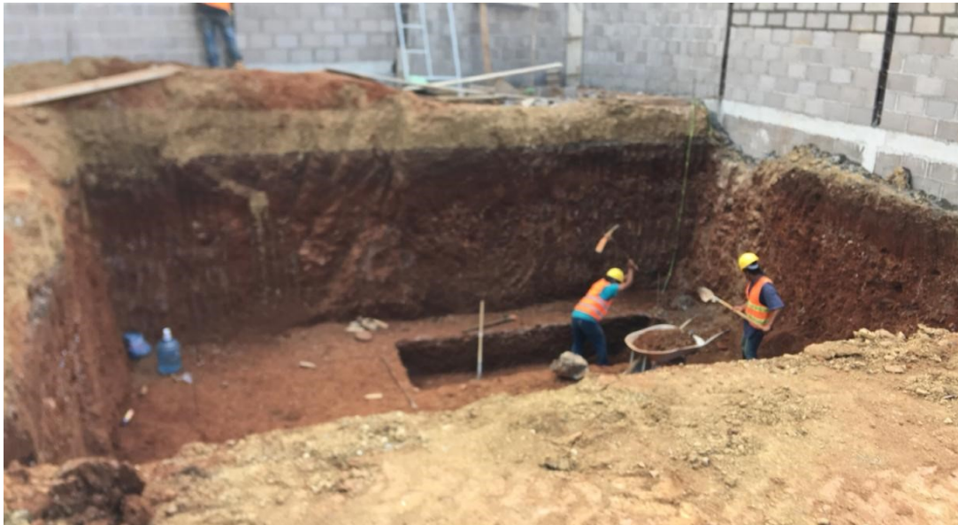
Ilustración 15: Excavación para cisterna
