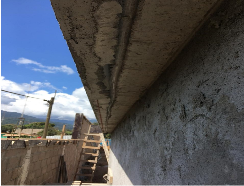
Ilustración 12: Inspección de calidad de obra
