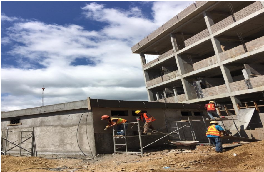
Ilustración 11: Proceso de repello y pulido en pared
