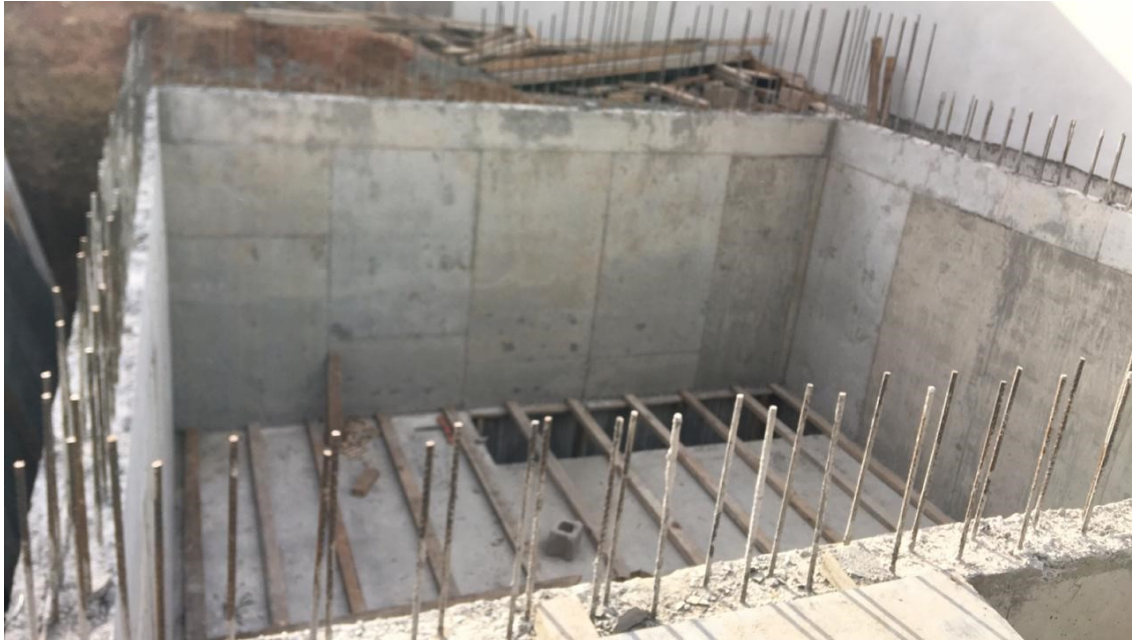
Ilustración 16: Cisterna desencofrada
