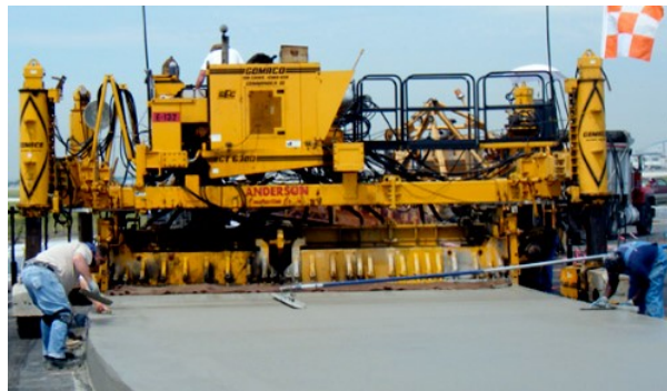
Ilustración 8: Construcción de pavimento de concreto con equipo de alto rendimiento
