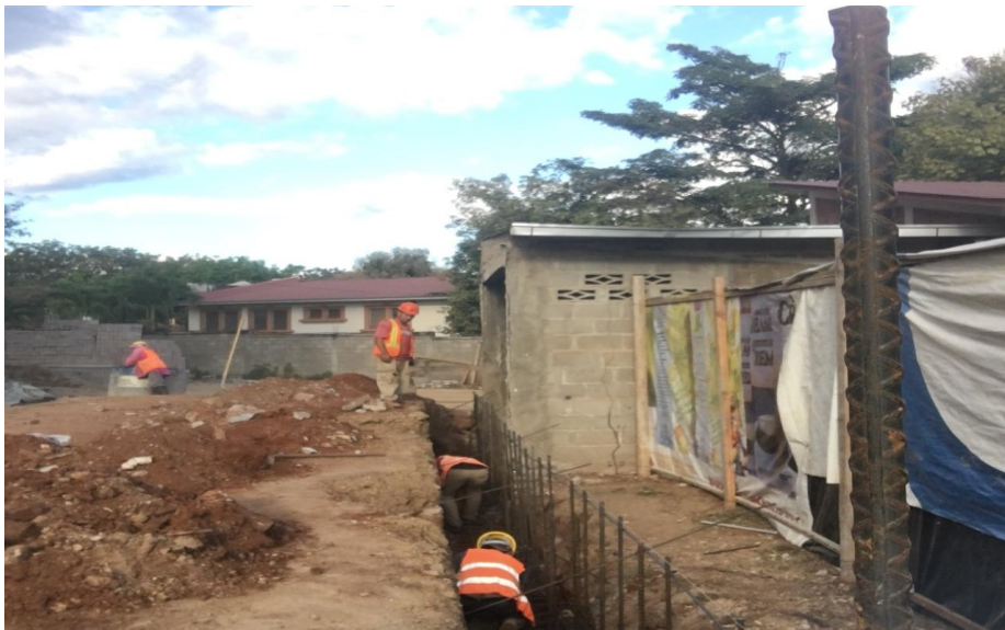
Ilustración 13: Colocación de hierro en zapata corrida
