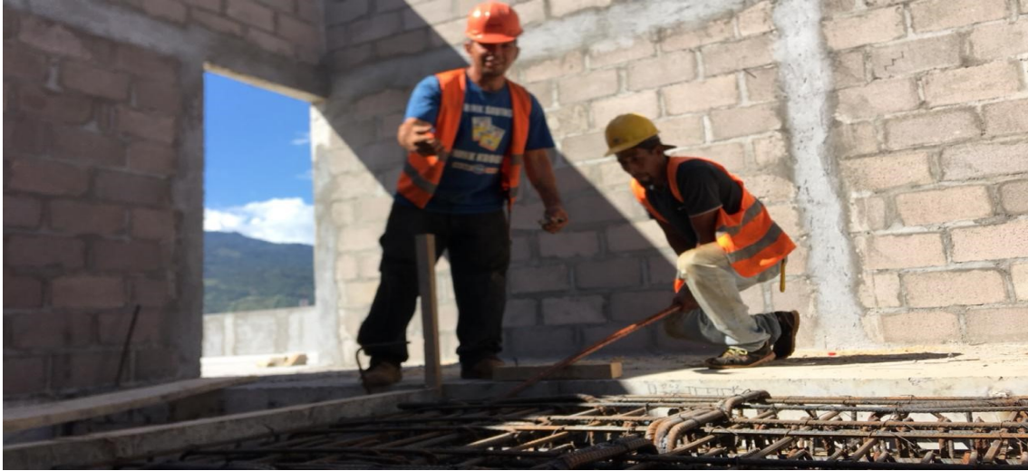
Ilustración 14: Armado de losa en muro cortante
