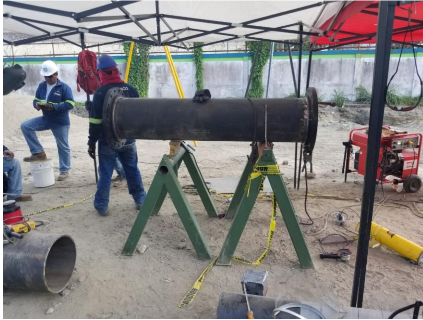
Figura 31. Pega de dos bridas a un niple de 2 metros.
