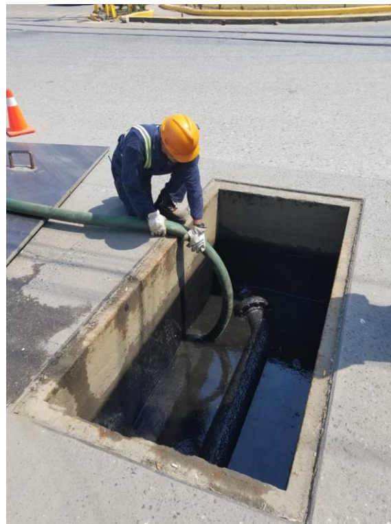
Figura 30. Achique con bomba para conocer la invertida de la tubería existente y así determinar el paso de la nueva.
