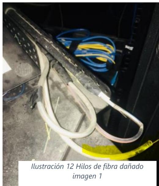
Ilustración 12 Hilos de fibra dañado imagen 1
