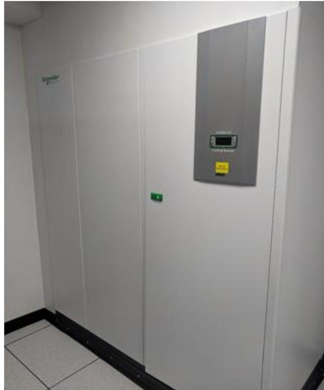
*Ilustración 3 Aire de precisión Uniflier LE*
