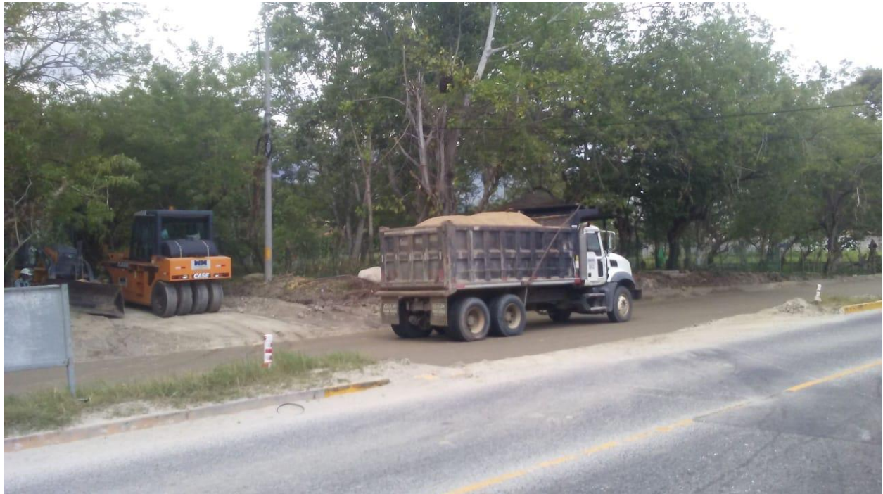
Ilustración 14-Prueba de carga en subbase
