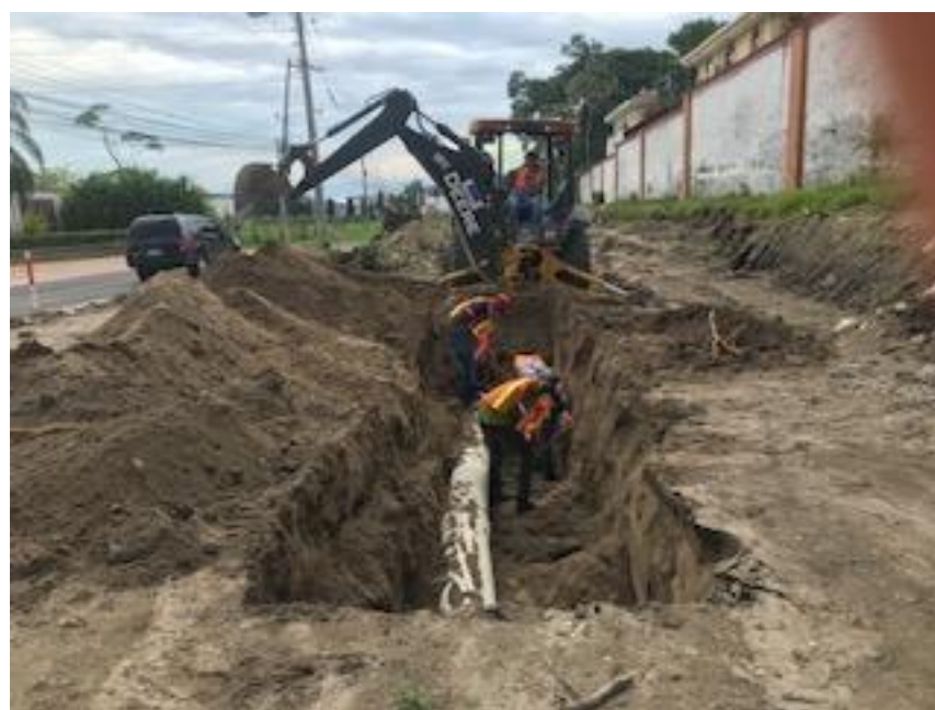
Ilustración 12-Excavación de tubo de agua potable para colocarlo más abajo
