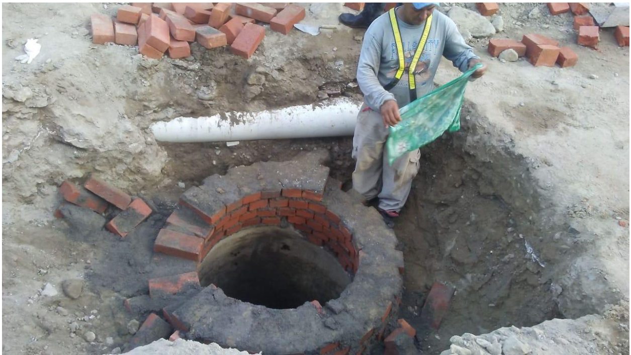
Ilustración 16-Levantamiento de pozo de aguas negras a nivel de subbase
