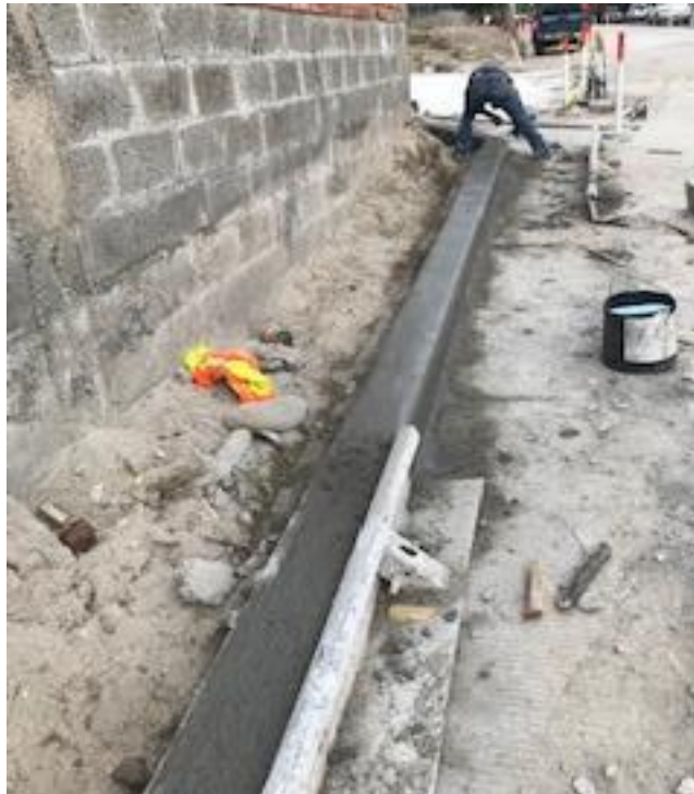
Ilustración 19-Fundición de bordillos
