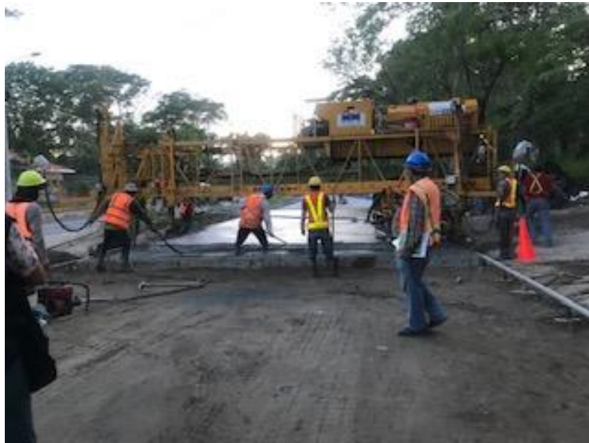
Ilustración 1-Fundición de calzada lado izquierdo, estación 2+380
