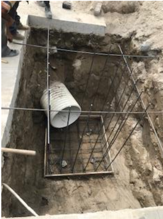
Ilustración 17-encofrado y armado de acero en tragante
