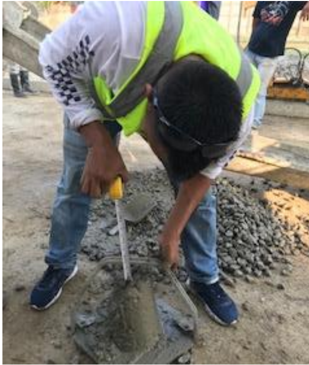
Ilustración 9-Prueba de revenimiento en concreto
