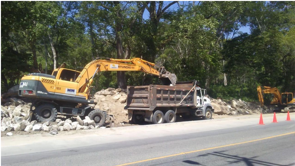
Ilustración 6-Carga de material de sitio en volqueta para trasladar a 27 calle
