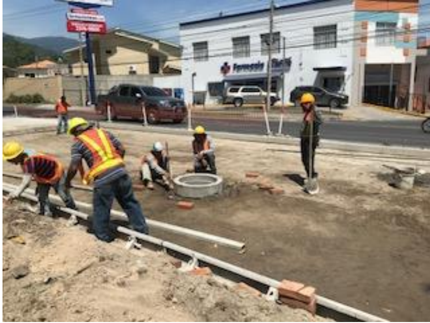
Ilustración 7-Colocación de casquete en pozo existente de aguas lluvia
