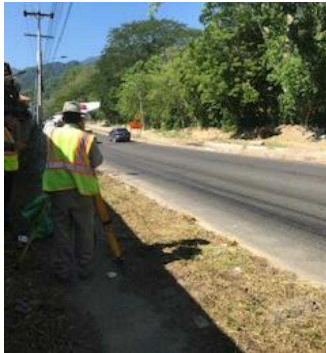
Ilustración 8-Levantamiento topográfico de derecho de vía
