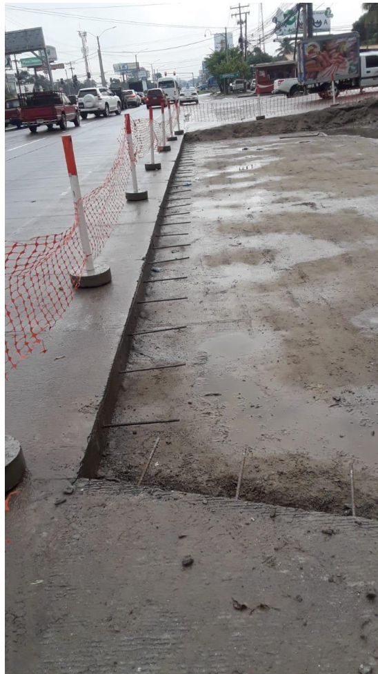
Ilustración 26-Perforacion y colocación de pines de espera
