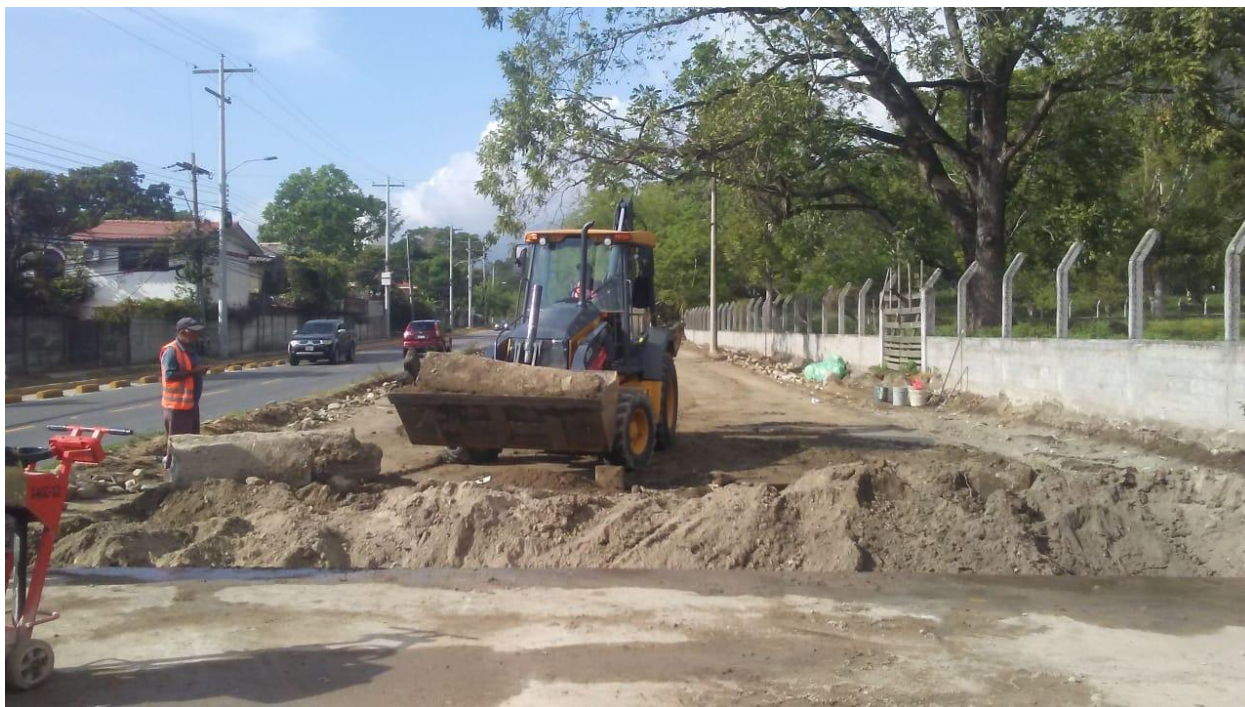
Ilustración 11-Extracción de diente de concreto
