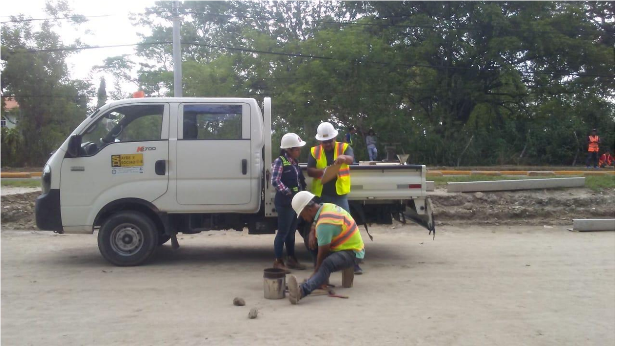
Ilustración 3-Prueba de densidad en subbase
