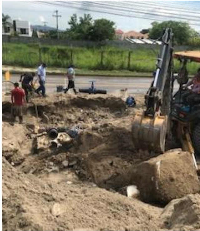
Ilustración 21-Agua de San Pedro bajando nivel de tubería de agua potable
