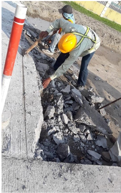
Ilustración 23-Demolicion de concreto existente en Inicio Ramal Cortés-Zapotal
