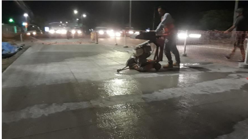
Ilustración 25-Corte de juntas transversales en Ramal Cortés-Zapotal
