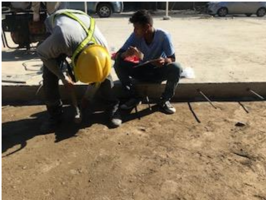
Ilustración 18-Colocación de pines de espera
