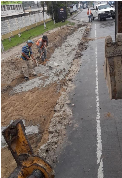
Ilustración 24-Mezcla de Suelo-Cemento
