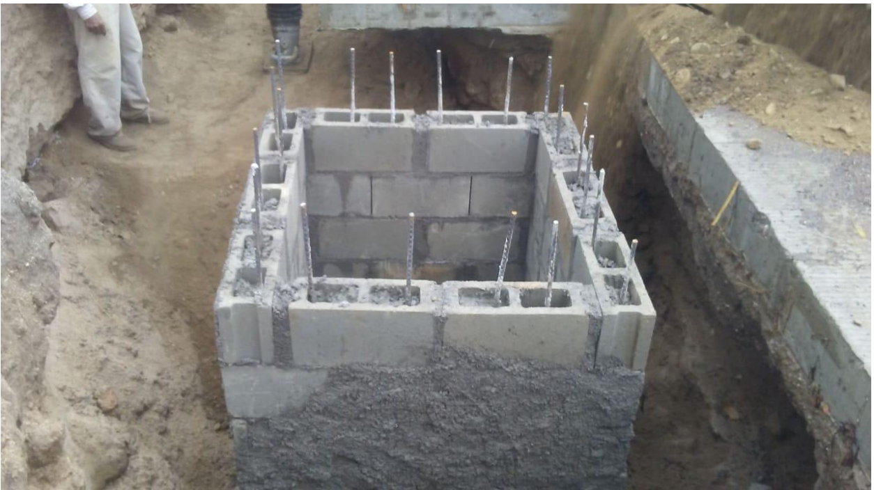
Ilustración 4-Construcción de tragante frente a Panistro
