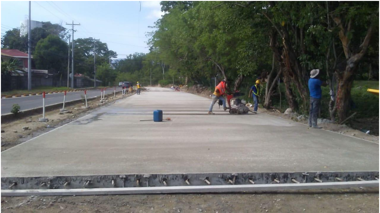
Ilustración 5-Corte de pastillas en losa de pavimento
