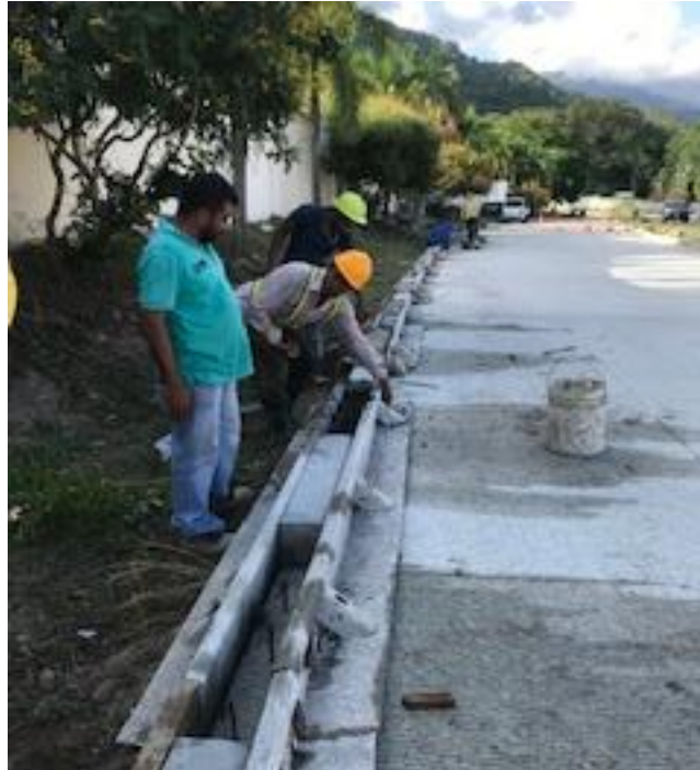
Ilustración 22-Encofrado y fundición de bordillos
