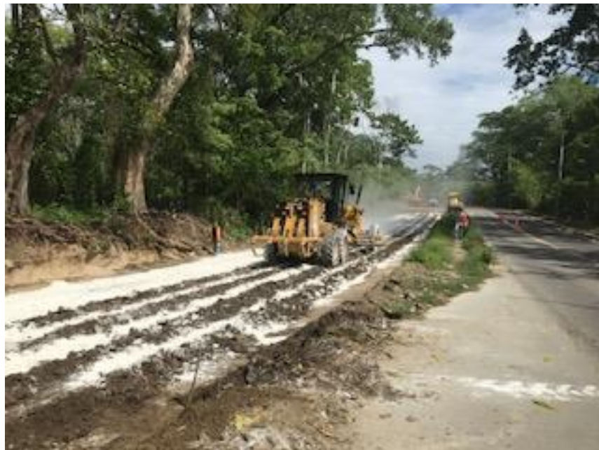
Ilustración 2-Mezclado de cal en material relleno existente
