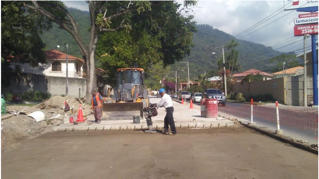
Ilustración 15-Compactación de subbase con bailarina
