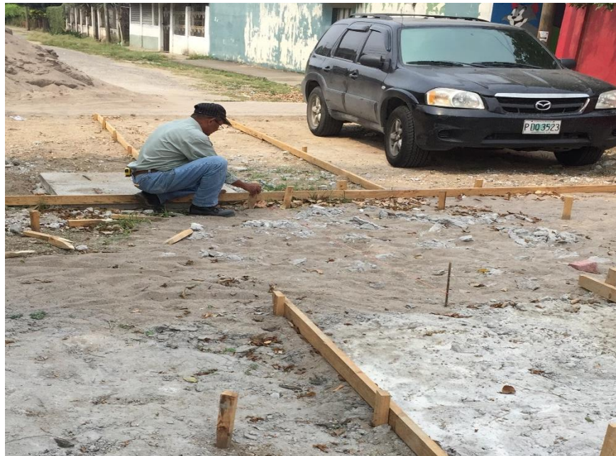
Ilustración 15. Marcaje de terreno
