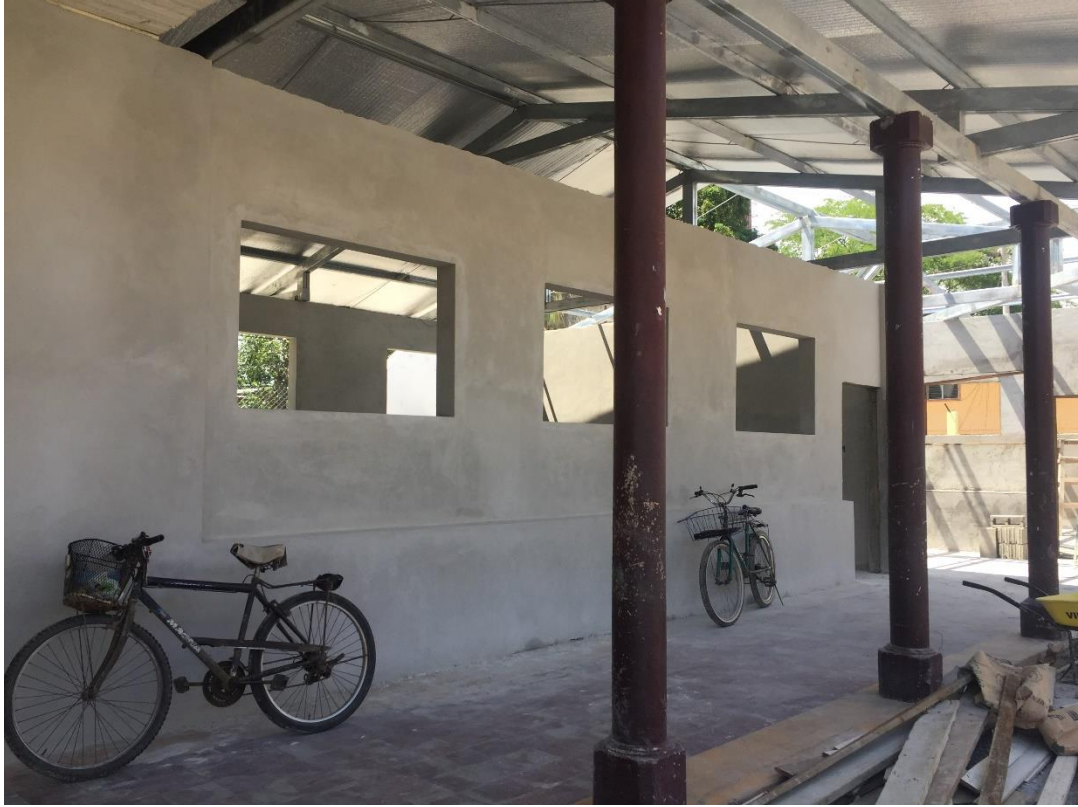
Ilustración 24. Pulido en paredes interiores
