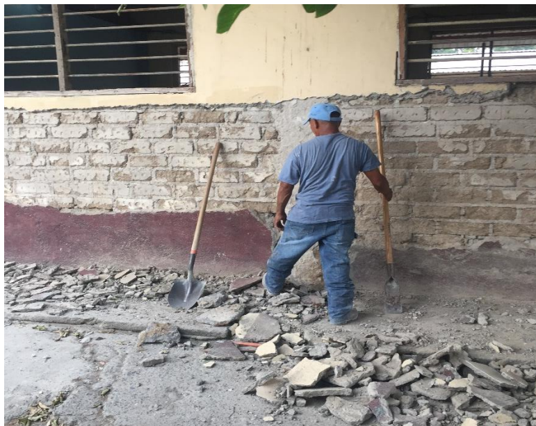
Ilustración 17. Picado de paredes exteriores
