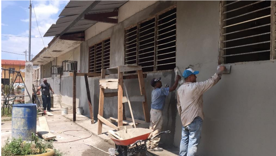
Ilustración 14. Pulido de paredes
