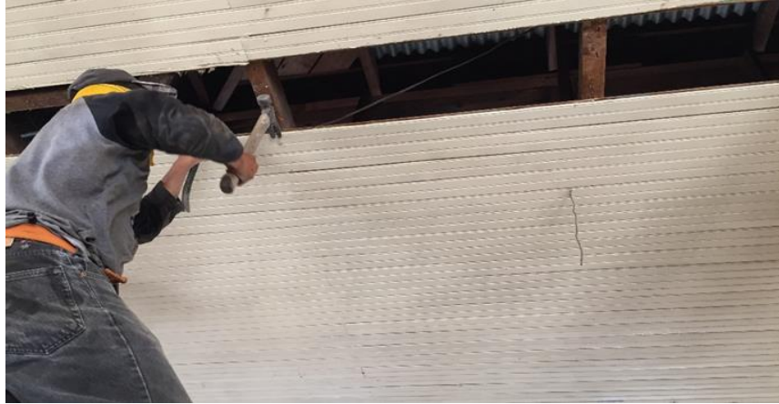
Ilustración 4. Desmantelamiento de techo
