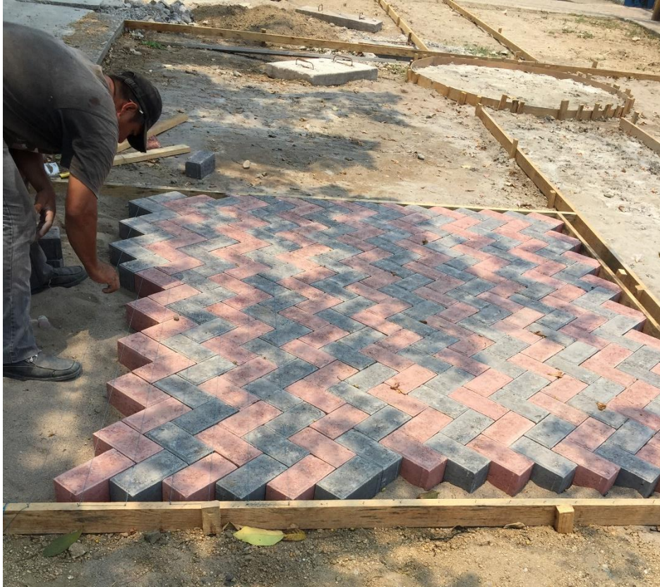
Ilustración 20. Colocación de adoquines
