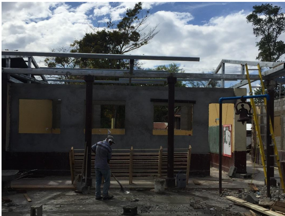
Ilustración 23. Colocación de estructura metálica
