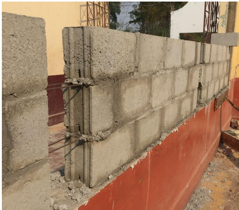
Ilustración 21. Colocación de varilla de temperatura
