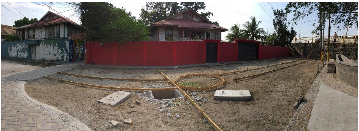
Ilustración 19. Marcaje de terreno proyecto Camino de Los Gatos
