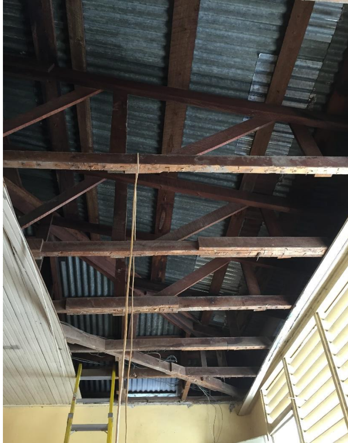
Ilustración 18. Desmantelamiento de techo
