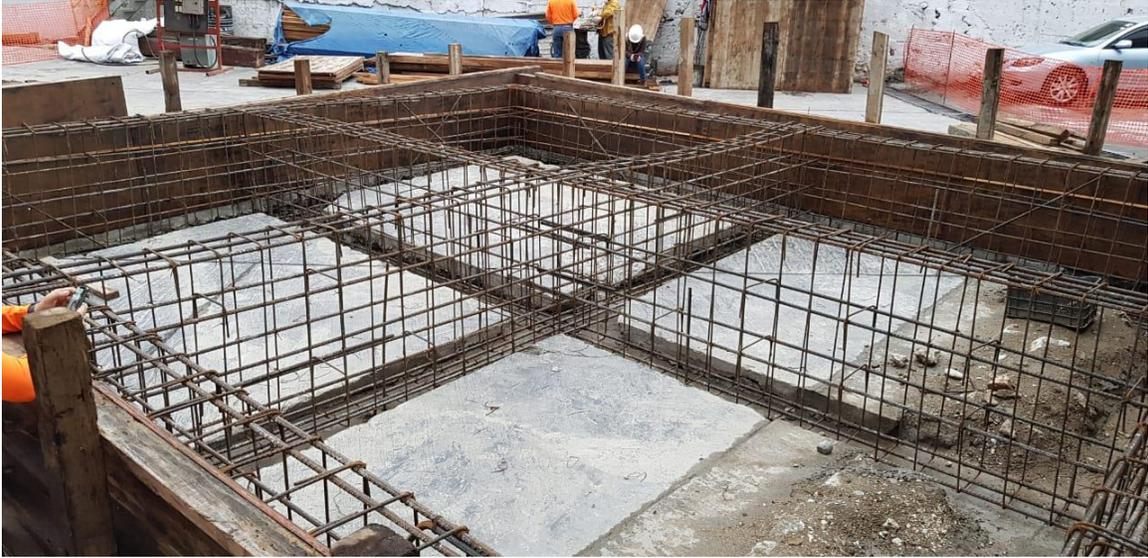
**Ilustración 6 Encofrado para traves de cimentación**
