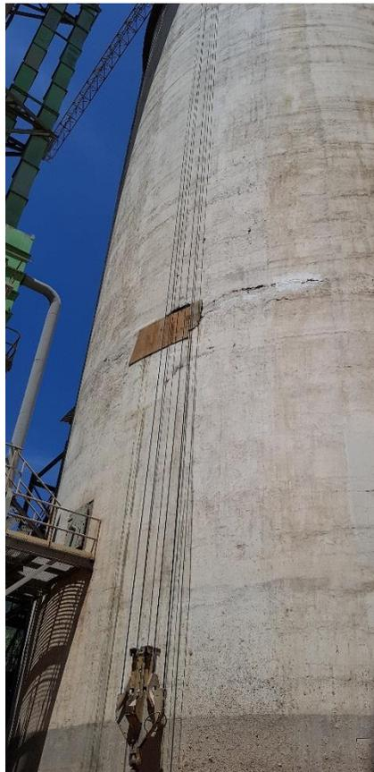
**Ilustración 25 Reparación de Fisura en silo de concreto**
