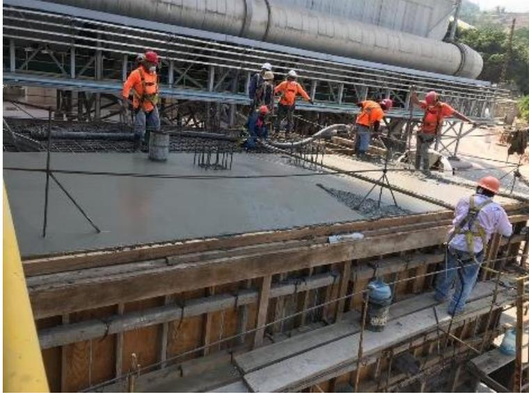
**Ilustración 16 Fundición de losa superior**
