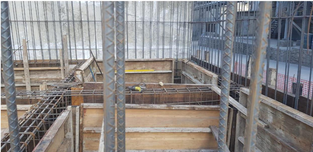
**Ilustración 9 Encofrado interno de trabes de cimentación**
