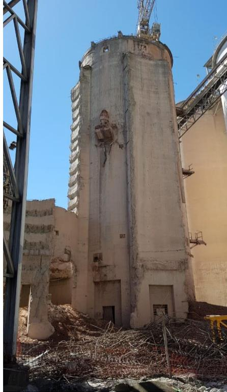
**Ilustración 18 Demolición de silo de concreto**
