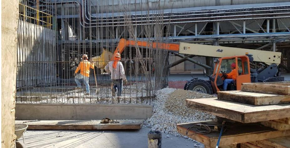
**Ilustración 10 Relleno con material rocoso**
