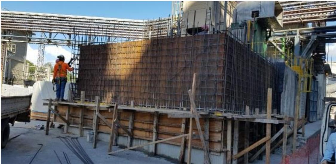
**Ilustración 13 Encofrado de paredes**
