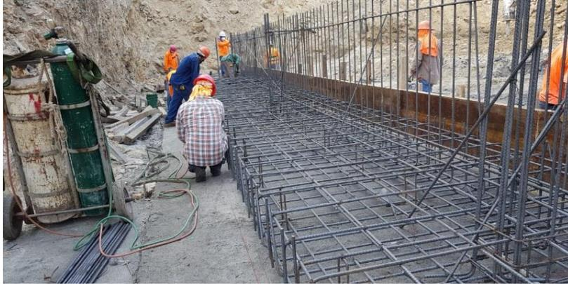
**Ilustración 20 Armado de Cimentación de muro de contención**
