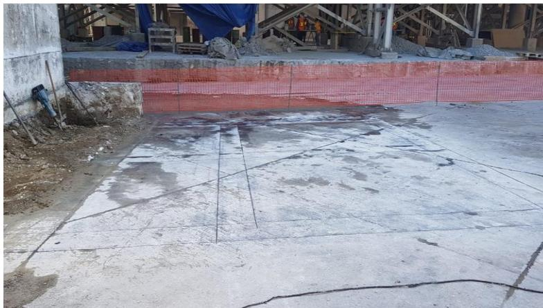
**Ilustración 5 Corte de pavimento para traveses de cimentación**
