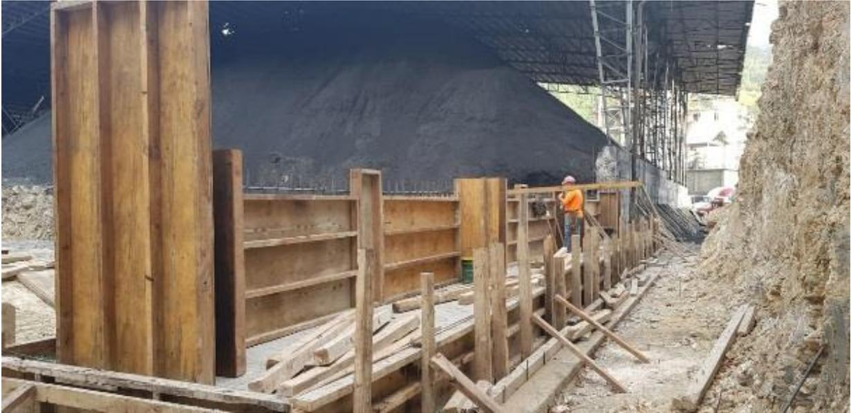
**Ilustración 22 Encofrado de pantalla de muro**
