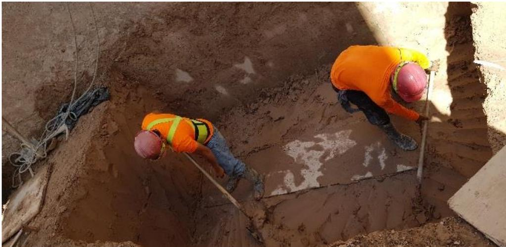
**Ilustración 19 Extracción de material de silo de concreto**
