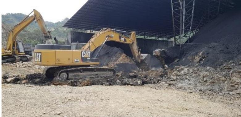
**Ilustración 24 Retro 349D abriendo tramo para muro**
