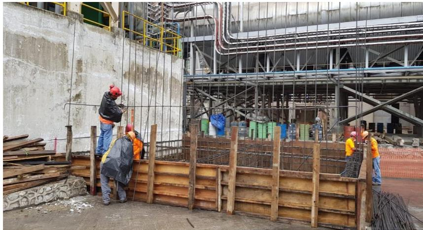
**Ilustración 7 Colocación de acero para paredes del tanque de agua**
