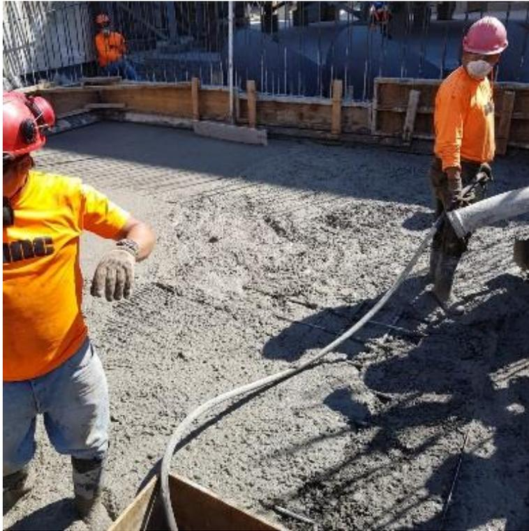
**Ilustración 12 Fundición de Losa**
