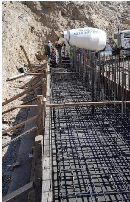
**Ilustración 21 Fundición de Zapata de muro de contención**
