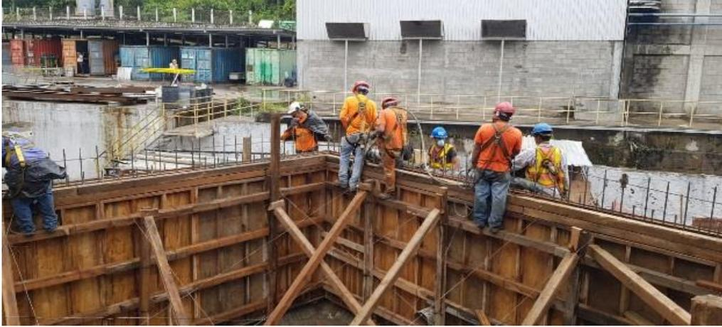
**Ilustración 14 Fundición de Paredes**
