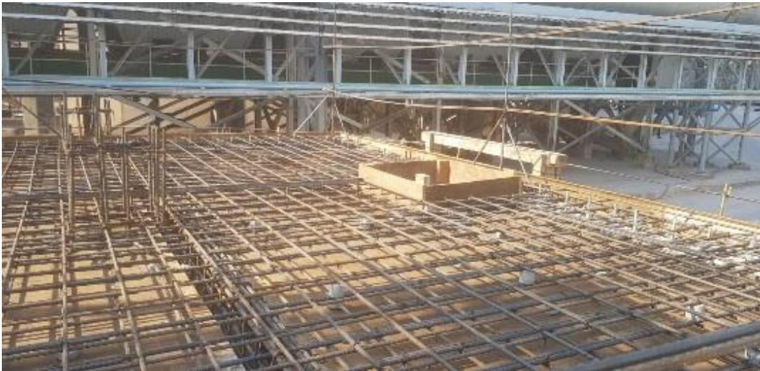
**Ilustración 15 Armado de losa superior**
