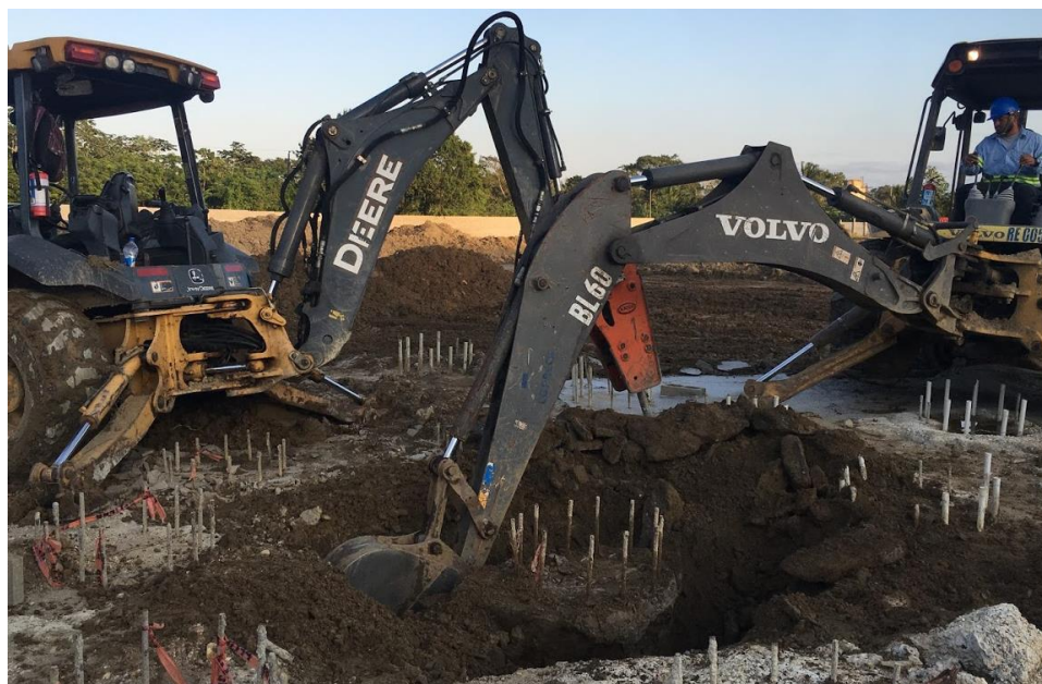
Ilustración 18. Excavación para descubrir pilotes previos a descabezado
