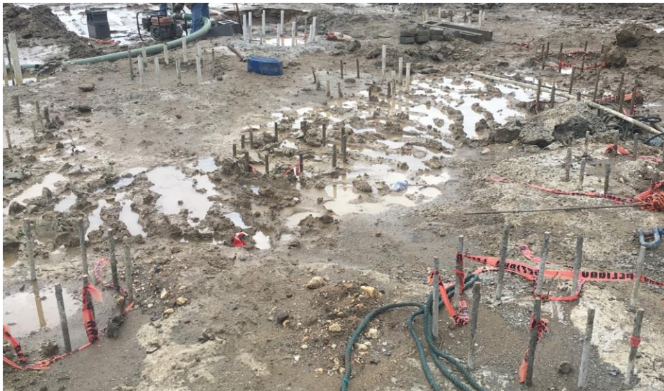
Ilustración 9. Pilotes fundidos in situ
