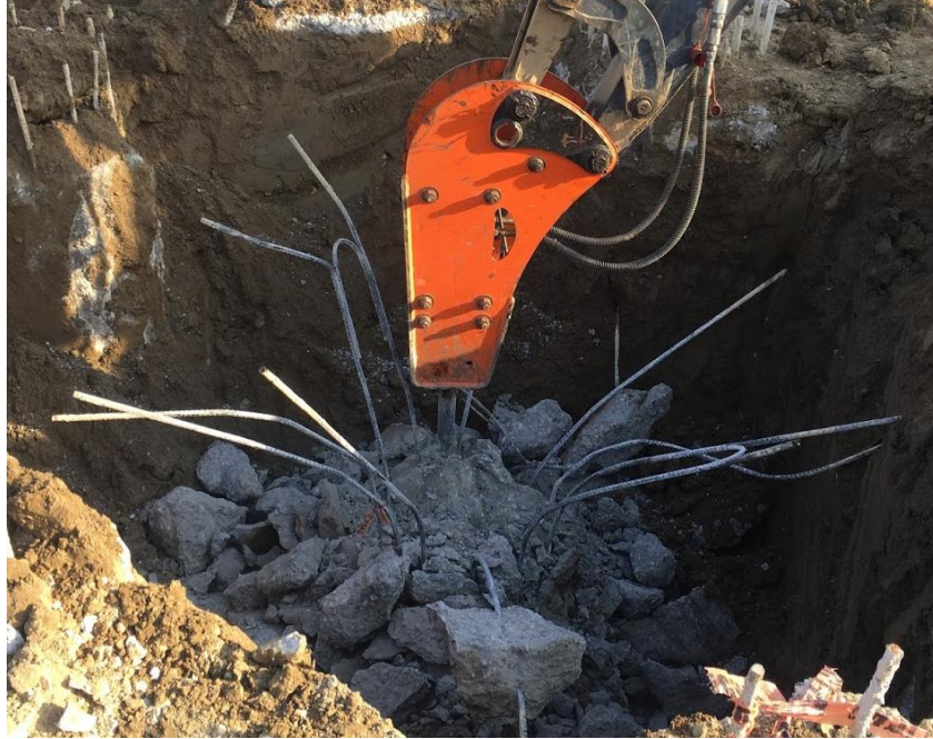
Ilustración 19. Descabezado de pilotes a 2m de profundidad
