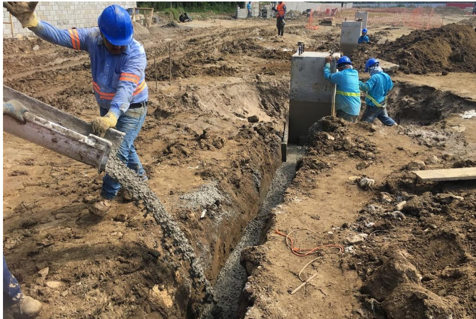
Ilustración 12. Fundición de vigas tensoras en naves de Clinker
