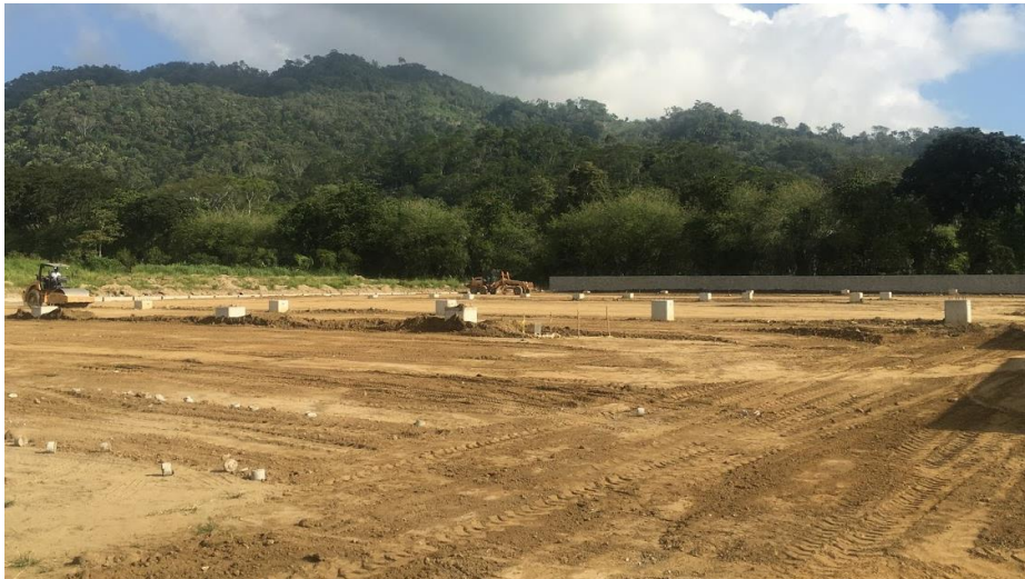
Ilustración 20. Terracería finalizada para naves de Clinker
