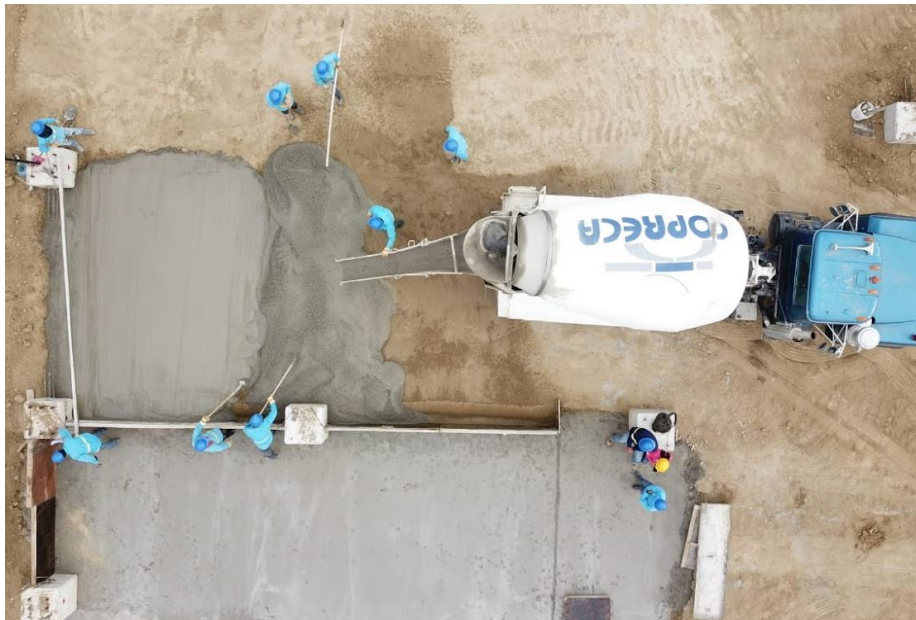
Ilustración 23. Vista aérea de fundición de losas
