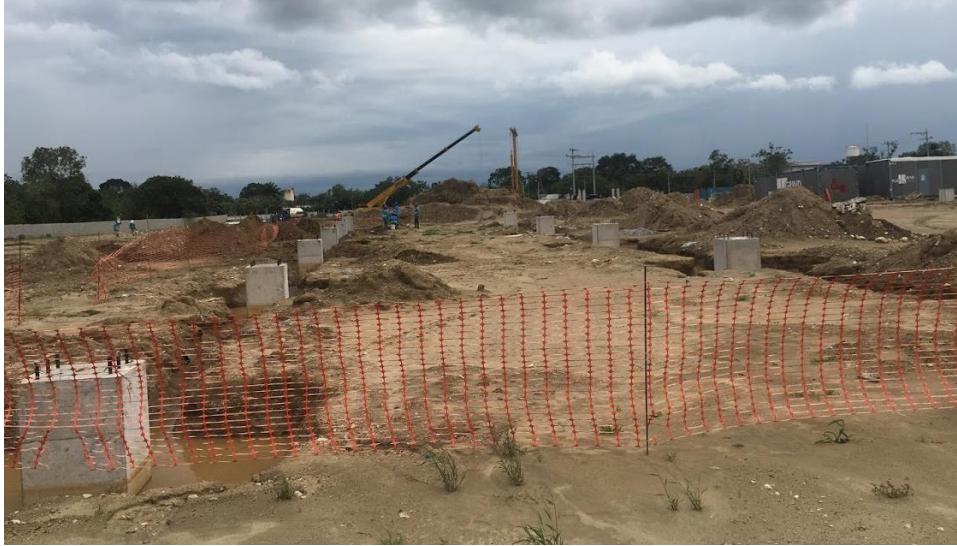
Ilustración 8. Cimentación de naves de clinker
