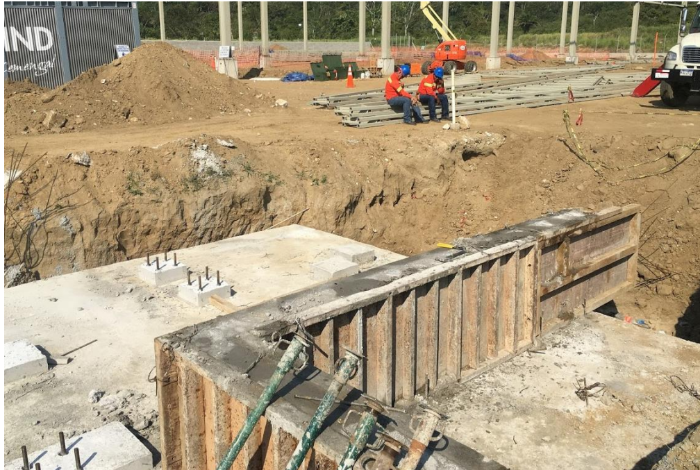
Ilustración 30. Muro de Contención
