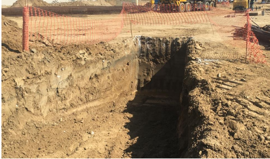
Ilustración 21. Excavación para mejoramiento de suelo con material selecto
