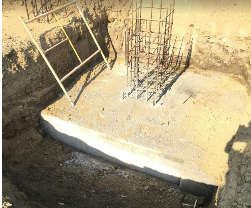
Ilustración 15. Zapata aislada de nave empacadora (2mx2m)
