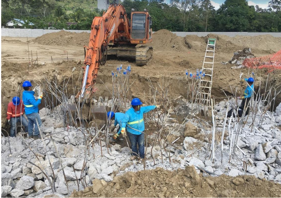
Ilustración 22. Pilotes descabezados
