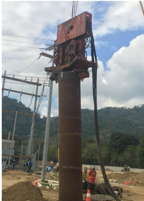
Ilustración 29. Hincado de camisa por vibración
