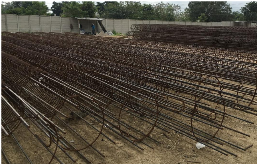
Ilustración 16. Zunchos de Acero para pilotes
