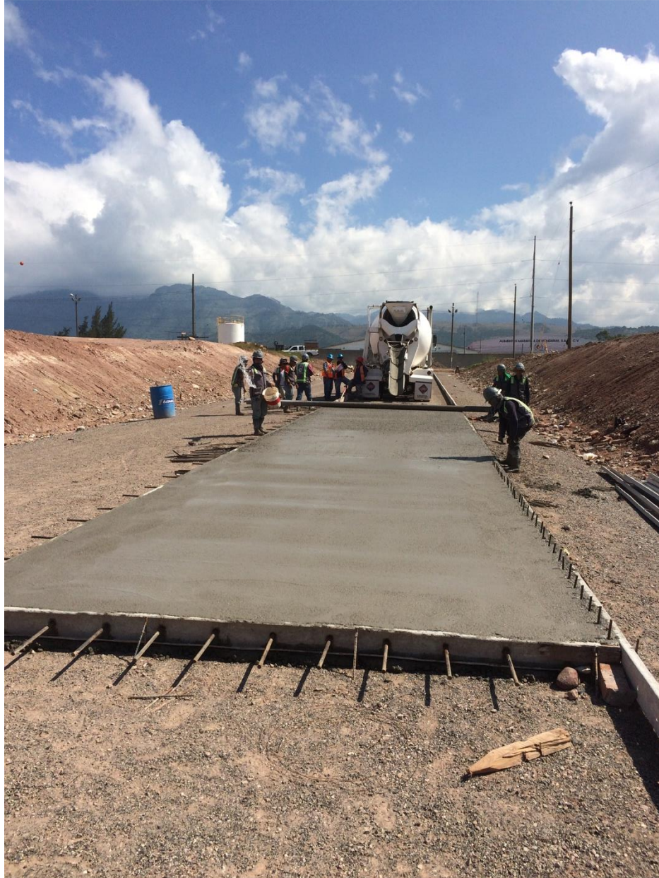
Ilustración 4. Colado de pavimento
