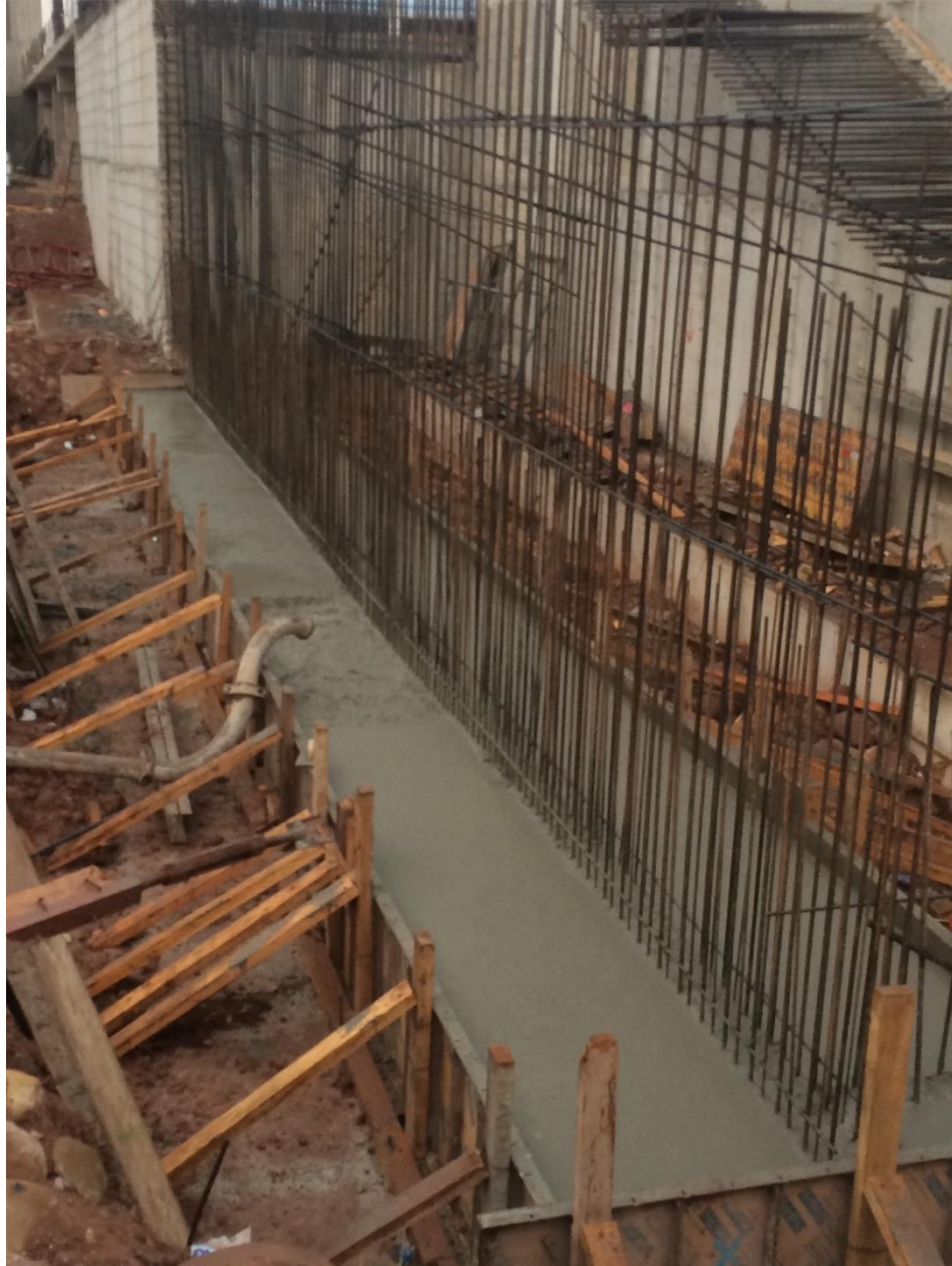
Ilustración 5. Colado de zapata de pared de carga
