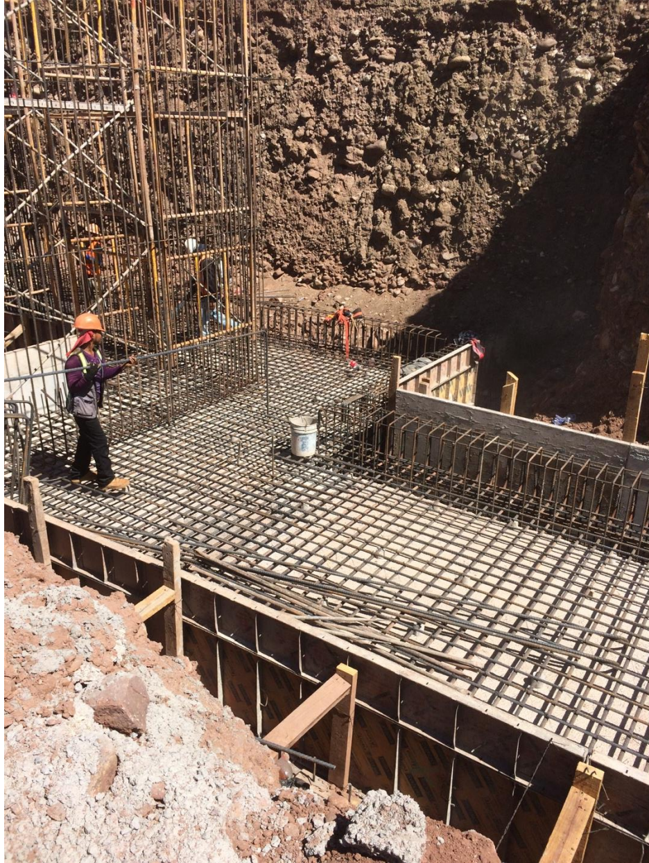
Ilustración 7. Armado y encofrado de zapata de Muro tipo 5
