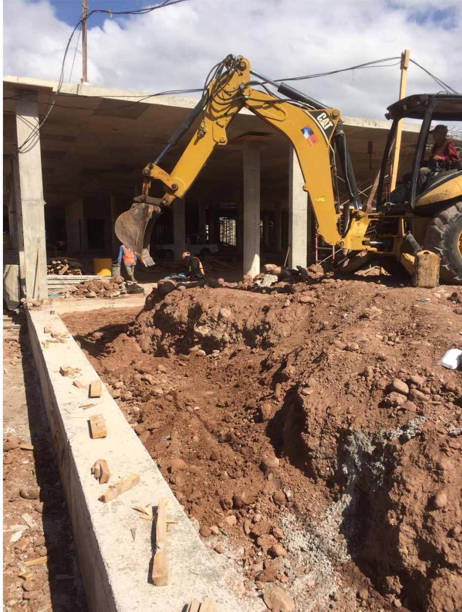
Ilustración 6. Resane de area para relleno de cuadrantes
