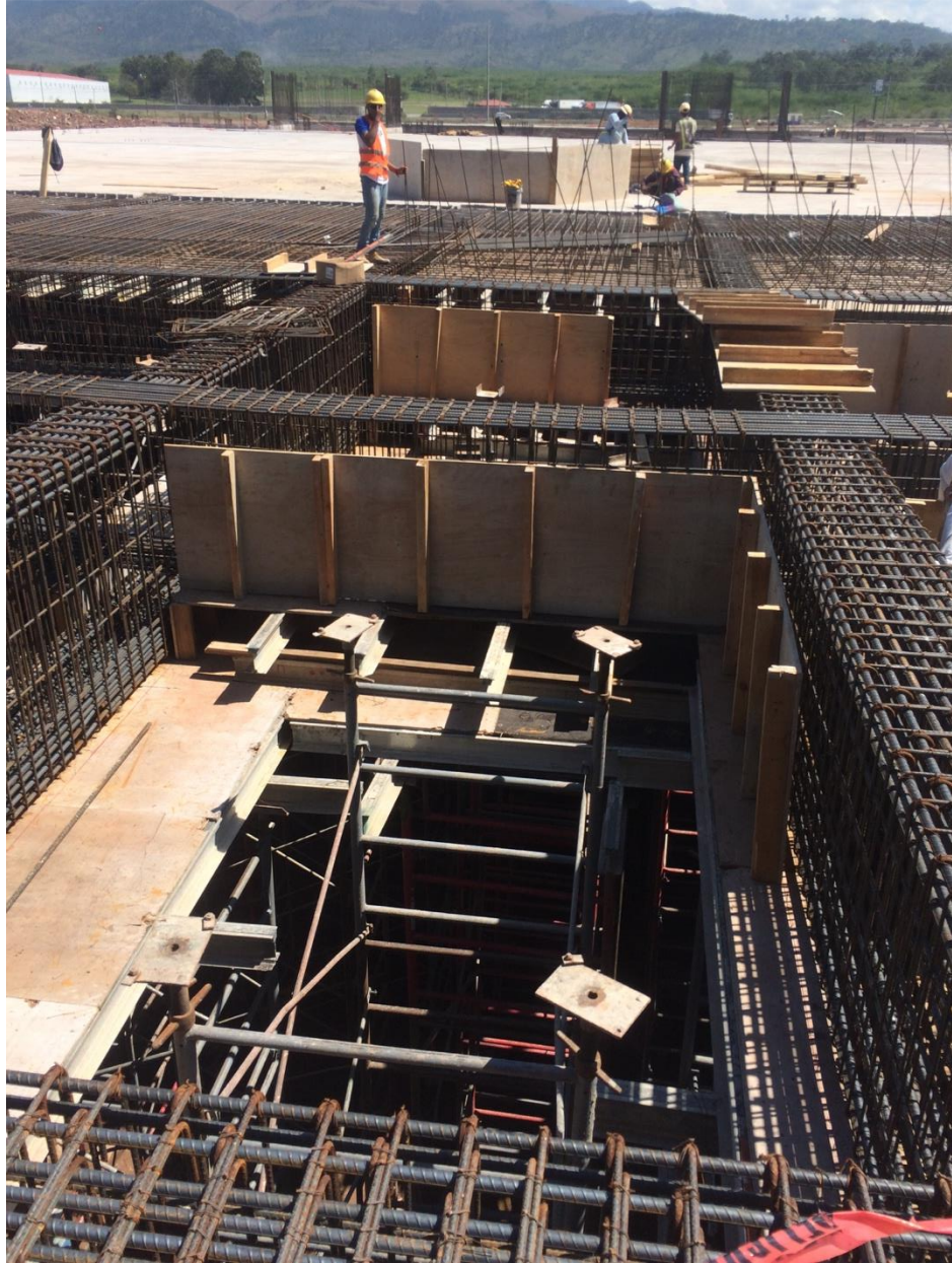
Ilustración 3. Armado de vigas para losa nervada
