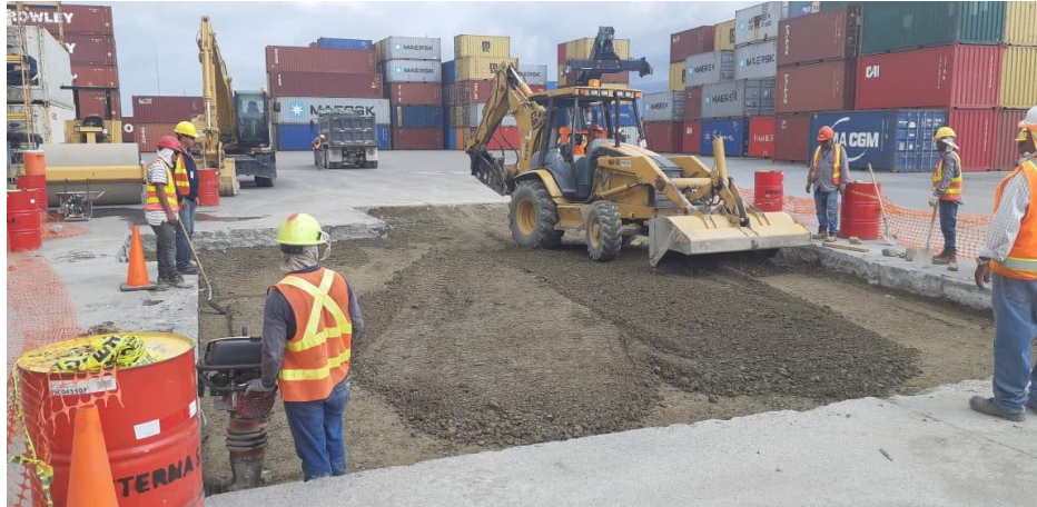
Ilustración 24. Base Suelo Cemento al 4% para Bache #3.
