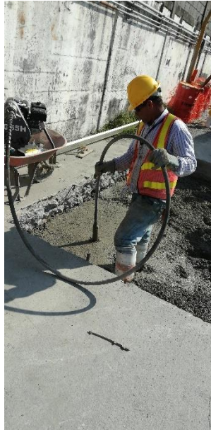
Ilustración 9. Vibrado de Concreto Bache #1.
