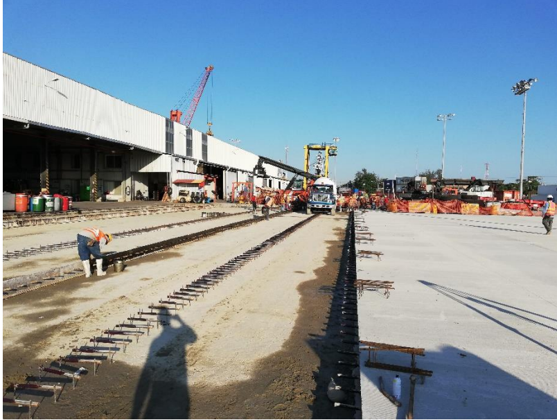
Ilustración 14. Fundición de Trocha 20-21.
