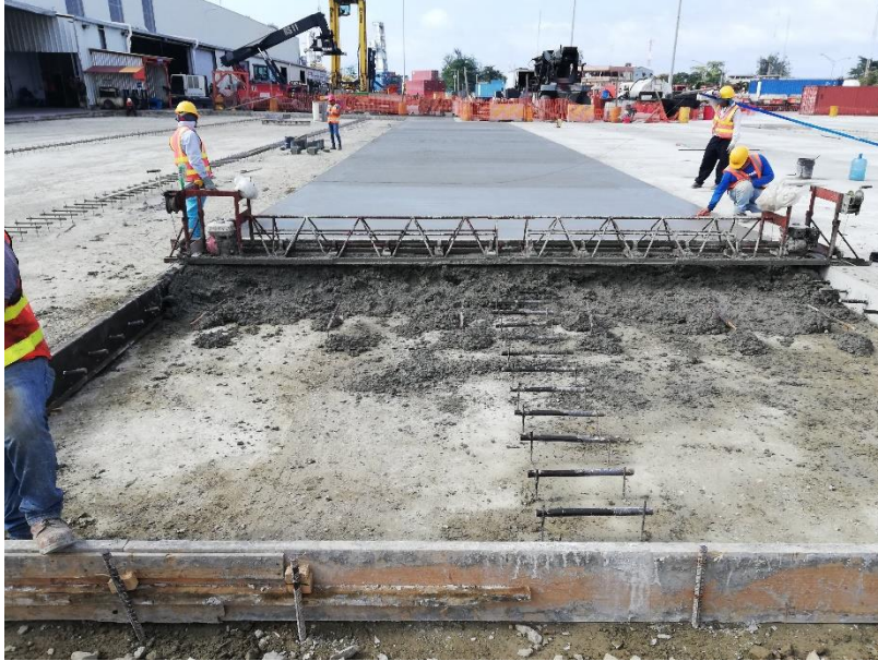
Ilustración 12. Fundición de Trocha 15-16.
