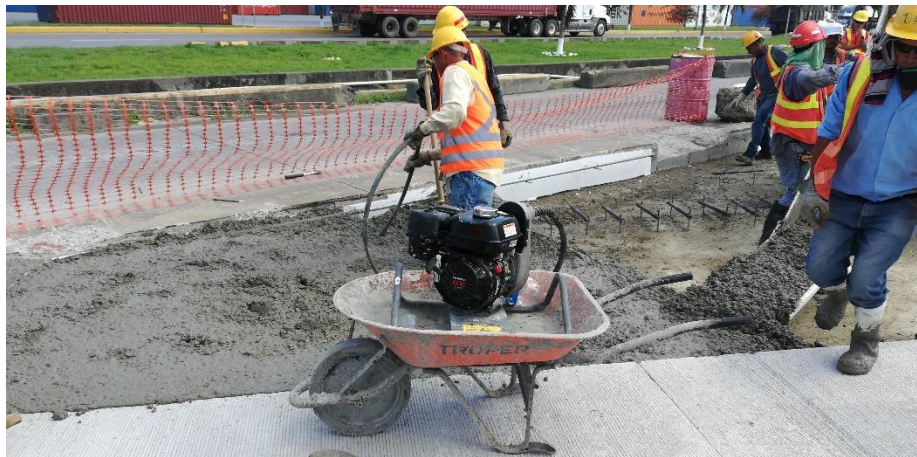
Ilustración 21. Fundición de Trocha 3-4.
