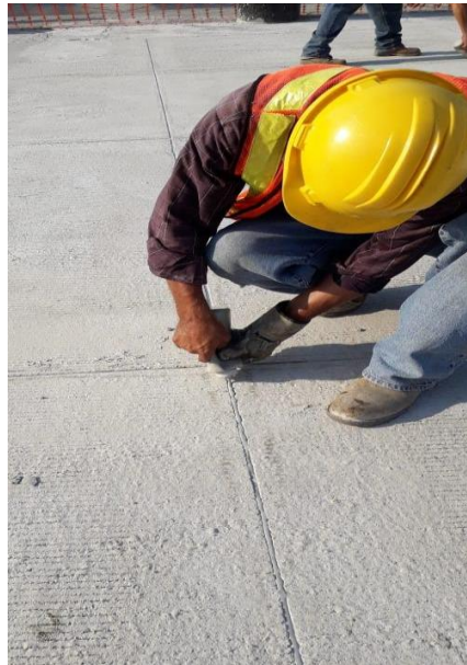
Ilustración 29. Colocado de Sikaflex 2CSL.
