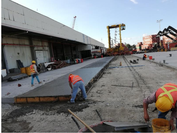
Ilustración 22. Fundición de Trocha 22-23 Segunda Parte.
