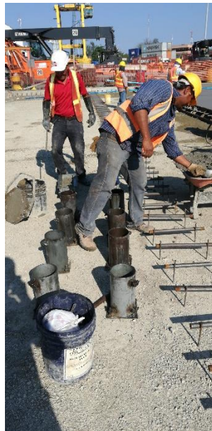
Ilustración 15. Toma de Muestra de Concreto Fresco para Trocha 20-21.
