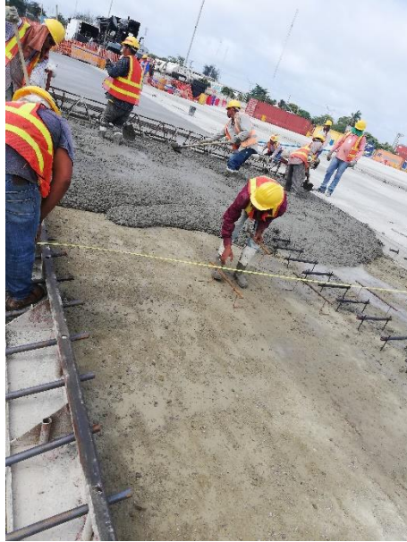
Ilustración 6. Fundición de Trocha 18-19.
