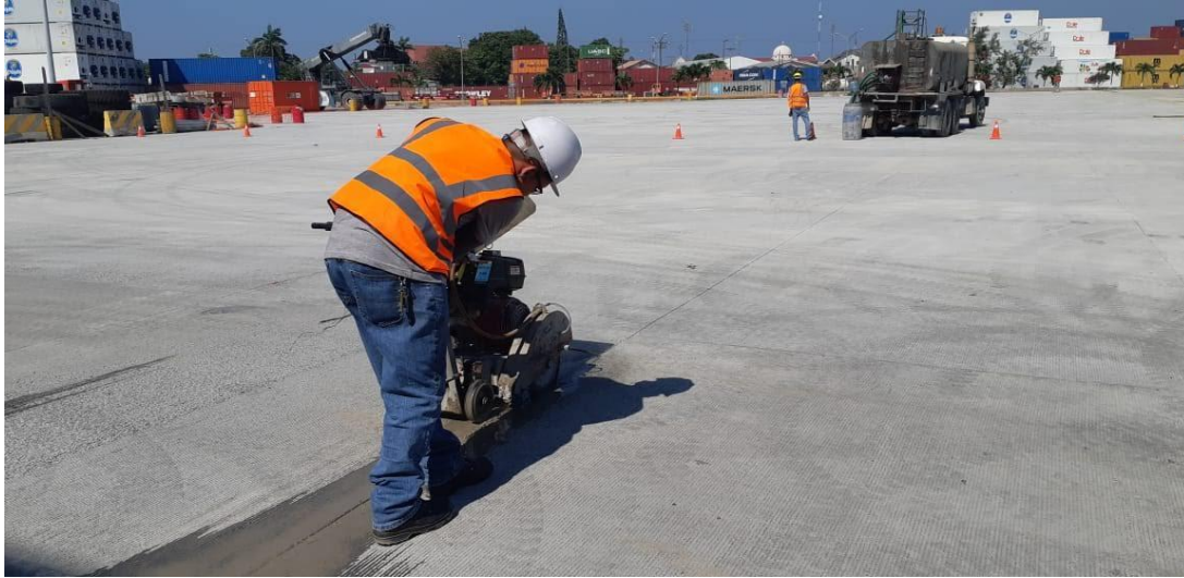
Ilustración 28. Ensanchamiento de Juntas en Patio T Lazarus Service.
