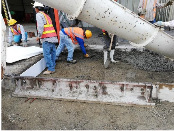
Ilustración 10. Fundición de Pastilla de Taller en Patio T.
