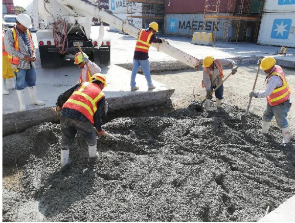
Ilustración 8. Fundición de Concreto Pobre en Bache #1.
