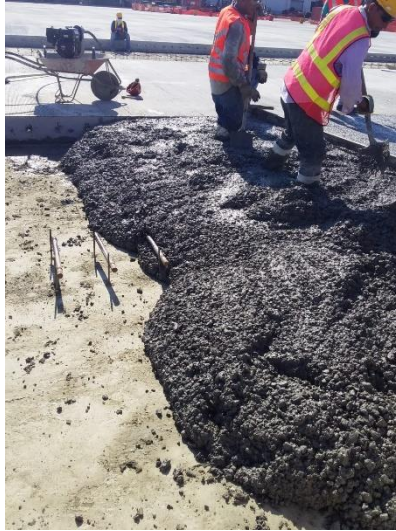
Ilustración 20. Fundición de Trocha 1-2.
