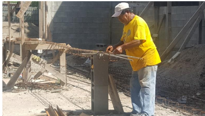
Figura 2. Armado de acero de columnas
