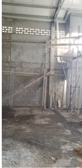
Figura 16. Repello de paredes en segundo nivel y labores de limpieza
