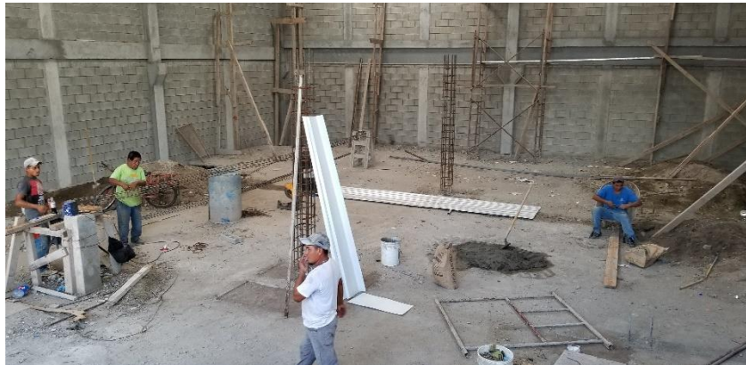
Figura 13. Montaje de flashing y capote de cumbrera de lámina de Aluzinc
