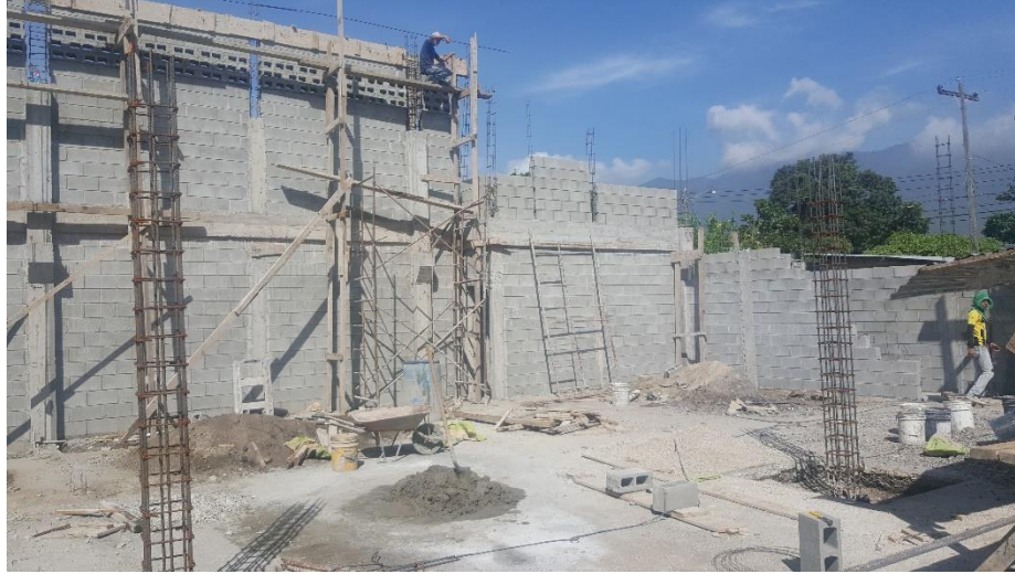
Figura 5. Elaboración de paredes de bloques de concreto
