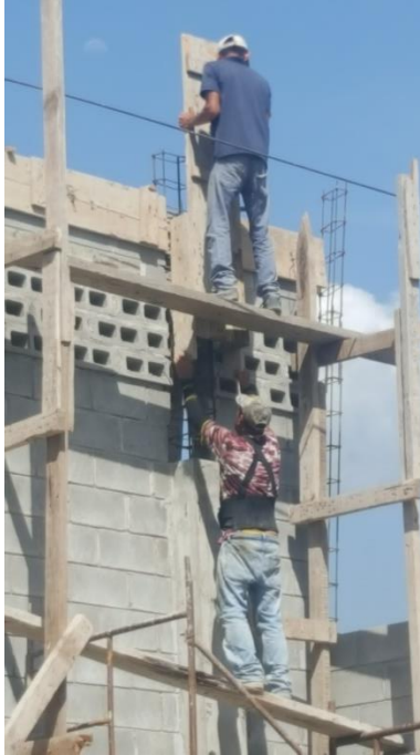
Figura 7. Encofrado y fundición de Columnas
