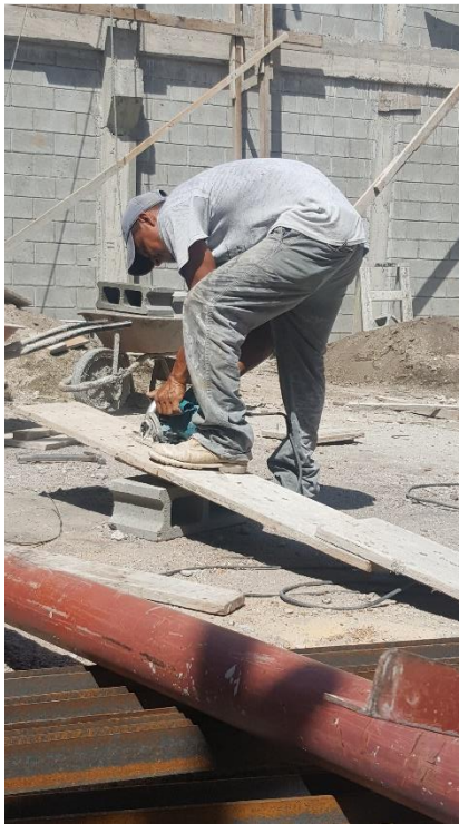
Figura 6. Elaboración de encofrado con madera rustica de pino
