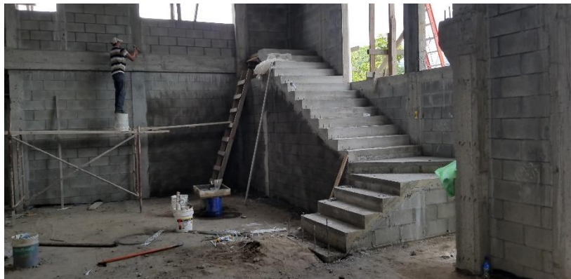
Figura 11. Repello y Tallado de columnas vigas y paredes
