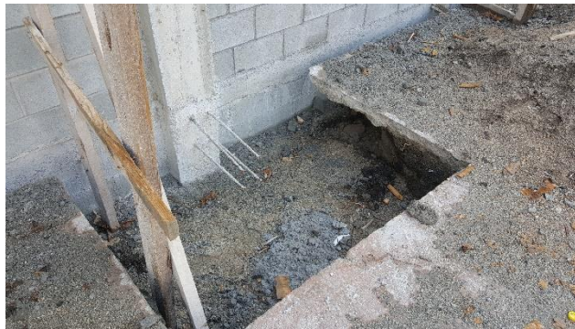
Figura 8. Corte en piso existente para fundición de cimentación y viga tensora
