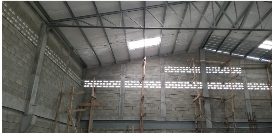
Figura 10. Montaje de cumbrera de lámina de Aluzinc y aislante térmico tipo Prodex
