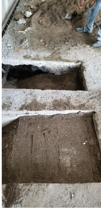
Figura 12. Relleno y compactación de cimentación bajo corte de piso terminado
