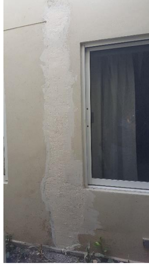
Figura 1. Culminación de enmasillado y pulido en trabajo de mantenimiento
