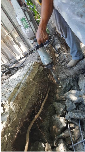
Figura 14. Demolición de cerco perimetral
