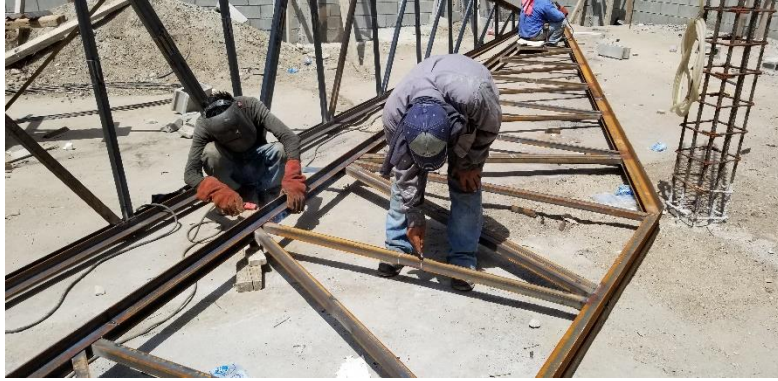
Figura 9. Armado de tijeras para estructura de techo
