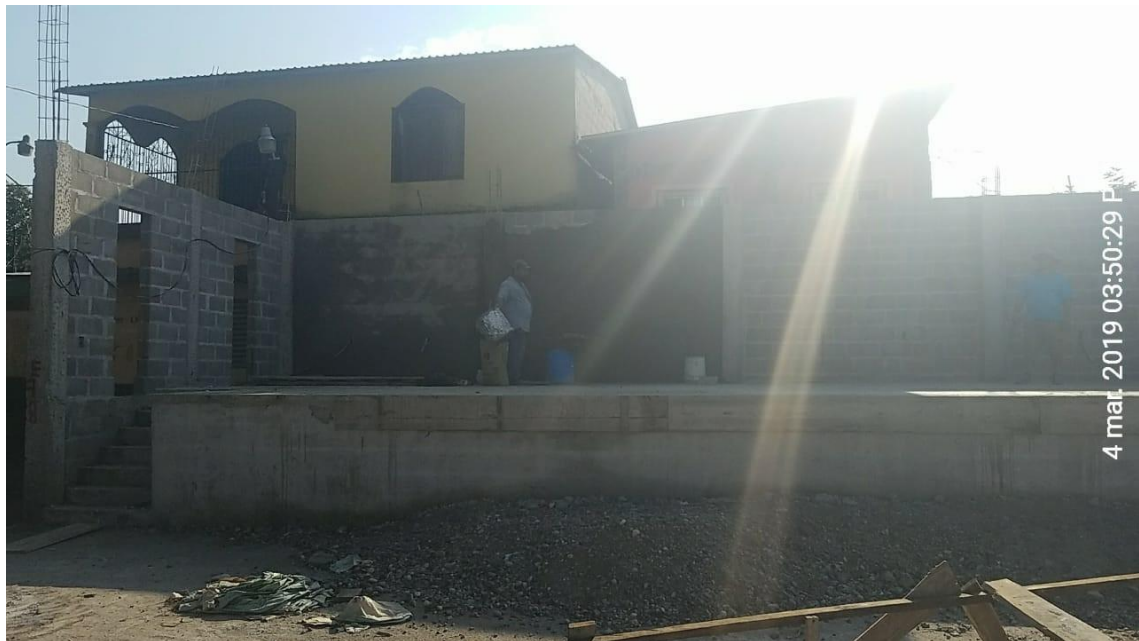
Figura 13. Medición de posible pavimentación en Peña Blanca
