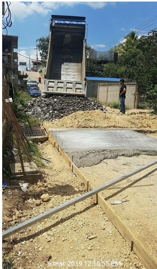
Figura 11. Colocación de piedras utilizadas al momento de fundir la losa de pavimento
