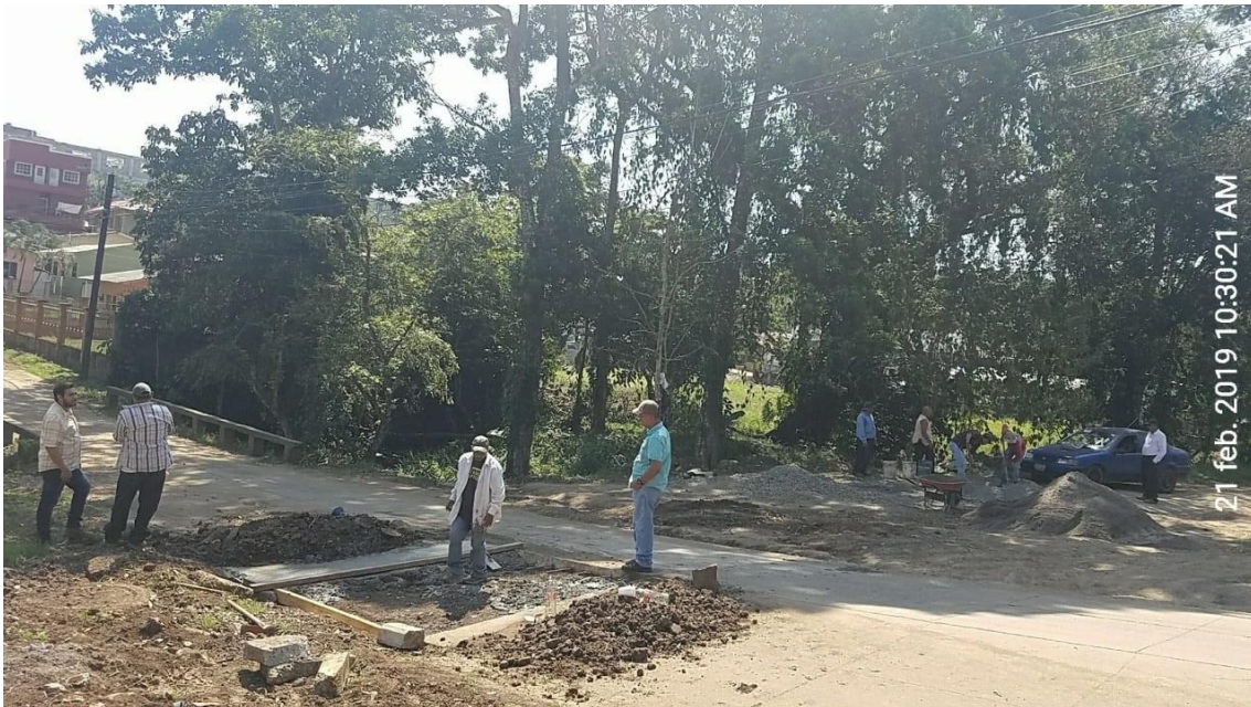
Figura 17. Medición del ancho libre con el que se dejó caja puente
