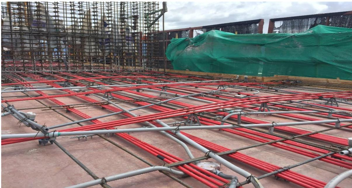
**Ilustración 20. Varillas de losa postensada de URBN Escalante**
