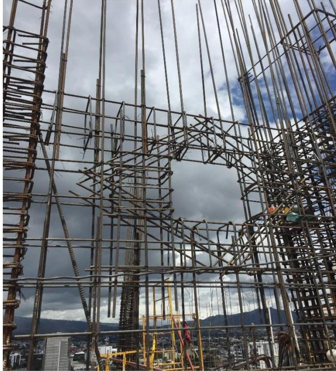
**Ilustración 21. Acero diagonal en muros**
