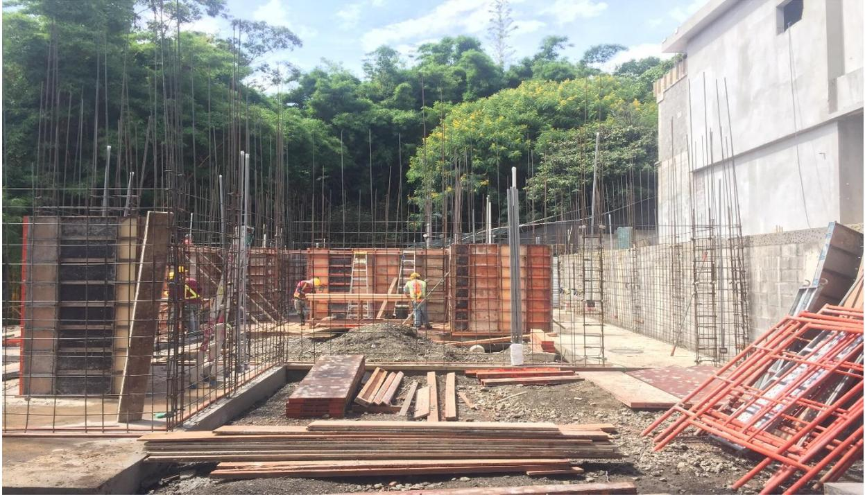
**Ilustración 13. Armado y encofrado de paredes de concreto**
