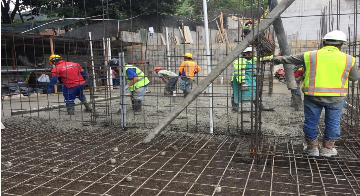
**Ilustración 9. Fundición de losa con bomba telescópica**
