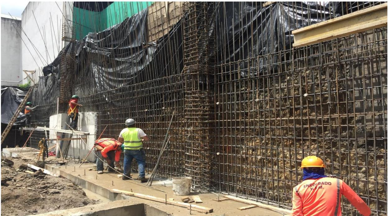
**Ilustración 26. Muros de contención Amará Escazú**
