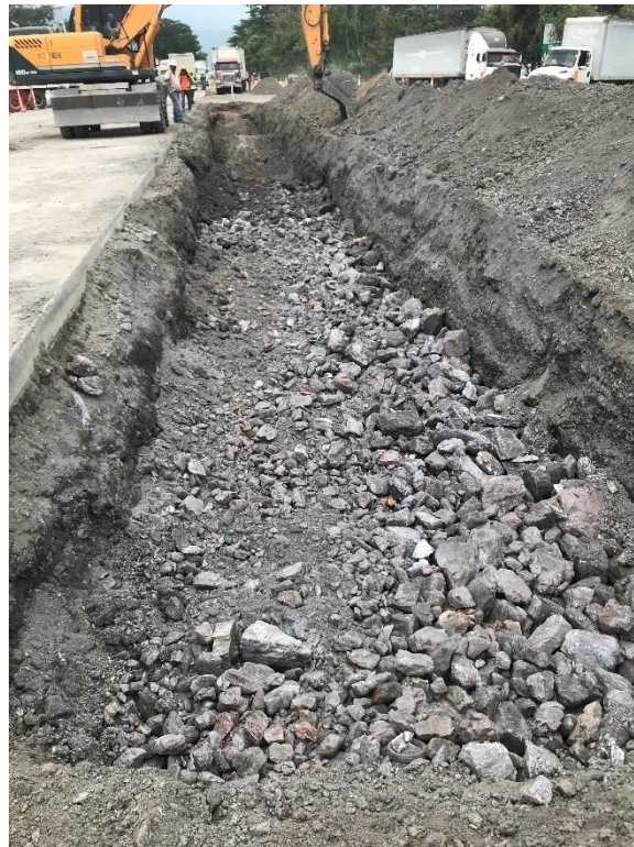
Ilustración 20 Cama de Piedra para estabilización
