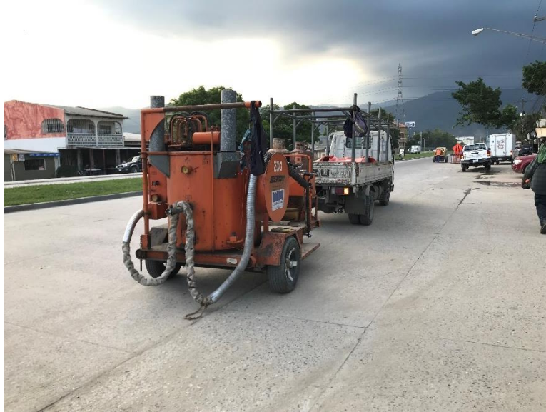
Ilustración 13 Dispensadora de Asfalto en sellado de grietas
