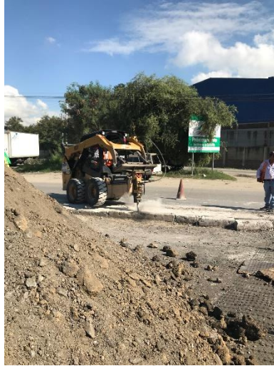
Ilustración 25 Rompimiento para el emparejamiento de losa
