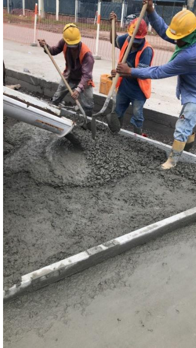
Ilustración 9 Obradores en fundición de concreto
