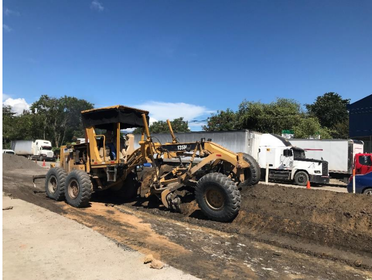
Ilustración 19 Mezclado subrasante con patrol
