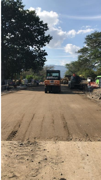
Ilustración 7 Compactación de suelo con compactadora neumática
