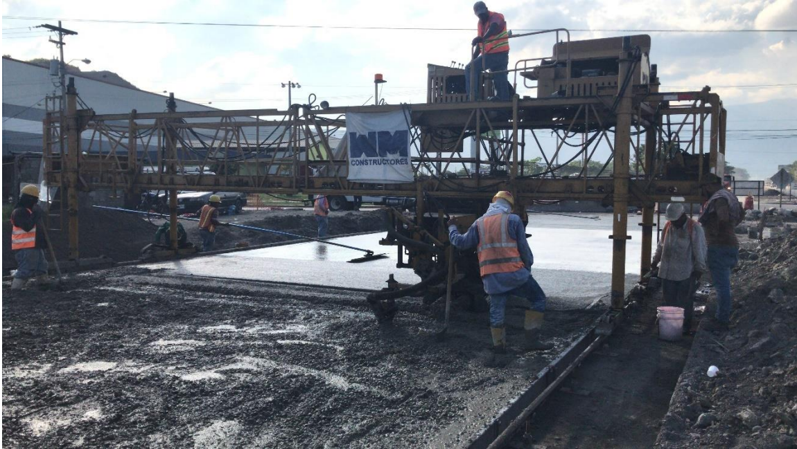
Ilustración 11 Maquina Bidwell en fundición de concreto
