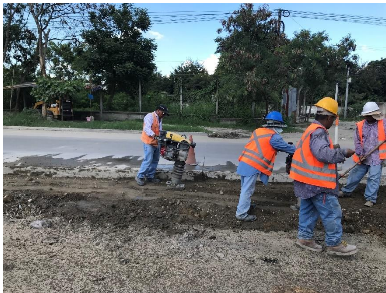
Ilustración 24 Compactado mecánico de suelo
