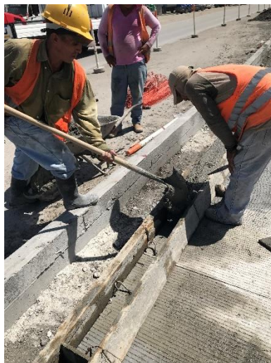
Ilustración 22 Colocado de bordillos
