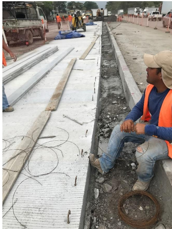
Ilustración 18 Colocación de armado de acero para bordillos
