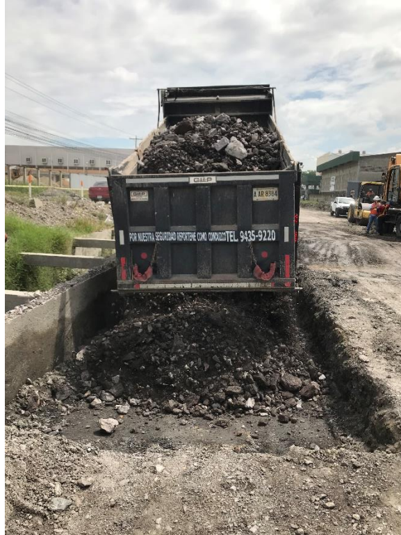
Ilustración 15 Relleno con material de el polvorín
