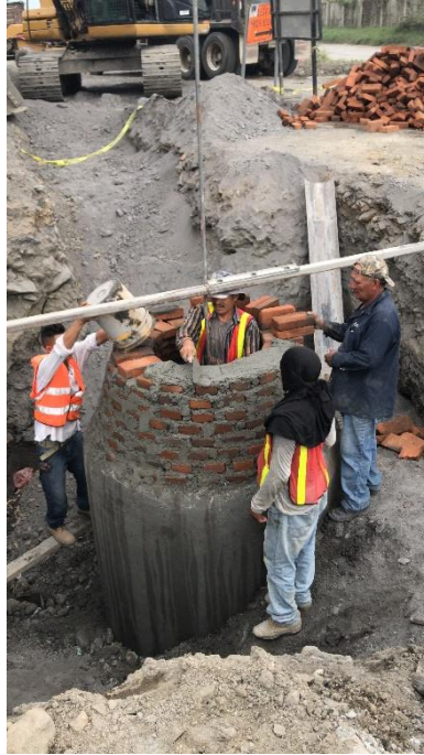
Ilustración 3 Construcción de un Pozo de Inspección
