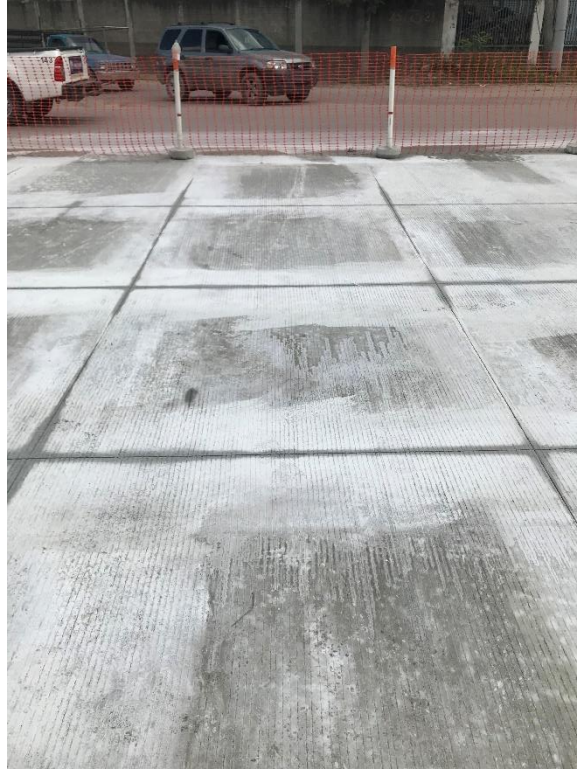
Ilustración 23 Juntas constructivas en losa de concreto
