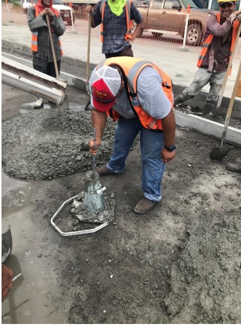
Ilustración 17 Prueba de Revenimiento de concreto
