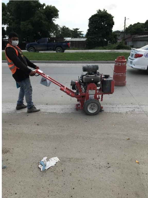
Ilustración 12 Rotadora en apertura de grietas
