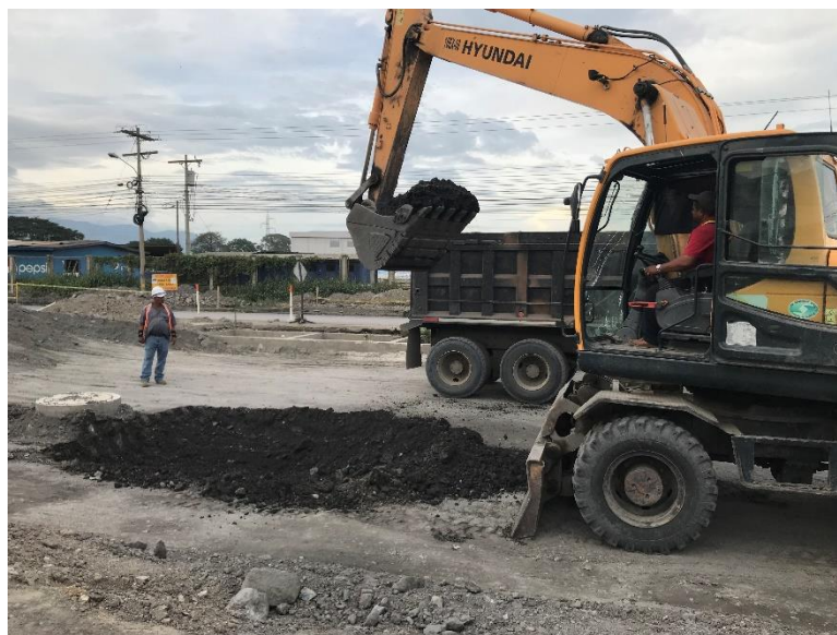
Ilustración 16 Excavación en saneamiento de bache
