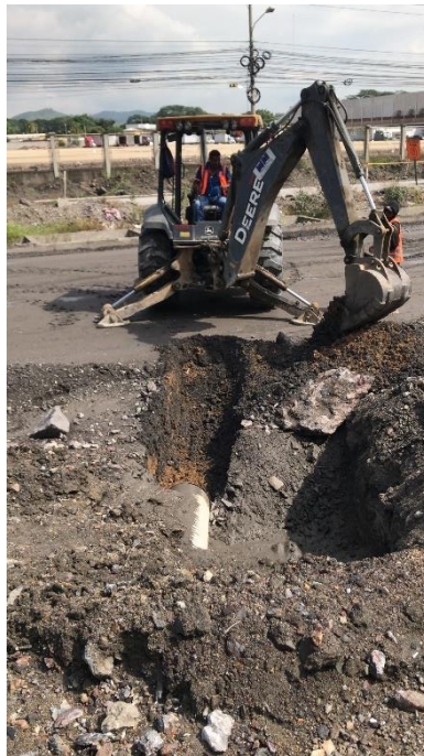
Ilustración 6 Excavación de zanja para la colocación de tubería
