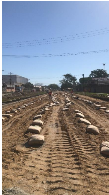
Ilustración 4 Colocación de cemento para mezclado de subbase
