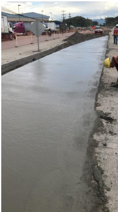
Ilustración 8 Fundición de refugio previo a retorno
