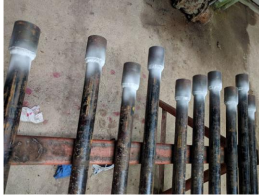
Figura 2. Revisión de Soldaduras para Tubería de Gas y Aceite
