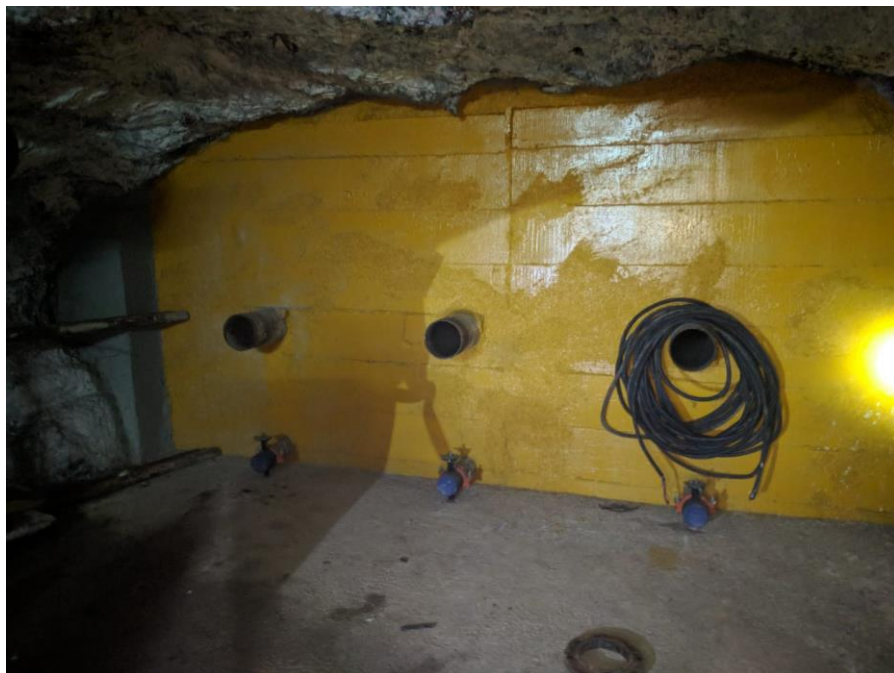
Figura 9. Salidas de Tuberías para Estacion de Bombeo en Nivel 24-50
