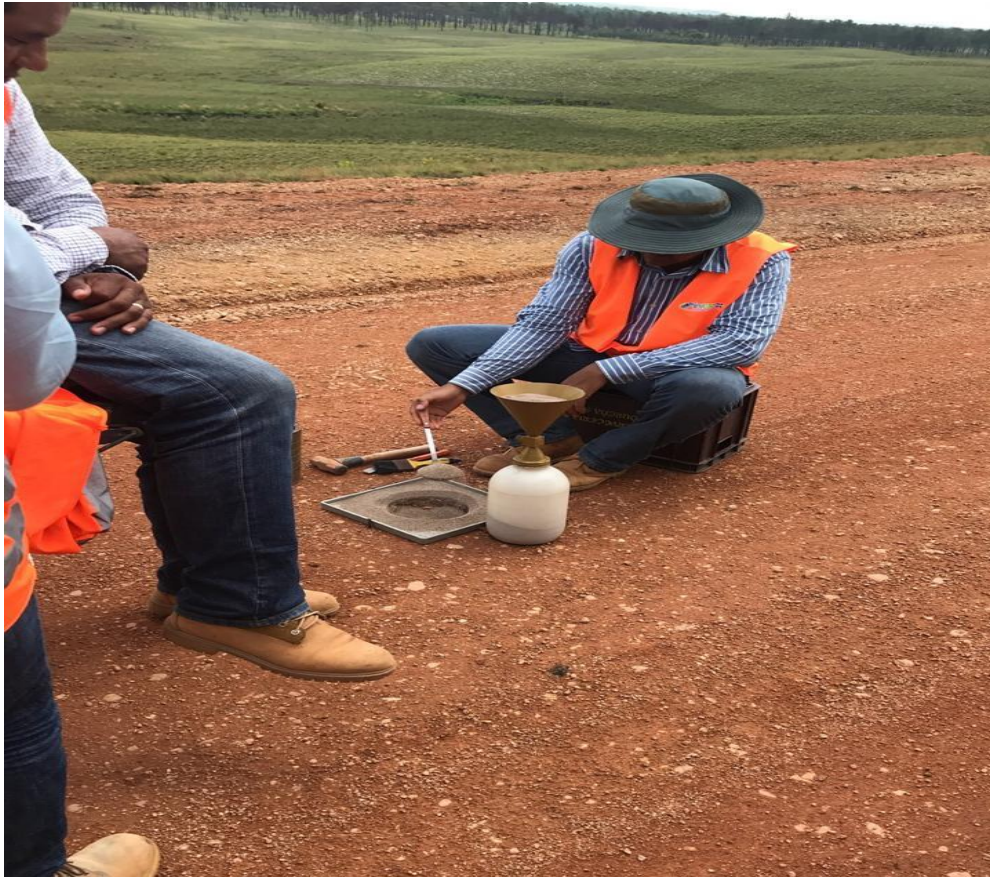
Figura 6 : Prueba de densidad in situ.
