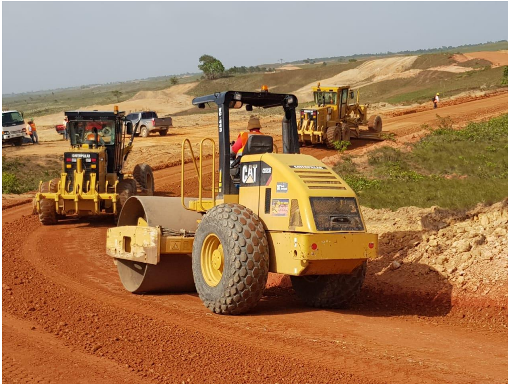
Figura 1 : afinamiento y compactación de carretera.
