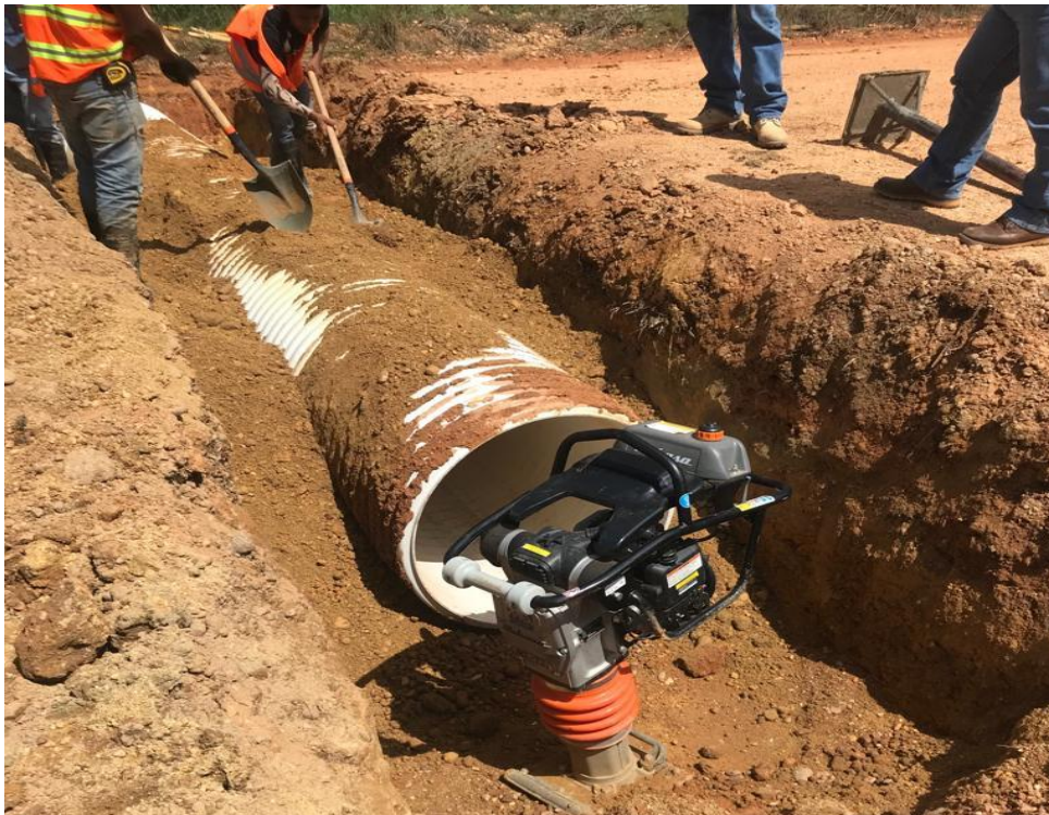
Figura 4 : colocación de tubería para drenar el agua lluvia.
