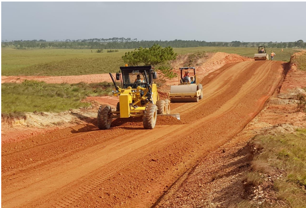
Figura 2: extendido de material balasto.
