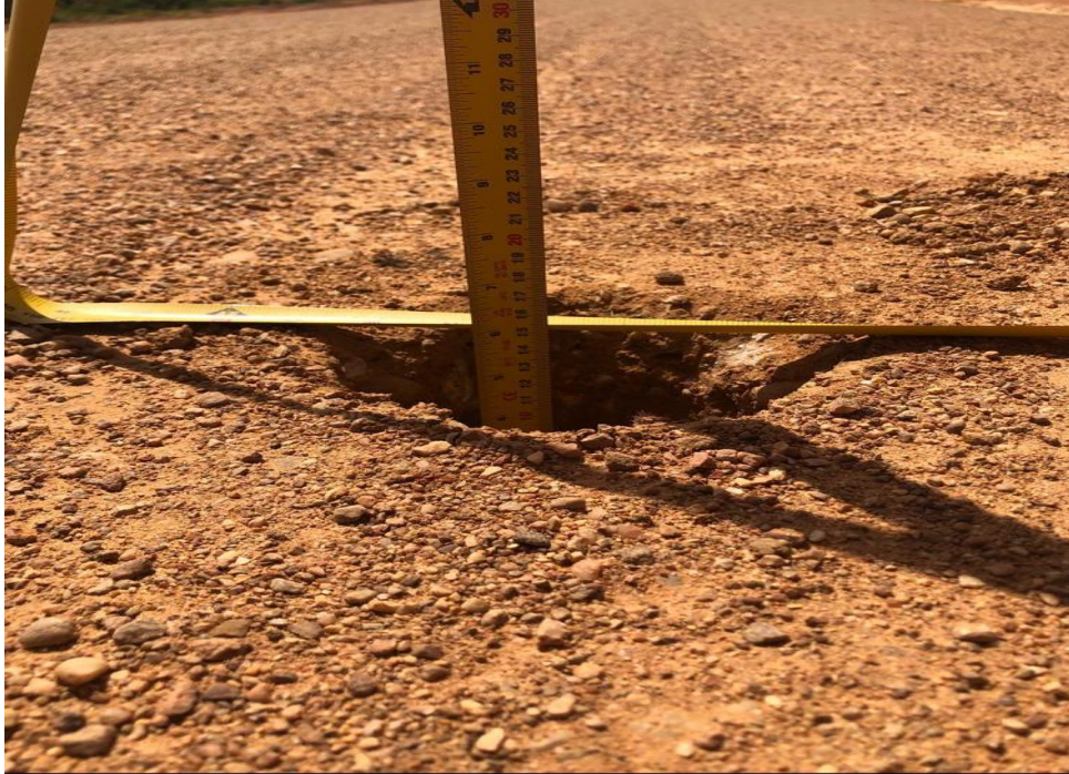
Figura 3 :Prueba de espesor de capa balasto.
