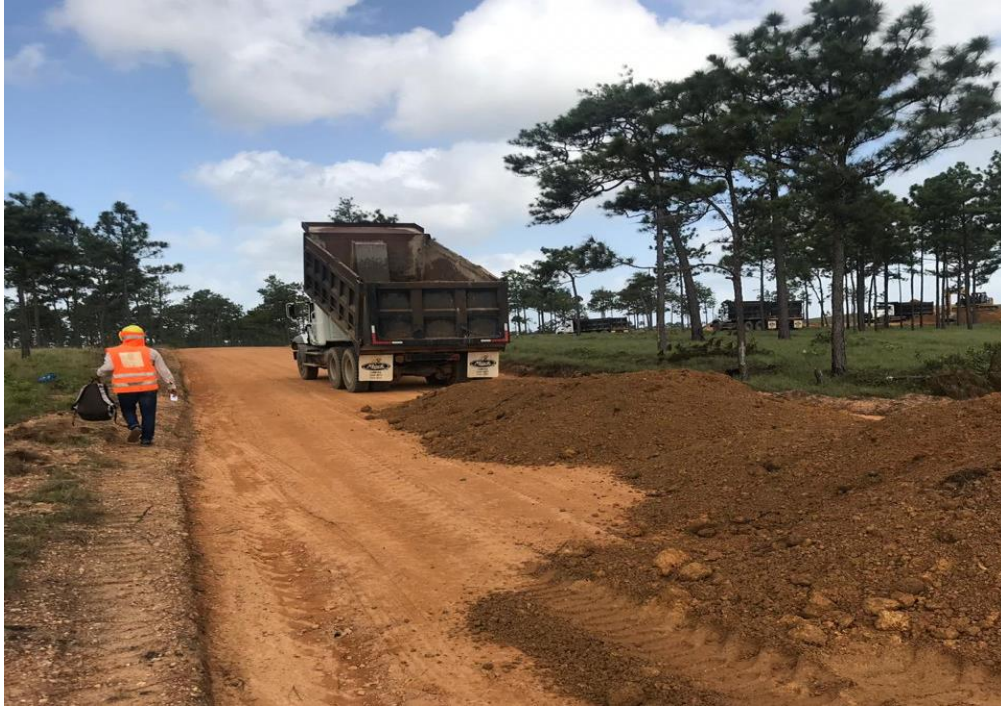
Figura 5: Colocación de balasto.
