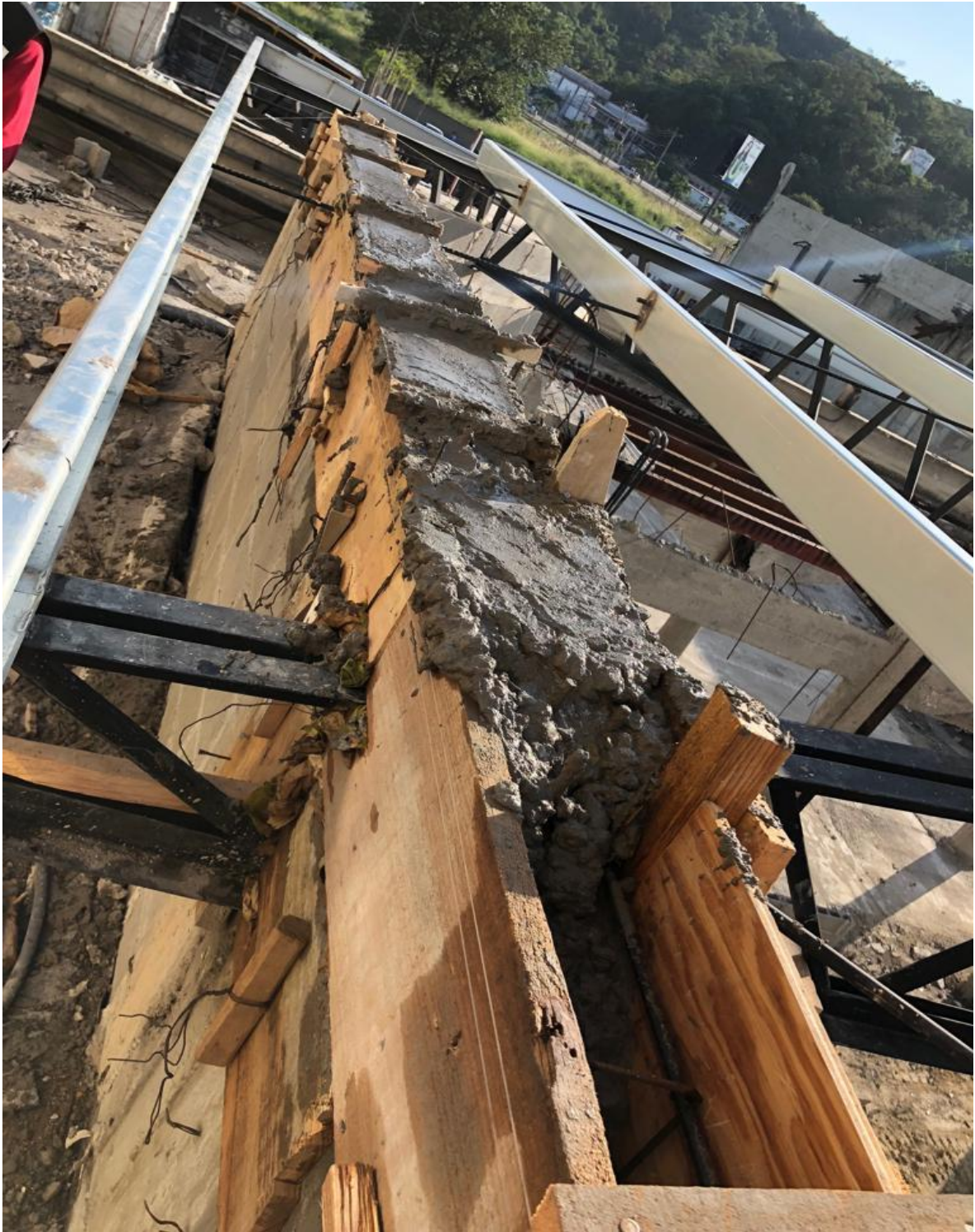
Ilustración 5. Fundición de solera superior en pared de segundo nivel.
