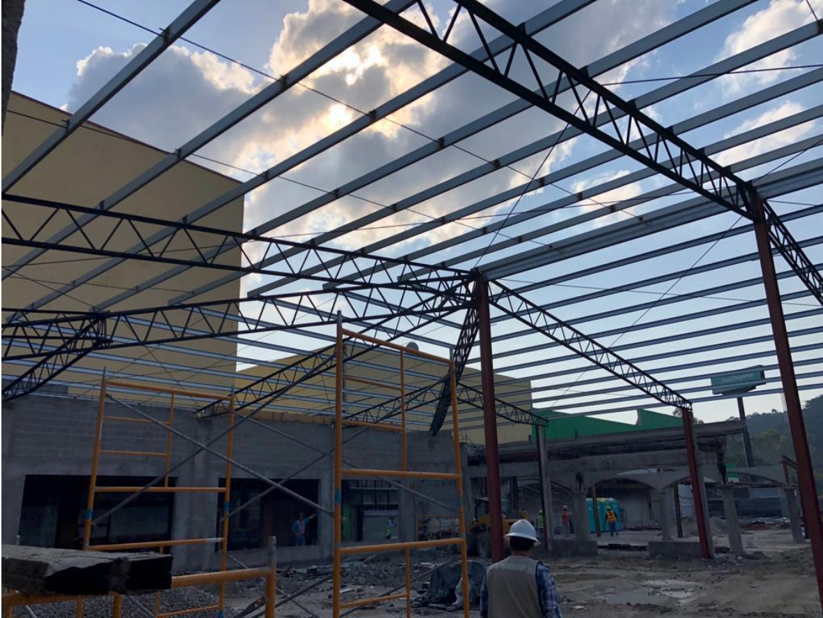
Ilustración 7. Estructura de techo con Joist metálicos y canaletas.
