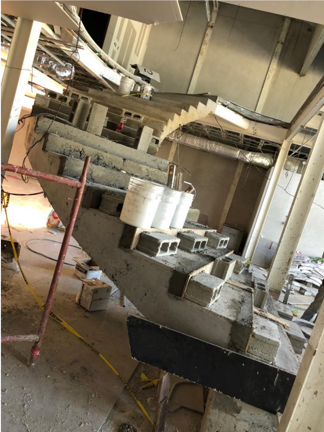
Ilustración 2. Escalera de caracol hecha de concreto reforzado con acero.
