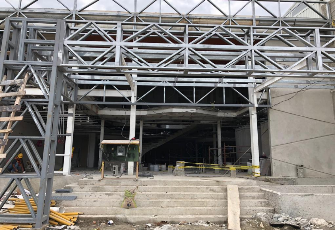
Ilustración 3. Fascia de tubo estructura para fachada de durock.
