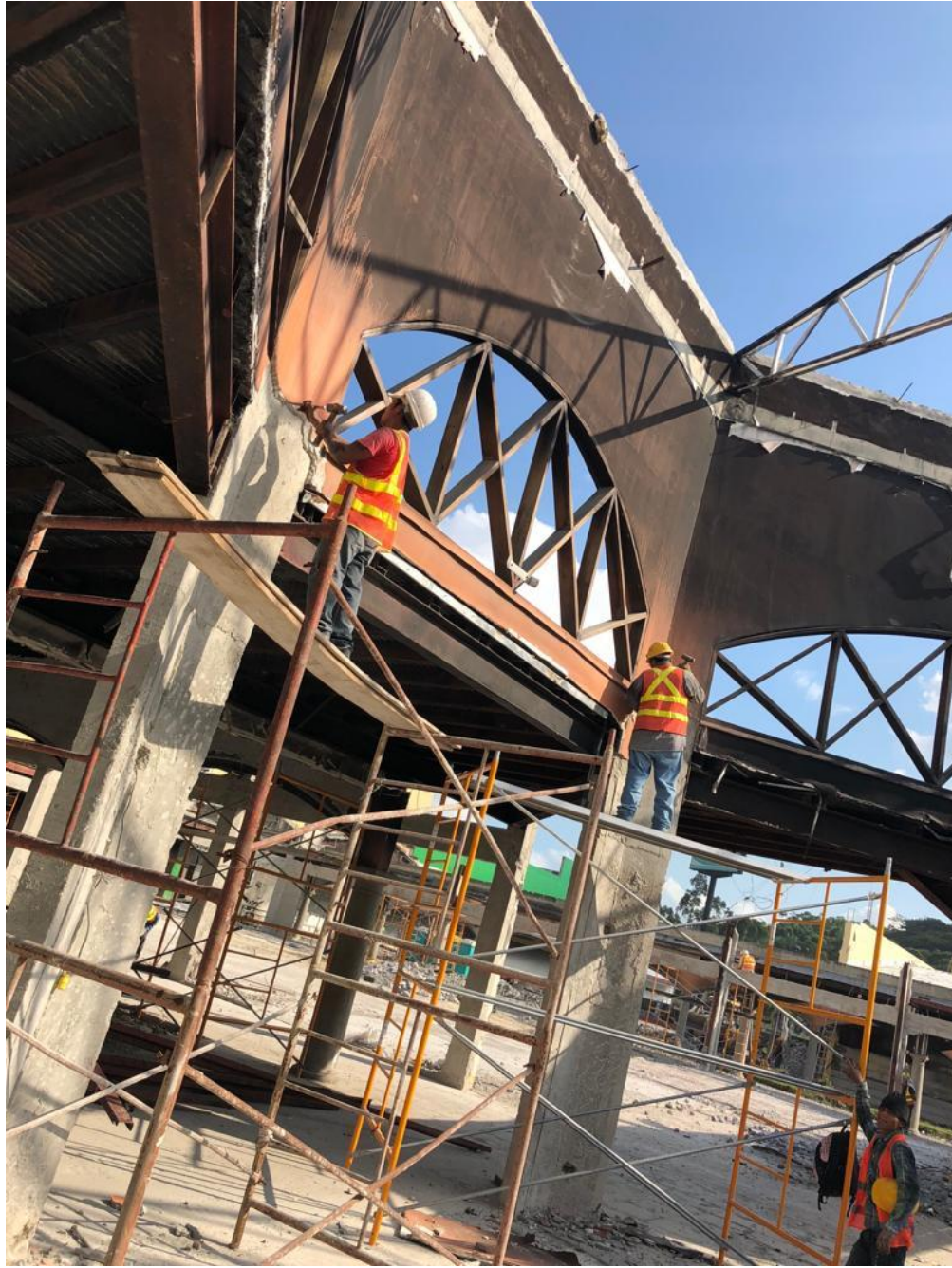
Ilustración 6. Demolición de repello y pulido en todas las paredes afectadas por el incendio.
