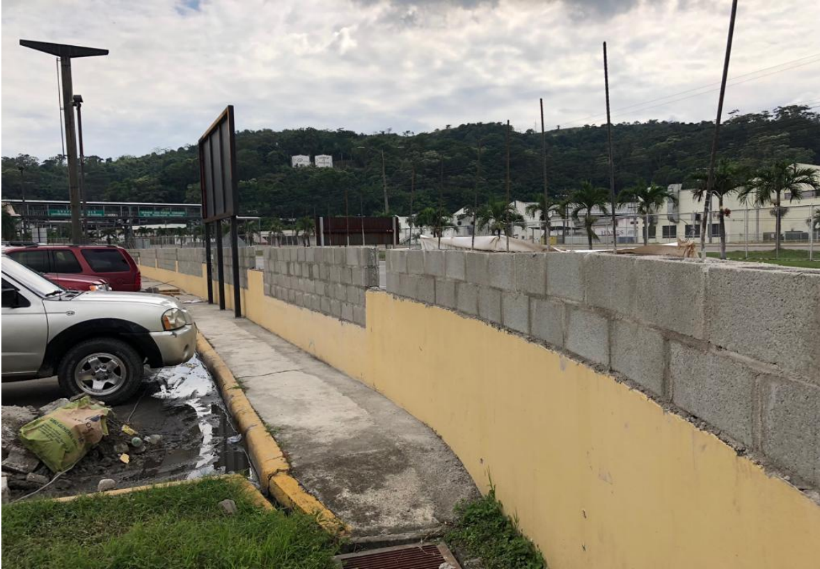
Ilustración 4. Elevación de bloque de 6" en muro frontal y lateral del Mall.
