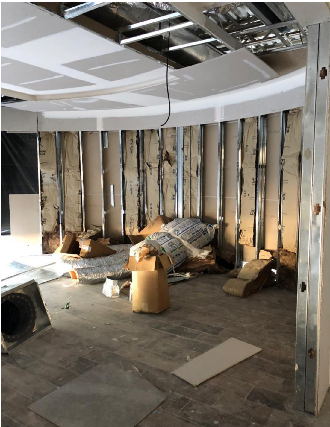
Ilustración 1. Pared curva de tabla yeso con su debido aislante.
