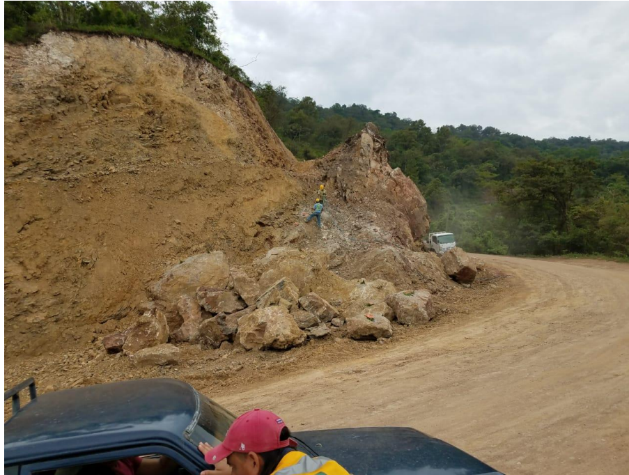
Figura 19. Colocación y marcado de dinamita
