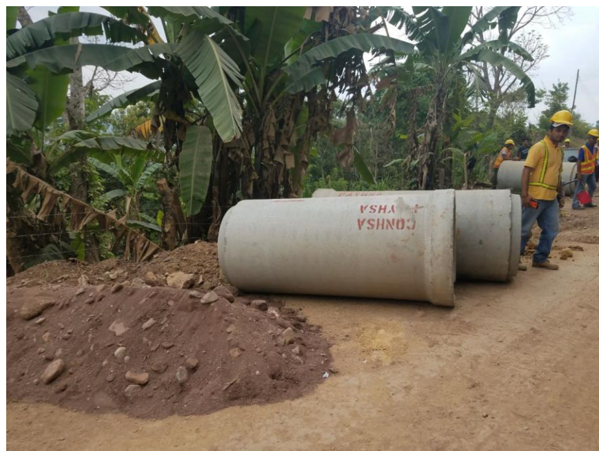
Figura 7. Tubería de concreto de 30" diámetro
