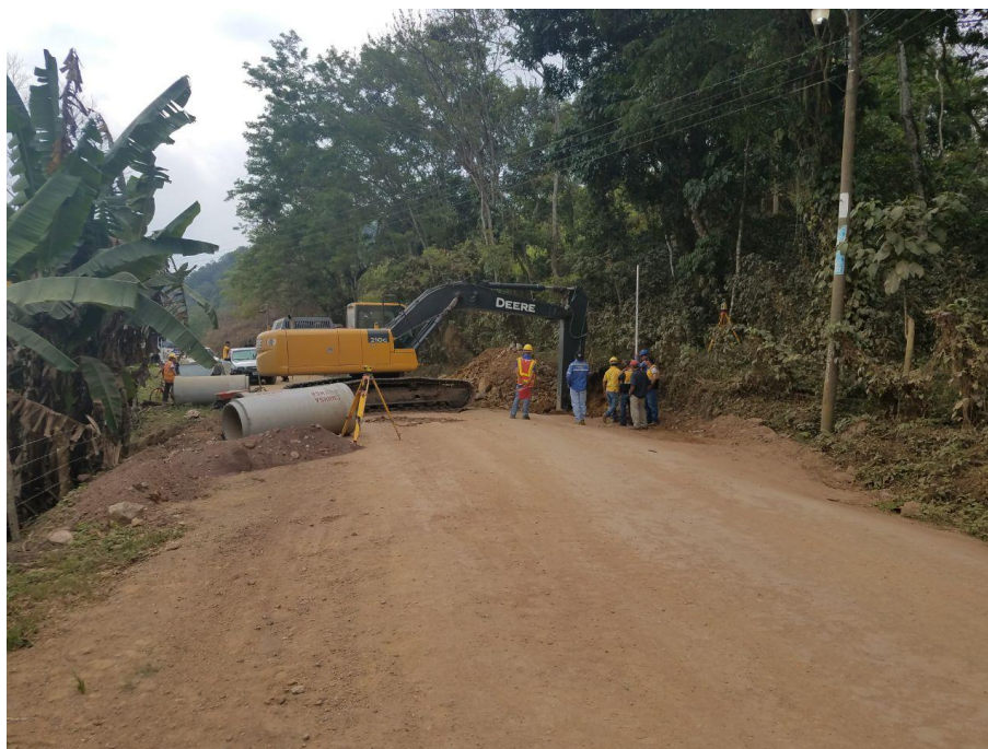
Figura 6. Tramo "3+487.37" colocación del drenaje menor
