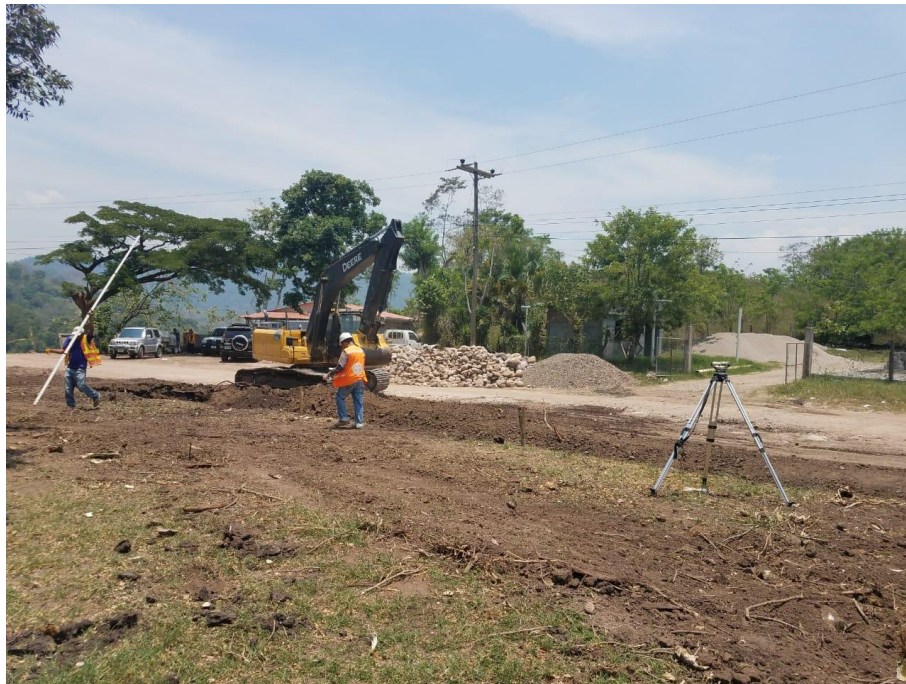
Figura 12. Nivelación para taludes
