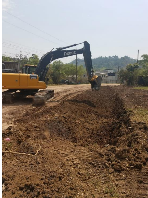
Figura 11. Excavación de taludes tramo 1+140 al 1+190
