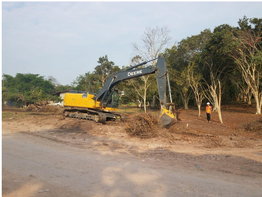
Figura 10. Limpieza y remoción con retroexcavadora
