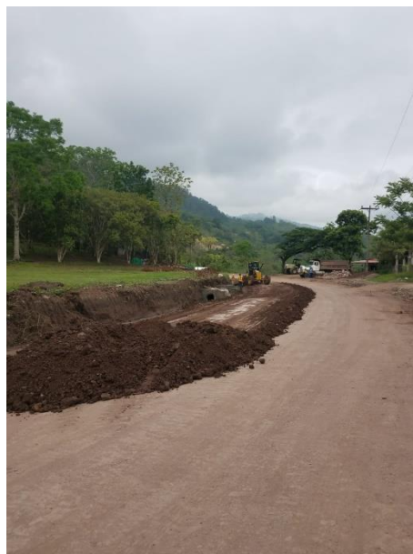
Figura 18. Afinamiento del tramo 1+000 al 1+220
