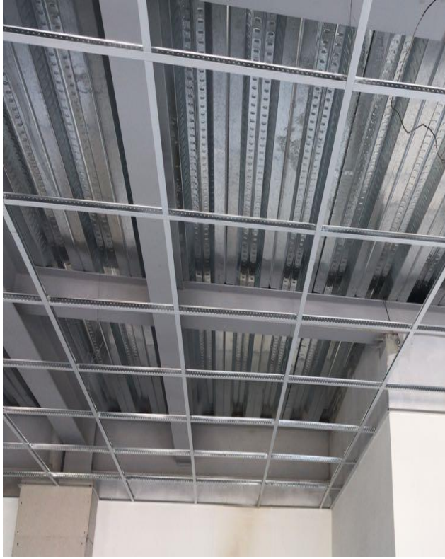
Ilustración 7. Estructura metálica que forma parte de losa de locales comerciales.
