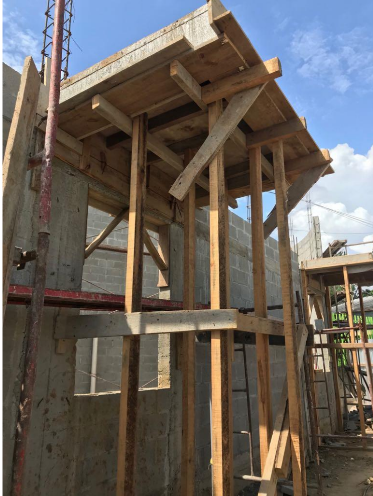
Ilustración 9. Encofrado de losa en voladizo.
