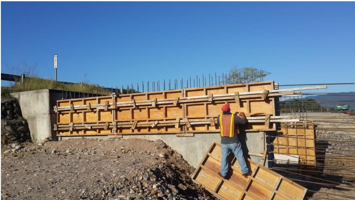
Fig2. *Fundición de paredes de concreto en caja vehicular*
