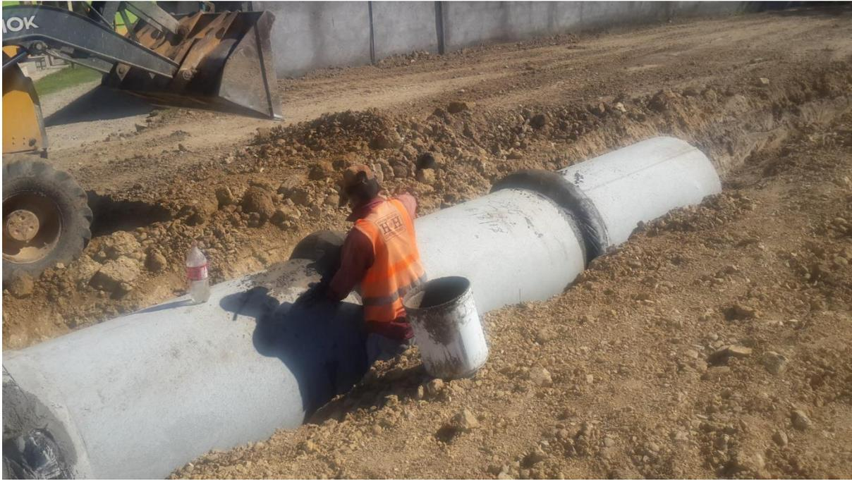
Fig3. *Colocación de tuberías de concreto diámetro de 48"*
