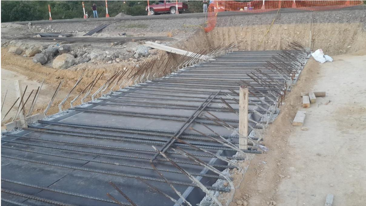
Fig1. Armado de acero y fundición de caja peatonal
