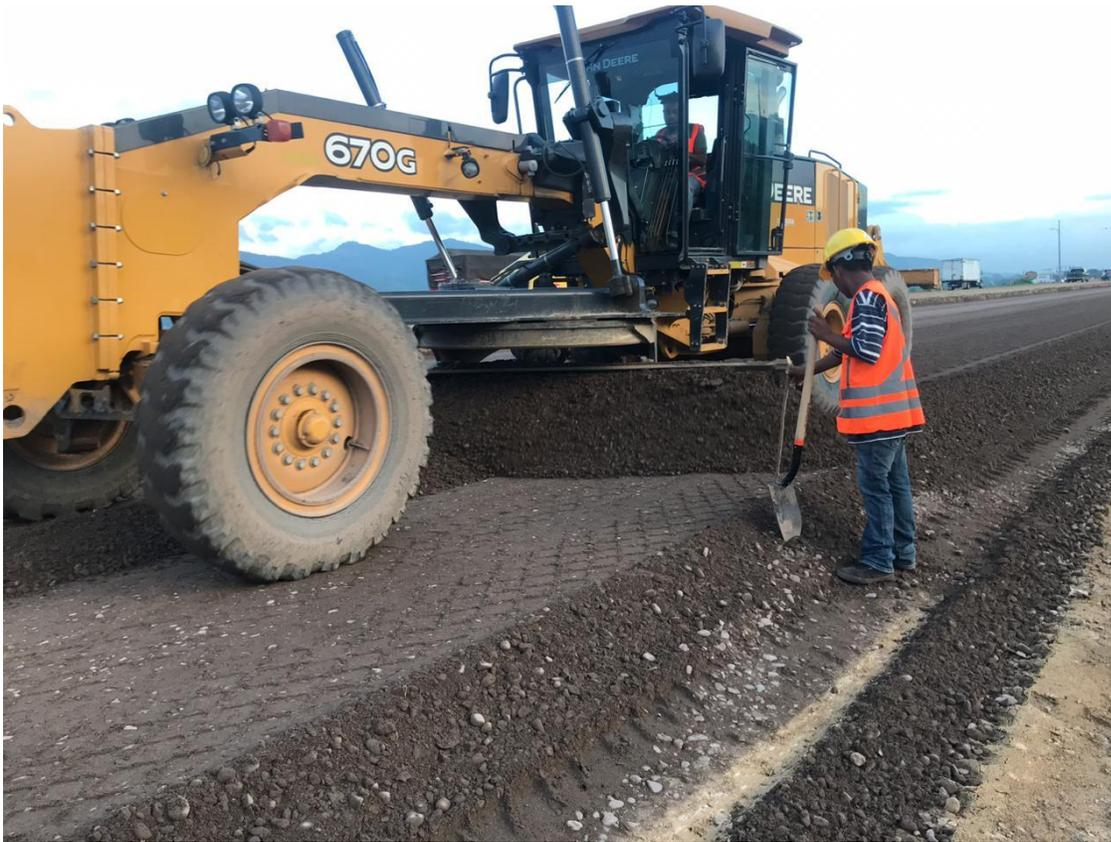
Fig5. *Colocación de base y subbase*
