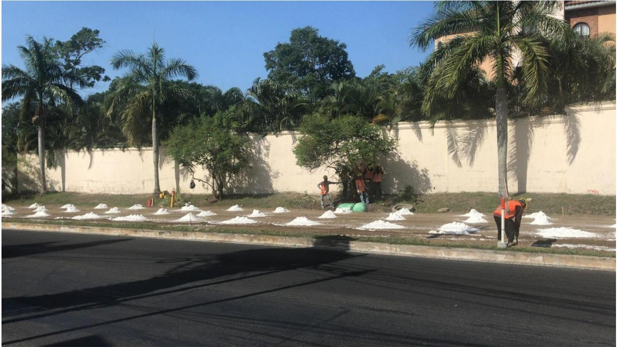
**Ilustración 10- Colocación de bolsas de cal en tramo a mezclar. Se utilizó 1 bolsa de cal por metro cúbico.**
