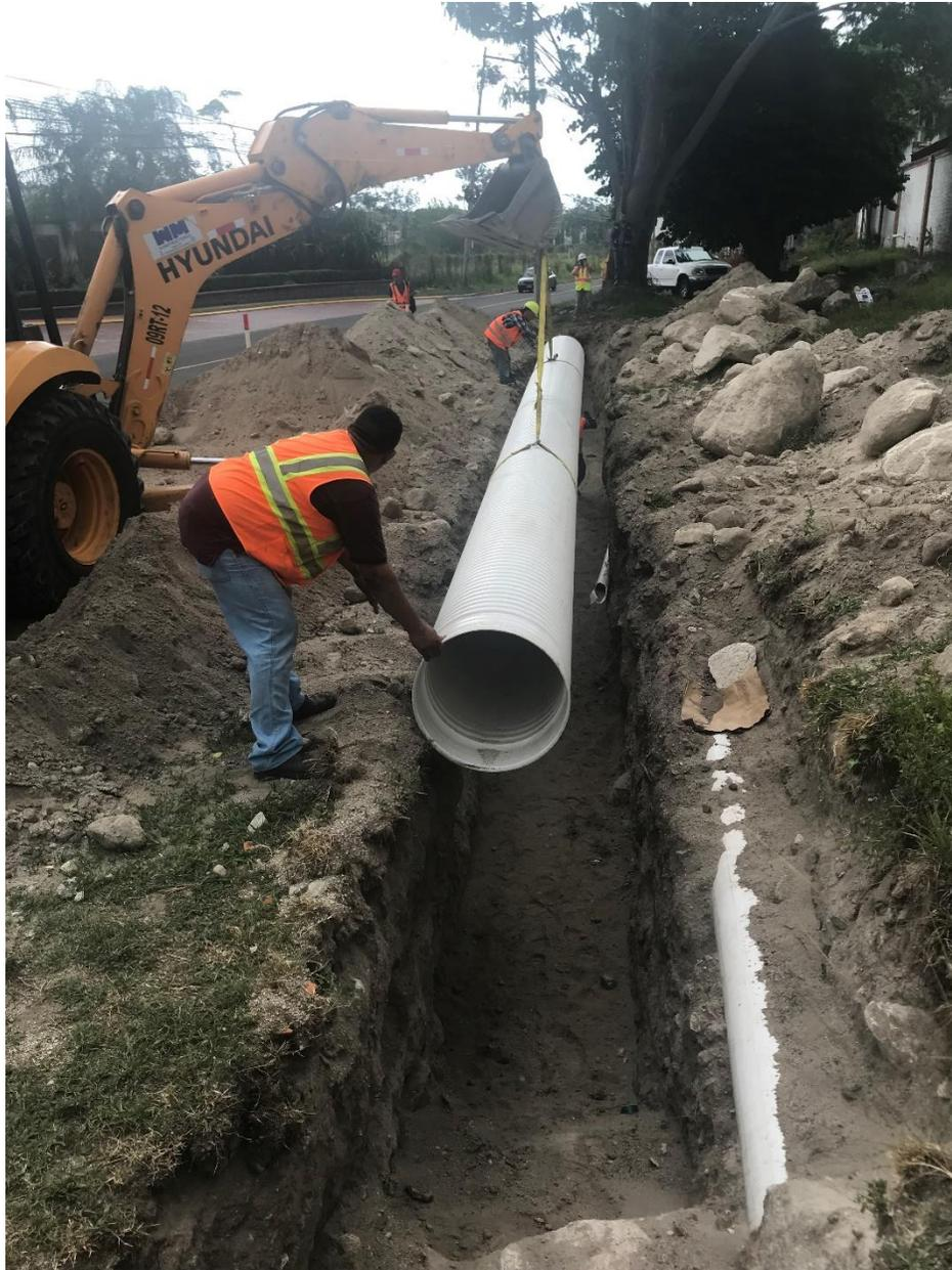
**Ilustración 3- Colocación de 3 lances de tubería en tragante #9.**
