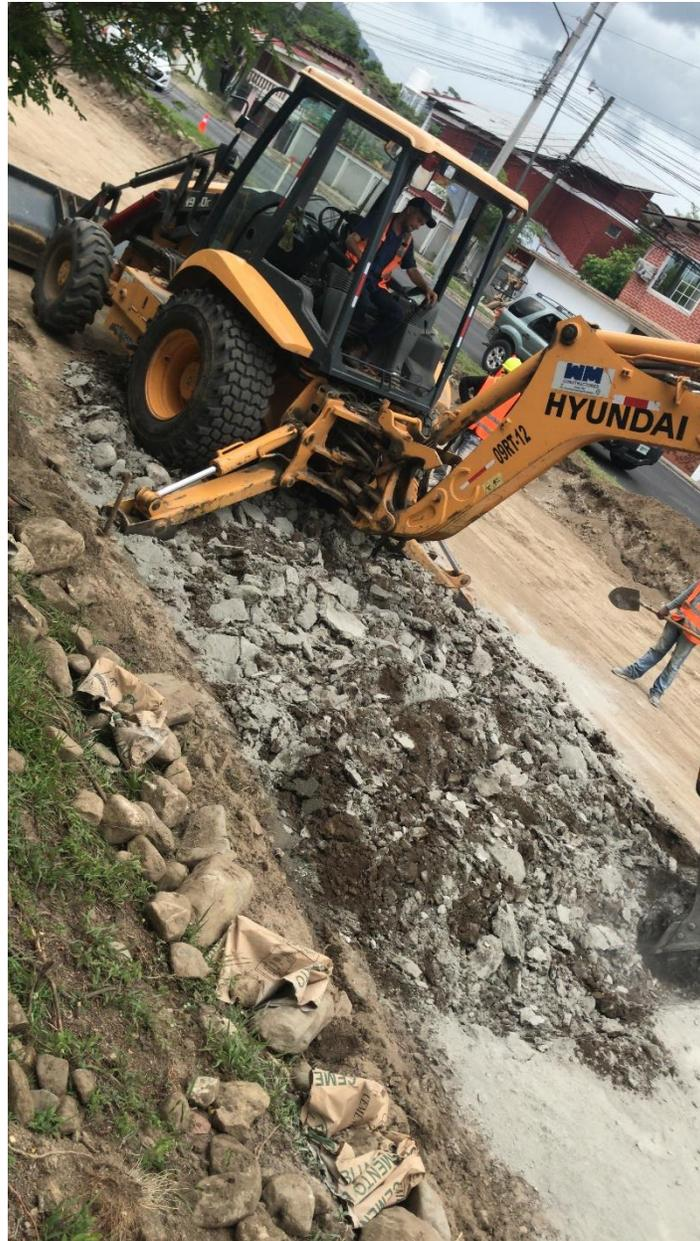
**Ilustración 11- Mezclando suelo-cemento a zona de hundimiento en el tramo.**
