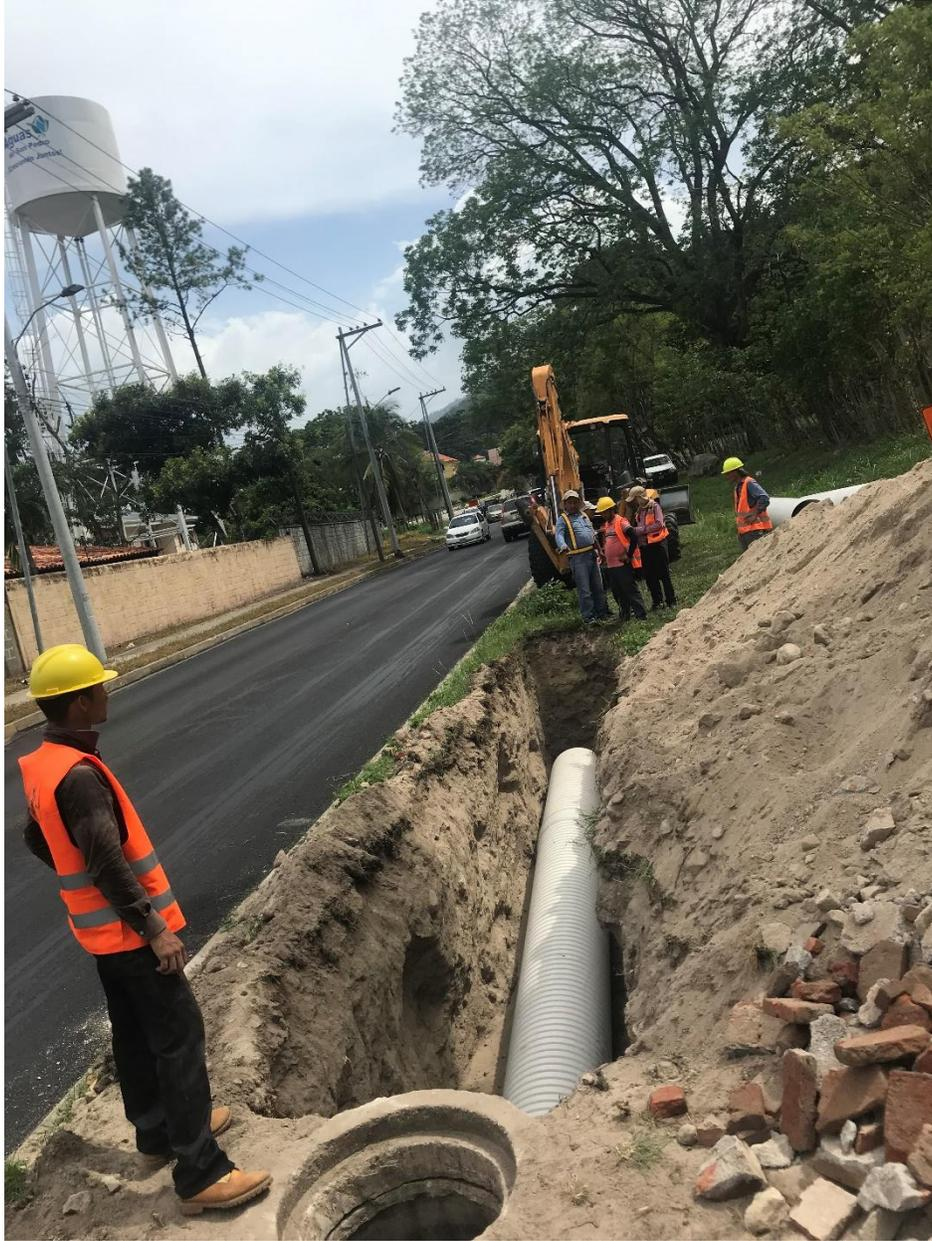
**Ilustración 5- Colocación de tubería en pozo #9.**
