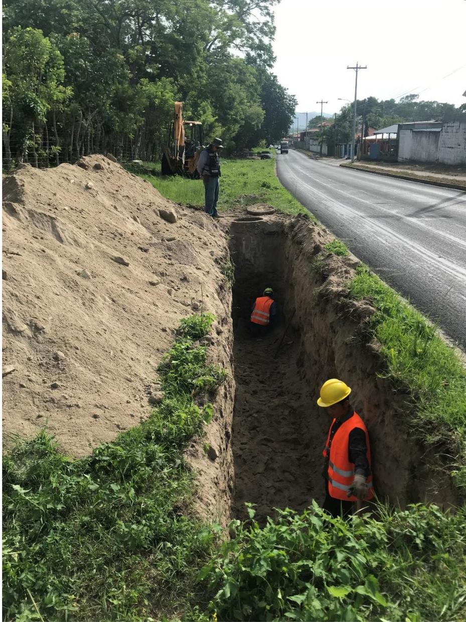
**Ilustración 4- Excavación de zanja para colocación de tubería en pozo #9.**
