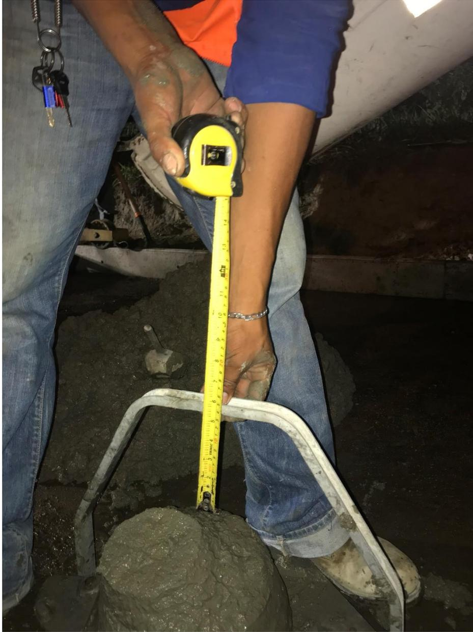
**Ilustración 13- Realización de prueba de revenimiento para asegurarse que este dentro del rango establecido.**
