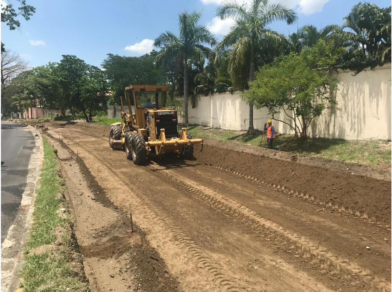
**Ilustración 6- Mezcla de suelo para subbase, de la estación 0+520 hasta la 0+715.**
