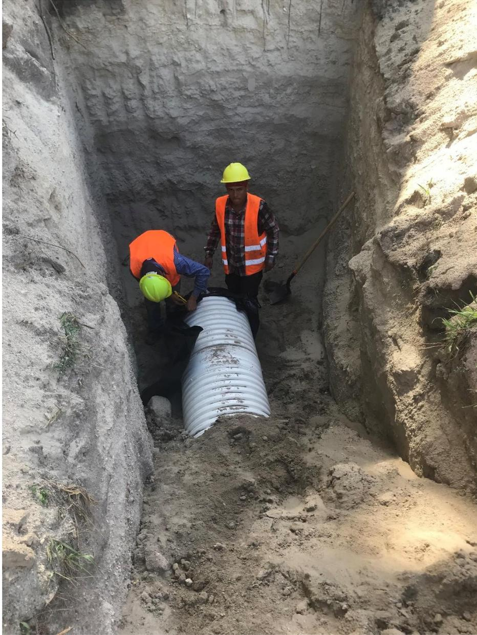
**Ilustración 2- Colocación de tubería para tragante #7.**
