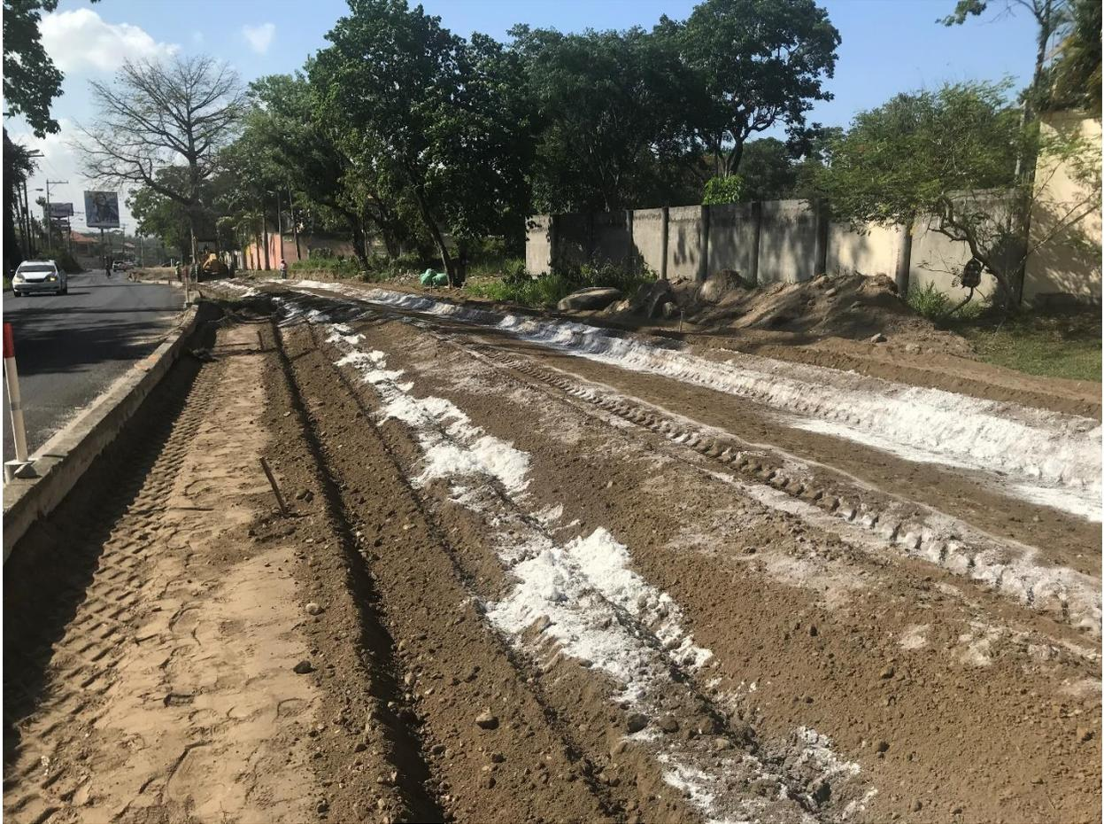
**Ilustración 8- Mezcla de suelo-cal, desde la estación 0+520 hasta la 0+715.**
