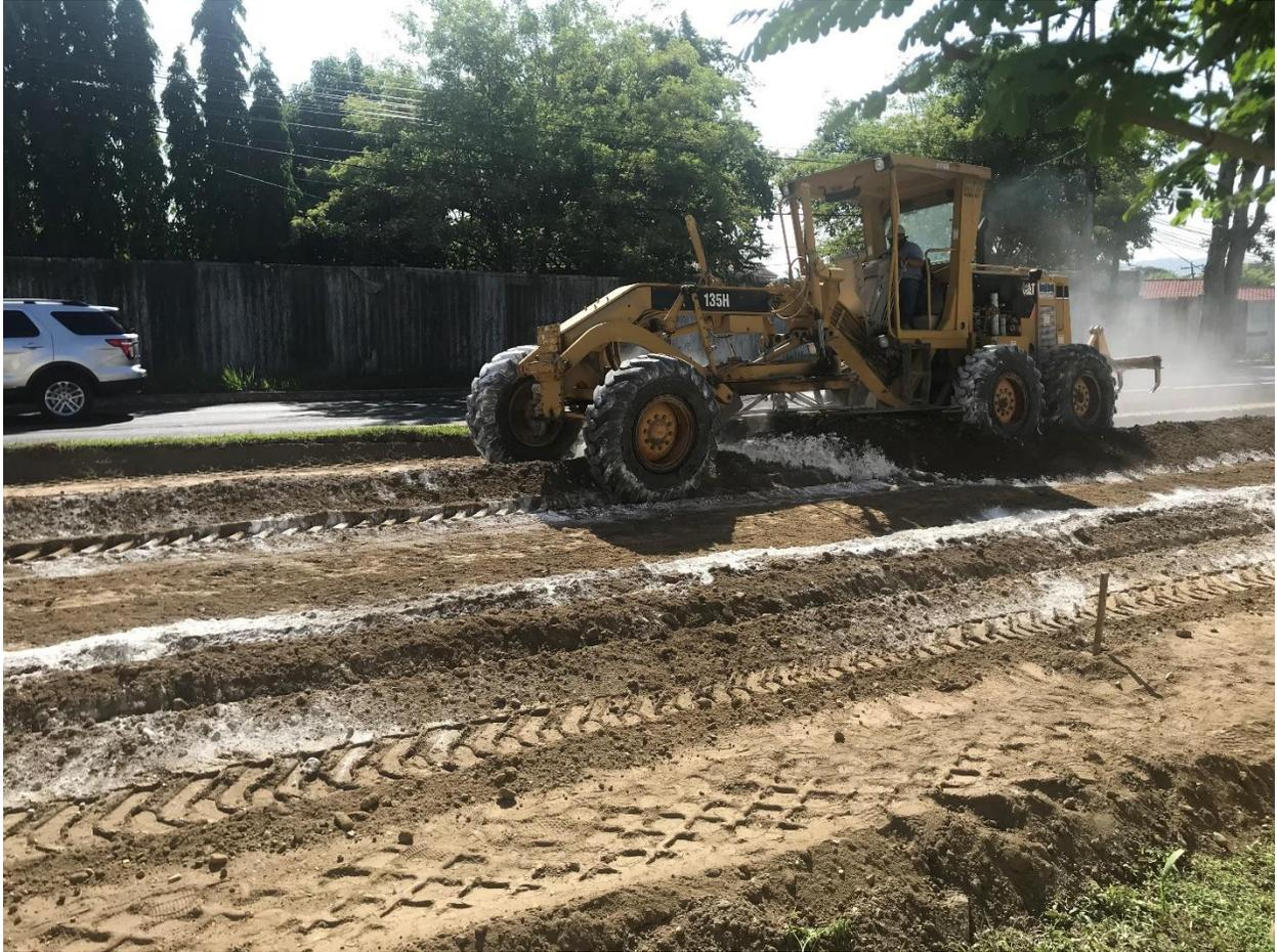
**Ilustración 9- Motoniveladora realizando cordones para mezcla.**
