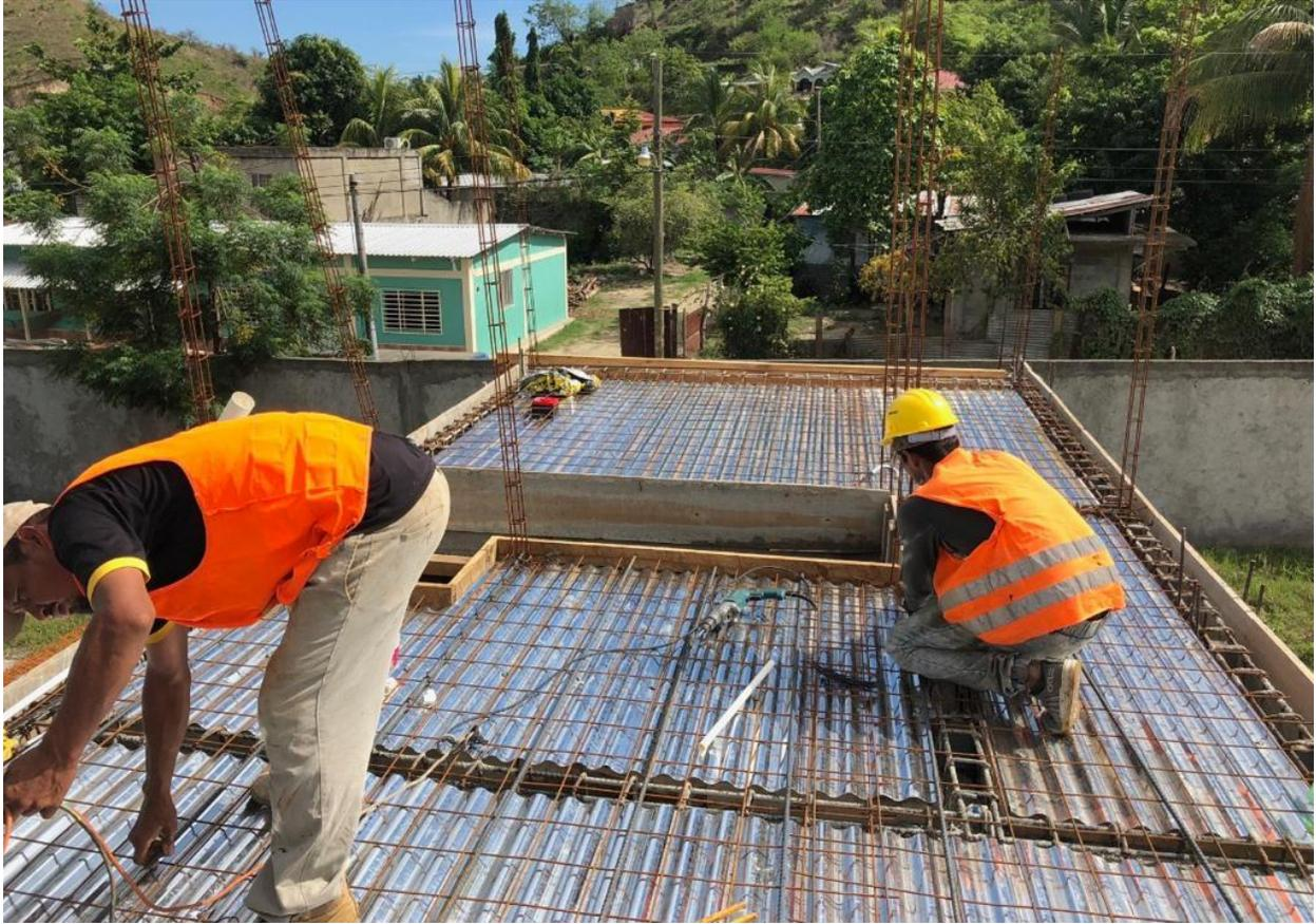
*Ilustración 25 instalación de encofrado de casa 10ab y malla electro soldada*
