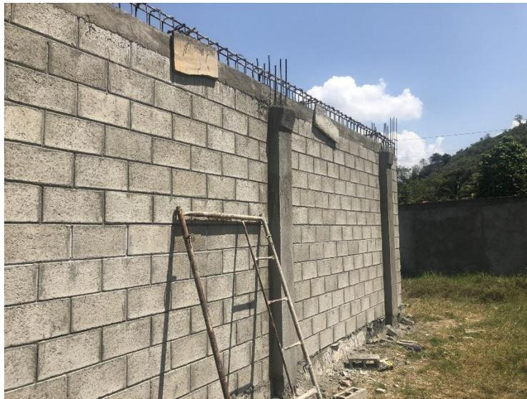
*Ilustración 20 tallado de columnas externas en casa 10ab*
