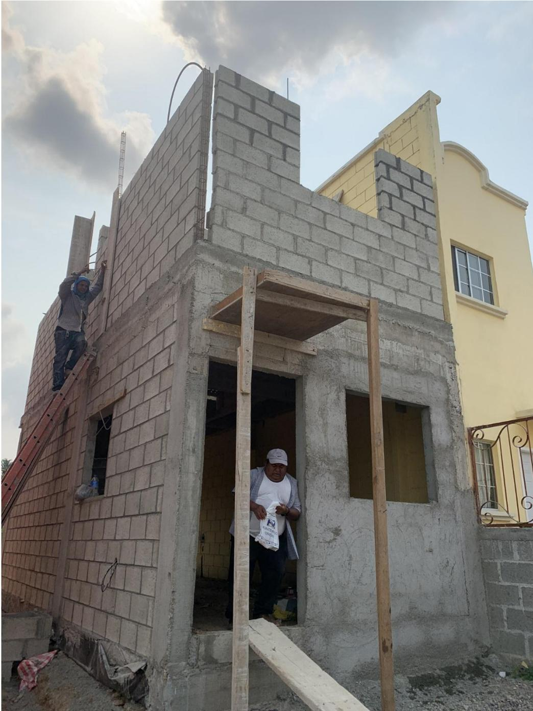
*Ilustración 5 Fundición de losa frontal y continuación de pegado de bloques*
