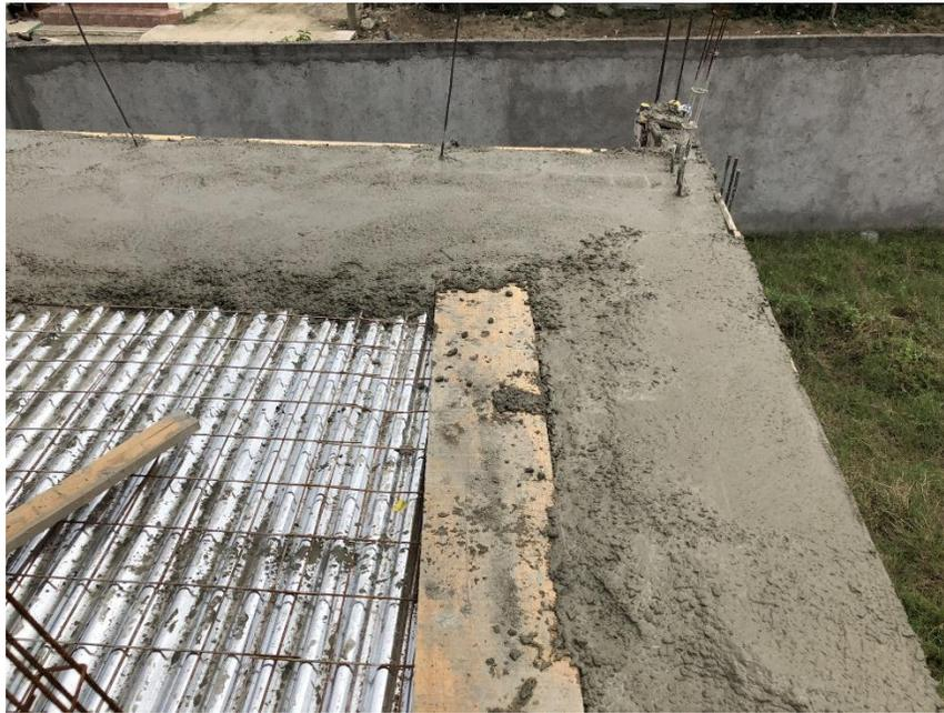
*Ilustración 28 Fundición de losa en casa 10AB*
