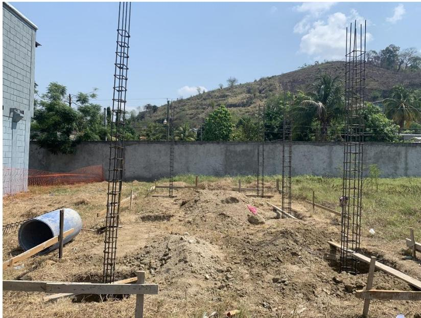
*Ilustración 18 Revisión de zapatas y columnas previo a fundición en casa 10ab*
