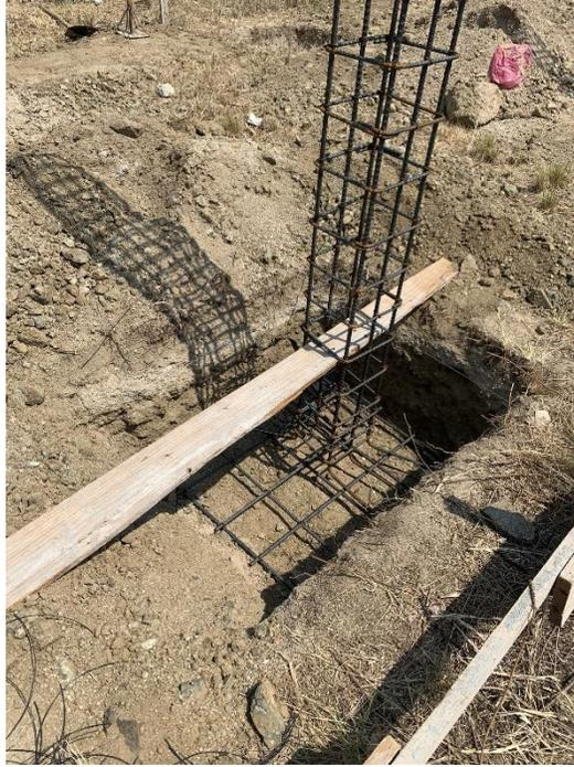
*Ilustración 17 Zanjeado y colocación de zapatas y columnas en casa 10ab*
