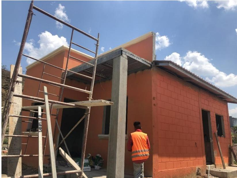
*Ilustración 22 fundición de losa frontal y primera mano de pintura exterior*
