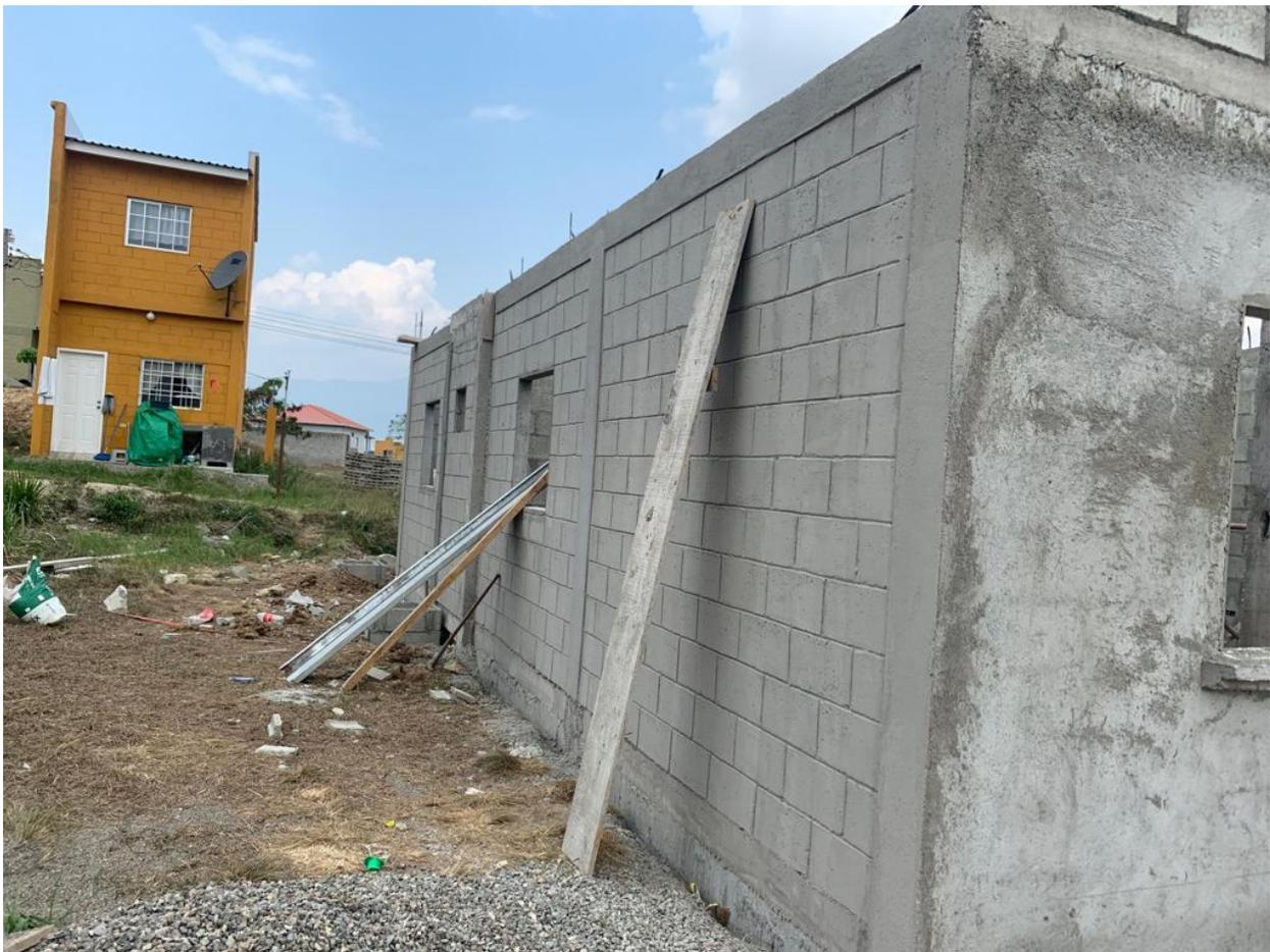
*Ilustración 2 Tallado de columnas y sellado de pared con lechado de cemento*
