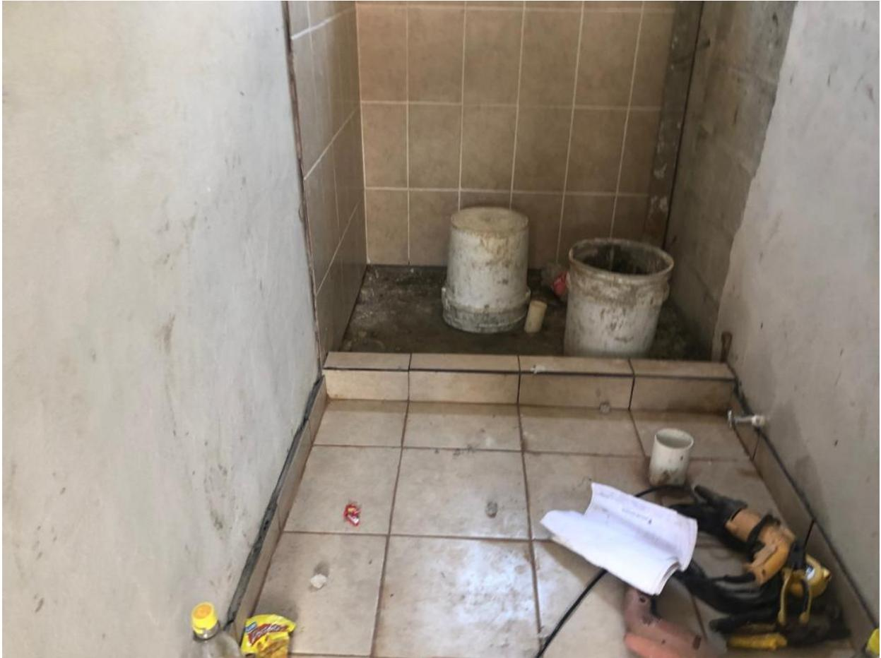
*Ilustración 24 instalación de cerámica en baño de casa 12f*
