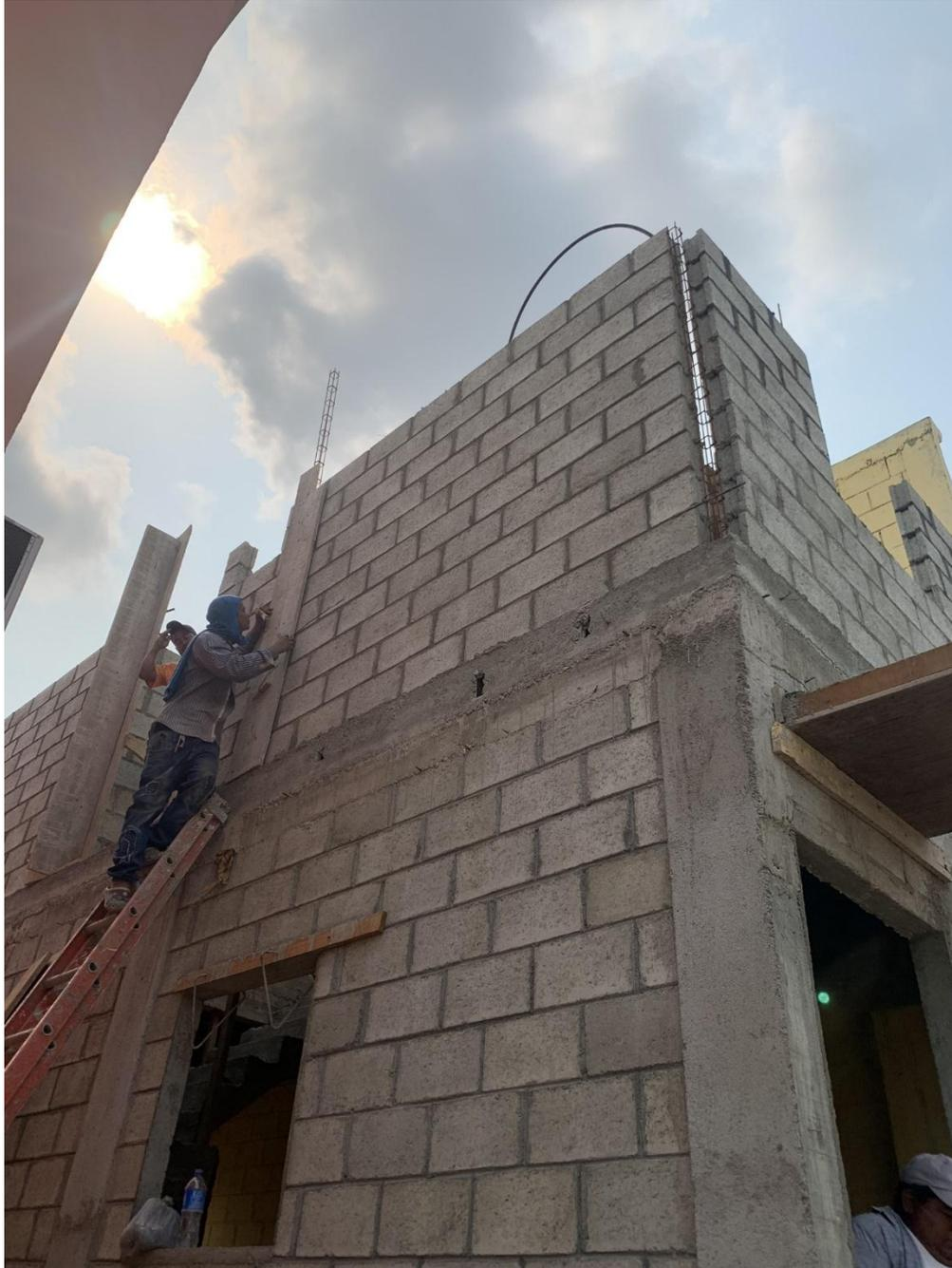
*Ilustración 4 Pegado de bloques en segundo nivel en casa 4F , así como el enconfrado de castillos*
