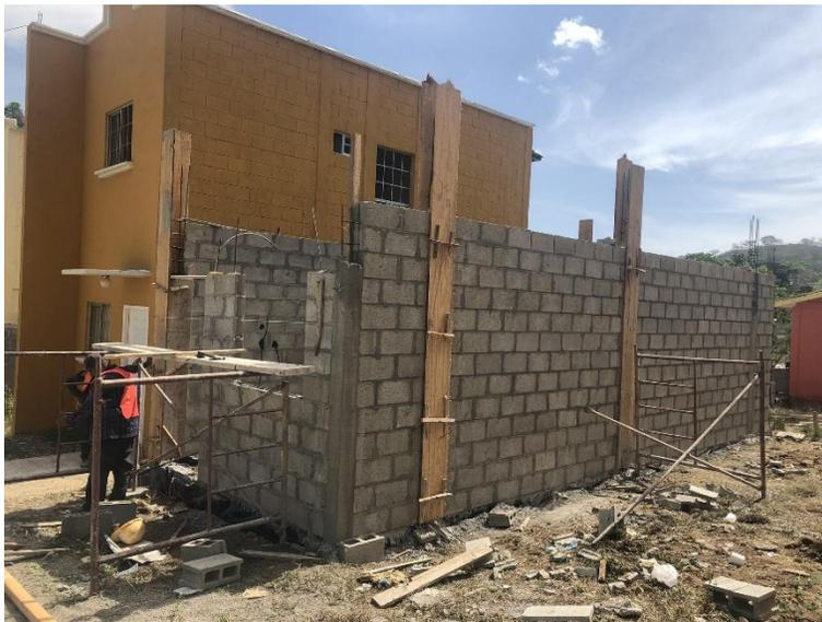
*Ilustración 30 encofrado de columnas y avance de pegado de bloques en casa 6f*
