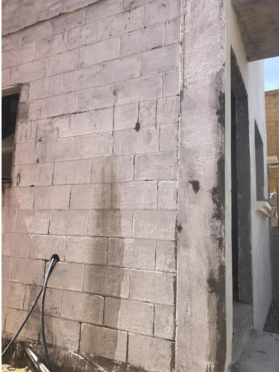
*Ilustración 31 Sellado de bloque con lechada de cemento blanco*
