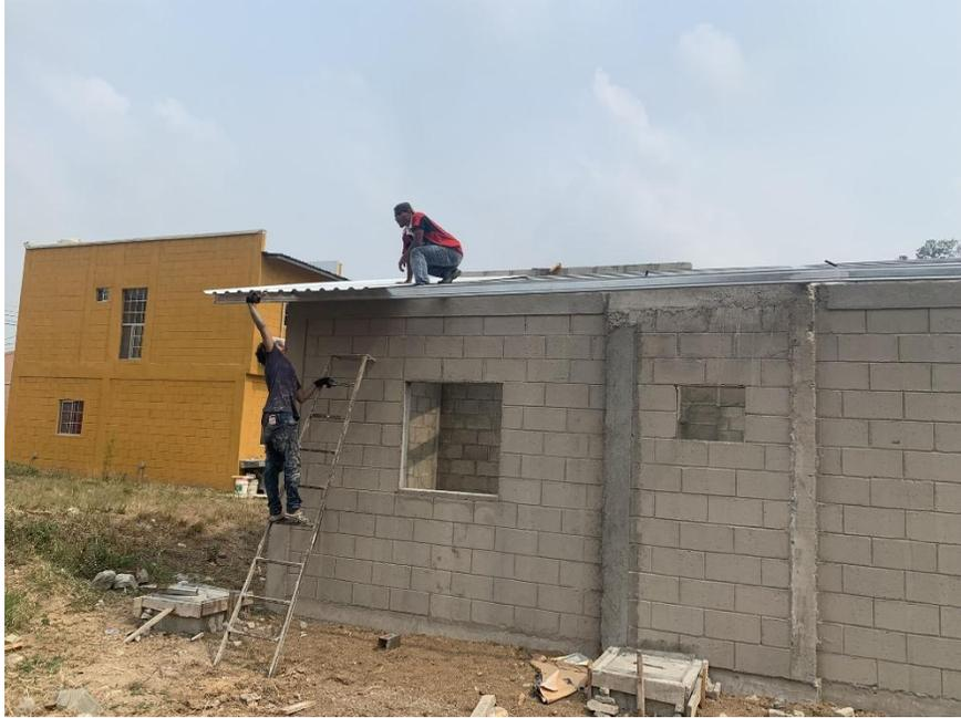
*Ilustración 15 Instalación de techo en casa 12F*
