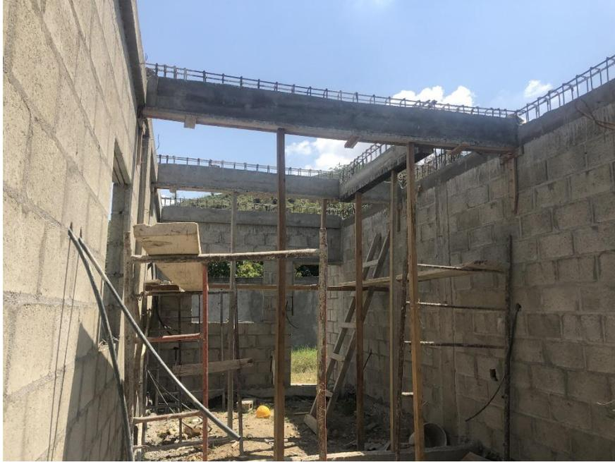
*Ilustración 21 Fundición de media viga de entepiso en casa 10ab*
