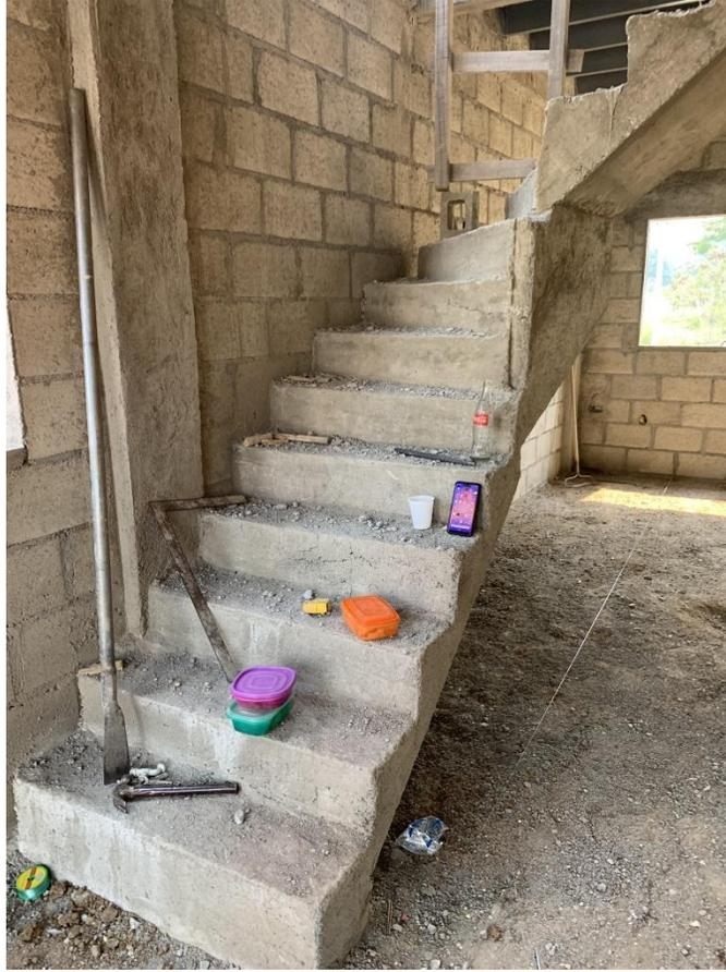
*Ilustración 13 Desencofrado de grada y revision de nivel de firme*
