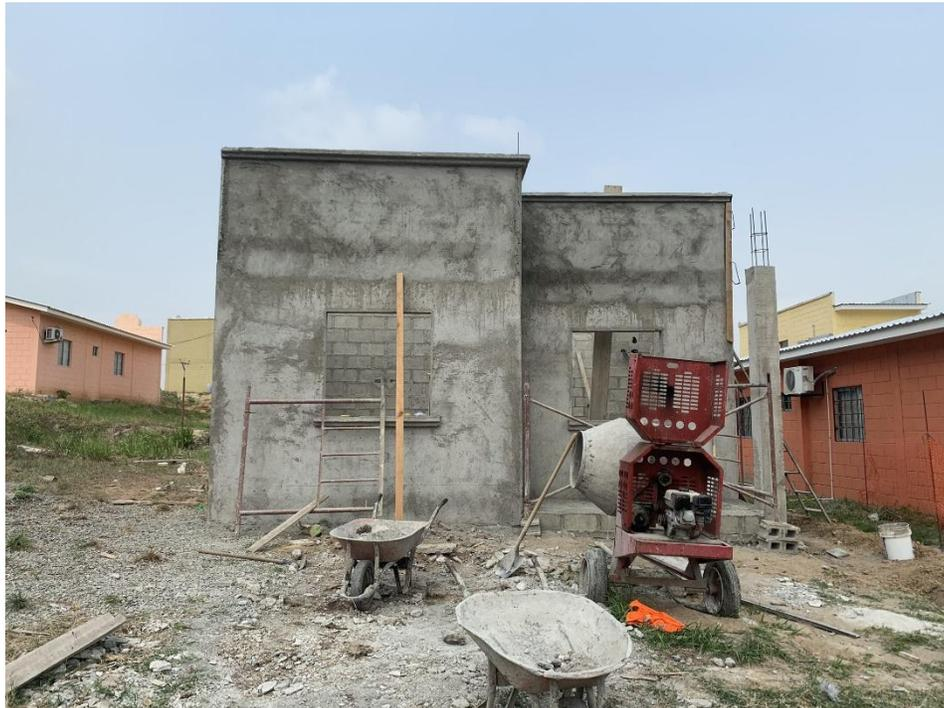
*Ilustración 7 Repello de fachada de casa 12f y fundición de moldura superior*
