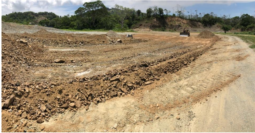
Figura 31. Corte de material granular.
