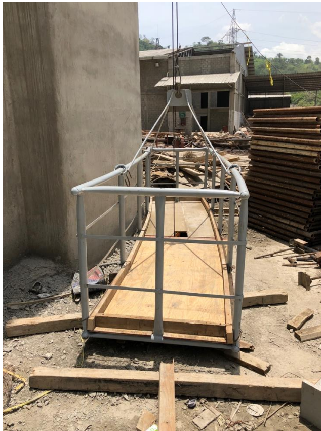
Figura 28. Canasta para tensado de torones.
