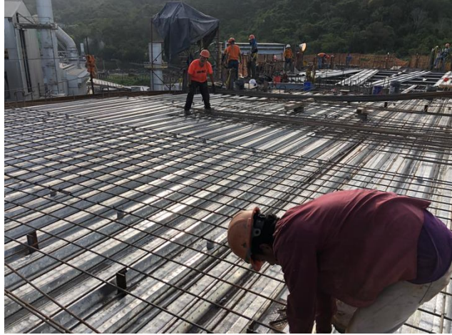
Figura 23. Colocación de acero por temperatura.
