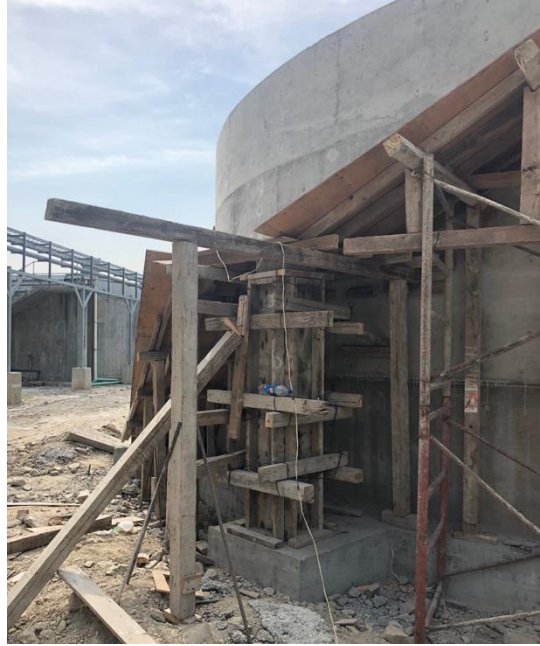
Figura 15. Encofrado de escalera de tanque clarificador.
