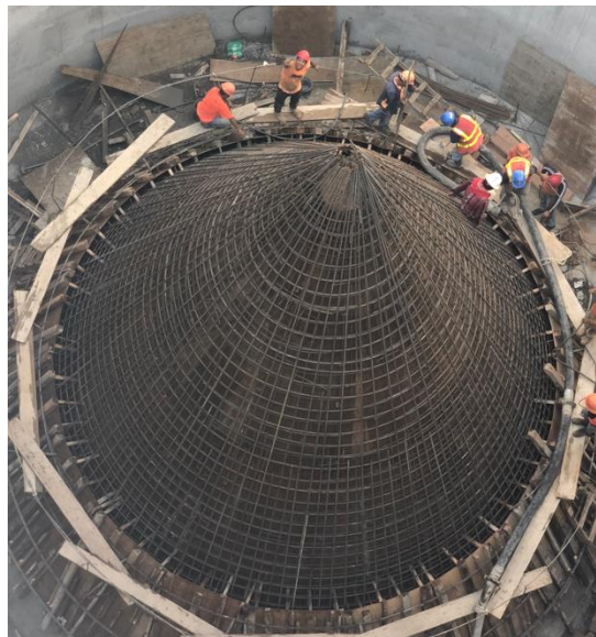
Figura 18. Fundición de segundo tramo del cono de concreto reforzado del silo 14.
