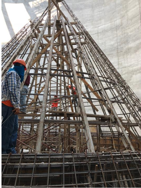
Figura 11. Colocación de vigas verticales y varillas radiales para encofrado interior de cono de concreto reforzado.
