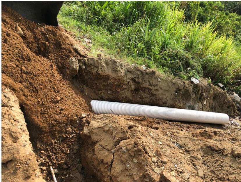
Figura 32. Colocación de tubería Novafort de 12" para drenaje de aguas lluvias.
