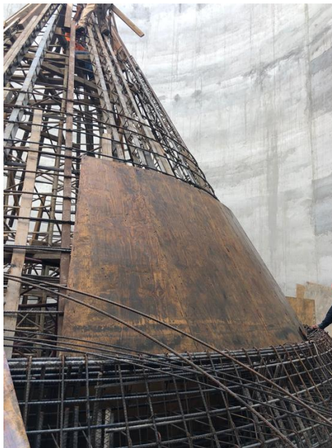
Figura 12. Inicio del encofrado interior de cono de concreto reforzado.
