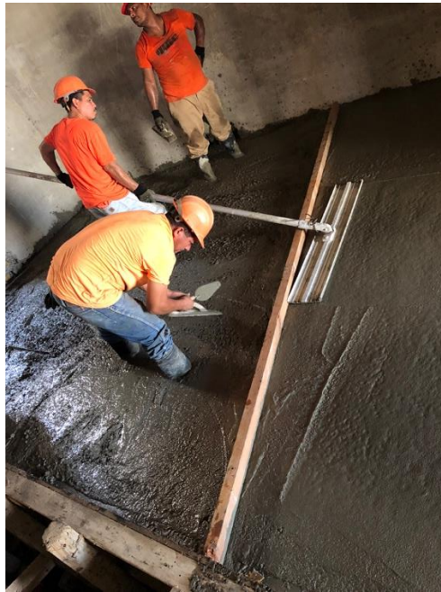
Figura 1. Fundición de losa de concreto reforzado nivel 6.80 msnm., silo 13.
