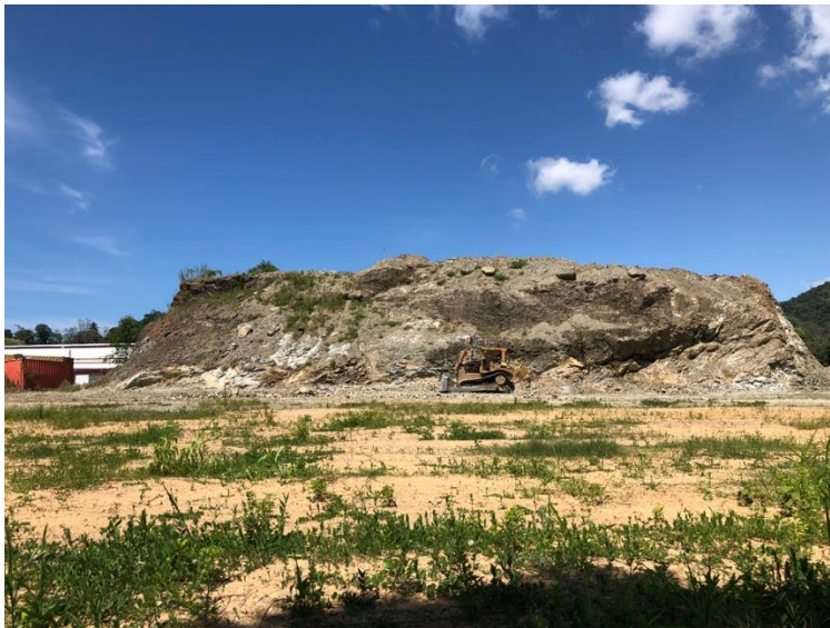
Figura 30. Remoción de capa vegetal.
