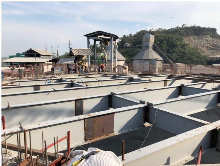
Figura 4. Colocación de vigas H nivel 36.00 msnm silo 14.
