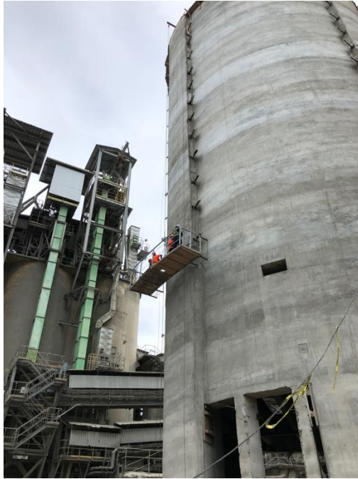
Figura 29. Canasta realizando la primer prueba con personas.
