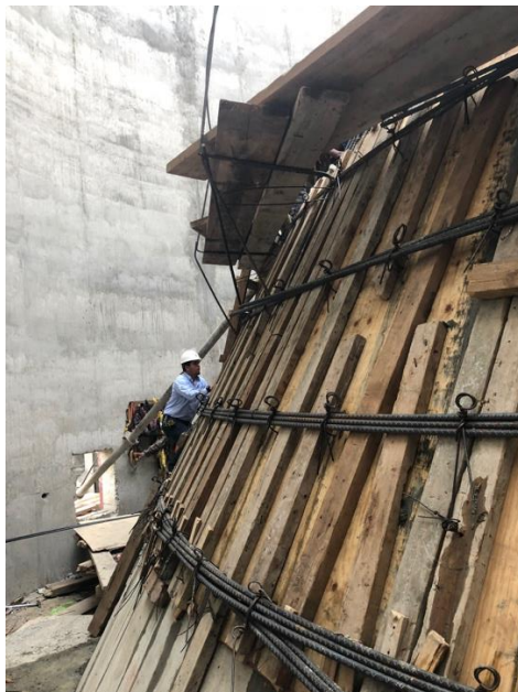
Figura 2. Fundición de cono de concreto reforzado nivel 10.80 msnm., silo 13.
