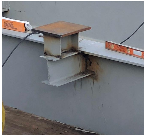
Figura 20. Placa de anclaje sobre vigas principales.
