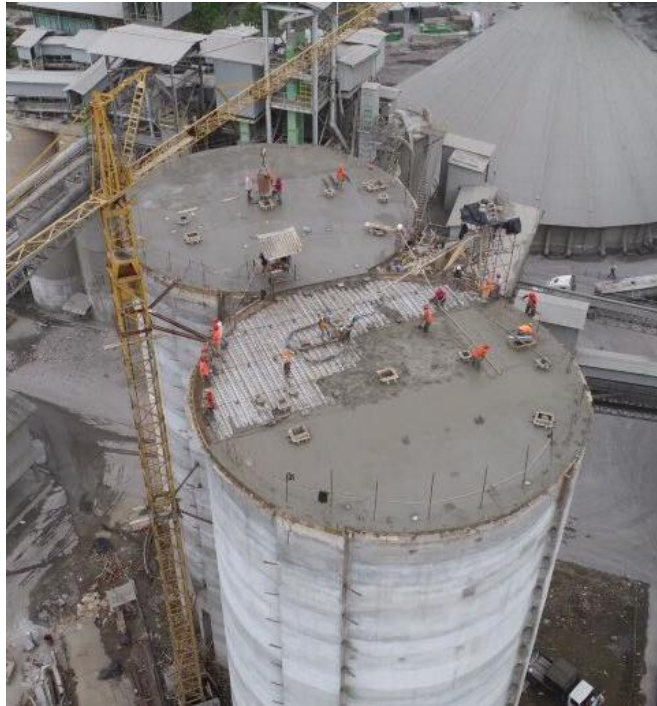
Figura 24. Fundición de losacero de cerramiento, nivel 36 msnm.
