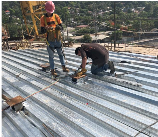
Figura 22. Cerramiento de silo 14 con canaleta cal. 20.
