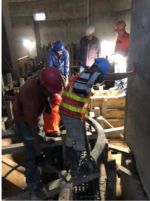
Figura 9. Fundición de 11 m 3 de concreto en traves de losa de concreto reforzado nivel 6.80 msnm., silo no. 14.
