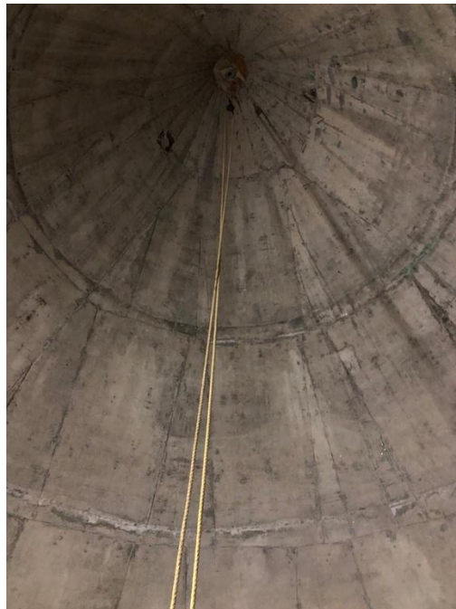
Figura 26. Desencofrado interior de cono de concreto reforzado.
