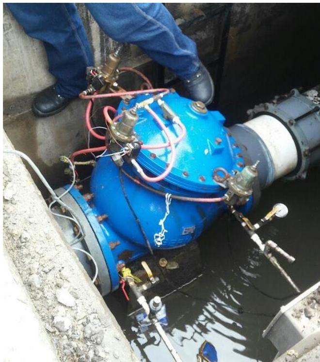
**Ilustración 4.** Válvula reguladora de presión ya instalada y en funcionamiento.
