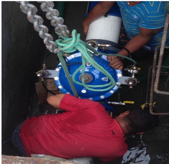
**Ilustración 2.** Colocación de la válvula reguladora en tubería existente.
