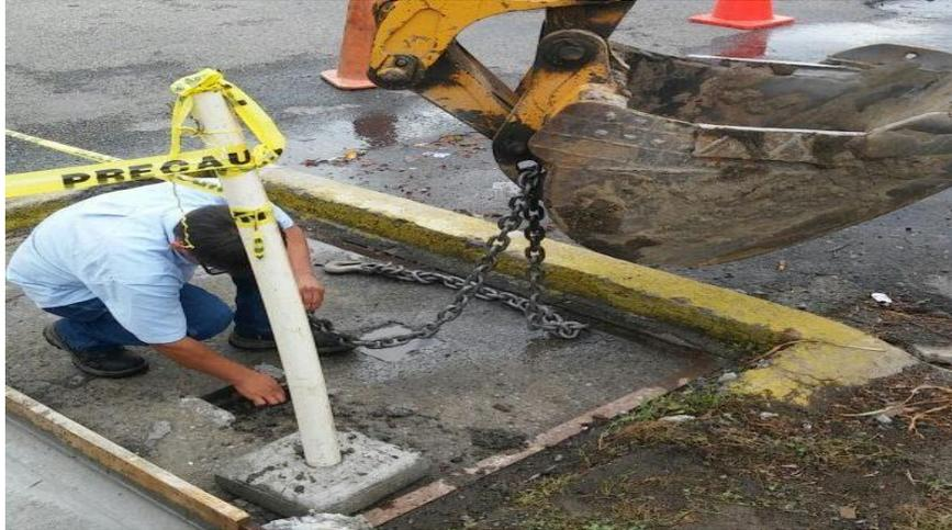
**Ilustración 3.** Reparación de tapadera de válvula reguladora de presión, caja de distrito.
