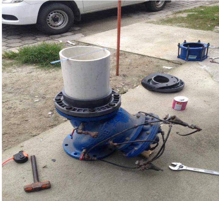
**Ilustración 1.** Armado de válvula reguladora de presión de 10" para distrito de agua potable.
