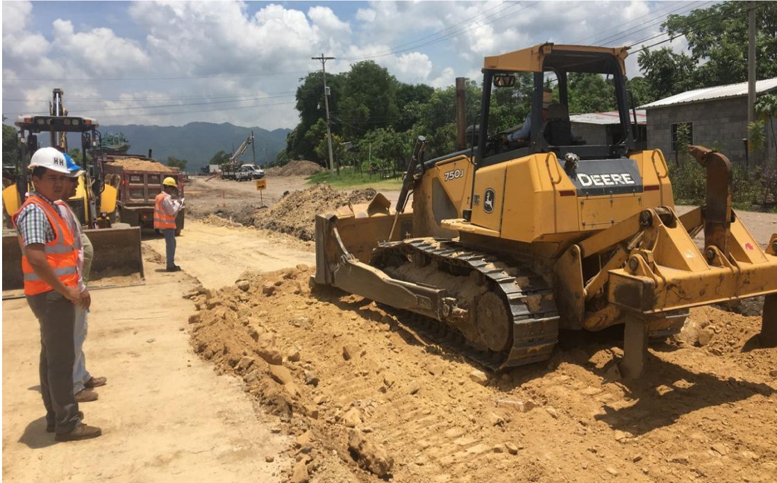
Ilustración 1. Colocación de relleno con material selecto en terraplén
