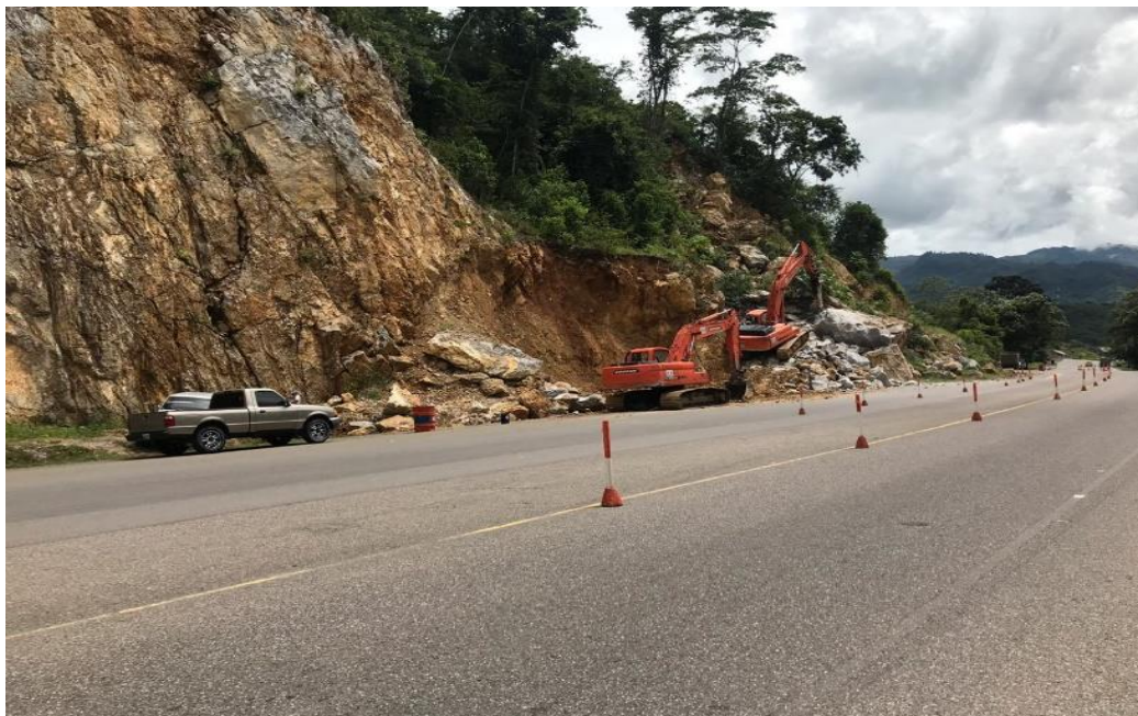
Ilustración 4. Remoción de material producto de derrumbe a la altura de Pito Solo
