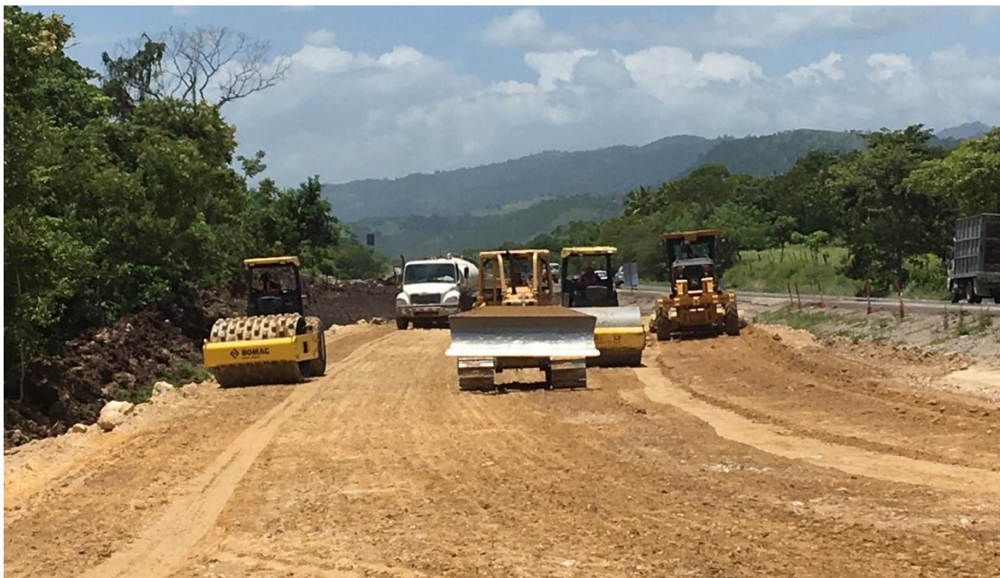
Ilustración 2. Conformación de relleno y compactación de material en terraplén
