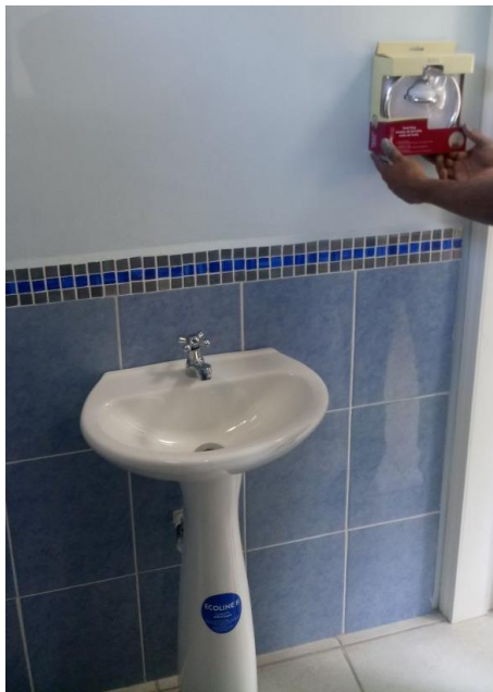
Ilustración 6. Instalación de accesorios para baño.
