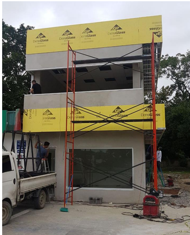
Ilustración 4.. Instalación de DenGlass para fascia Fontal.
