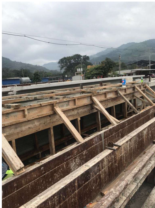
Figura 24. Encofrado De Madera De Losa.
