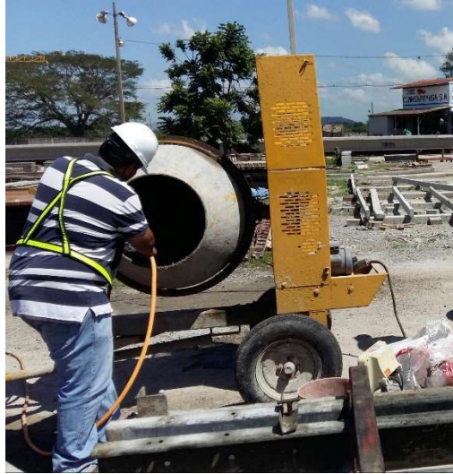
Figura 8. Lavado de Concretera para realizar mezclas de control de dosificación de concreto para postes de la tela.
