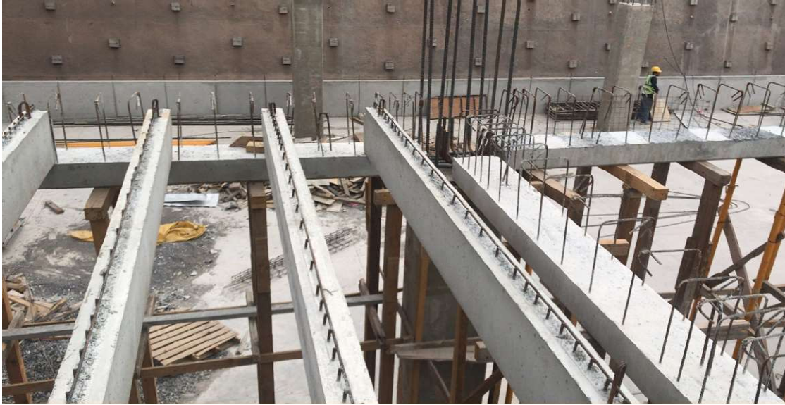
Figura 12. Colocación de Viguetas.
