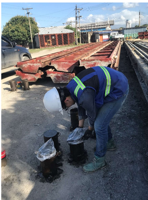
Figura 20. Cubrimiento De Cilindros De Concreto.
