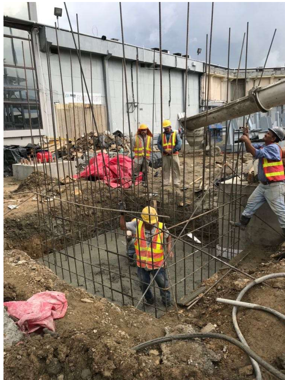
Figura 34. Fundición De Columna En Proyecto Megamall.
