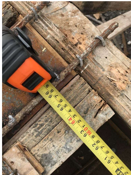
Figura 28. Inspección De Espaciamento Antes De Colar.
