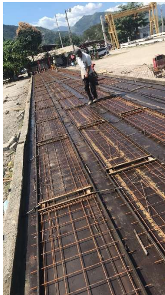
Figura 3. Armado de Losas de Concreto.
