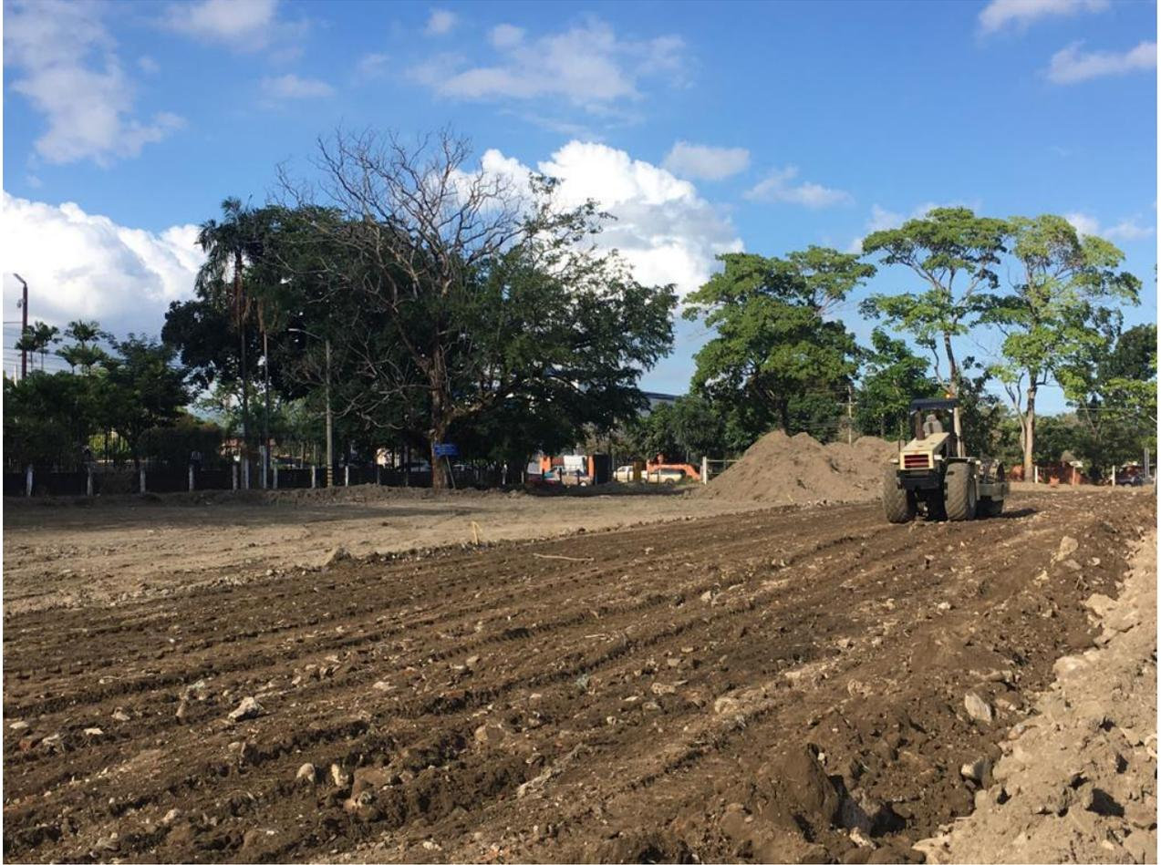
**Ilustración 9:** Proceso de Escarificado con Rodillo Pata de Cabra
