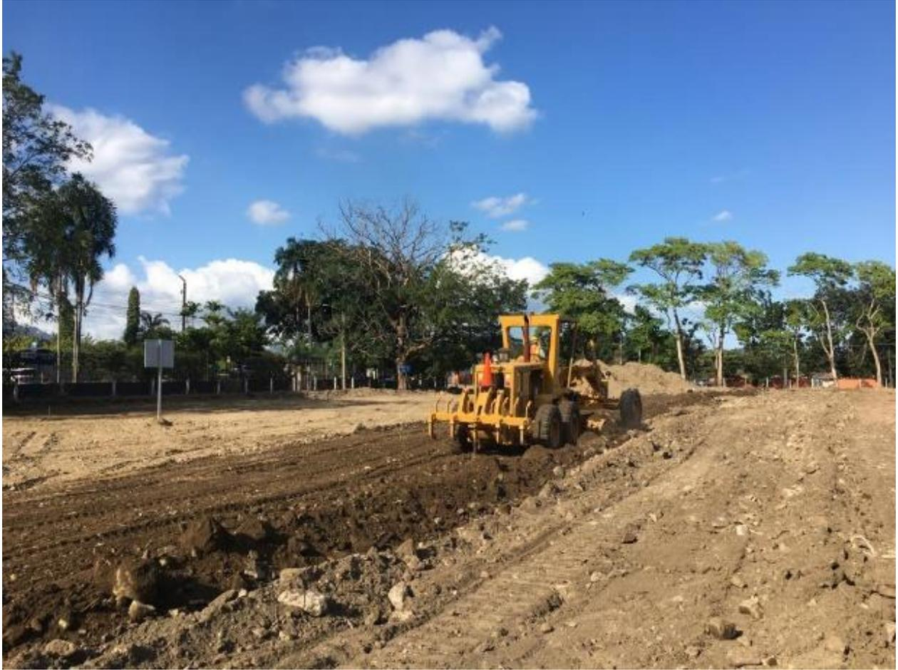
**Ilustración 8:** Patrol Escarificando superficie de Calle D
