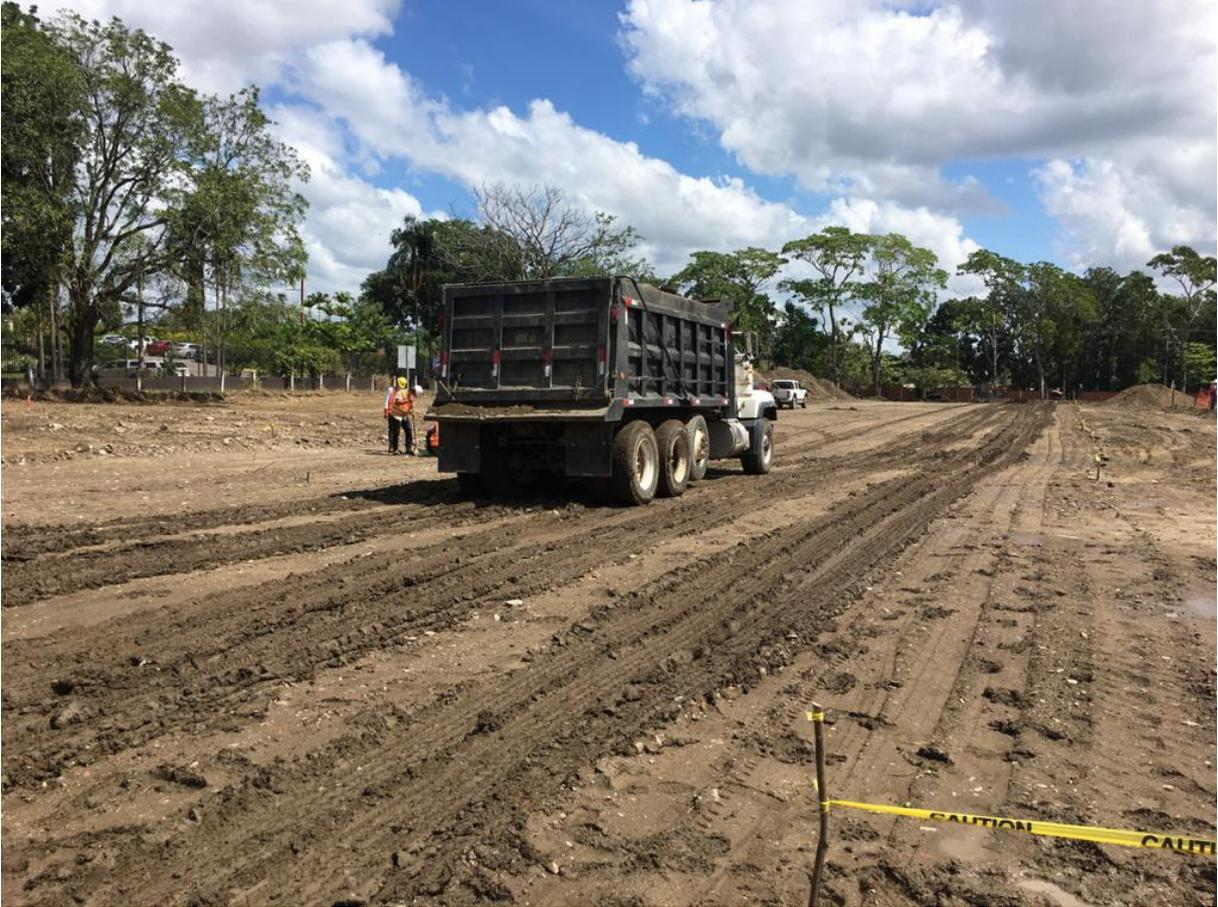
**Ilustración 11:** Prueba de carga de volqueta
