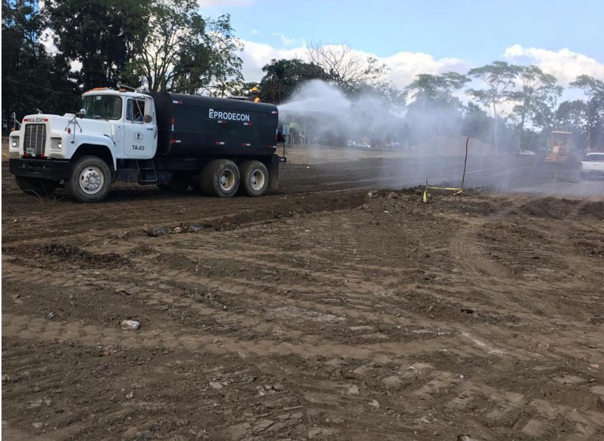
**Ilustración 10:** Parte de Escarificado de superficie con Cisterna de agua
