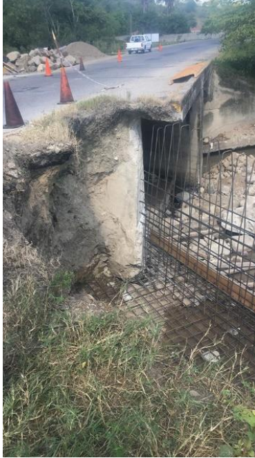
Ilustración 9. Reconstrucción puente en Ticamaya
