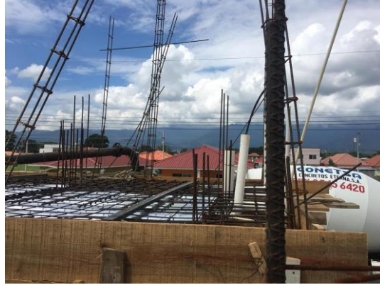
Ilustración 6. Losa segundo piso, Res. Costa Verde en San Pedro Sula
