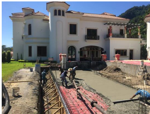
Ilustración 5. Losa en Portofino Hills
