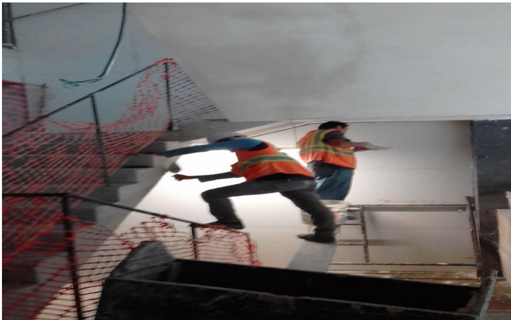
Ilustración 7 Tallado y pulido de escaleras
