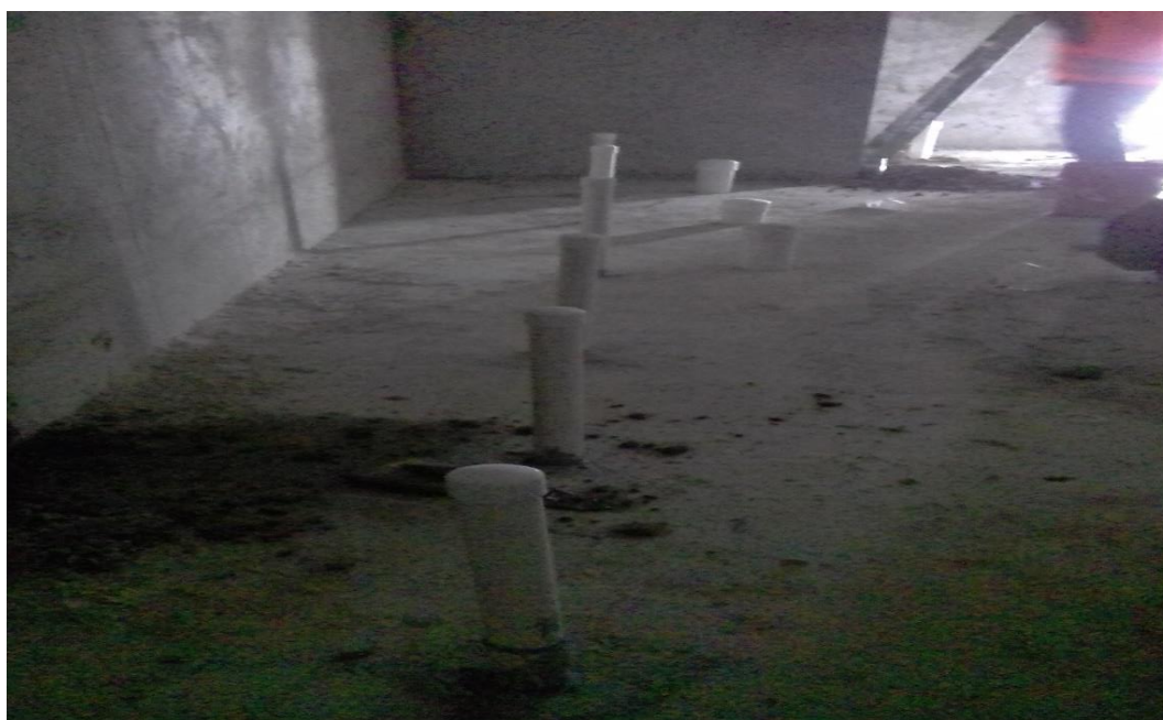
Ilustración 8 Instalación de tubería para baños
