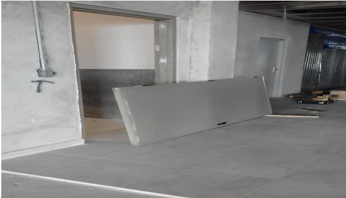
Ilustración 11 Instalación de puertas en el Hotel
