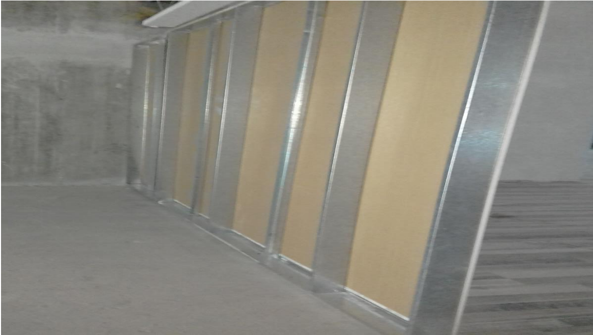
Ilustración 15 Instalación de paredes de tabla yeso.
