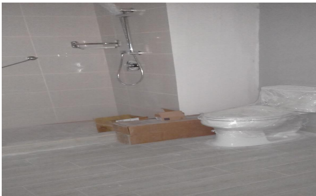
Ilustración 6 Instalación de los muebles de los baños
