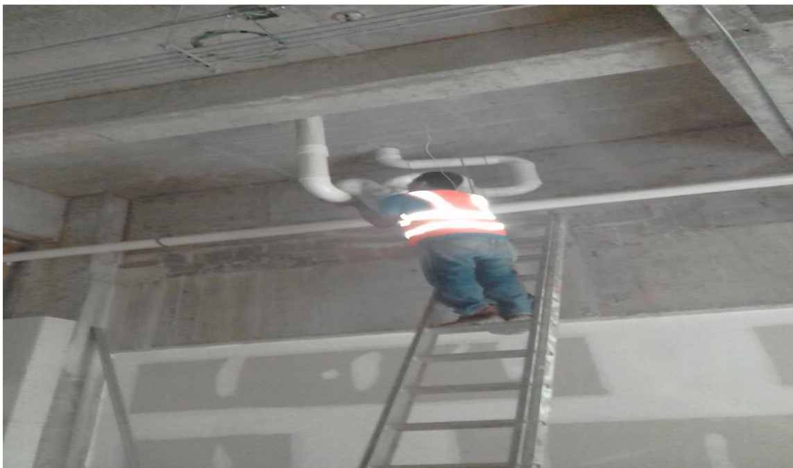
Ilustración 14 Instalación de trampas en tuberías de aguas lluvias
