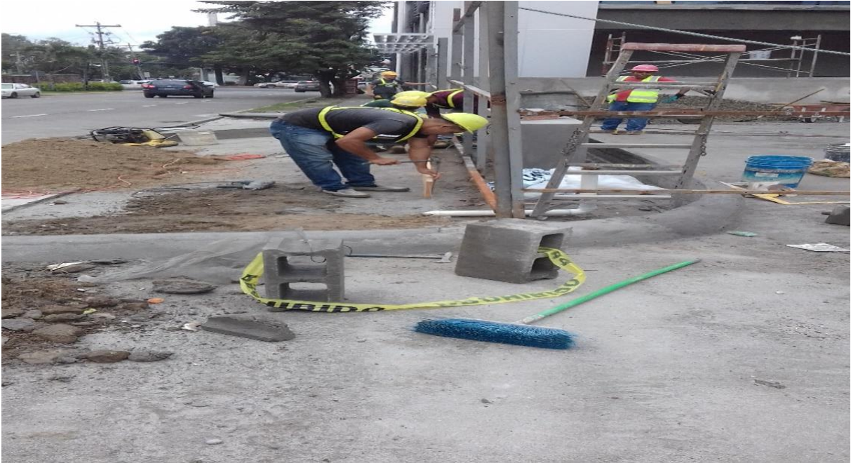
Ilustración 21 Construcción de la bahía en entrada al centro comercial.
