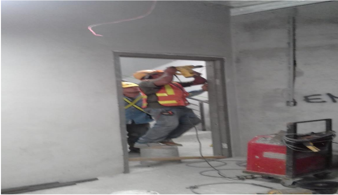
Ilustración 9 Instalación de marcos de puertas en gradas
