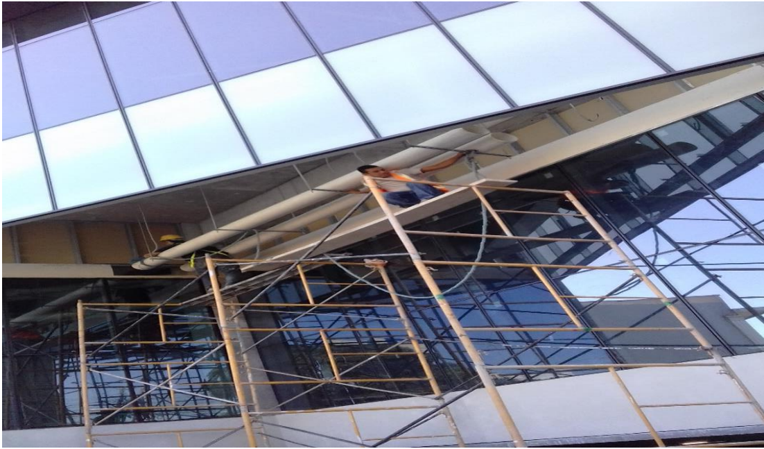
Ilustración 13 Instalación de tuberías bajante de aguas lluvias
