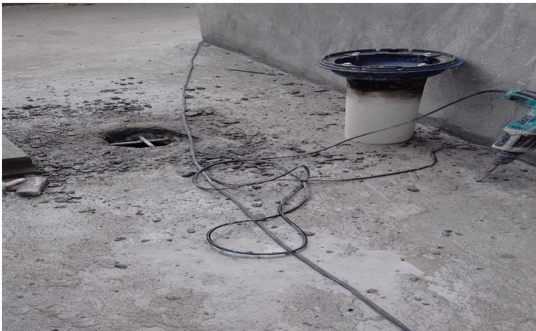
Ilustración 10 Instalación de coladeras para aguas lluvias
