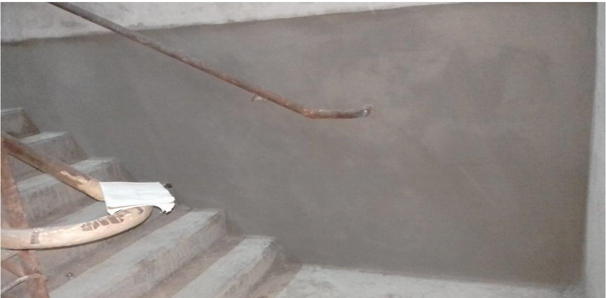
Ilustración 4 Pulido cubo de gradas de Oficinas
