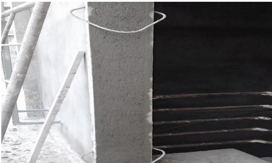
Ilustración 5 Tallado de marco de puertas
