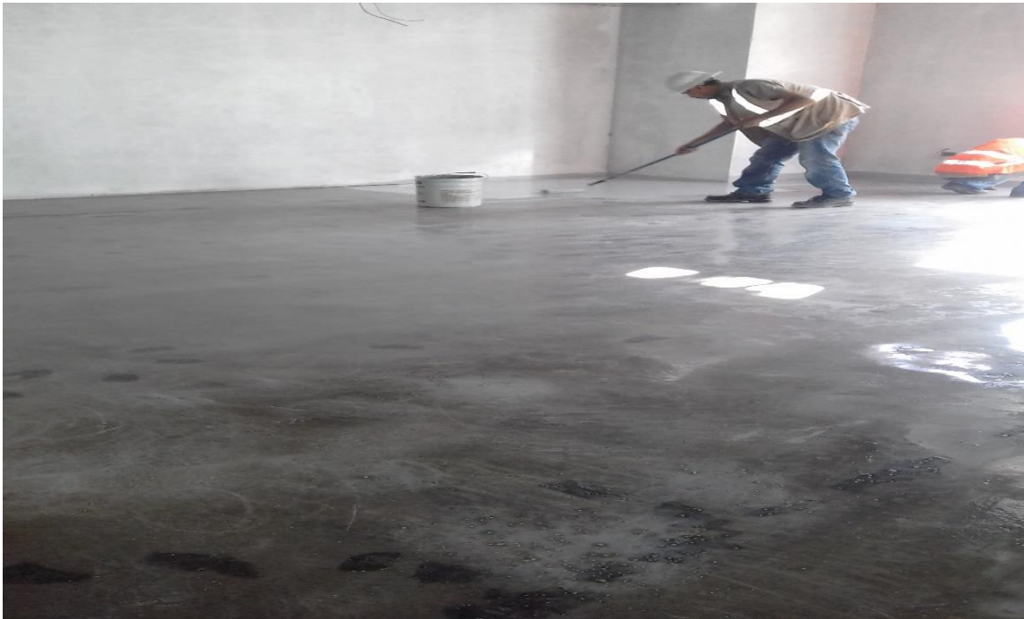
Ilustración 16 Aplicación de pintura epoxica en el piso.
