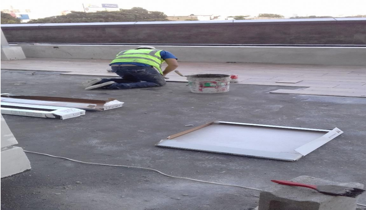
Ilustración 18 Instalación de cerámica en pisos.
