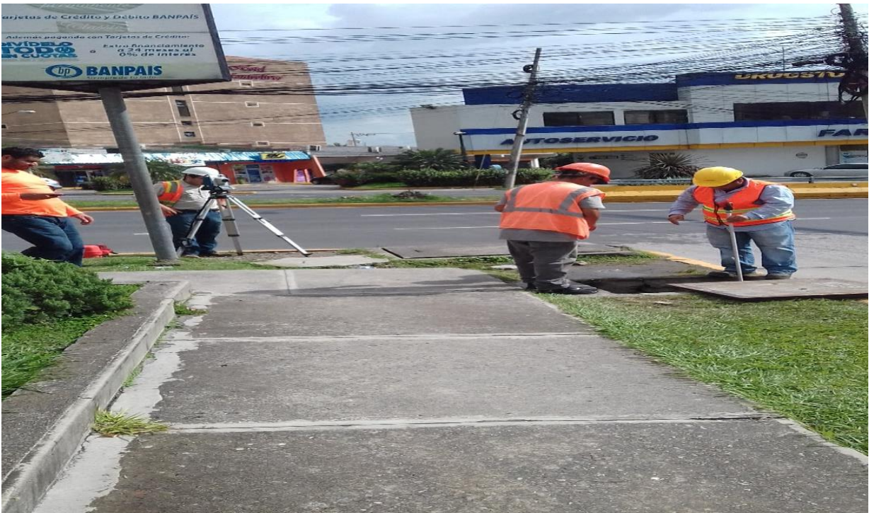
Ilustración 22 Levantamiento topográfico de tuberías de aguas negras.
