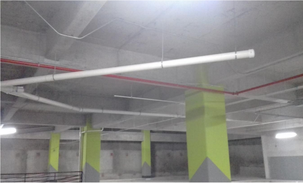
Ilustración 25 Instalación de mechas para tubería de locales.
