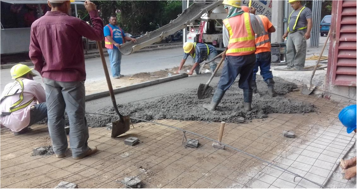
Ilustración 23 Fundición de acera de concreto.
