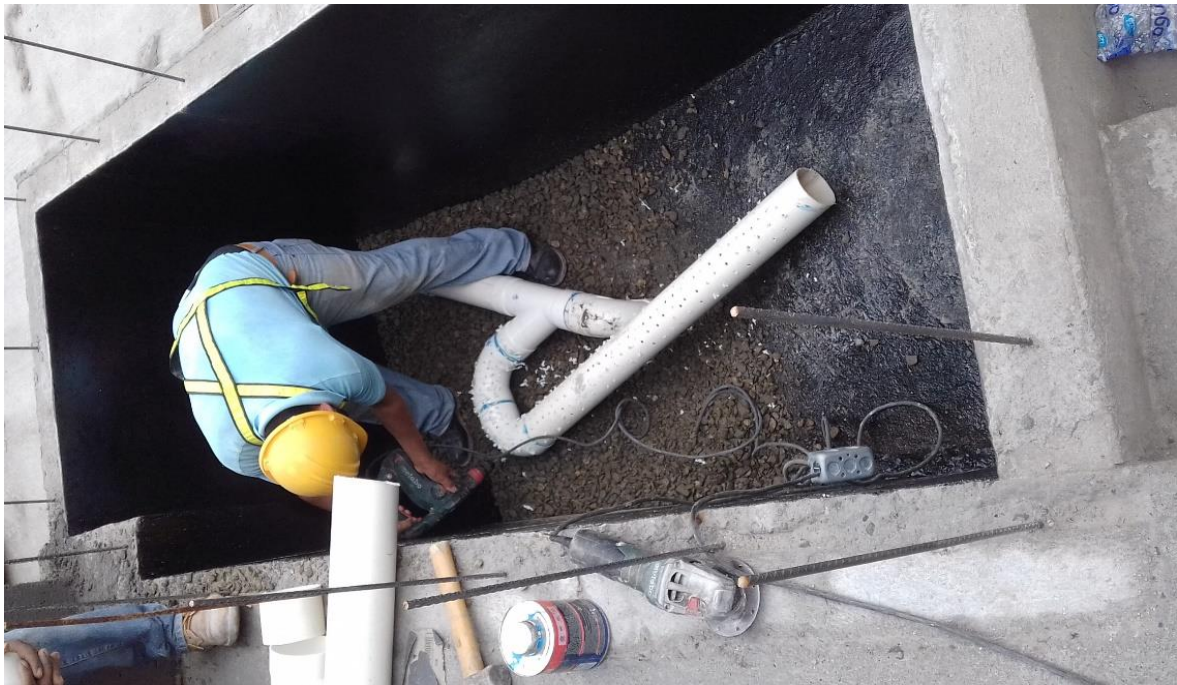
Ilustración 20 Instalación de tuberías para coladeras de jardineras.
