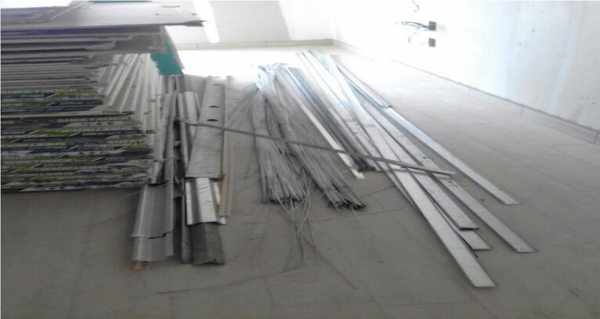
Ilustración 1 Materiales disponibles en edificio de Hotel
