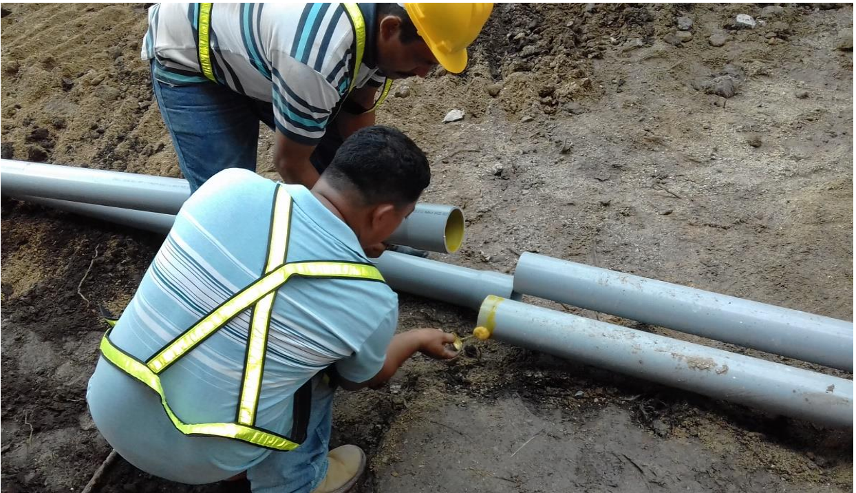
Ilustración 24 Instalación de tubería eléctrica.
