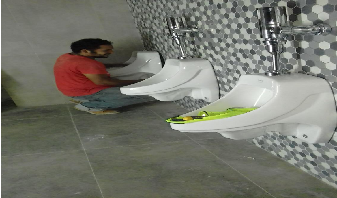
Ilustración 17 Instalación de urinarios en baños.
