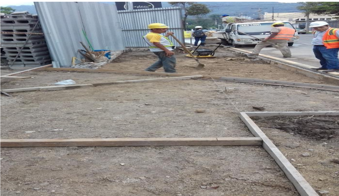
Ilustración 26 Encofrado para fundición de acera
