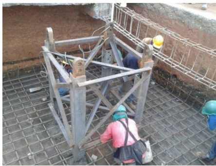
Ilustración 1 fundación de grúa Torre y nivelado
