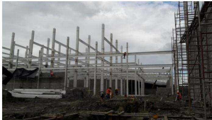
Ilustración 5 Construcción de torre nivel 7 UNITEXA
