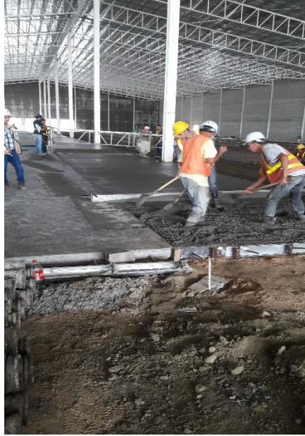
Ilustración 4 Fundiciones de pisos en UNITEXA
