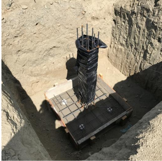
Figura 4. PREPARANDO ZAPATA AISLADA PARA LA FUNDICIÓN
