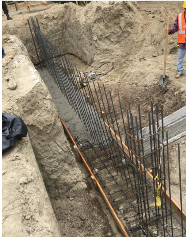
Figura 6. FUNDICIÓN DE ZAPATA CORRIDA
