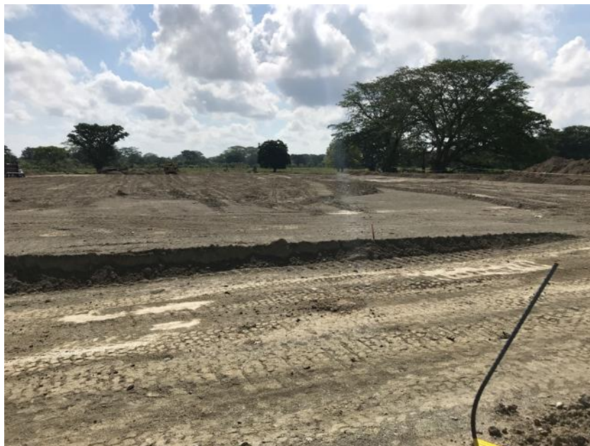
Figura 3. CORTE Y NIVELACION DE TERRENO
