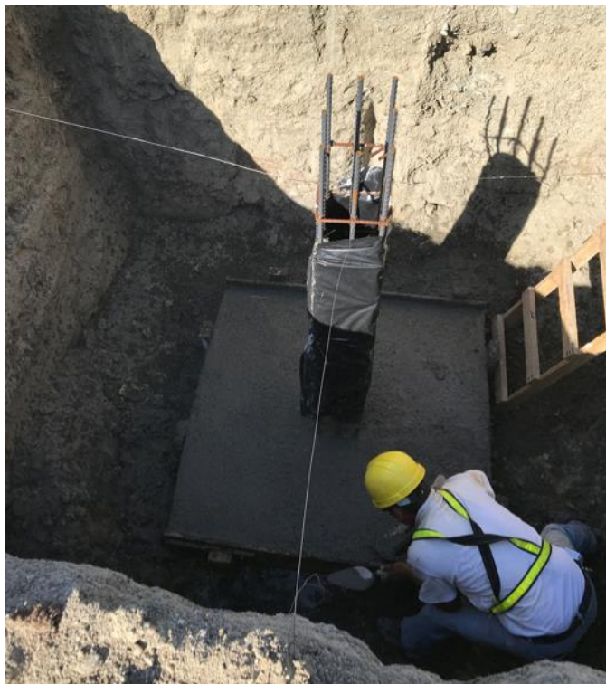
Figura 5. FUNDICIÓN DE ZAPATA AISLADA
