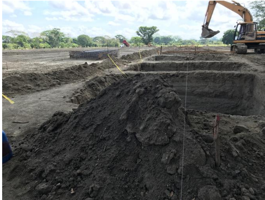
Figura 2. EXCAVACIÓN DE ZAPATAS AISLADAS
