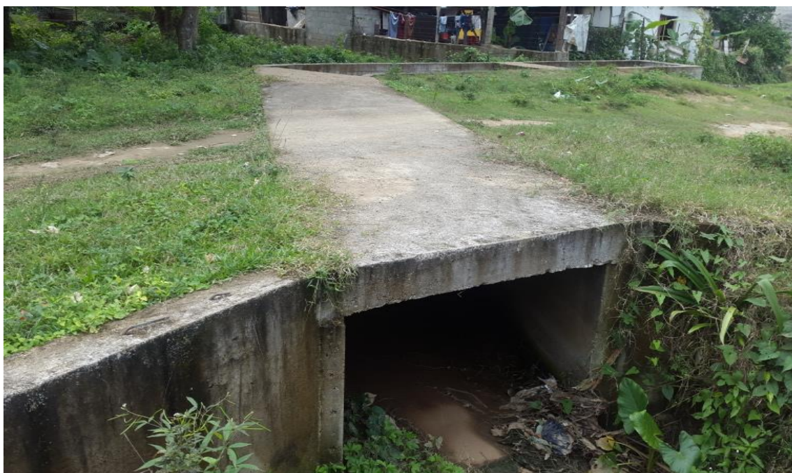
Ilustración 11. Construcción de Caja Puente
