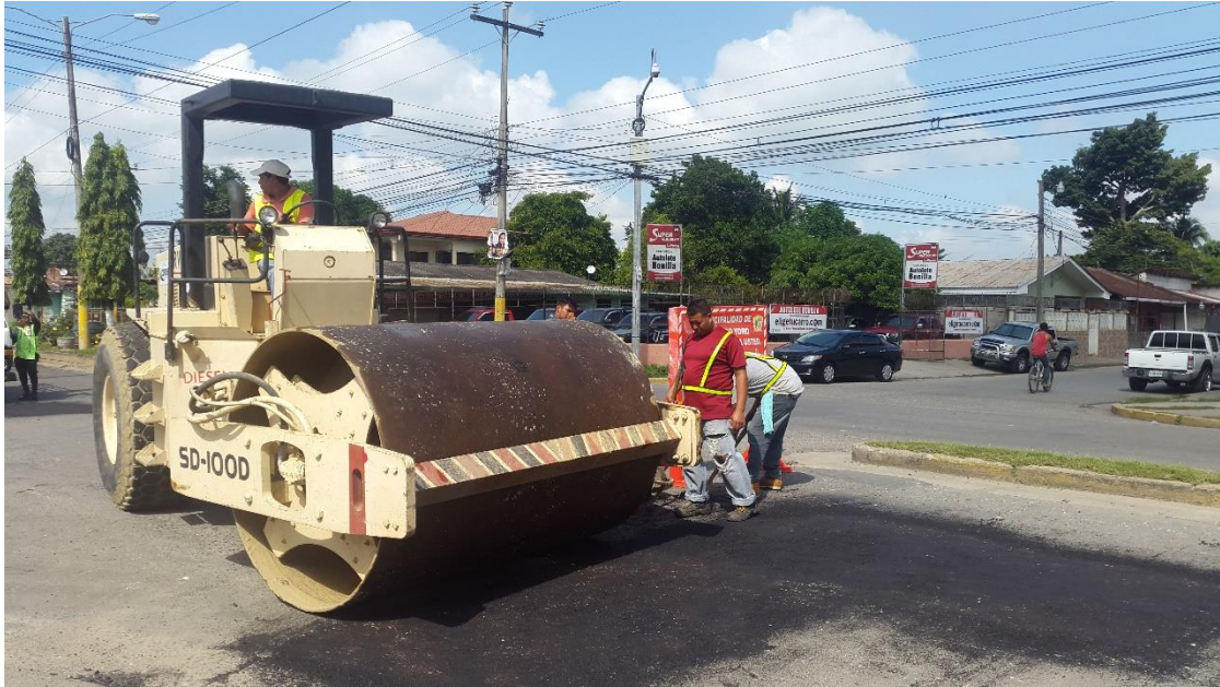
Ilustración 7. Compactación con vibro compactador
