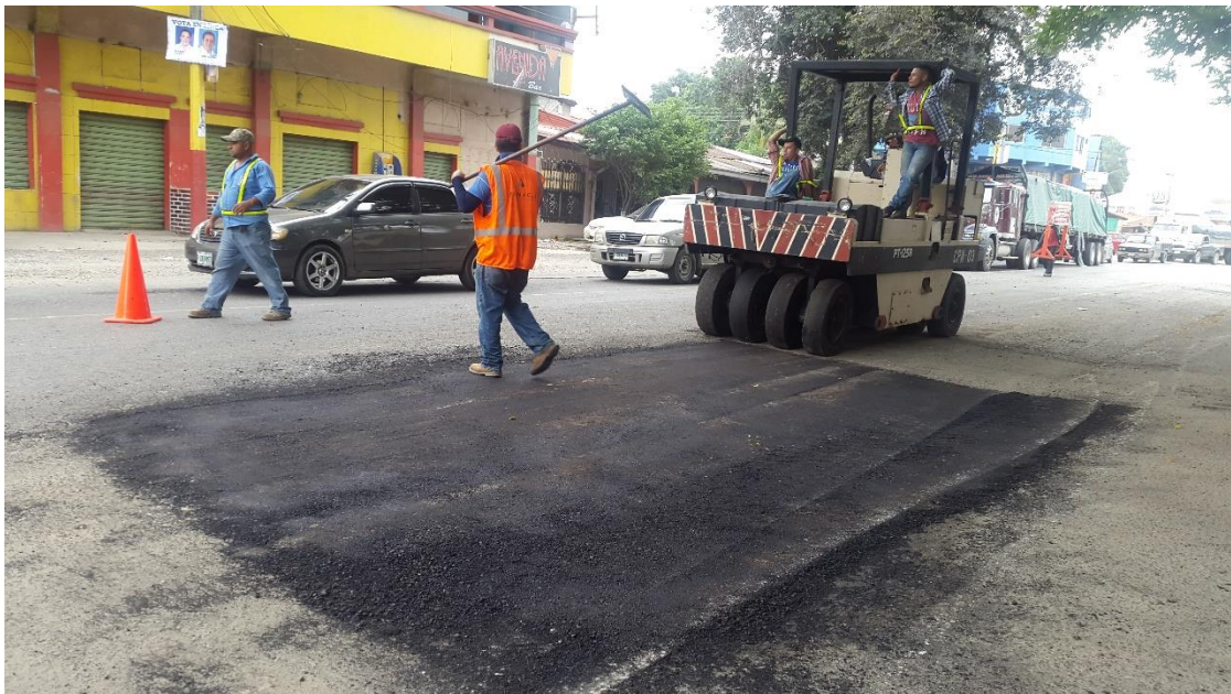
Ilustración 8. Impermeabilización con rodillo neumático
