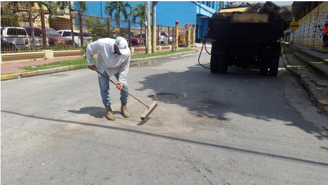
Ilustración 4. Limpieza de área designada
