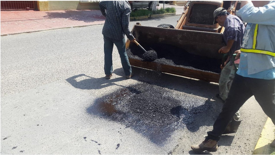
Ilustración 6. Relleno de bache con mezcla asfáltica
