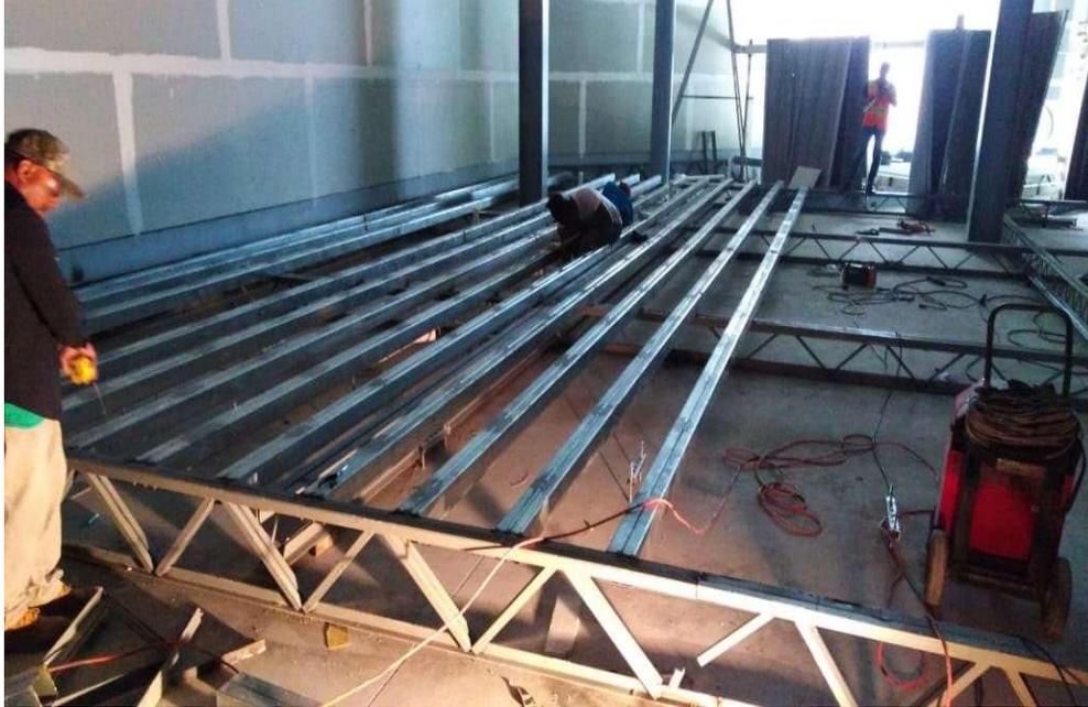
**Ilustración 10. Elaboración de la estructura de nivelación.**
