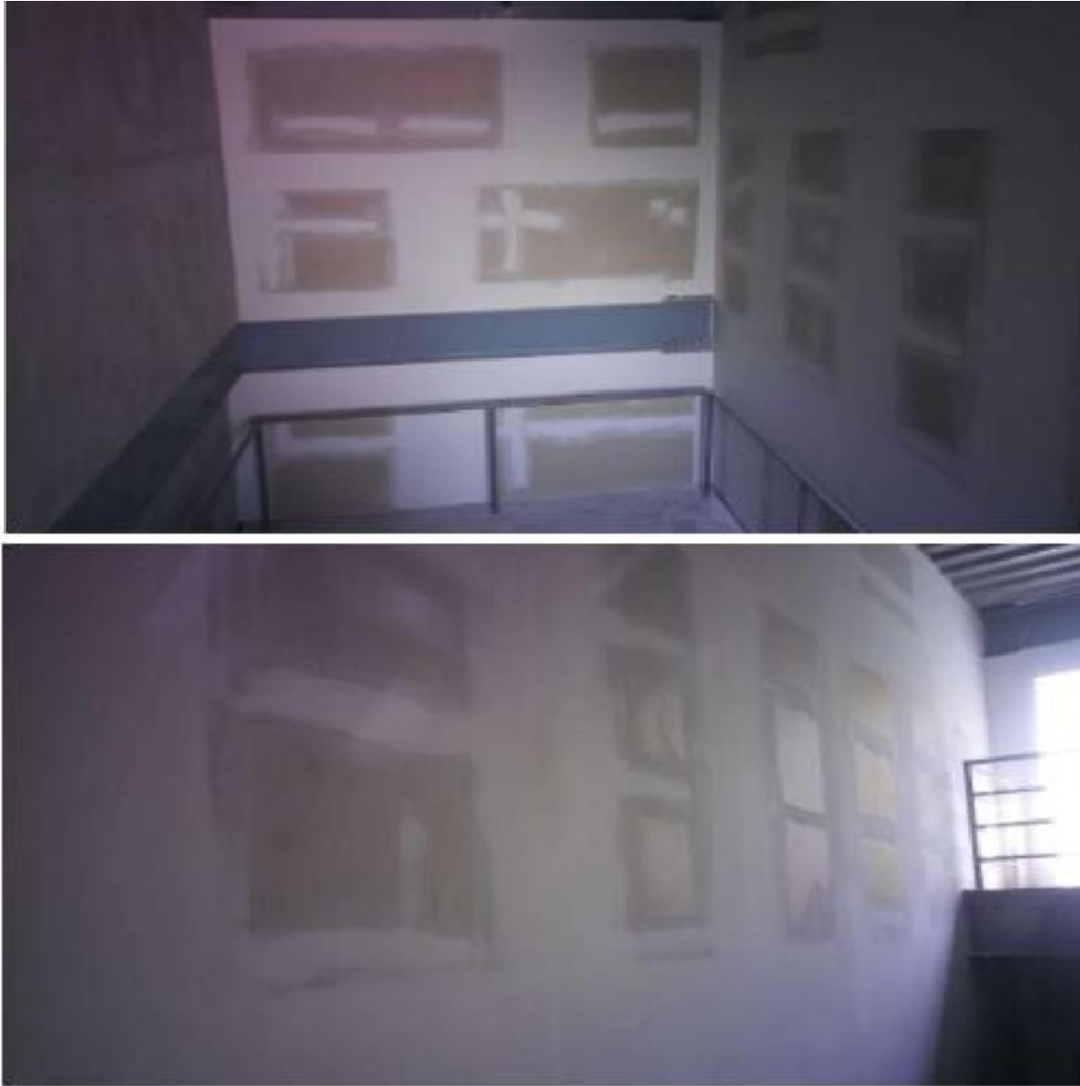
**Ilustración 7. Pared de tabla yeso con acabado a doble mano de masilla y lijada.**
