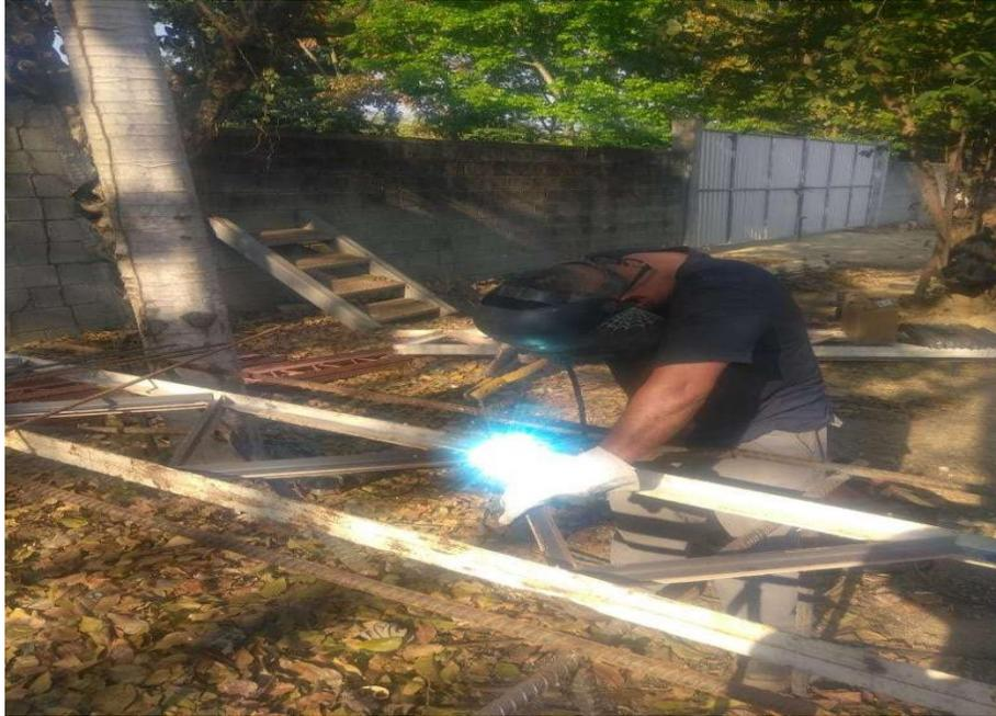
**Ilustración 8. Restauración de Joist para losa de nivelación.**
