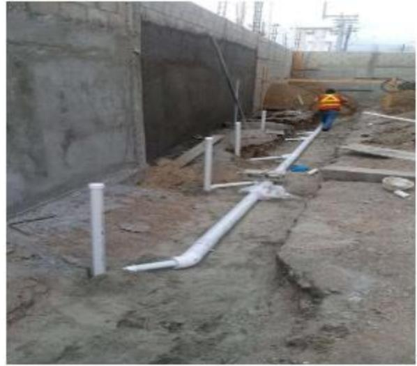
**Ilustración 12. Instalación de tubería de drenajes.**
