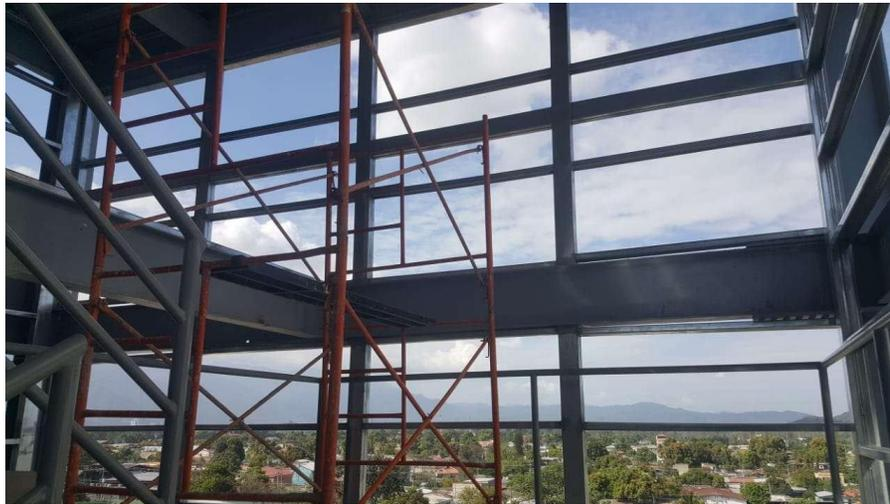
**Ilustración 4. Estructura de refuerzo con cajón de canaleta de 2"x 6" vista frontal.**
