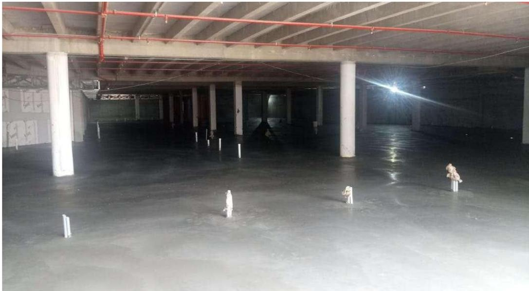
**Ilustración 15. Losa finalizada con acabado fino y corte de junta.**
