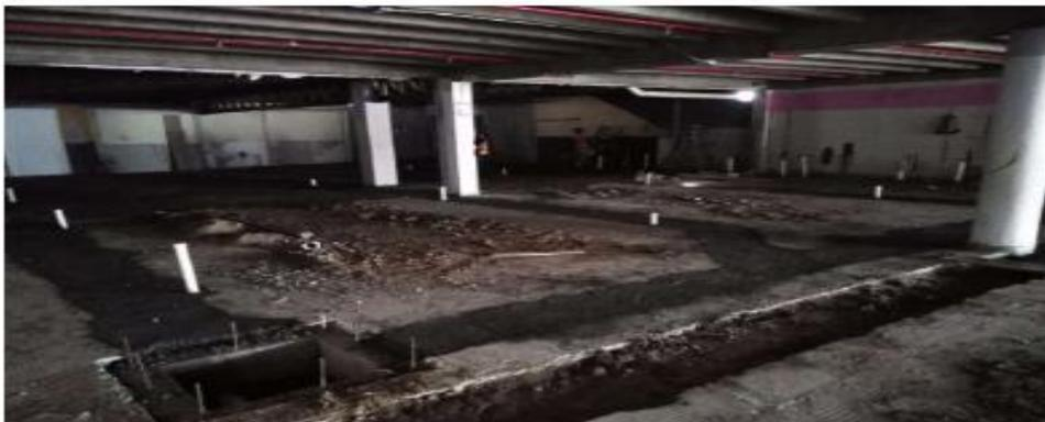
**Ilustración 13. Reparación de concreto donde se instalación de tubería.**
