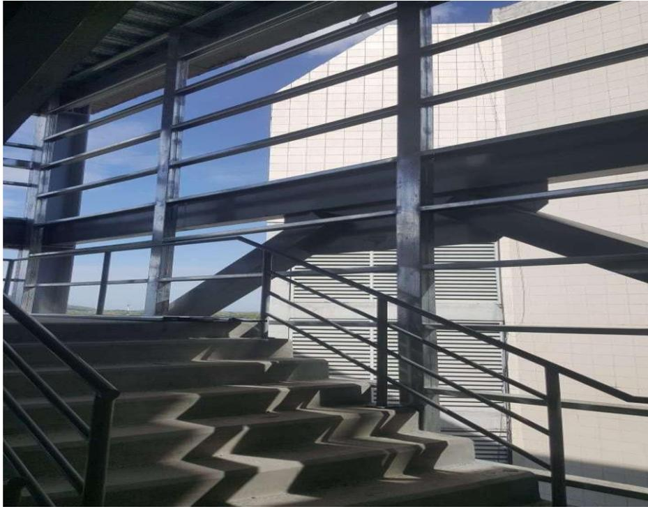
**Ilustración 5. Estructura de refuerzo con cajón de canaleta de 2"x 6", vista lateral.**
