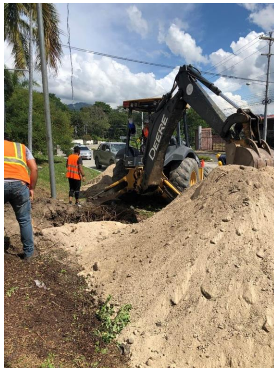
Figura 80. Excavación pozo inspección a construir
