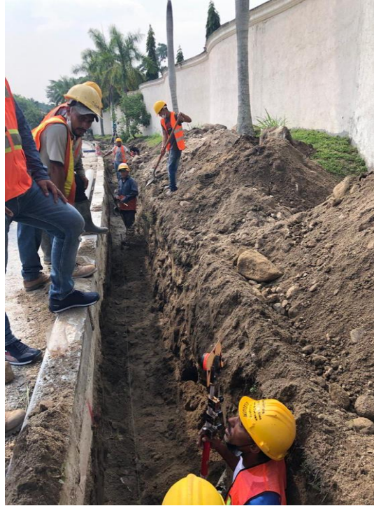
Figura 81. Excavación para tubería PVC 8" en colector área verde exterior
