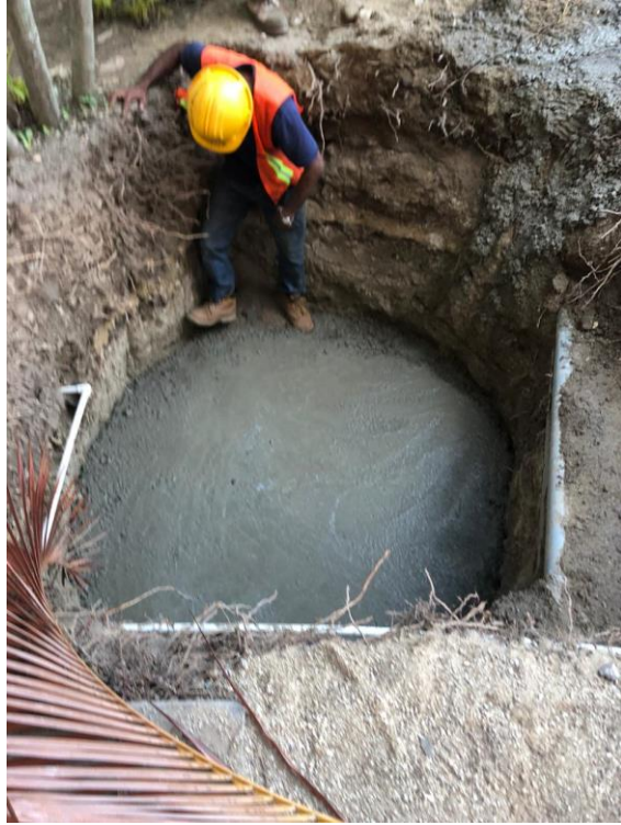
Figura 91. Fundición piso pozo de inspección
