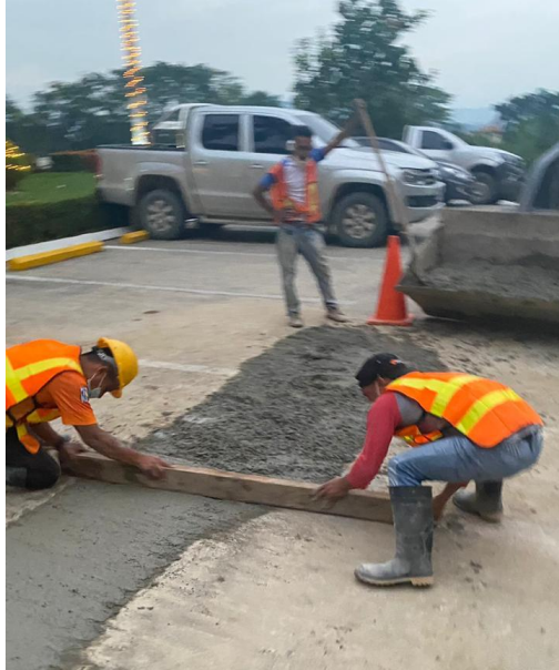
Figura 107. Nivelado de concreto
