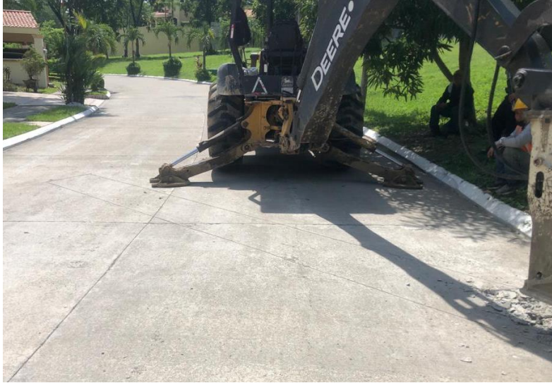
Figura 99. Demolición de pavimento
