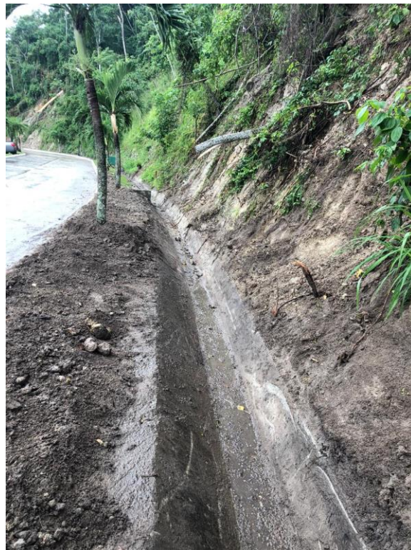
Figura 66. Limpieza total de canal de ALL
