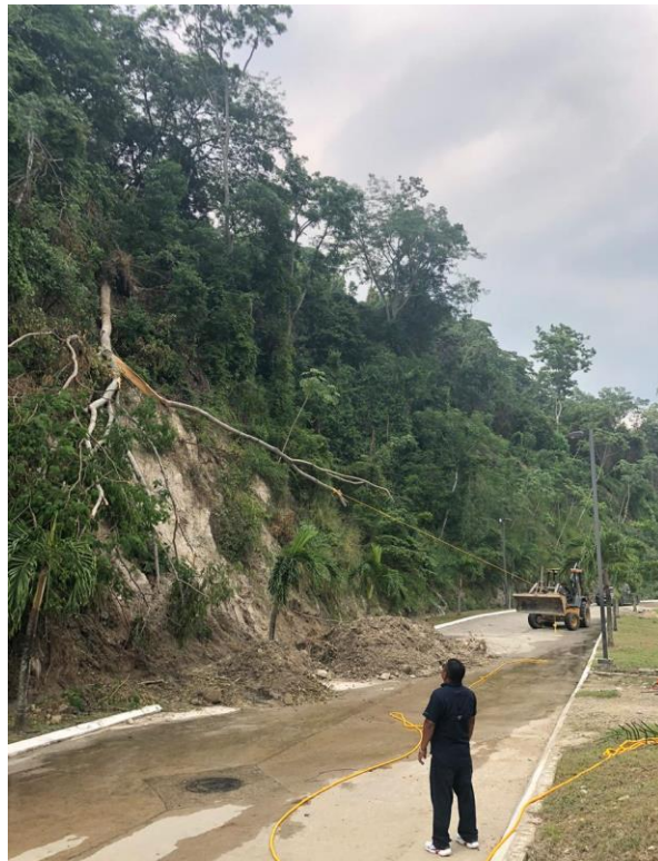
Figura 62. Jalado de árbol por medio de retroexcavadora
