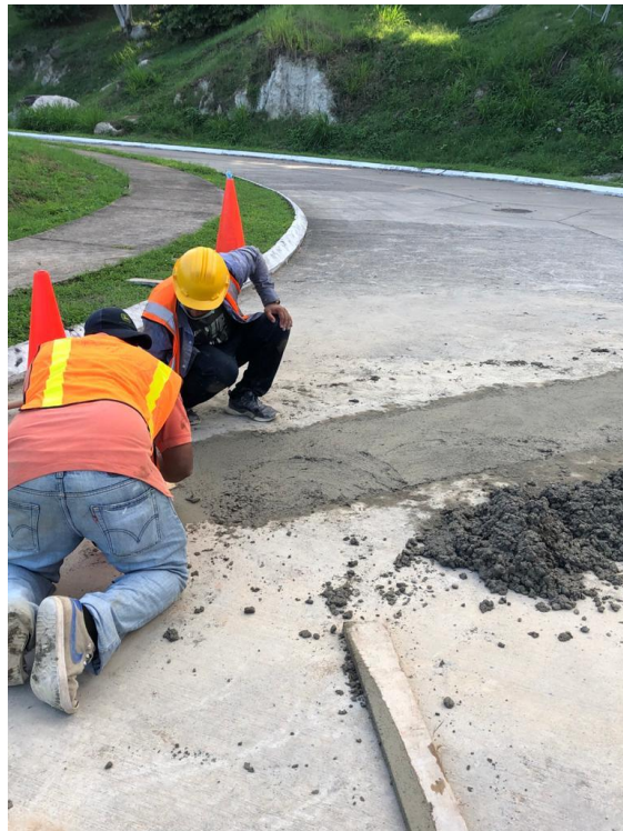
Figura 72. Fundición trocha frente a lote 4A Enclave
