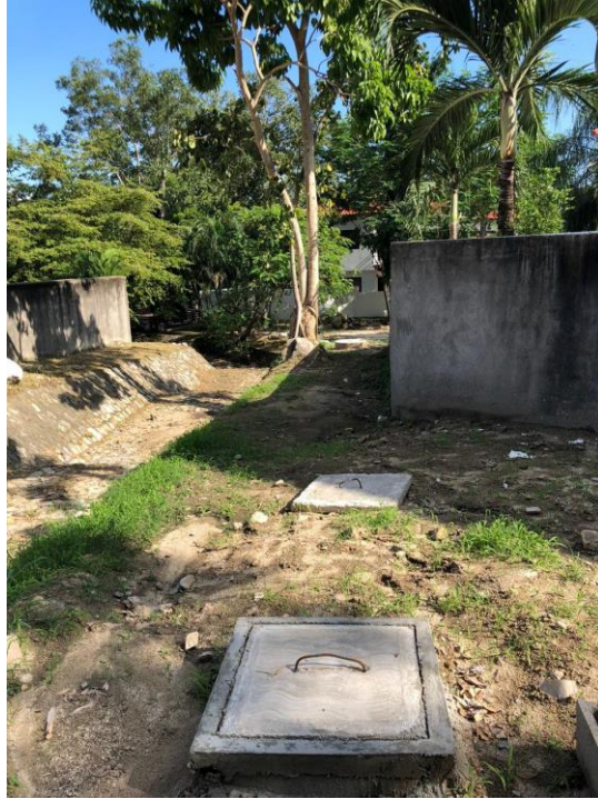
Figura 35. Caja de registro construida
