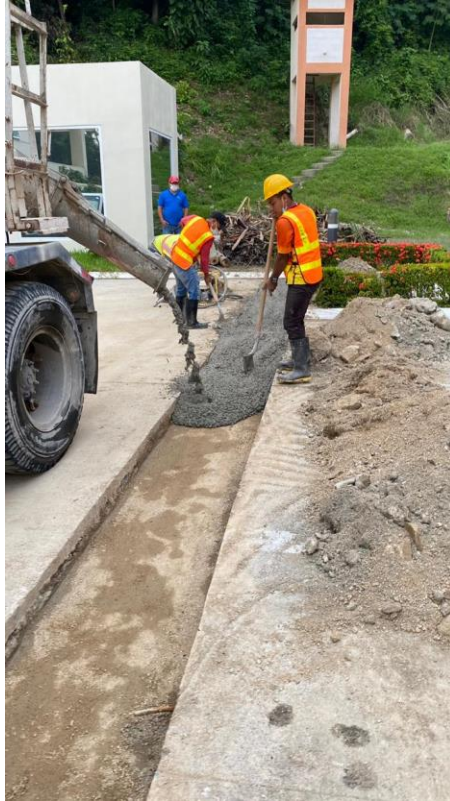
Figura 105. Vertido de concreto en colector área municipal
