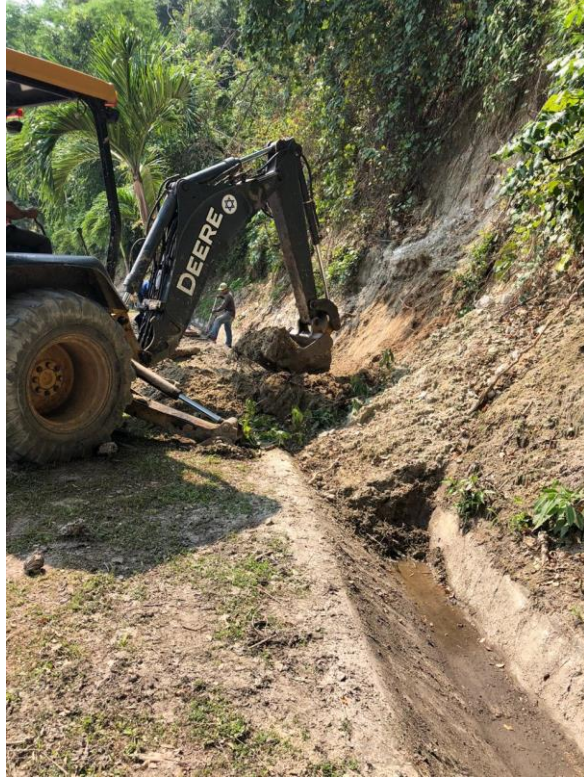
Figura 63. Limpieza de canal con retroexcavadora
