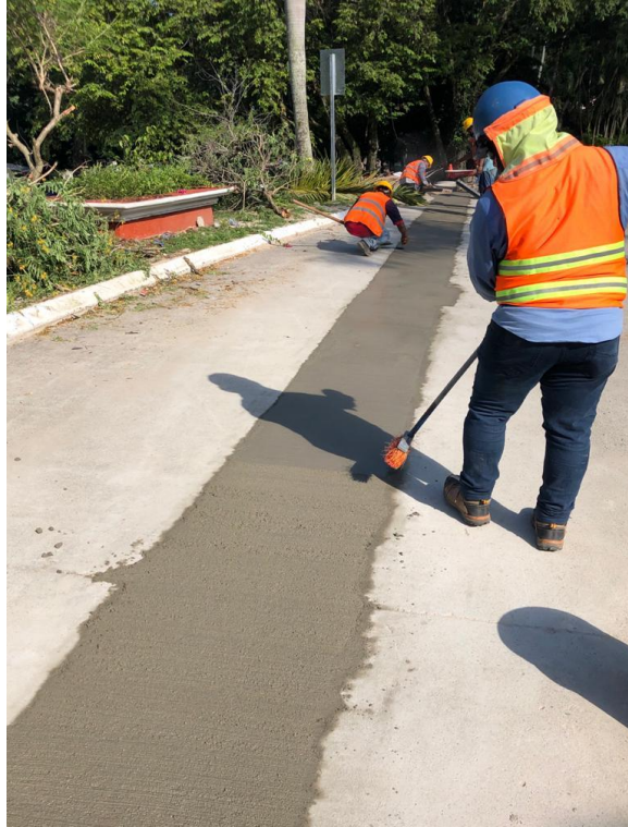
Figura 73. Escobillado para dar superficie rugosa al concreto
