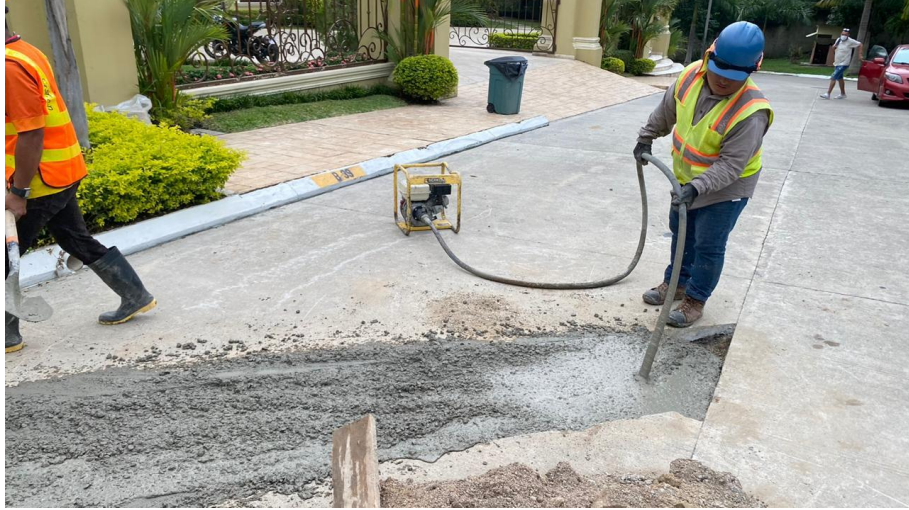
Figura 111. Vibrado de concreto
