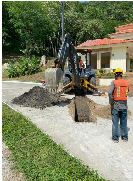
Figura 10. Excavación para tubería PVC 4" Lote 4A Enclave
