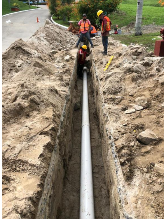
Figura 7. Colocación tubería PVC 8" sobre cama de arena
