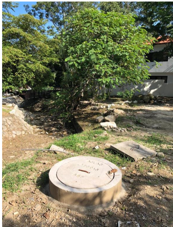
Figura 36. Casquete instalado en pozo de inspección
