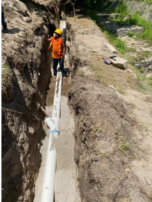
Figura 33. Colocación Yee Pvc 45°
