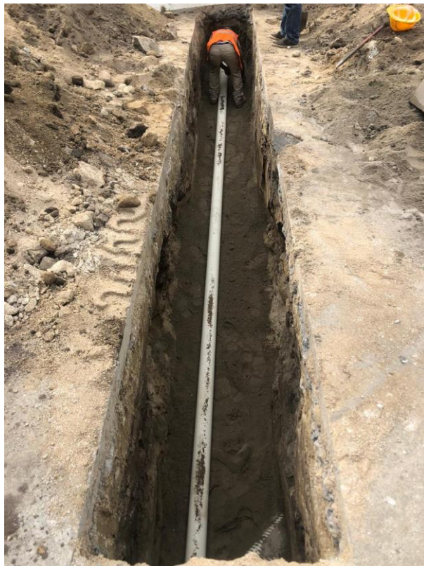
Figura 76. Colocación tubería pvc 4"
