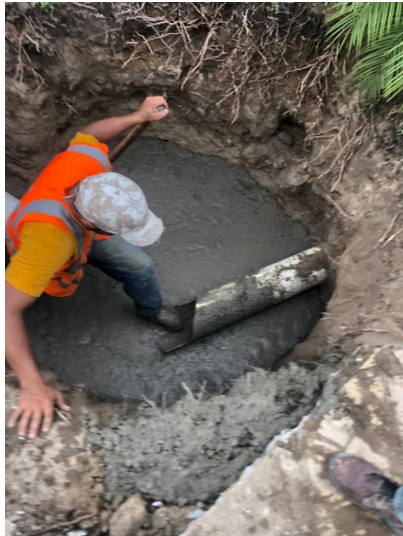
Figura 44. Fundición piso pozo a construir
