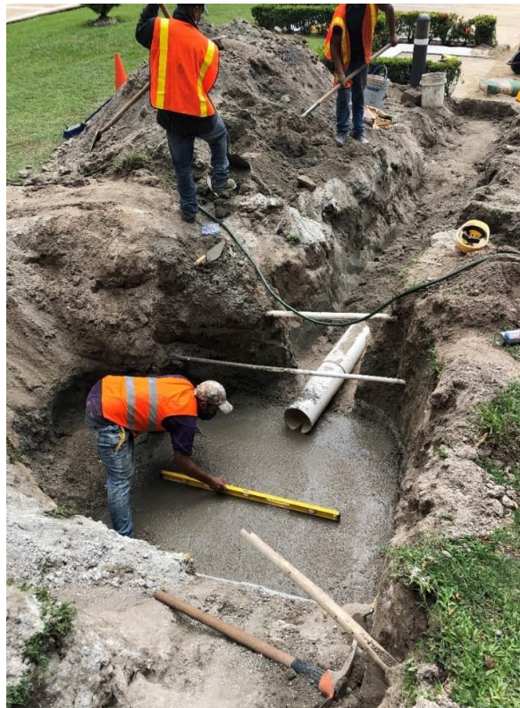
Figura 46. Fundición y nivelación piso en pozo cabecero
