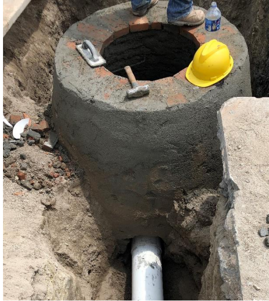
Figura 11. Pozo de inspección 12A repellado exteriormente
