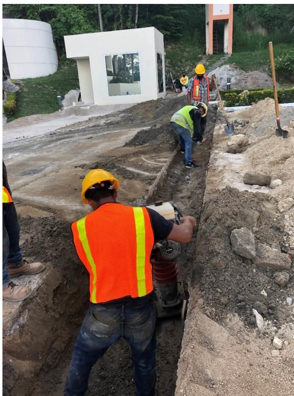
Figura 41. Compactación relleno sobre tubería PVC 8"
