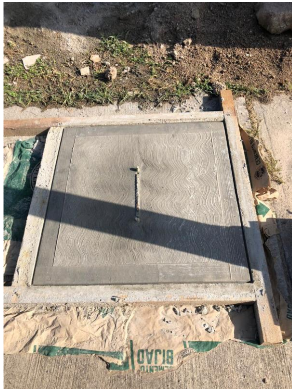
Figura 26. Tapadera caja registro lote 27A Bloque A
