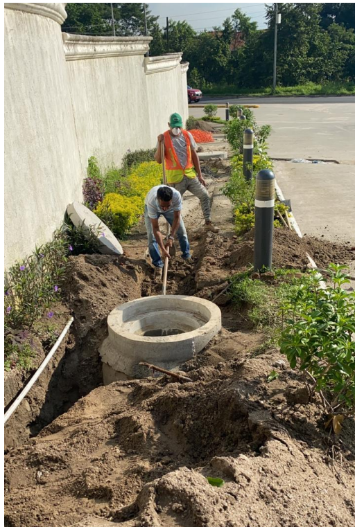
Figura 94. Continuación de excavación para tubería pvc 8"
