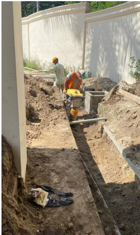
Figura 98. Compactación zanjo tubería pvc 8"
