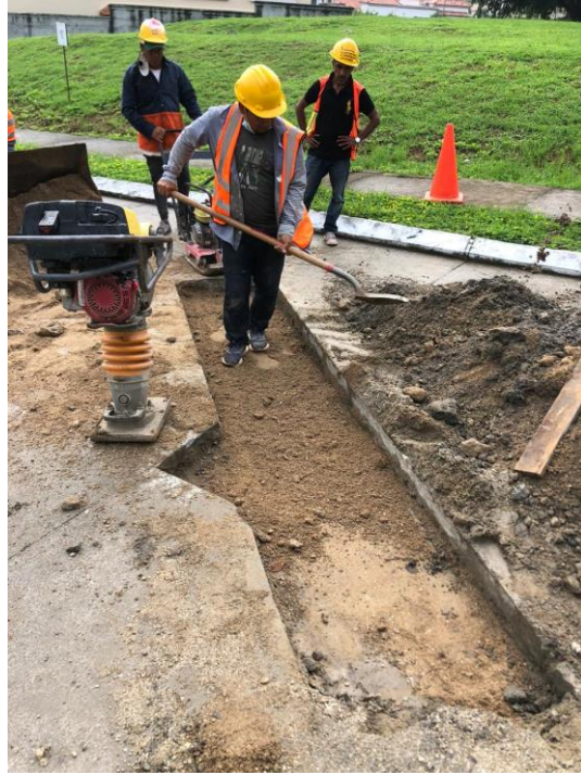
Figura 69. Colocación material sub-base
