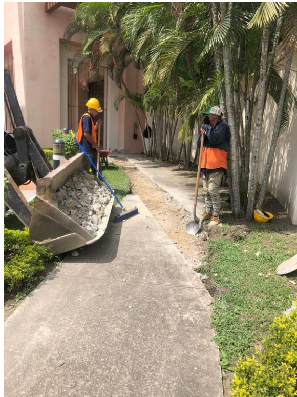
Figura 88. Retirado de ripio
