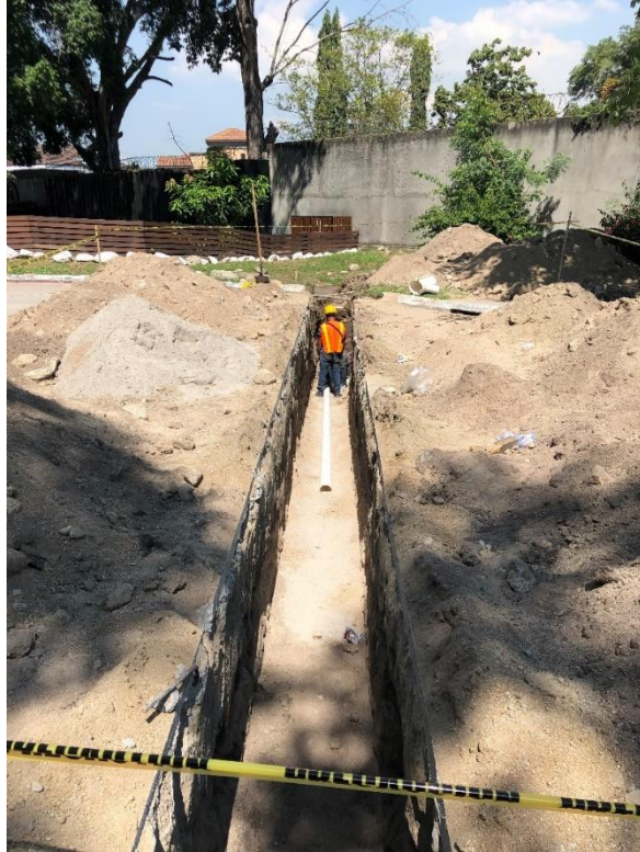
Figura 23. Colocación tubería PVC 4" en zanja
