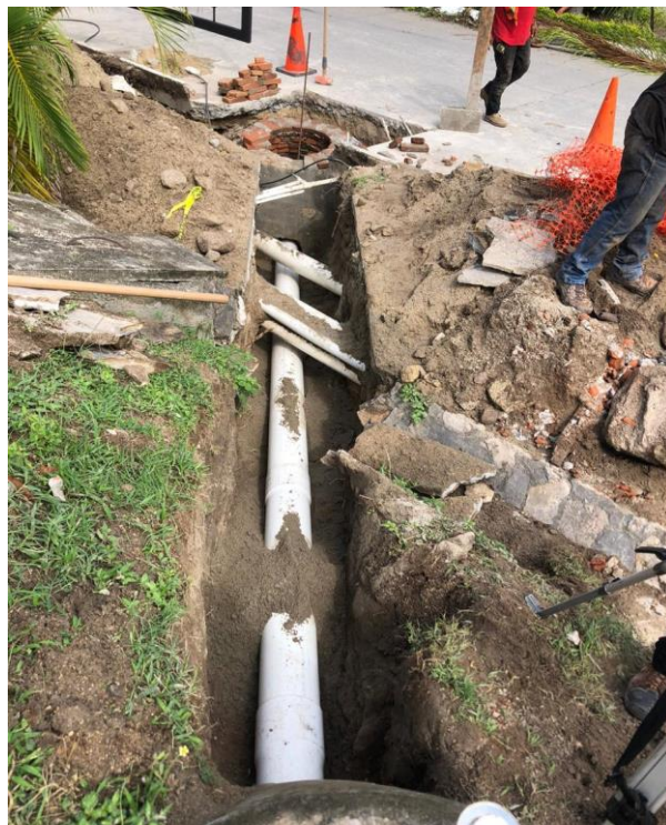
Figura 52. Colocación tubería pvc 8"
