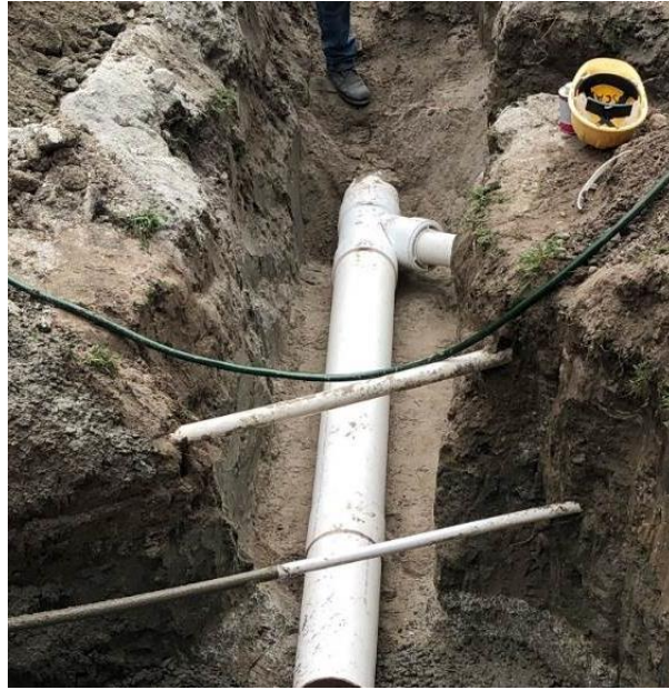
Figura 47. Colocación Yee Pvc 45°
