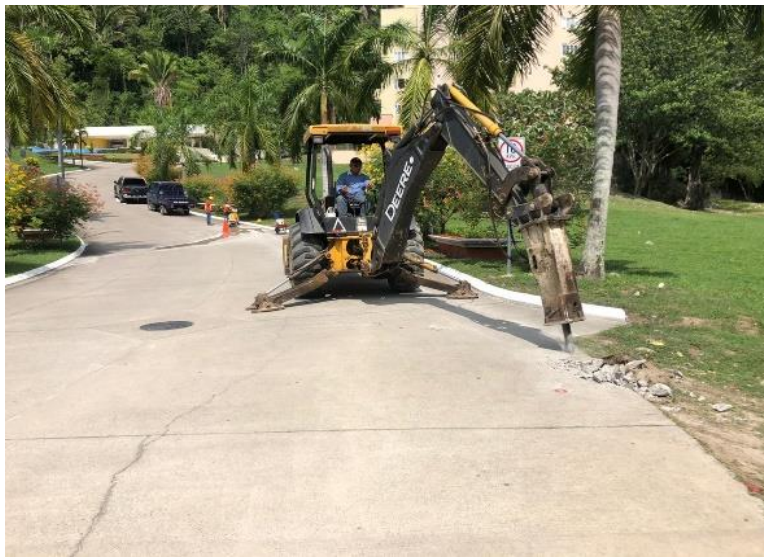
Figura 2. Demolicion Pavimento Tramo entre pozos 12A y 13A
