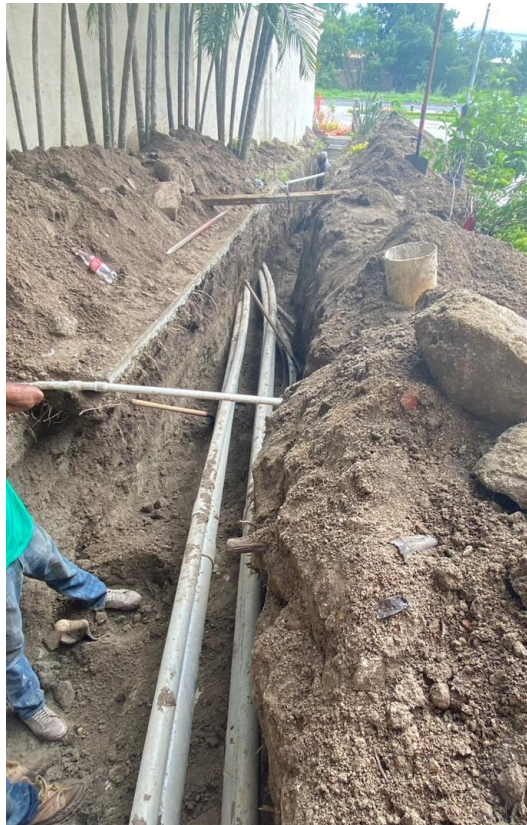
Figura 92. Excavación a mano para tubería pvc 8"
