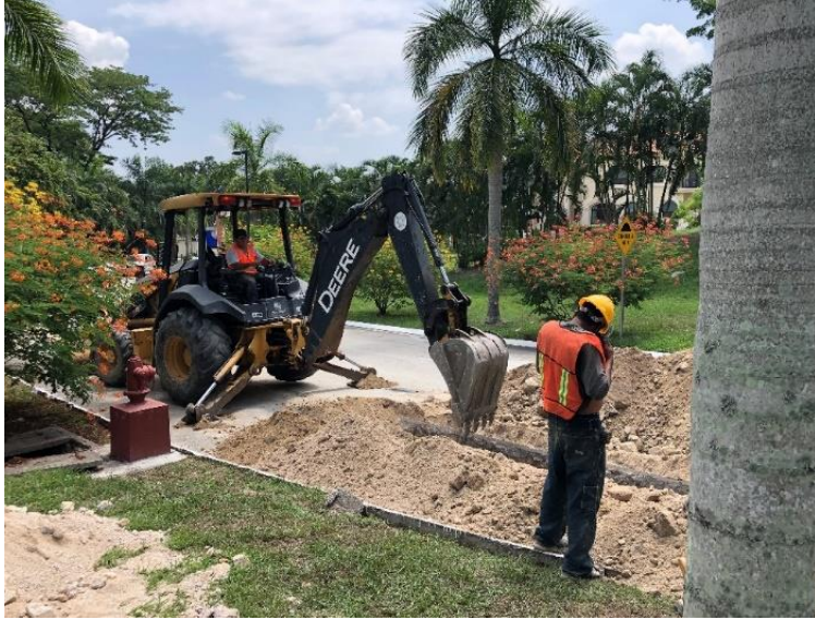
Figura 5. Excavación para tubería tramo entre pozos 12A y 13A
