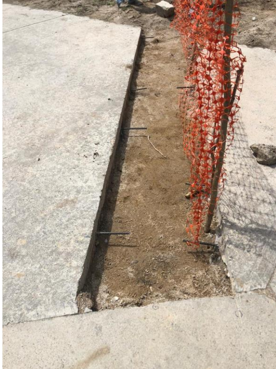
Figura 71. Colocación pines varilla 3/8 a cada 0.50 m
