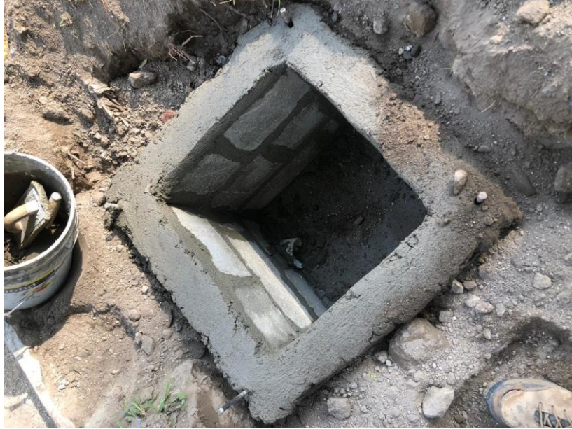
Figura 25. Proceso constructivo caja registro lote 27A Bloque A
