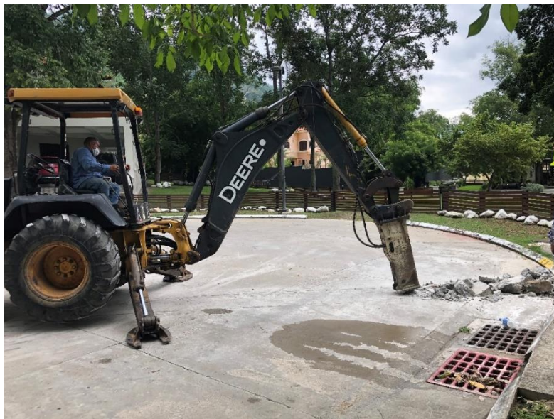
Figura 16. Demolicion pavimento frente a lote 17 Bloque B
