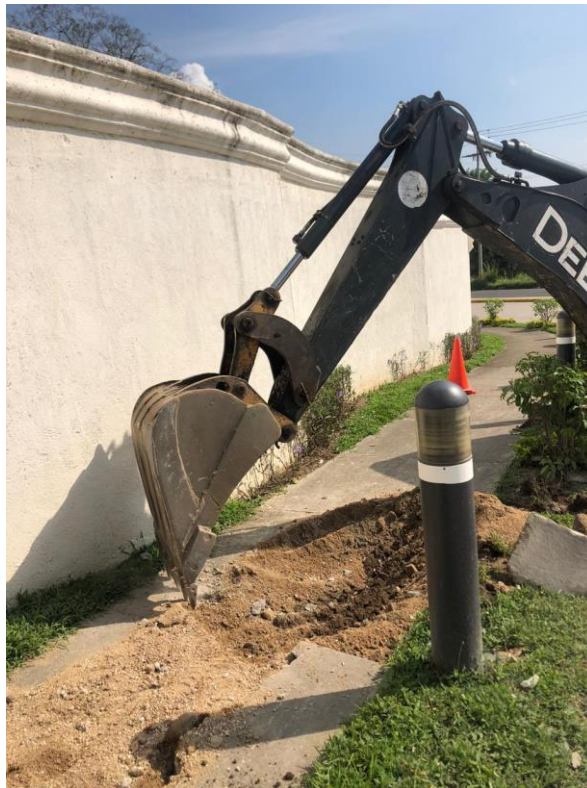
Figura 90. Excavación pozo inspección a construir
