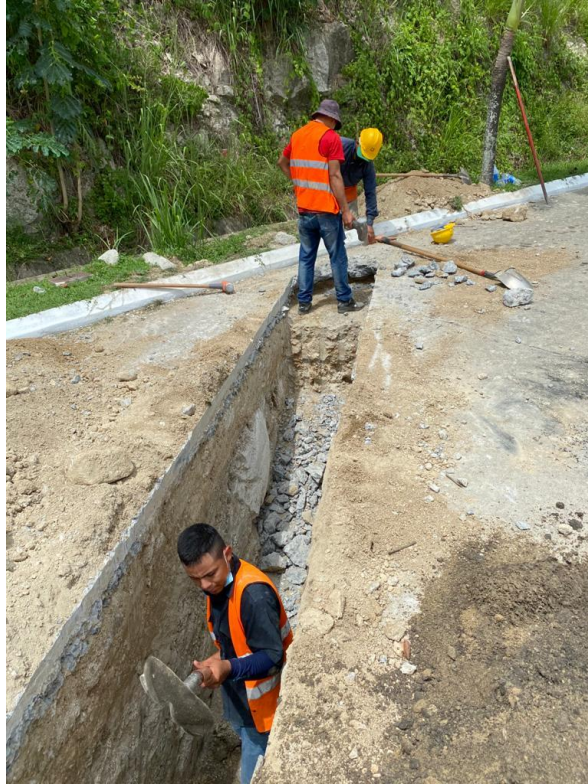
Figura 75. Excavación manual en zanjo
