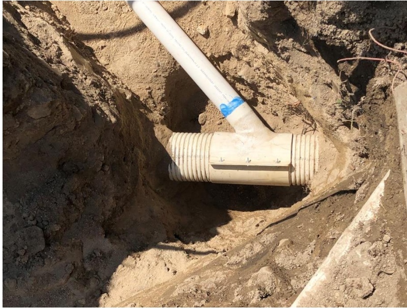
Figura 21. Instalacion de tubería PVC 4" y abrazadera 8x4"
