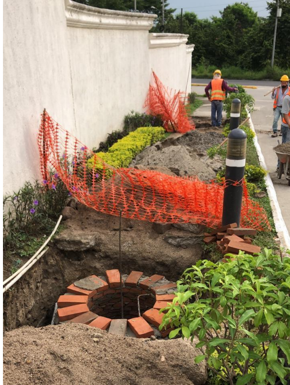
Figura 93. Proceso constructivo pozo de inspección
