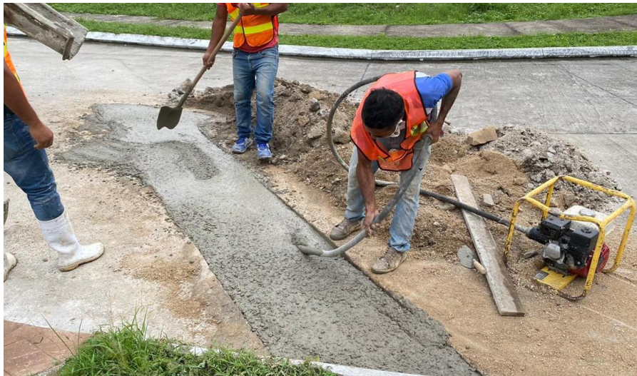
Figura 106. Vibrado de concreto
