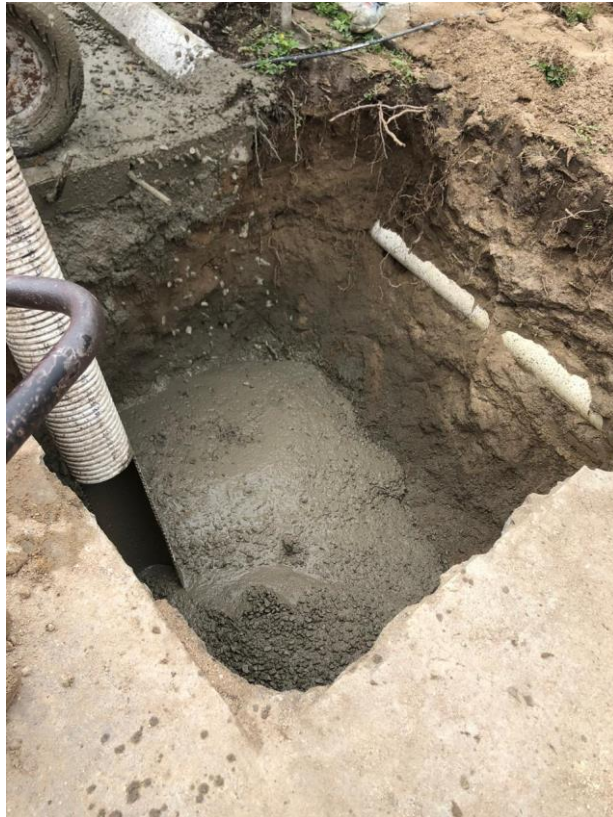
Figura 4. Fundición 0.20m de espesor para piso pozo 13A
