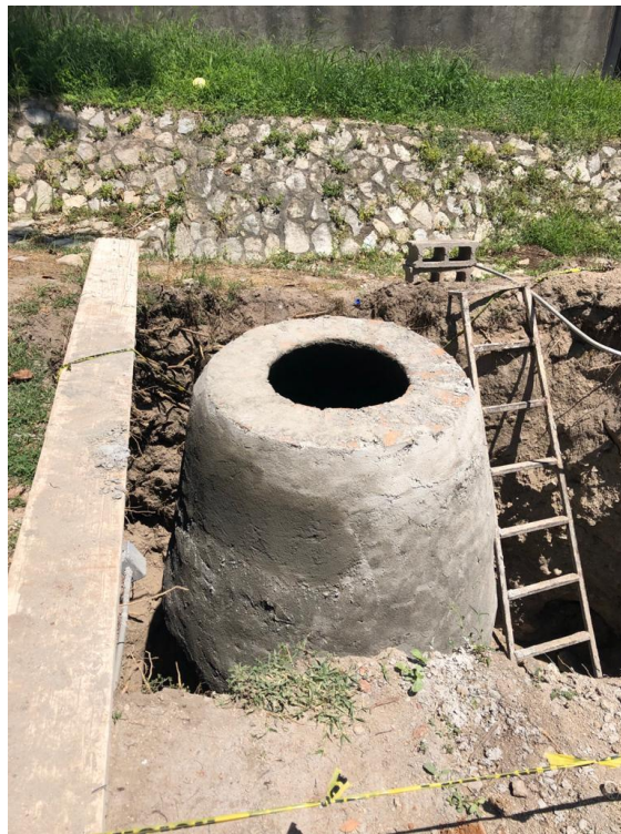
Figura 34. Pozo inspección construido con altura 3.30 m
