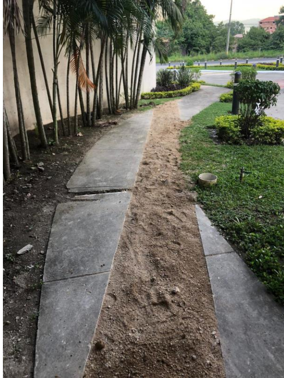
Figura 89. Capa material selecto colocado
