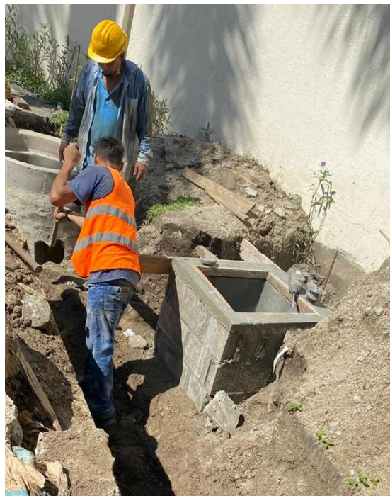
Figura 96. Proceso constructivo caja de registro
