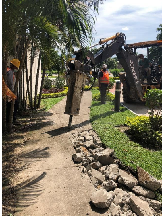
Figura 87. Demolición acera
