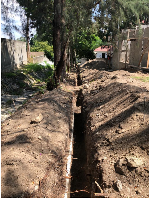
Figura 31. Zanjo excavado a mano
