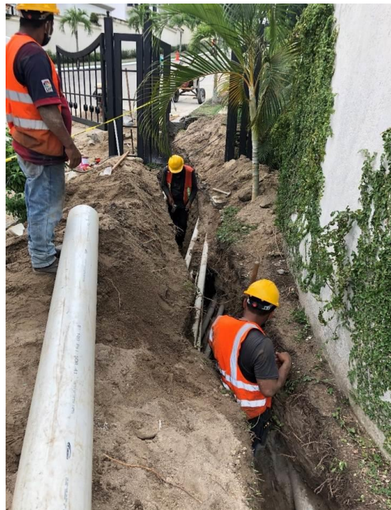
Figura 50. Excavación a mano para tubería PVC 8"
