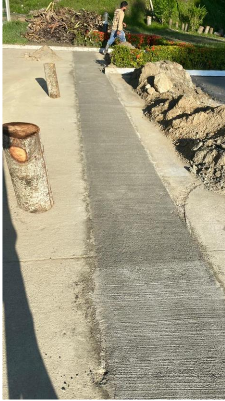
Figura 109. Fundición trocha colector área municipal
