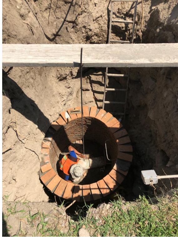
Figura 29. Proceso constructivo pozo de inspección colector atrás de lotes bloque B
