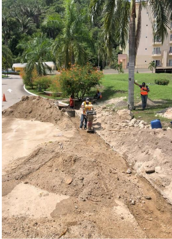
Figura 9. Compactación de zanjo tubería PVC 8"
