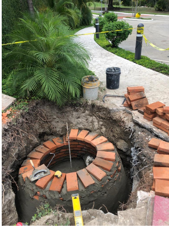
Figura 49. Proceso constructivo pozo en ubicación de caja AN demolida
