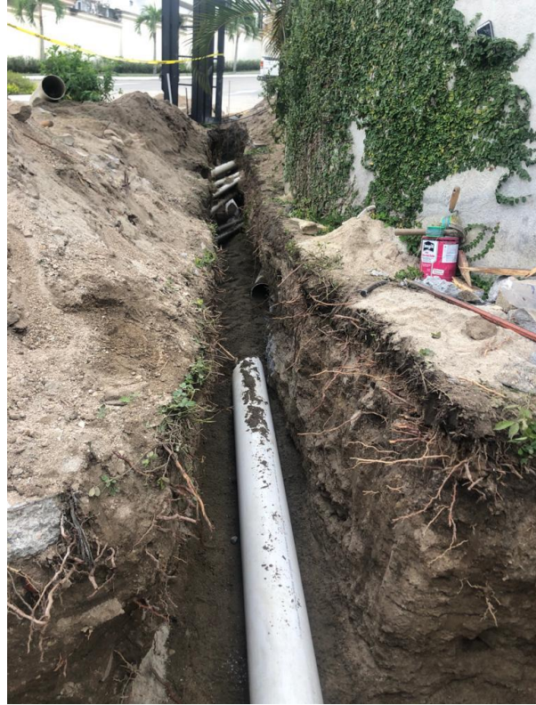
Figura 53. Colocación tubería pvc 8"
