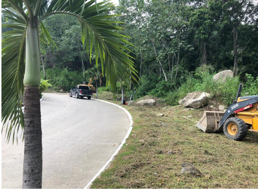
Figura 59. Ubicación canal provisional a excavar
