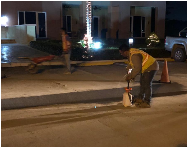
Figura 108. Aplicación de curador
