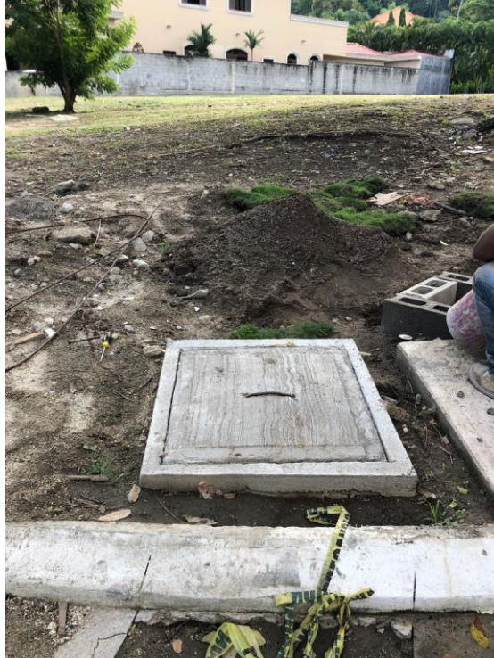
Figura 27. Caja registro lote 17 Bloque B
