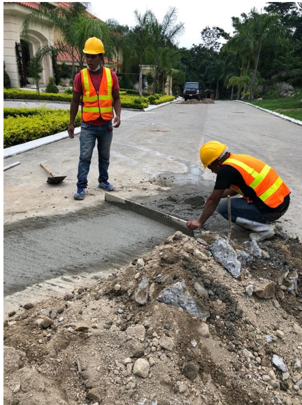
Figura 112. Nivelado de concreto
