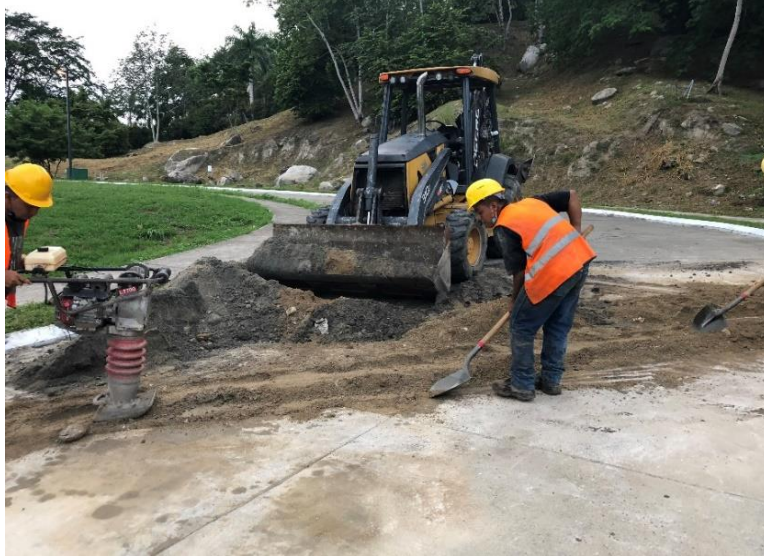
Figura 13. Relleno y compactado de zanjo frente a lote 4A Enclave
