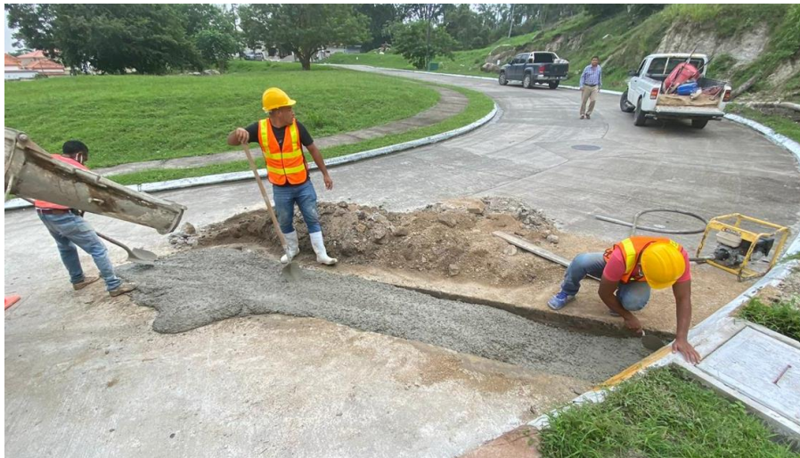
Figura 104. Vertido de concreto en trocha frente a lote 4A Enclave
