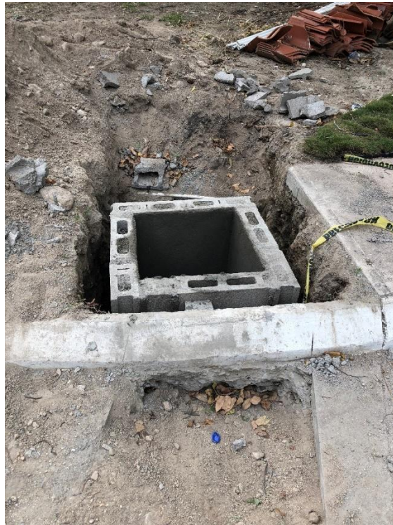
Figura 24. Proceso constructivo caja registro lote 17 Bloque B
