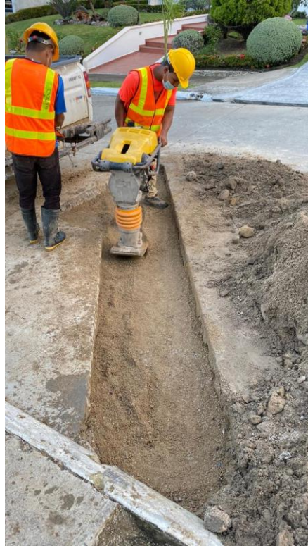
Figura 103. Compactación sub-base
