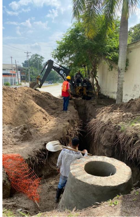
Figura 85. Excavación tramo colector área verde exterior
