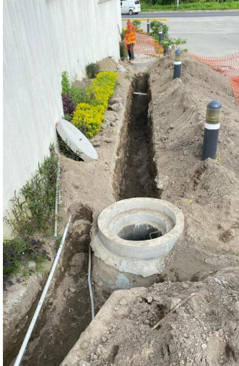
Figura 95. Casquete instalado en pozo de inspección
