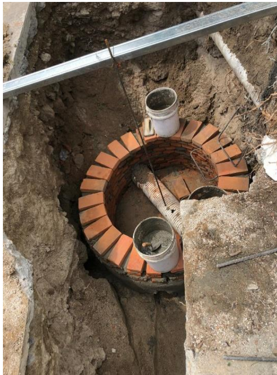
Figura 8. Proceso constructivo Pozo 12A
