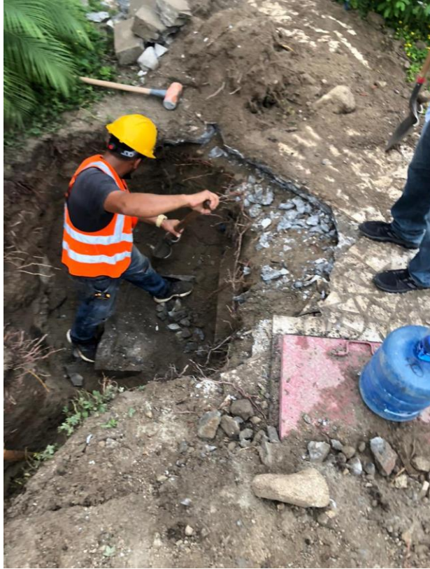
Figura 43. Demolición caja AN
