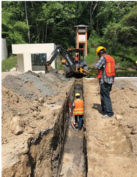
Figura 38. Marcacion niveles invertida tubería PVC 8"
