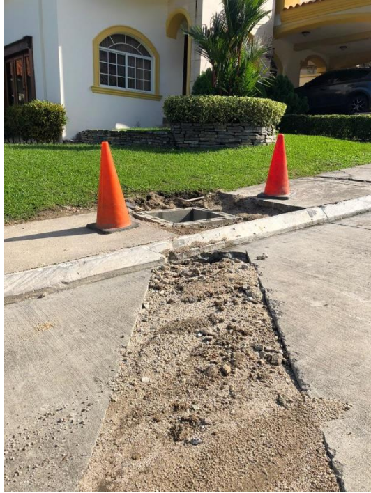
Figura 19. Relleno en zanja tubería pvc 4" Lote 27A Bloque A
