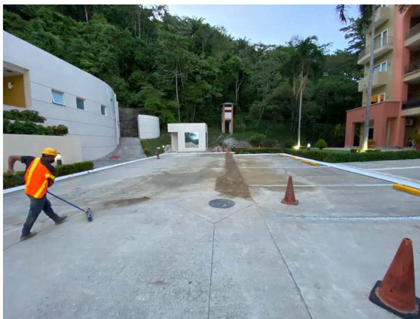
Figura 42. Limpieza y colocación de capa material selecto hasta nivel rasante
