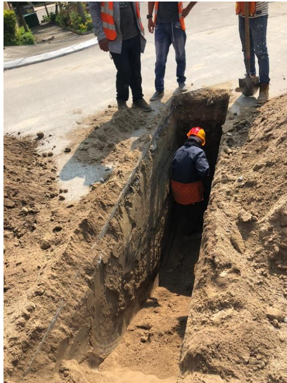
Figura 100. Excavación para tubería pvc 4"
