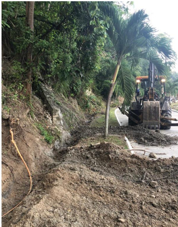
Figura 64. Colocado de material en calle para su posterior desalojo
