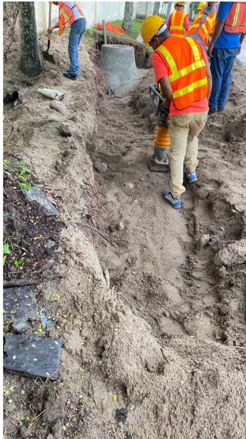
Figura 86. Relleno y compactación zanjo tubería pvc 8"
