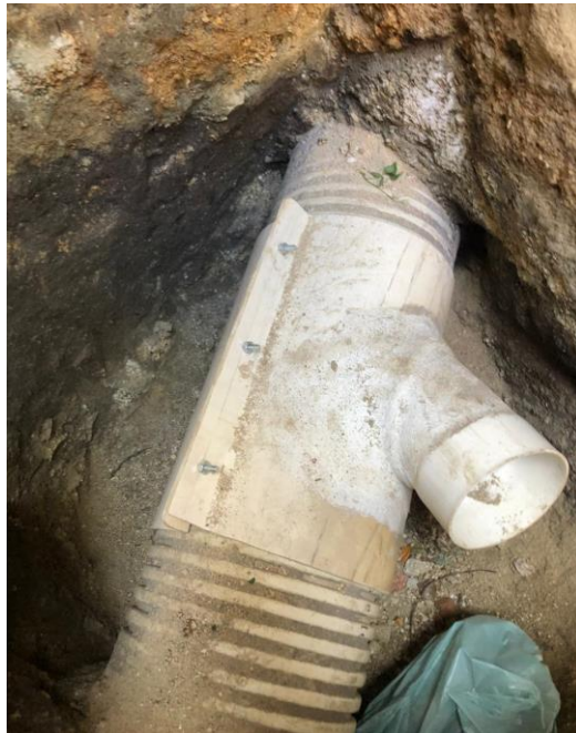
Figura 12. Abrazadera colocada en conexión caja lote 4A Enclave
