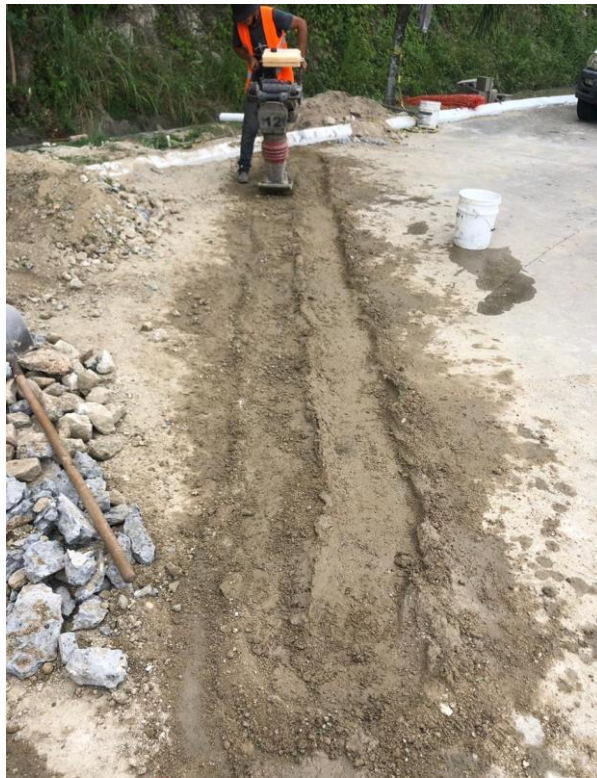
Figura 78. Relleno y compactado de zanjo
