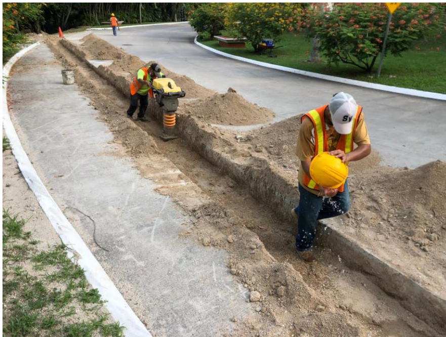
Figura 70. Compactación material sub-base
