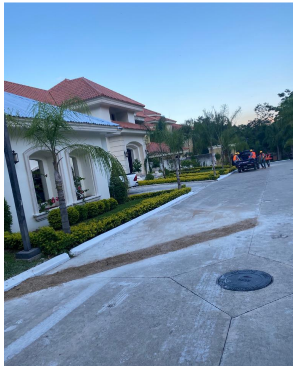
Figura 82. Relleno y compactado hasta rasante en zanja frente a lote 37 Bloque B
