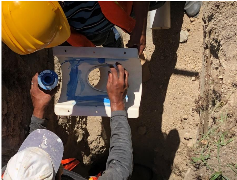
Figura 20. Colocación pegamento en abrazadera
