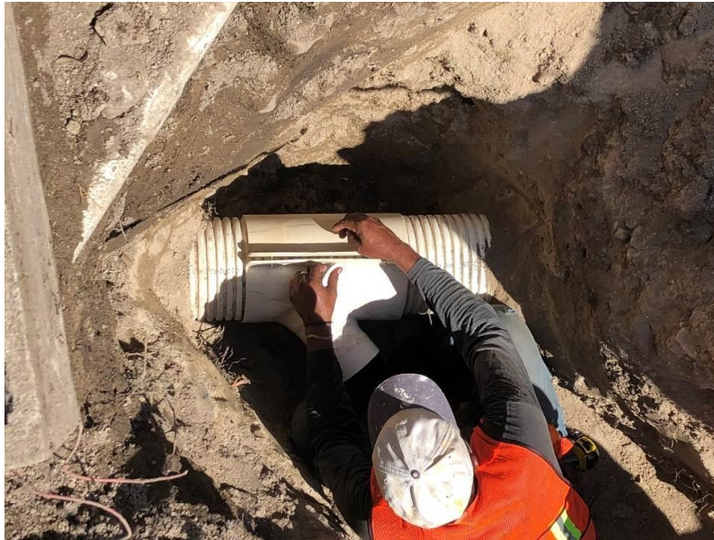
Figura 22. Ajuste de abrazadera por medio de tornillos
