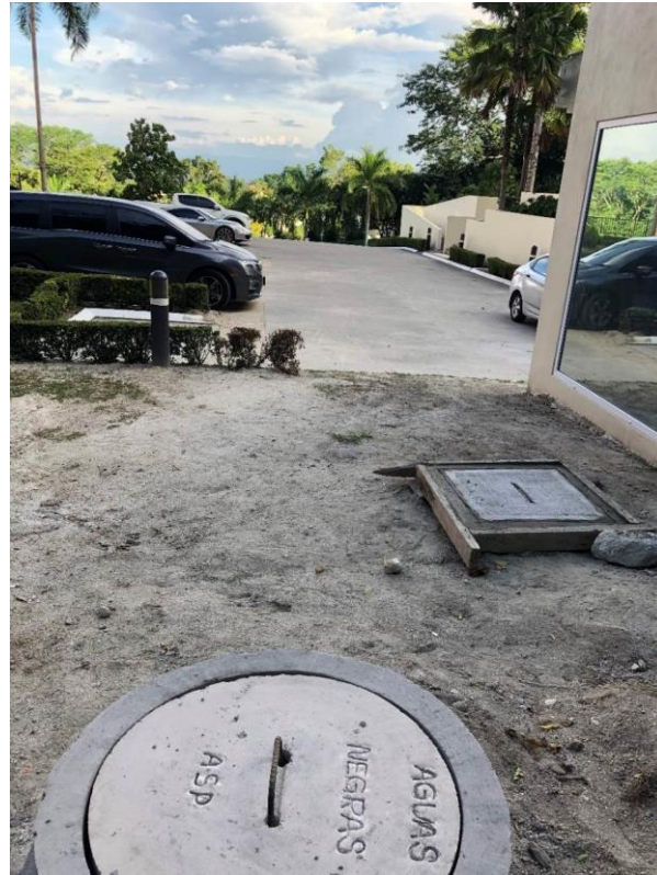
Figura 55. Colocación de casquete en pozo y conformación terreno natural
