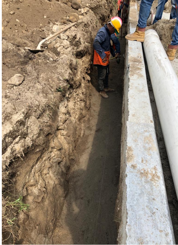
Figura 83. Colocación tubería pvc 8"
