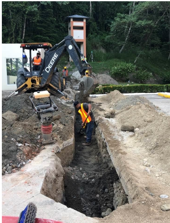
Figura 40. Relleno de zanjo con material de sitio
