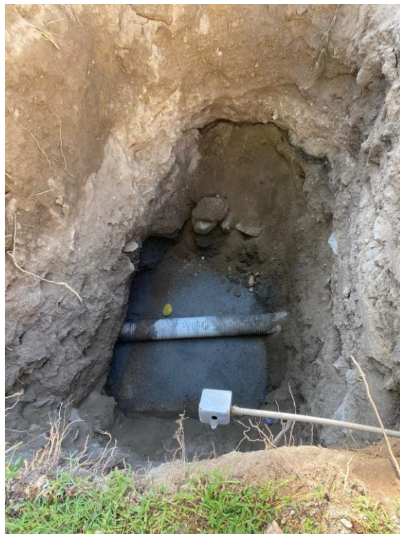
Figura 28. Fundición de piso para pozo en intersección colector existente
