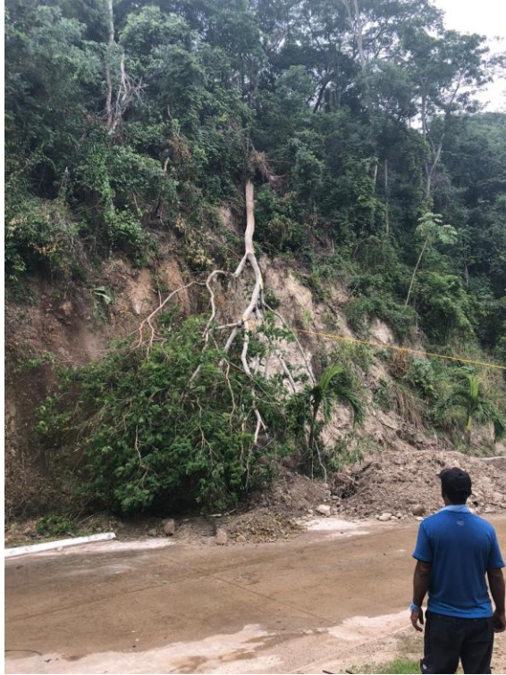
Figura 61. Árbol caído en residencial
