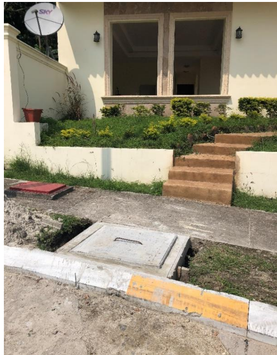
Figura 14. Colocación de tapadera Caja Registro Lote 4A
