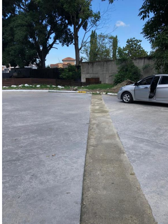
Figura 17. Material selecto colocado en calle frente lote 17 Bloque B
