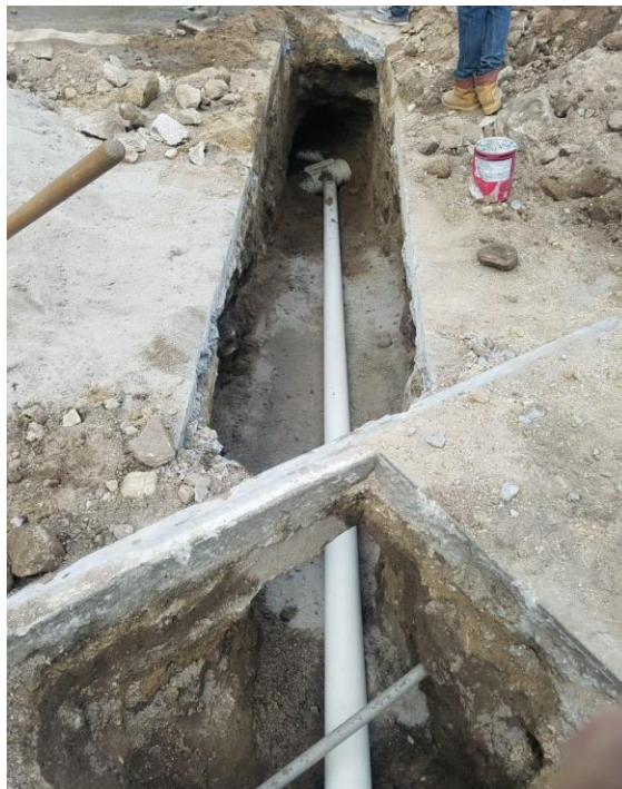
Figura 18. Instalación abrazadera PVC 8x4" conexión domiciliar lote 27A Bloque A
