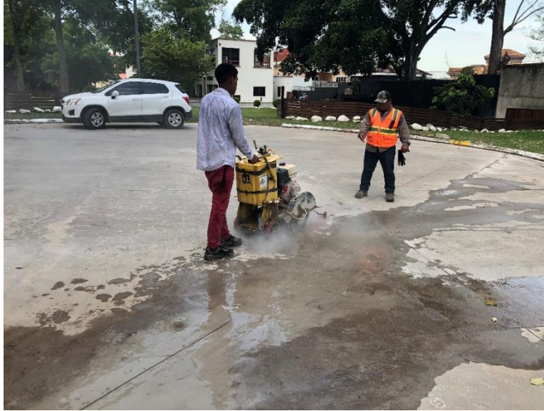
Figura 15. Corte de pavimento conexión domiciliar lote 17 Bloque B
