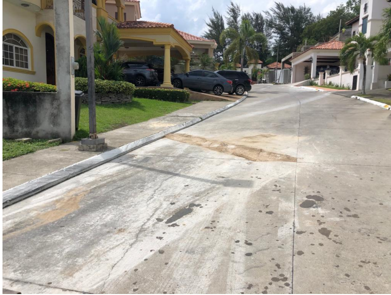
Figura 3. Colocación de material selecto en calle frente a lote 27A
