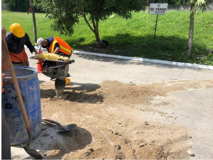
Figura 101. Relleno y compactación de zanjo
