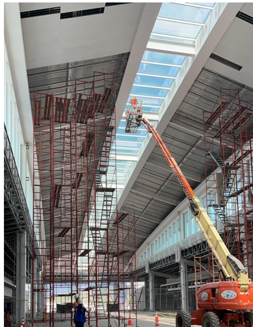
Ilustración 6- Trabajo con andamio
