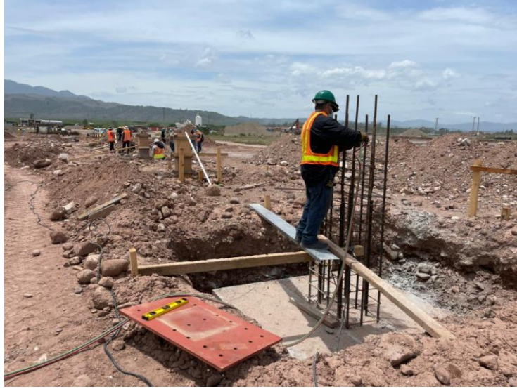
Ilustración 17- Cimentación edificio de cargo
