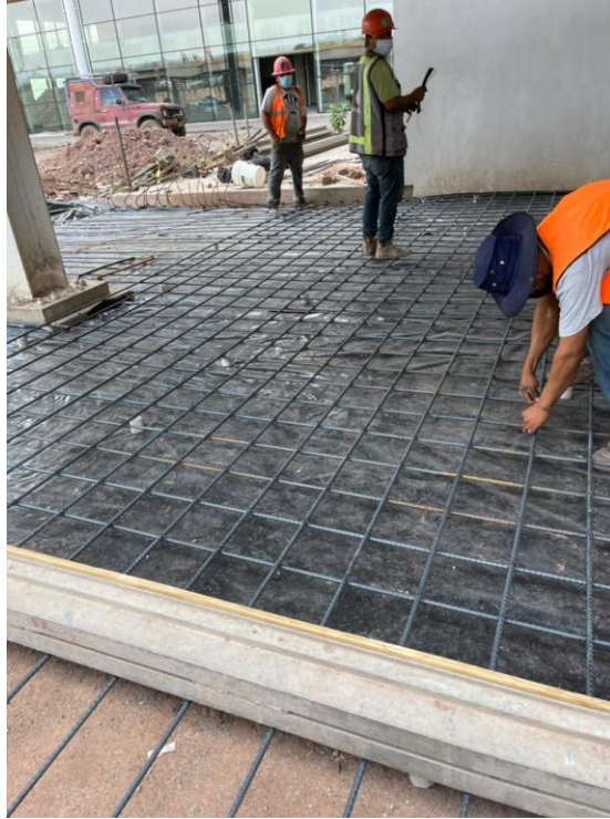
Ilustración 19- Losa de cimentación
