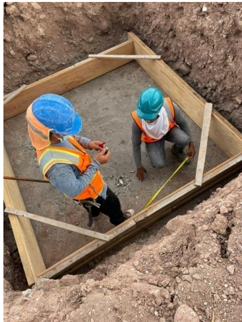
Ilustración 16- Construcción de zapata
