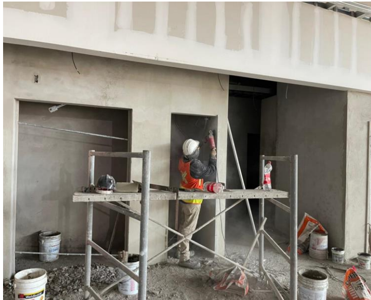
Ilustración 12- Avance de obra
