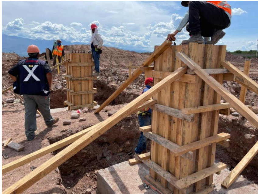
Ilustración 18- Encofrado de columnas de edificio de cargo
