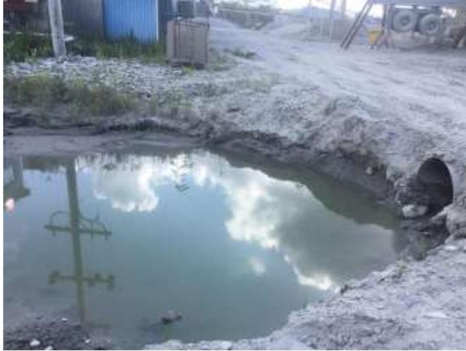
**Figura 23. Canalización en mal estado.**
