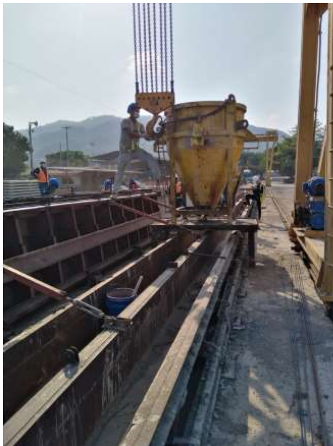
Anexo 9- Fundición de Viga Puente
