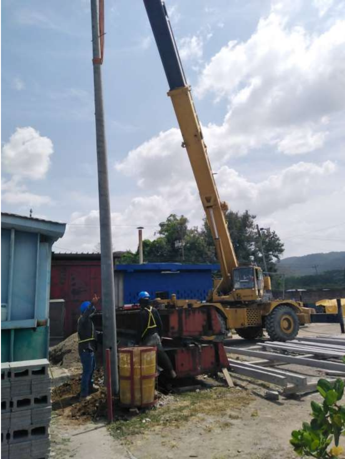
Anexo 11- Hincado de Poste Centrifugado
