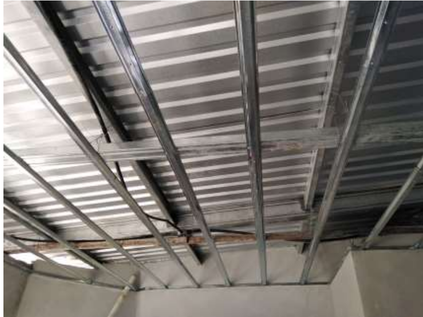
Anexo 3- Estructura de fijación de tabla yeso
