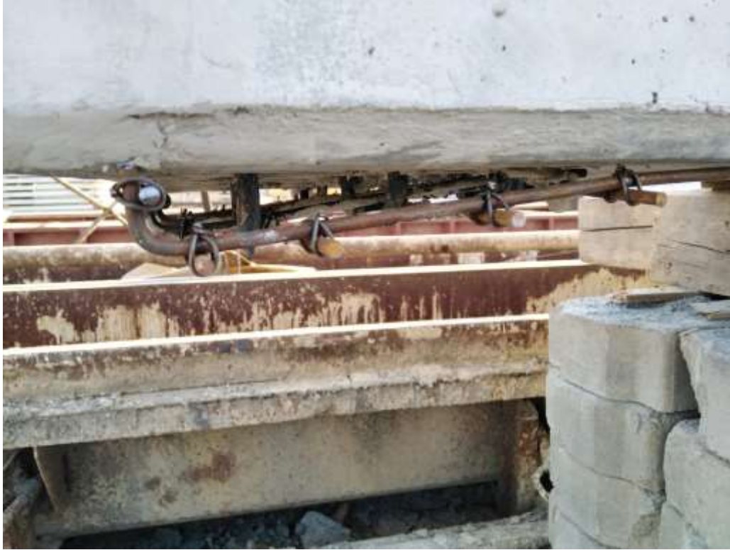
Anexo 10- Malla y "U" de refuerzo en tacones de apoyo
