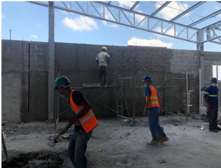
Ilustración 34. Repello de paredes segundo nivel
