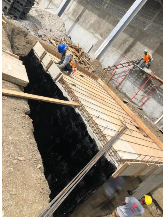
Ilustración 29. Impermeabilización de muros de cisterna
