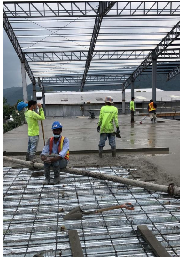
Ilustración 16. Fundición de losa entepiso
