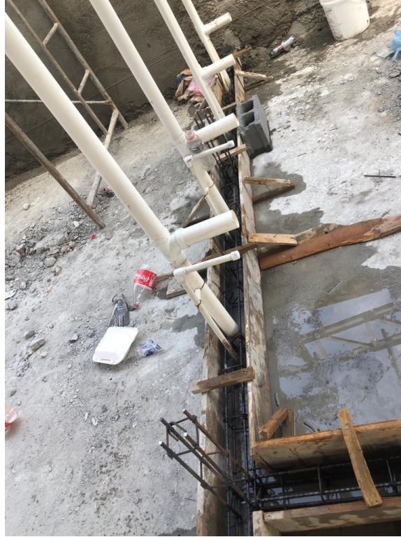
Ilustración 35. Encofrado de solera inferior en baños de segundo nivel
