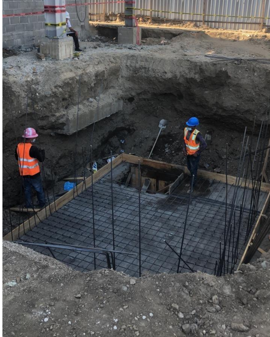
Ilustración 13. Encofrado y armado de acero en cisterna
