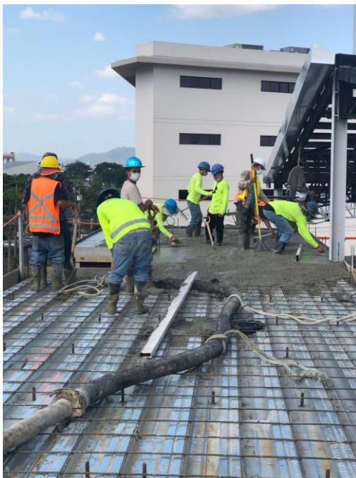
Ilustración 25. Fundición de losa entrepiso
