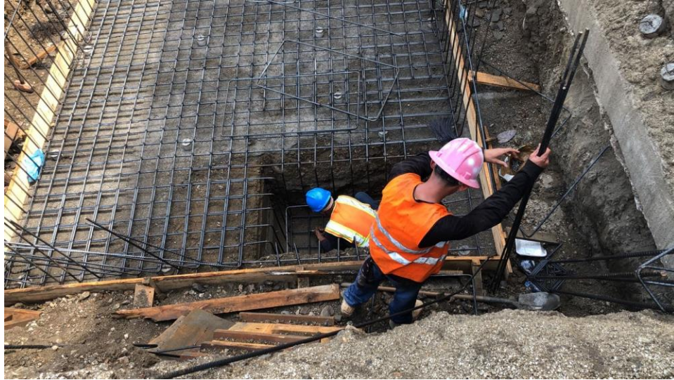
Ilustración 15. Armado de losa inferior y cárcamo
