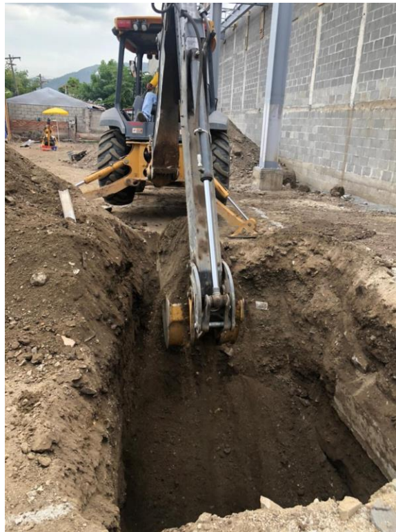
Ilustración 8. Excavación de cisterna
