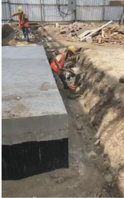
Ilustración 37. Relleno con material selecto en área de cisterna
