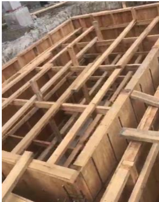
Ilustración 20. Encofrado de cisterna
