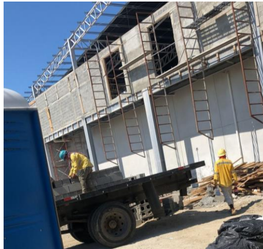
Ilustración 40. Carga de bloque de 8''
