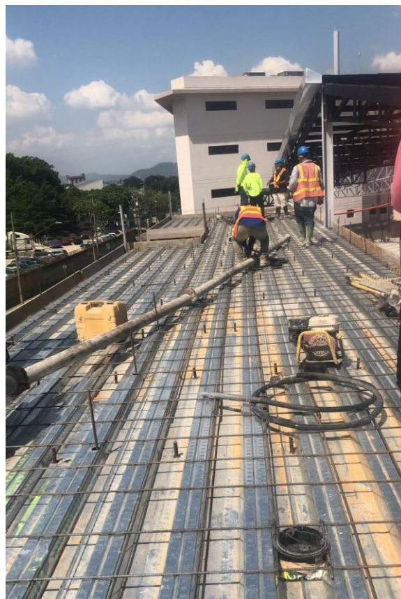
Ilustración 24. Losa de entepiso frontal
