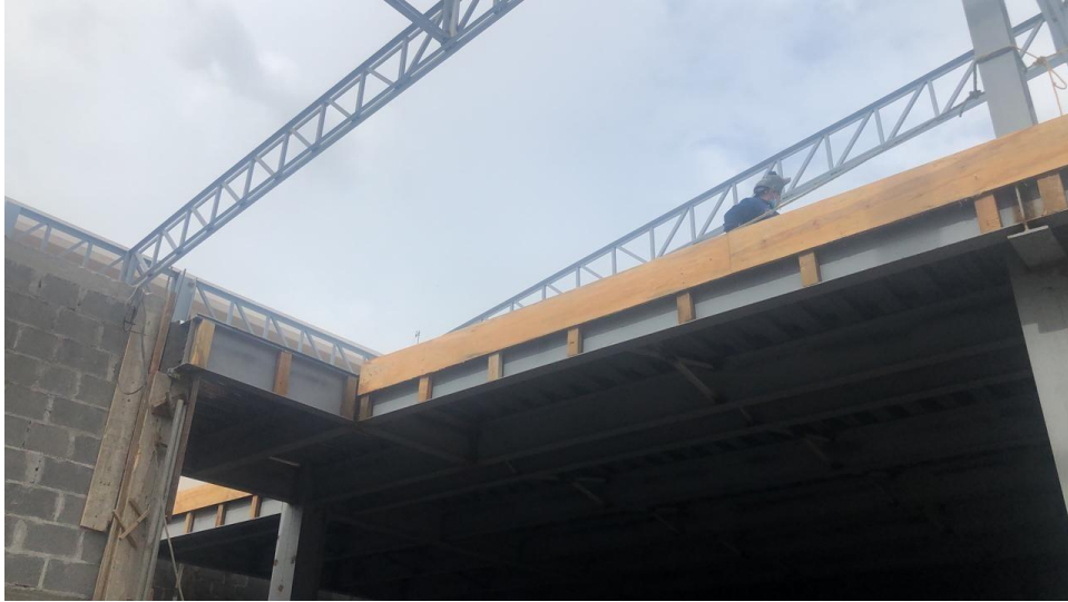
Ilustración 11. Instalación de madera para encofrado de losa acero
