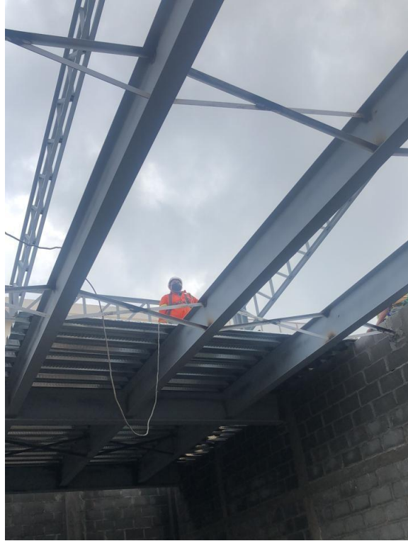
Ilustración 9. Instalación de lámina para losa acero
