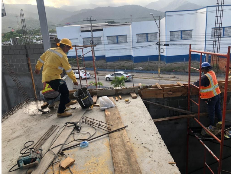
Ilustración 33. Fundición de solera inferior pared frontal
