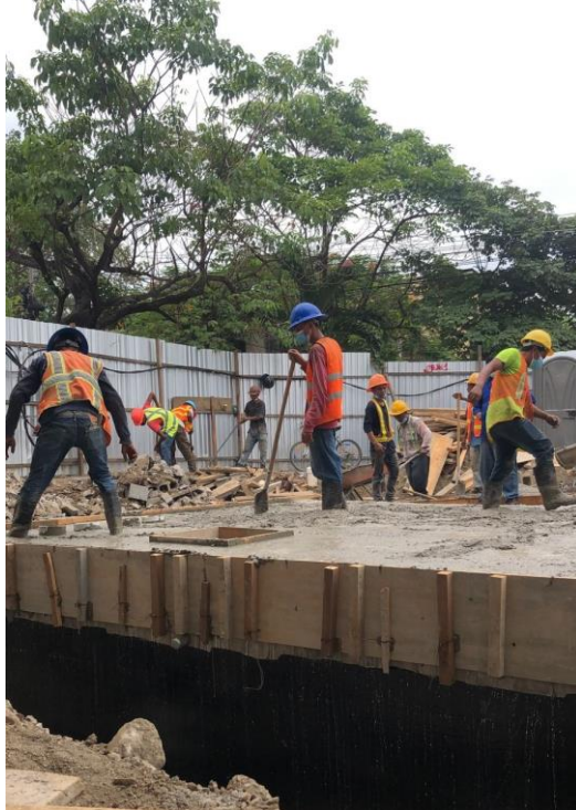
Ilustración 31. Fundición de losa superior de cisterna
