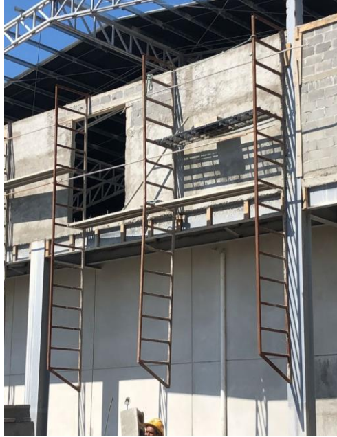
Ilustración 39. Colocación de guindolas
