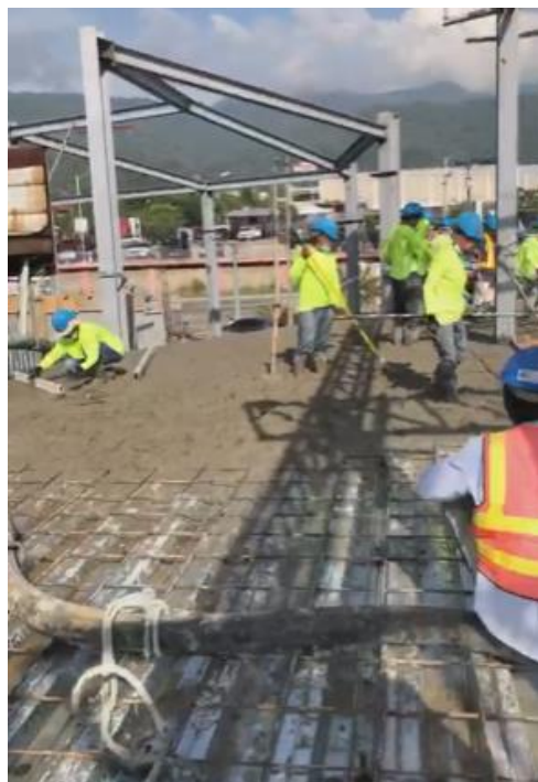
Ilustración 14. Fundición de entrepiso
