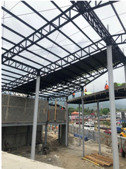
Ilustración 32. Instalación de vinil en techo
