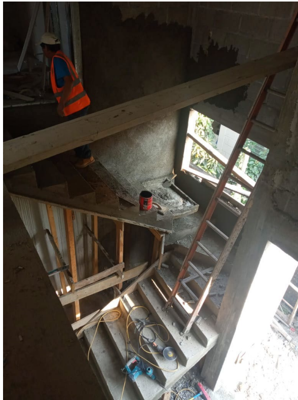
Ilustración 17. Avance escaleras Villa Valencia
