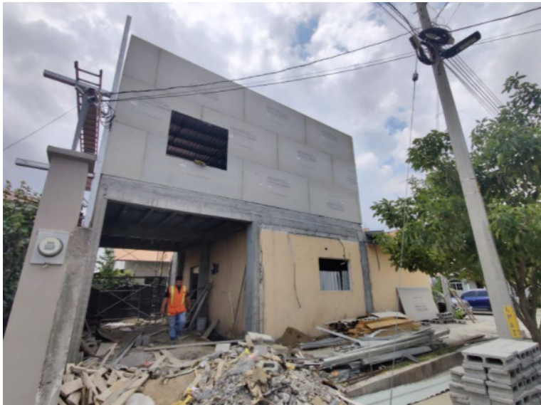
Ilustración 13. Avance de obra Villa Valencia
