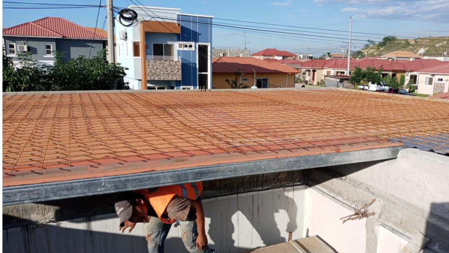
Ilustración 6. Armado de losa entrepiso Villa Valencia
