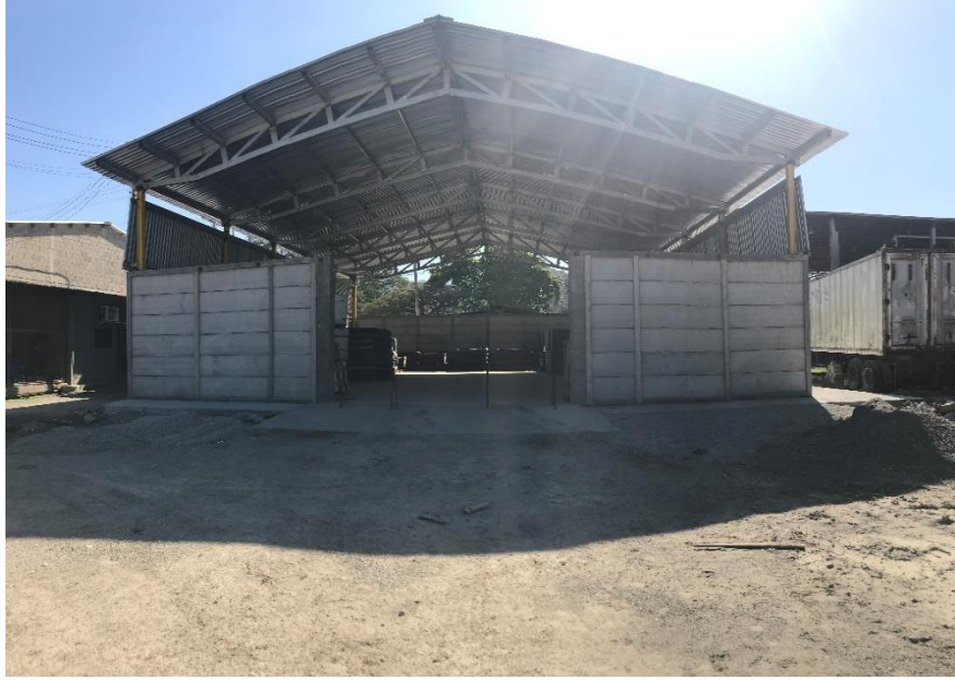
Ilustración 36-Culatas terminadas en Bodega de Almacenes y Compras
