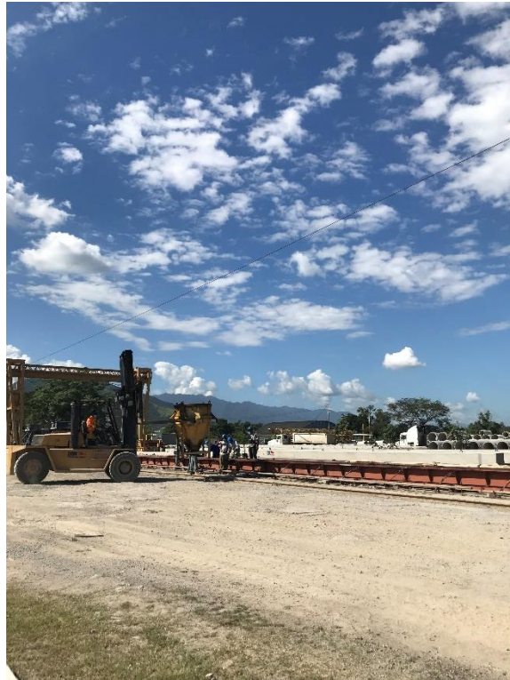
Ilustración 41-Carga de pilotes para despacho
