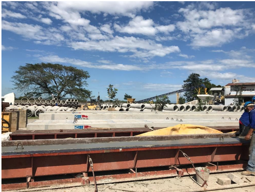
Ilustración 39-Pilotes 15A listos para despacho
