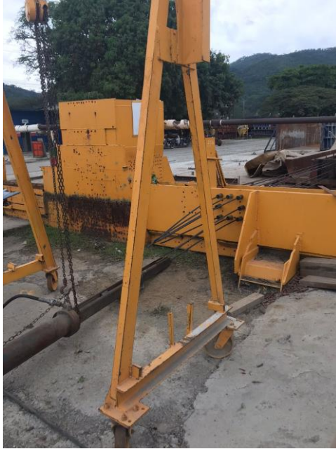
Ilustración 21 - Tensado de 8 Cables para Pilotes de 16m
