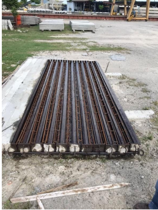
Ilustración 19 - Moldes de Columnas tipo B1
