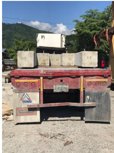
Ilustración 18 - Elementos rotulados para facilitar su identificación
