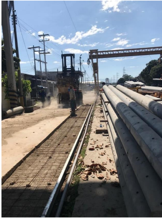
Ilustración 25 - Construcción de losa en el área de postes centrifugados
