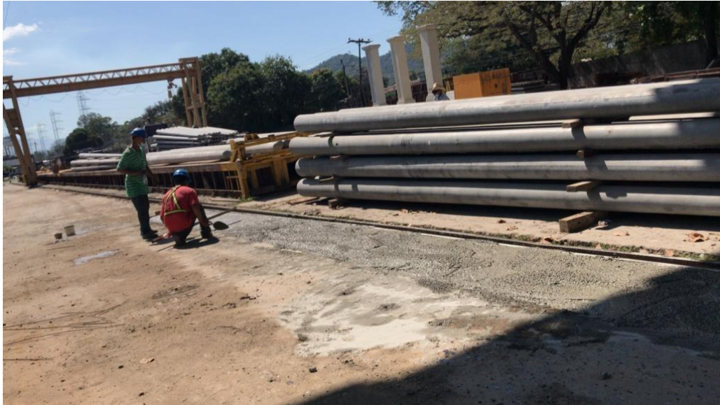
Ilustración 26 - Primera parte de la losa fundida
