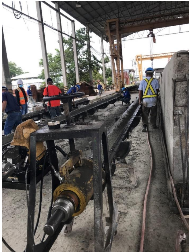
Ilustración 45-Preparación de Postes Centrifugados
