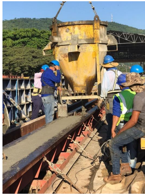
Ilustración 5-Fundición de pilotes con cubilete
