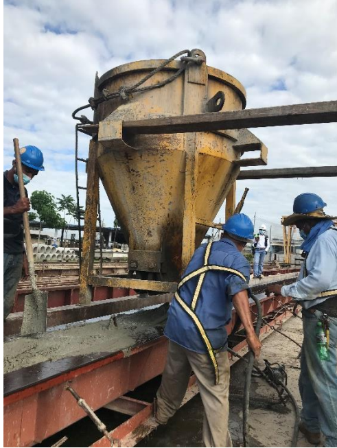
Ilustración 34-Fundición de Pilotes 15A y 15B
