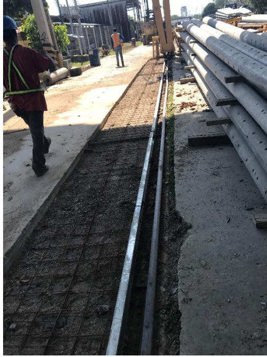
Ilustración 46-Fundición de acera en planta de Postes
