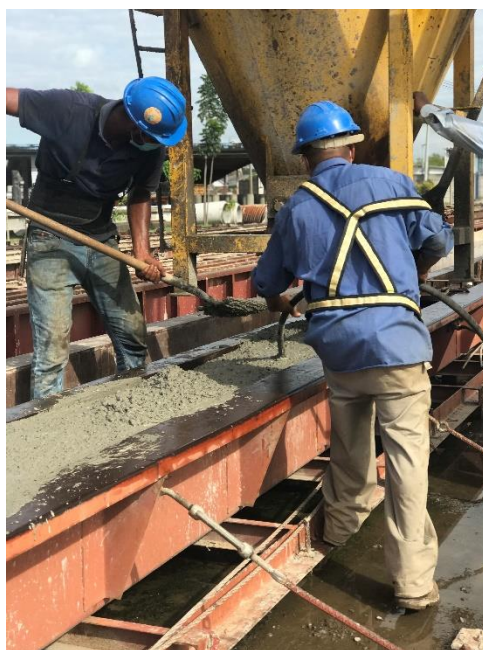
Ilustración 33-Fundición de Pilotes
