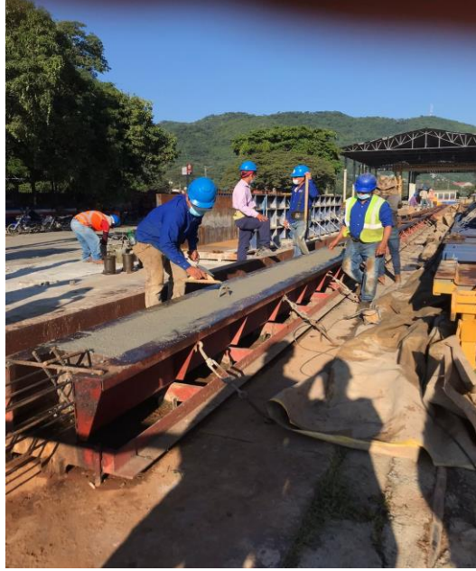
Ilustración 4-Repello de Pilotes
