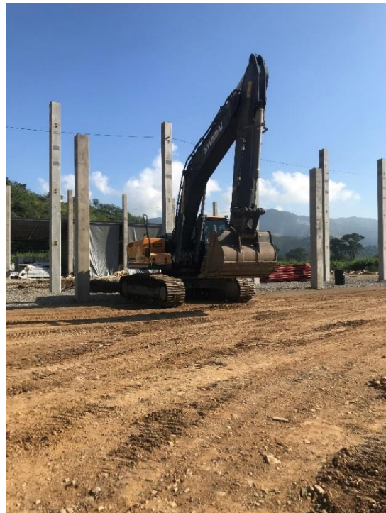
Ilustración 35-Zapatas en Bloquera "El Corbano"
