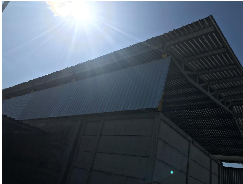
Ilustración 10-Culatas laterales instaladas en bodega
