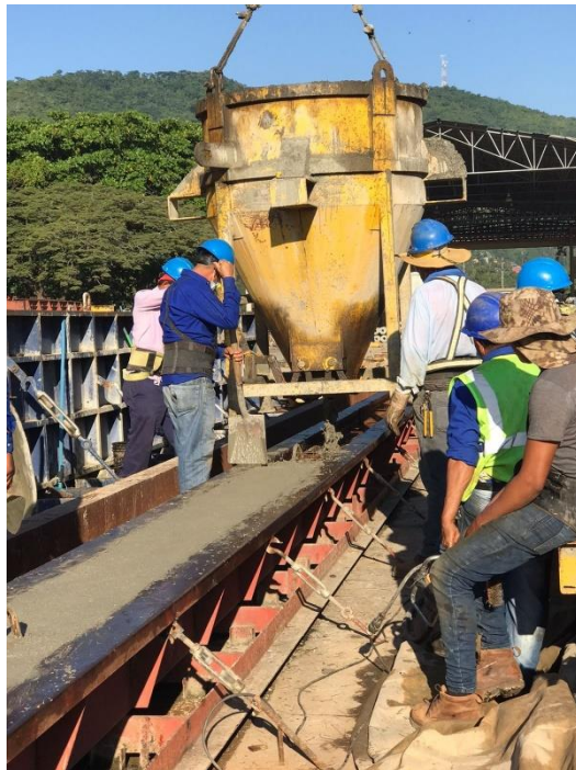
Ilustración 22 - Fundición de pilotes de 16m
