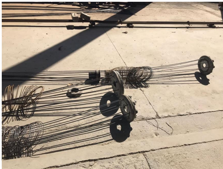
Ilustración 31 - Cable de 4mm utilizado para la preparación de los postes centrifugados
