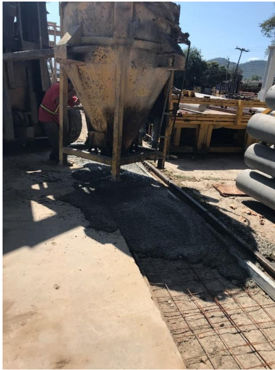
Ilustración 47-Fundición de acera en planta de Postes
