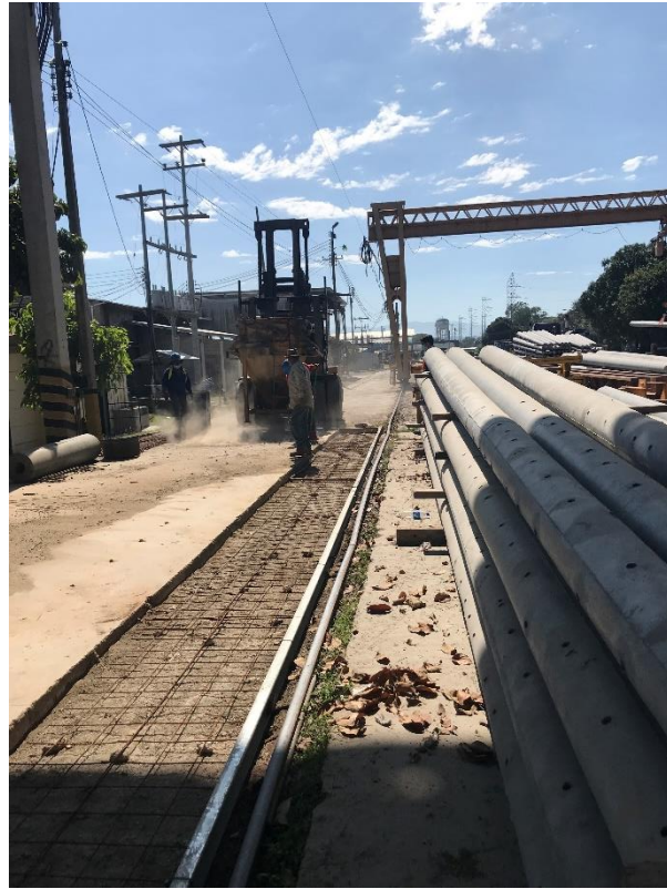
Ilustración 48-Fundición de acera en Postes- I Parte
