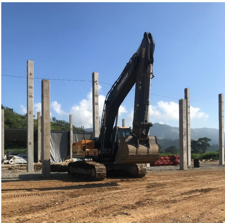
Ilustración 7-Cimentación en proceso
