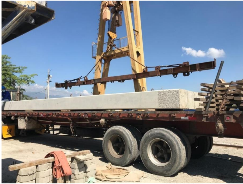
Ilustración 17- Entrega de Columnas debidamente cargada
