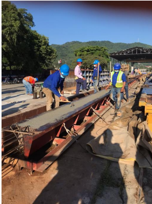
Ilustración 23 - Repello de Pilotes
