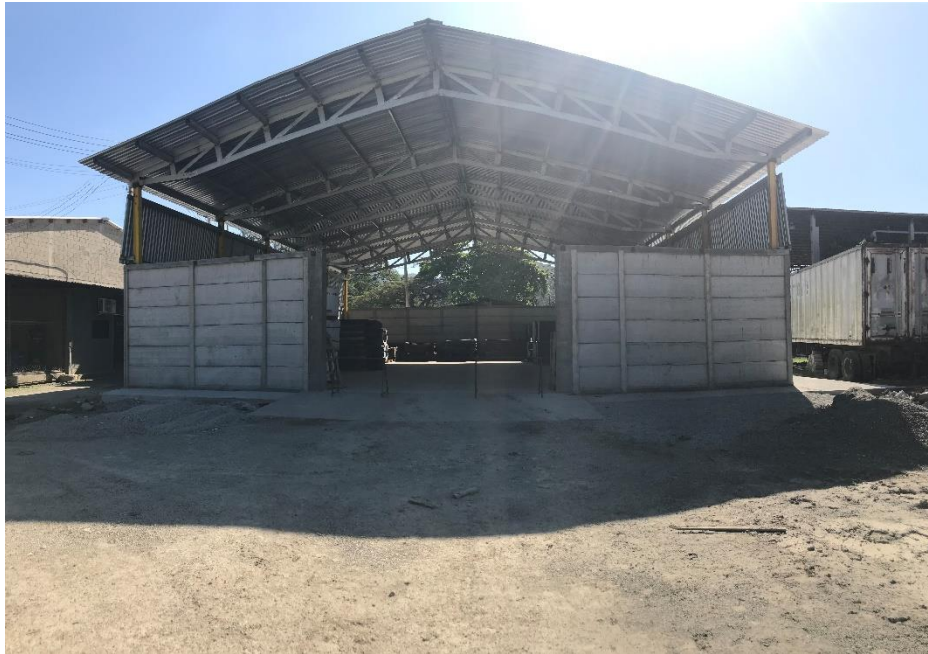
Ilustración 9-Remodelación de Bodega
