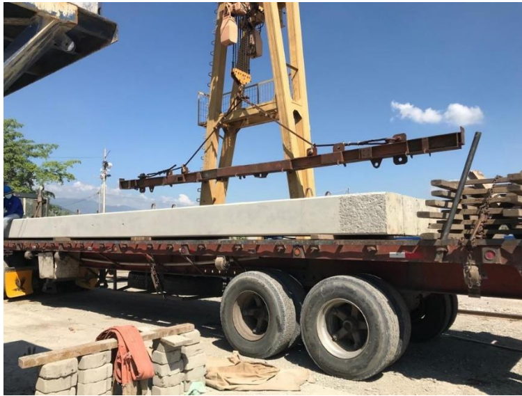
Ilustración 3-Columnas siendo cargadas en rastra
