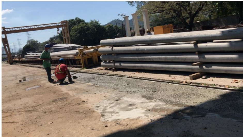
Ilustración 49-I Parte acera ya fundida
