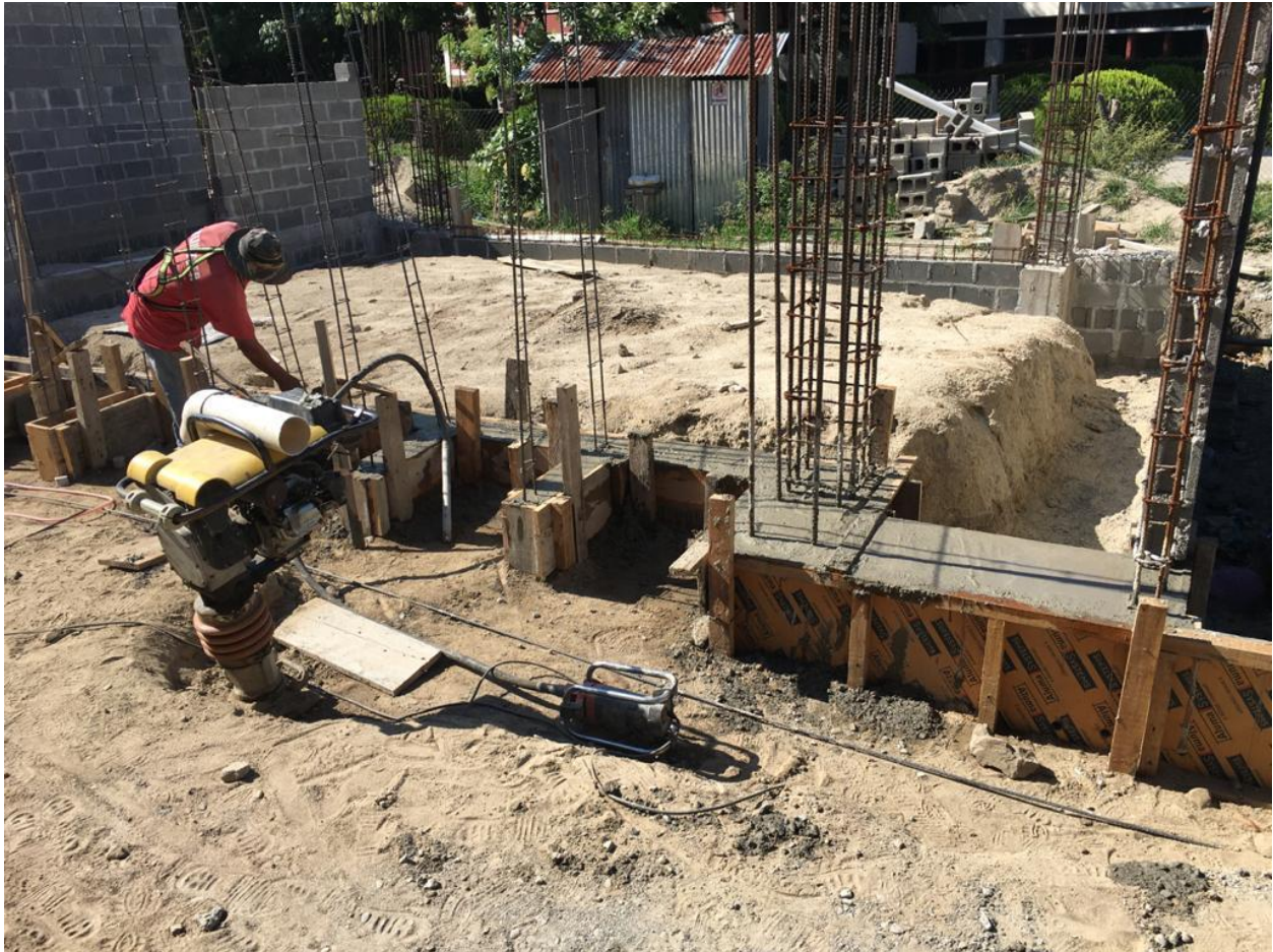
Ilustración 40-Fundido de la solera de cimentación del edificio anexo
