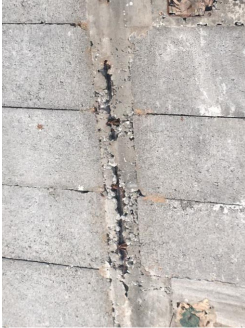
Ilustración 45-Canecheras en losa de entrepiso
