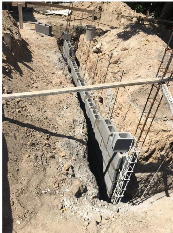
Ilustración 22-Sobrelevación de bloque de caseta de cuarto eléctrico
