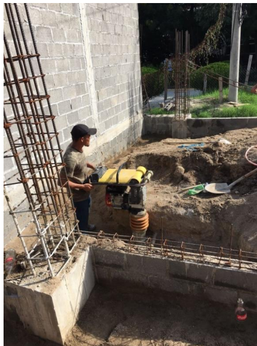
Ilustración 38-Compactado del relleno del edificio anexo
