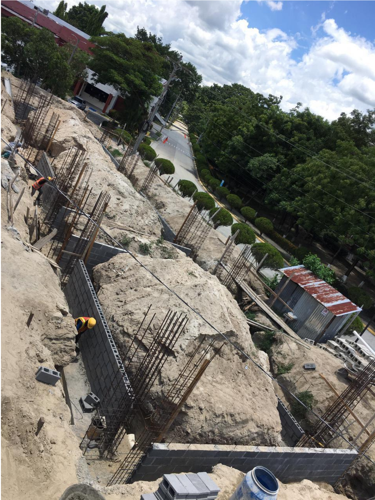
Ilustración 20-Sobrelevaciones de bloque desarrolladas en semana III
