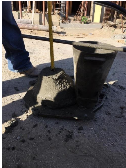
Ilustración 42-Prueba de revenimiento de concreto premezclado de 4000 psi
