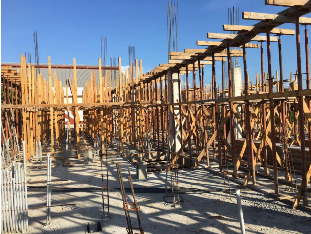
Ilustración 26-Piloteado del segundo nivel
