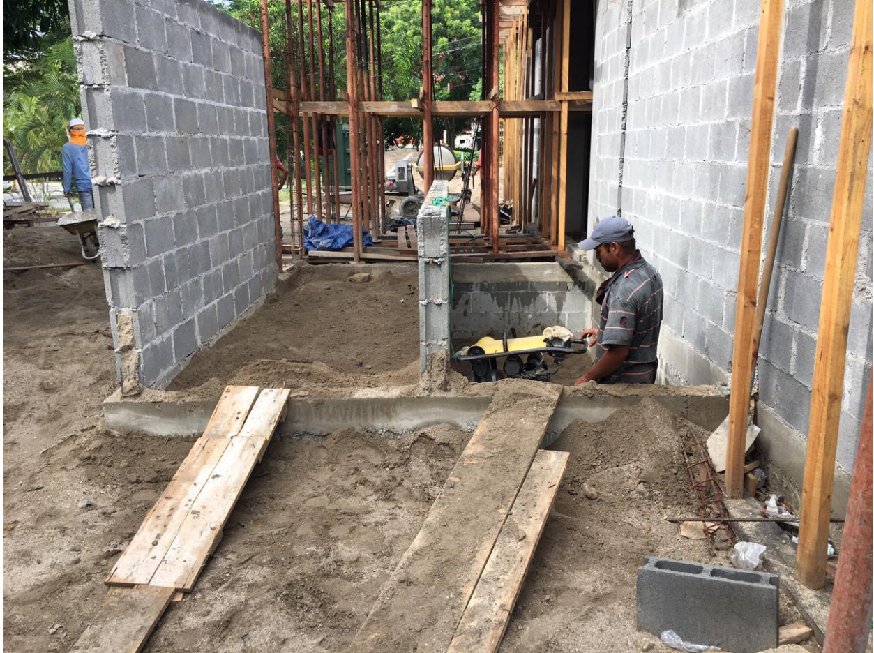
Ilustración 16-Relleno y compactado del cubo de escaleras
