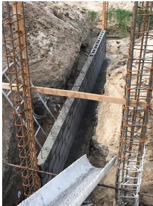
Ilustración 14-Sobrelevación de bloque de 6 sobre eje 52
