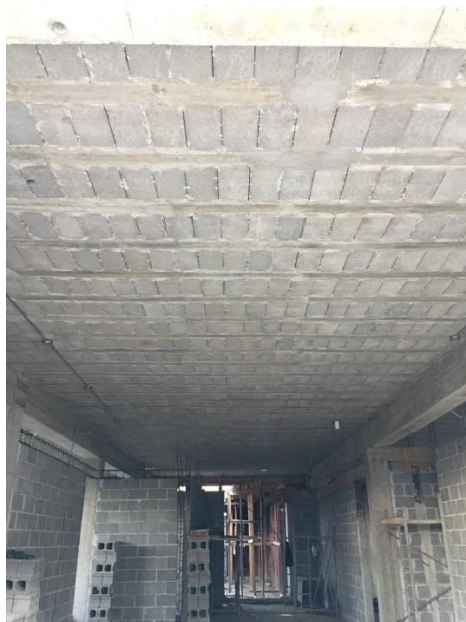
Ilustración 44-Acabado de la losa de entresiso
