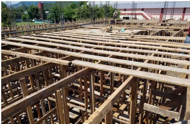
Ilustración 34-Molde inferior para nervios
