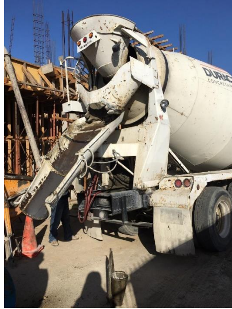
Ilustración 43-Camion con concreto premezclado de 4000 psi
