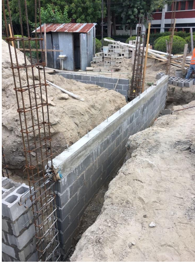
Ilustración 23-Sobrelevación de bloques del eje 24
