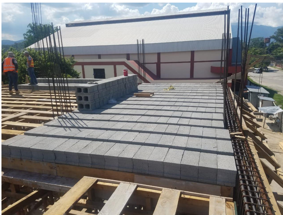
Ilustración 35-Colocado de bloque de 8" sobre fondo de nervios
