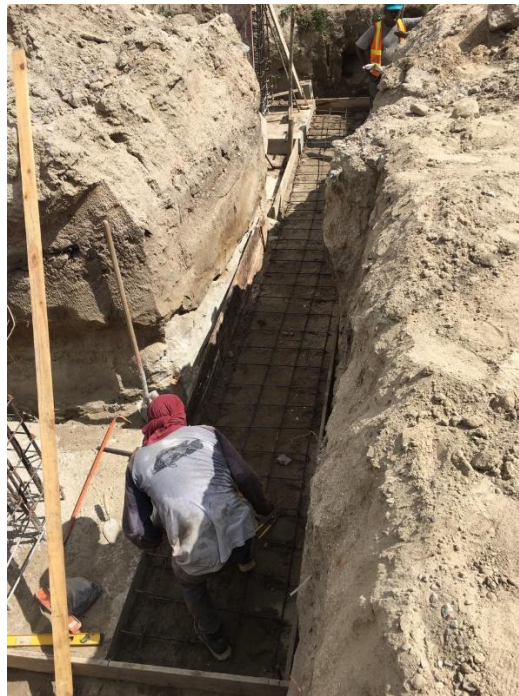
Ilustración 10-Encofrado de Zapata corrida junto a su armado de acero
