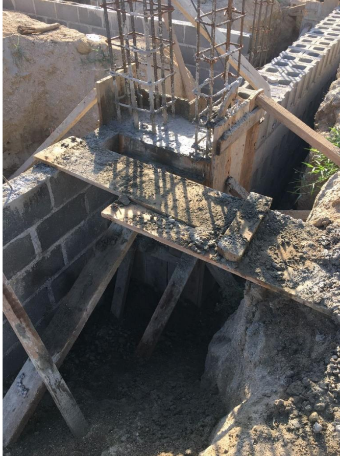
Ilustración 24-Pedestal de cimentación entre ejes 43-45
