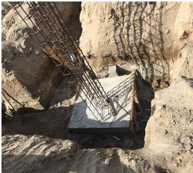
Ilustración 4-Zapata Aislada
