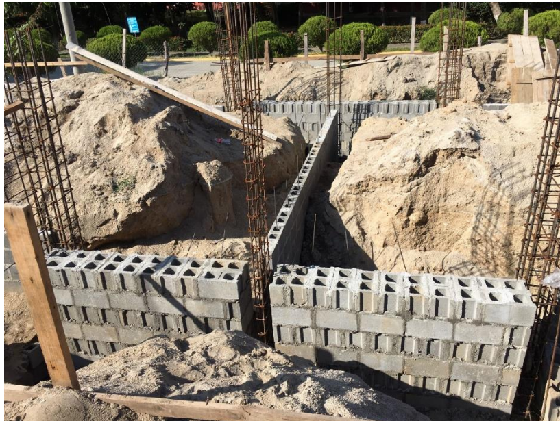
Ilustración 25-Bloque a tizón sobre ejes A y D
