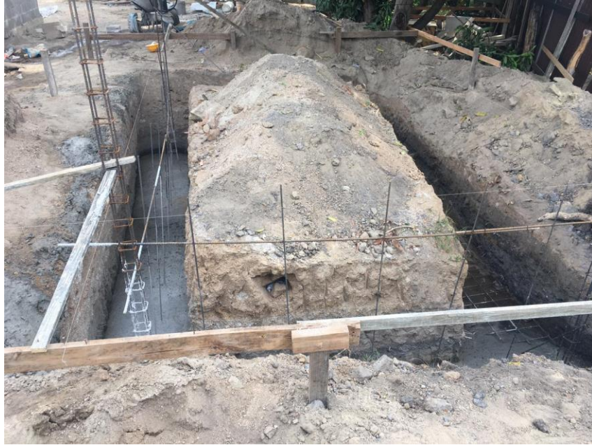
Ilustración 21-Fundición de Zapata corrida en caseta de cuarto eléctrico
