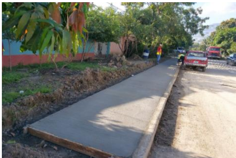
Ilustración 10 - Fundición de aceras
