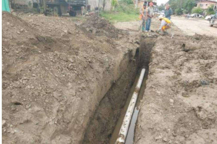
Ilustración 13 - Cambio de tubería
