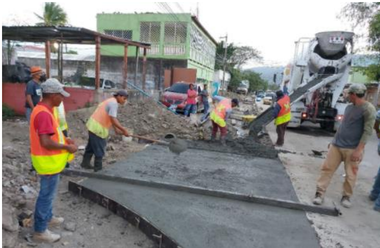
Ilustración 11 - Fundición de accesos
