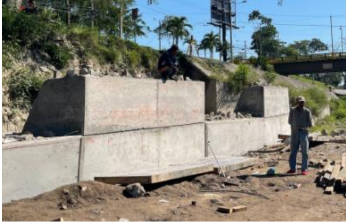
Ilustración 6 - Muro de Contención Los Alpes
