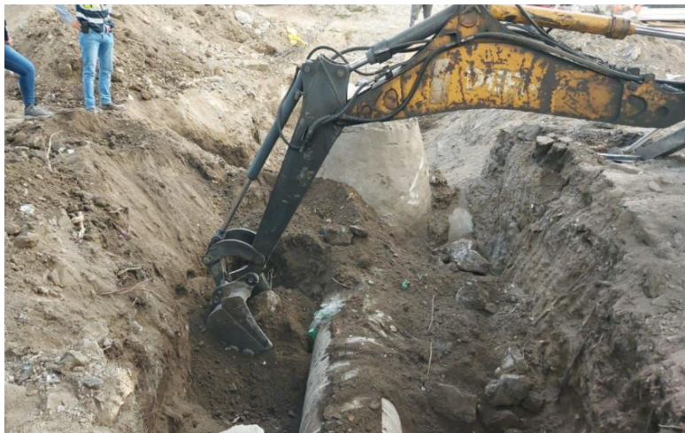
Ilustración 7 - Excavación canal de aguas lluvias
