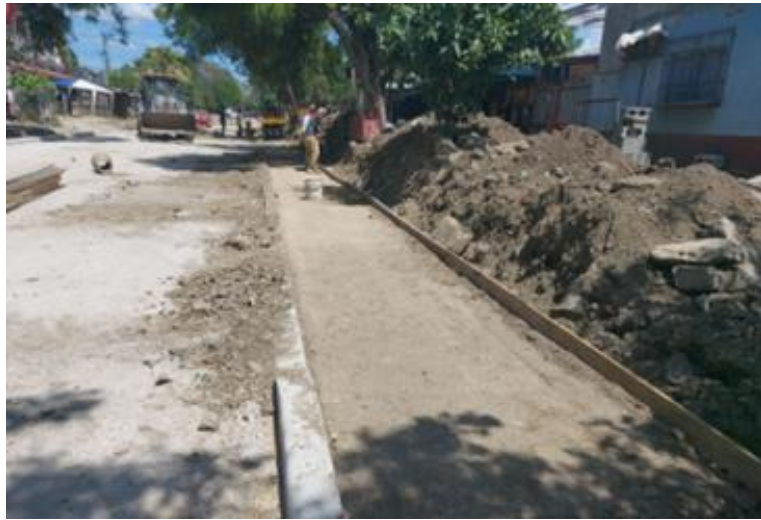
Ilustración 9 - Conformación de aceras
