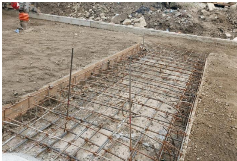
Ilustración 8 - Nivelado de Canal de aguas lluvias
