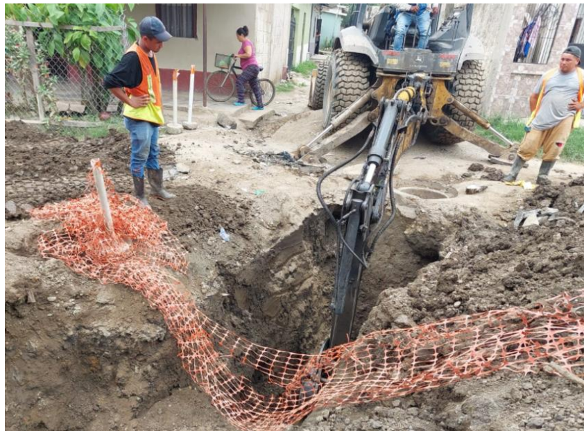
Ilustración 5- Colocación de Tubería de 8" en 4ta Ave.
