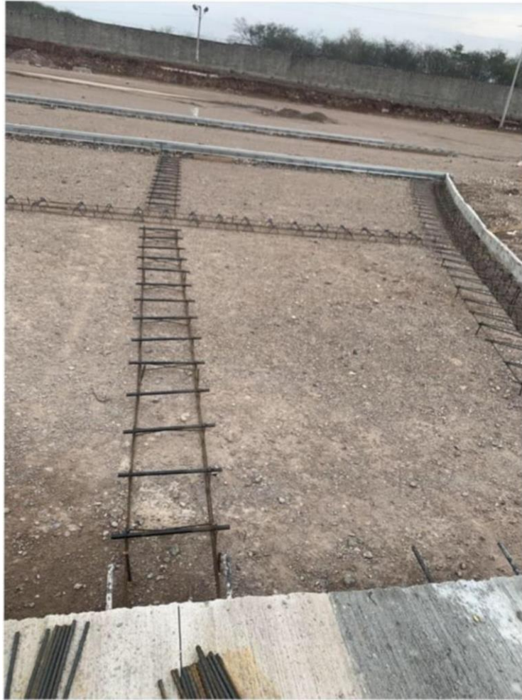
Figura 4. Colocación de dovelas
