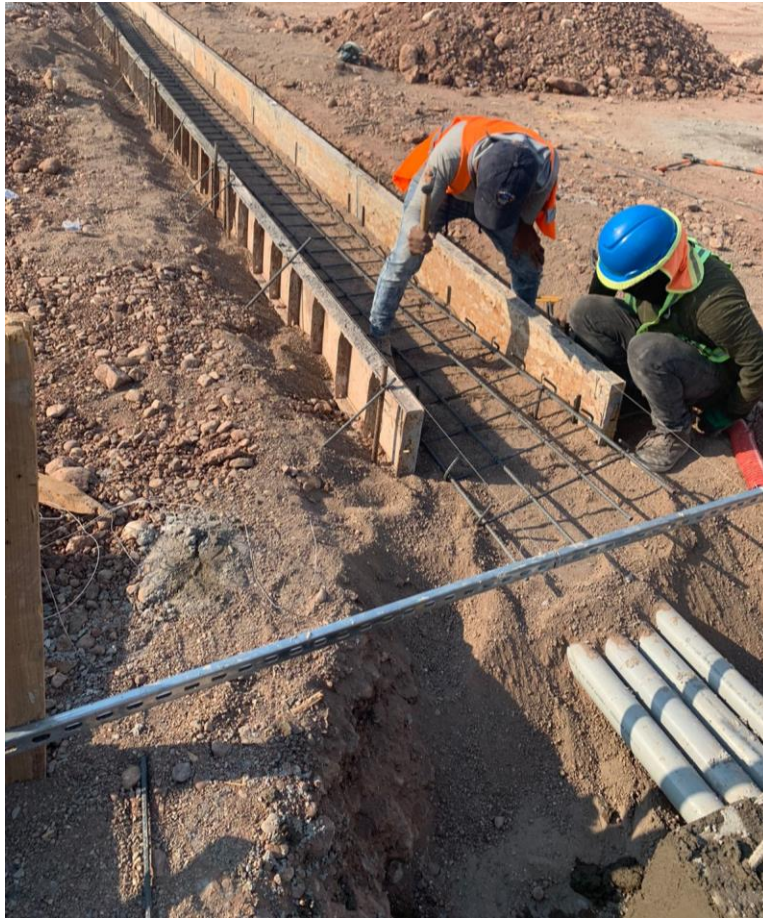
Figura 1. Armado del acero en cimentación
