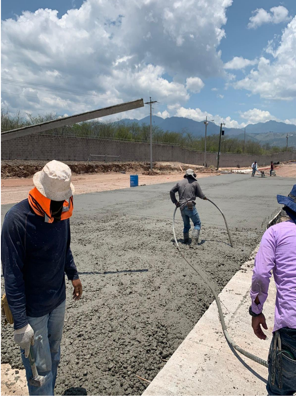
Figura 6. Fundición de losa de pavimento
