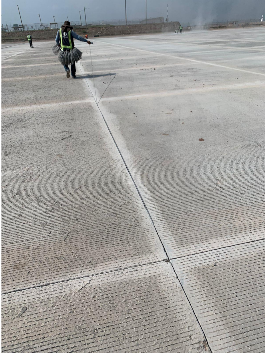
Figura 7.. Juntas en losa de pavimento
