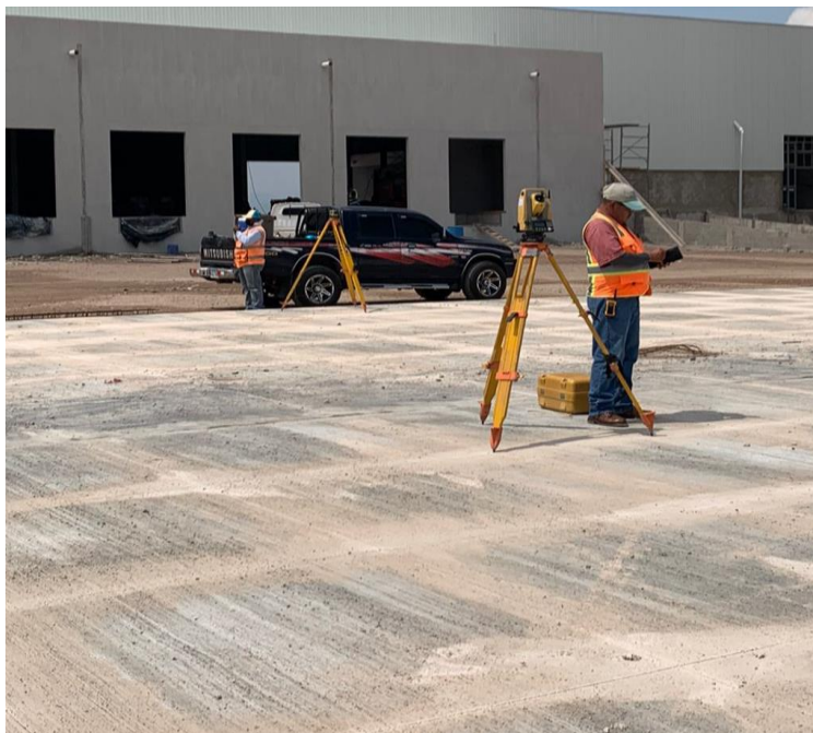
Figura 2. Marcaje topográfico con estación total.
