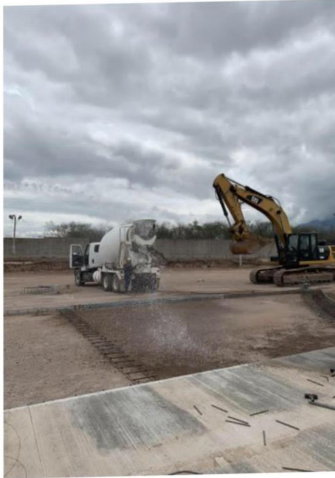
Figura 5. Riego con camión distribuidor de agua
