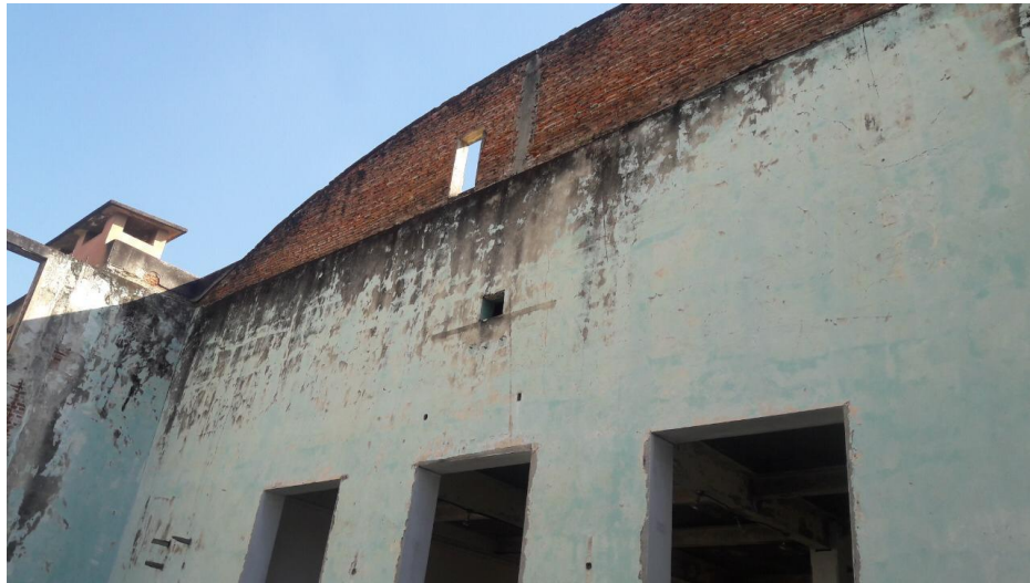
Ilustración 11- Arco ladrillo sobre pared final de vestíbulo
