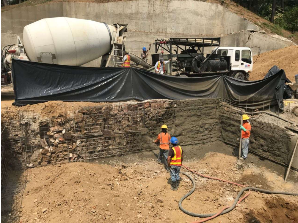
Figura 5. Lanzado de concreto (shotcrete).
