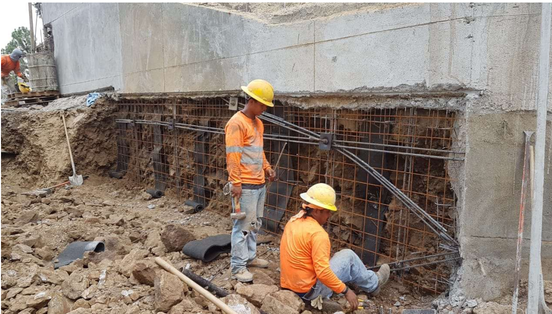
Figura 20. Conexión de muro B4 con muro B5.
