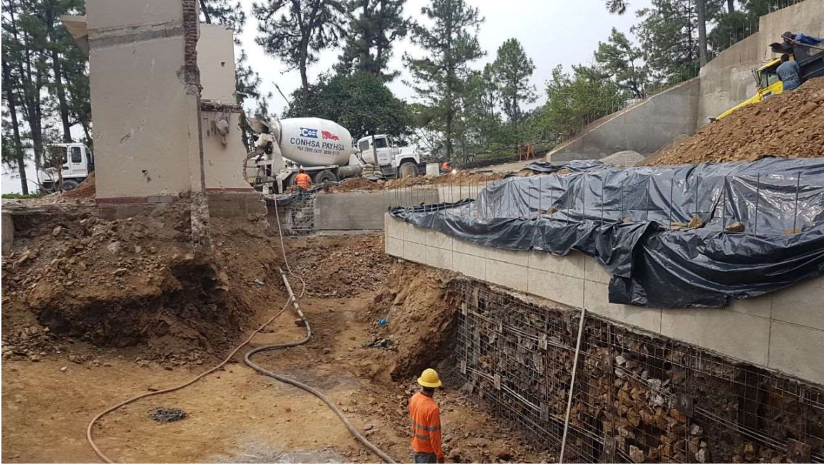
Figura 9. Protección de corona del muro contra posible lluvia.
