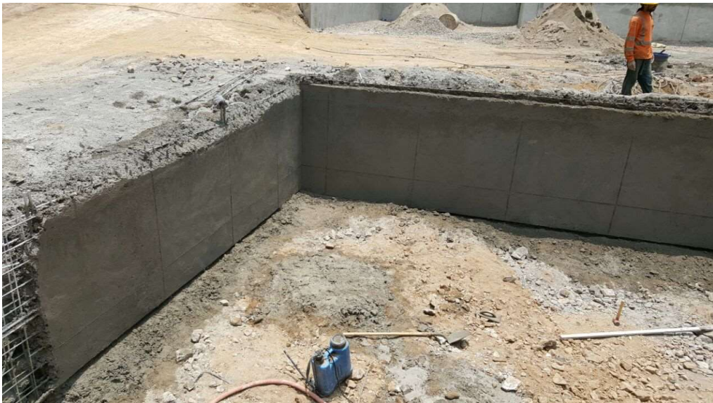
Figura 6. Codaleado y cisado de pantalla lanzada.
