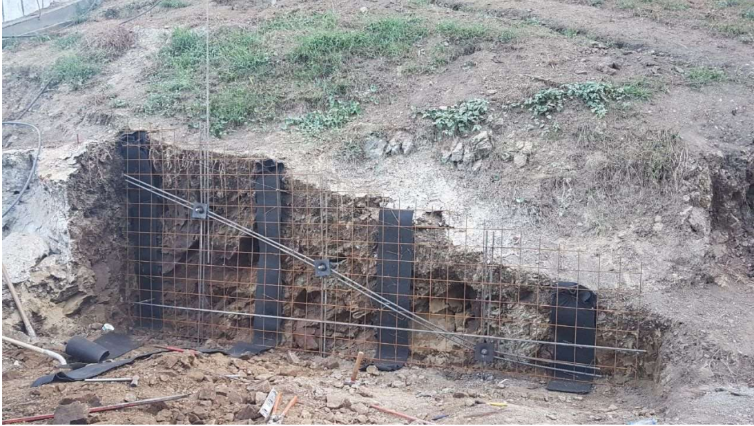
Figura 33. Sección de muro B4, lista para lanzado
