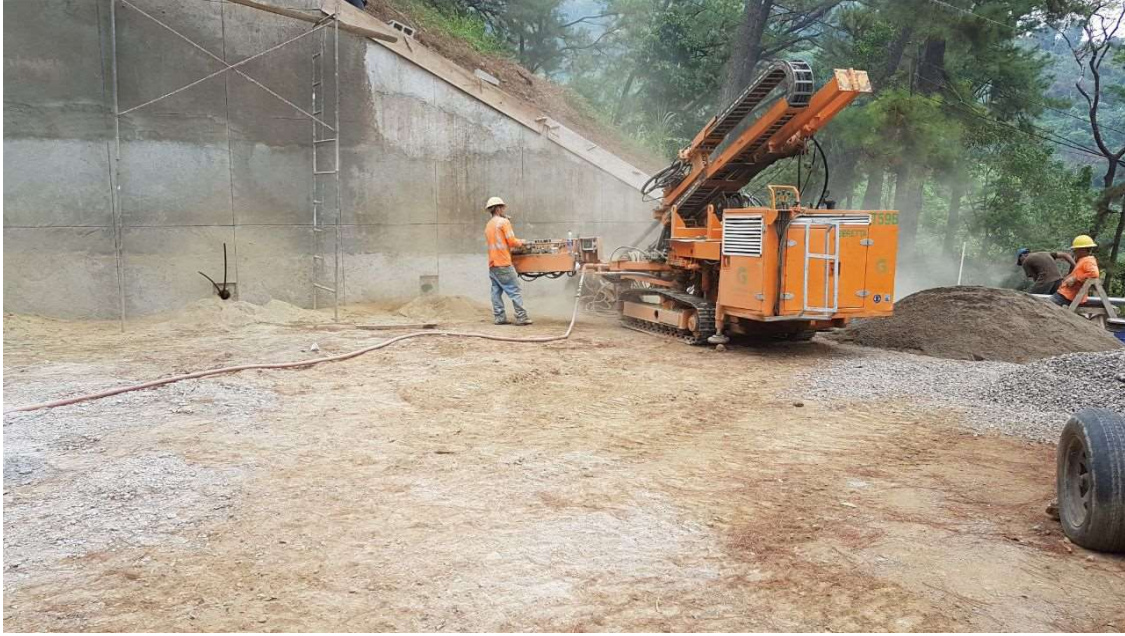
Figura 15. Perforación de anclajes de sección muro B6.
