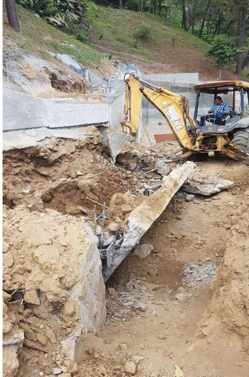
Figura 19. Demolición de sección de muro B4.
