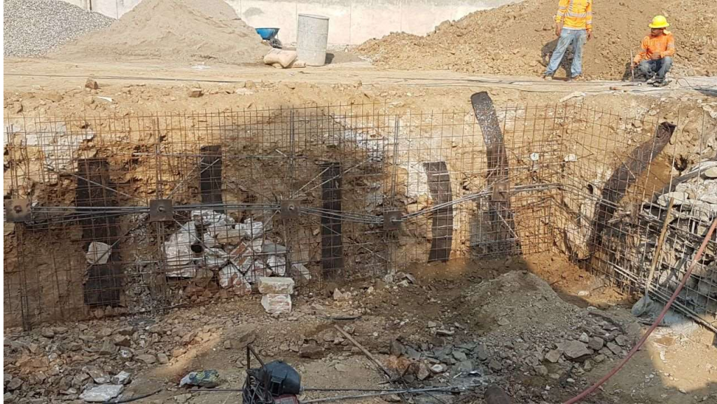
Figura 3. Armado de muro anclado, Muro C
