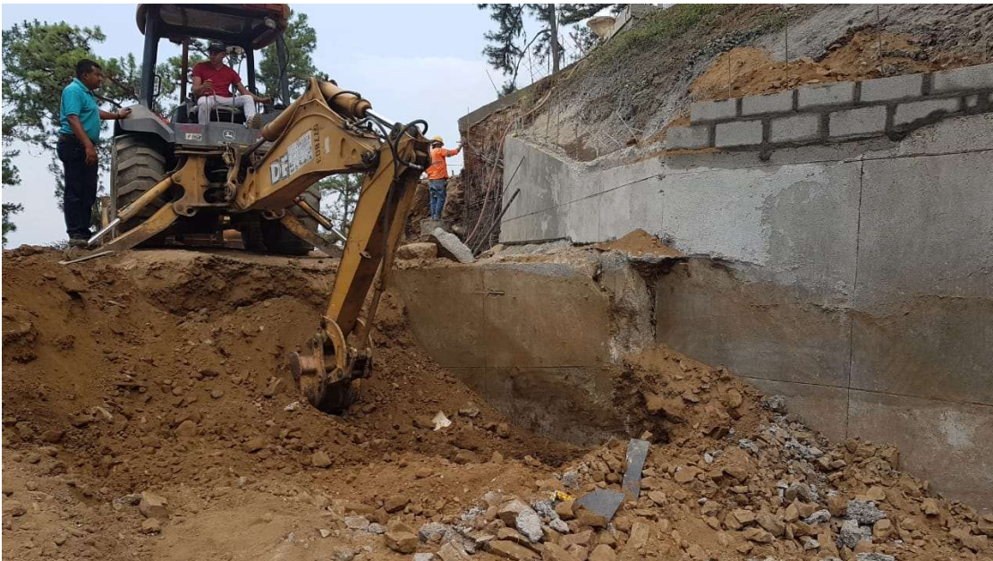
Figura 18. Demolición de sección de muro B4.
