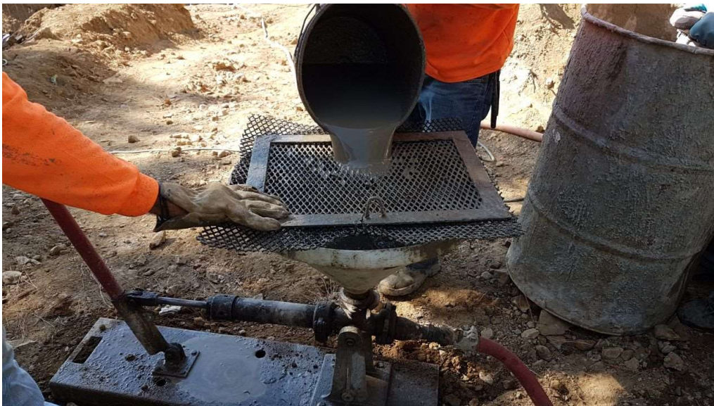
Figura 22. Inyección de lechada.
