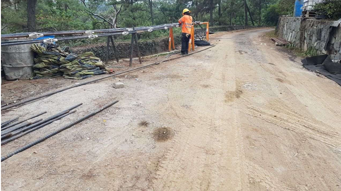
Figura17. Armado de anclajes de sección muro B6.
