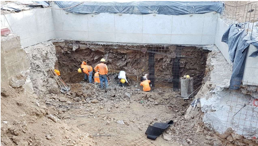
Figura 44. Preparación de sección muro c.
