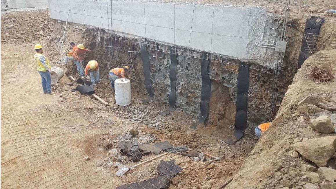
Figura 7. Perfilado, armado e inyección de muro anclado.
