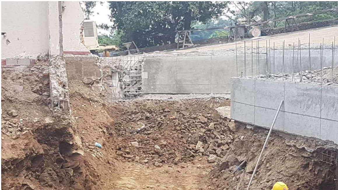
Figura 8. Corte y desalojo de material de corte.
