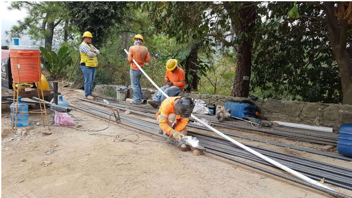
Figura16. Armado de anclajes de sección muro B6.
