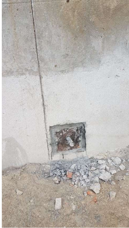
Figura 11. Colocación de anclaje con su placa.
