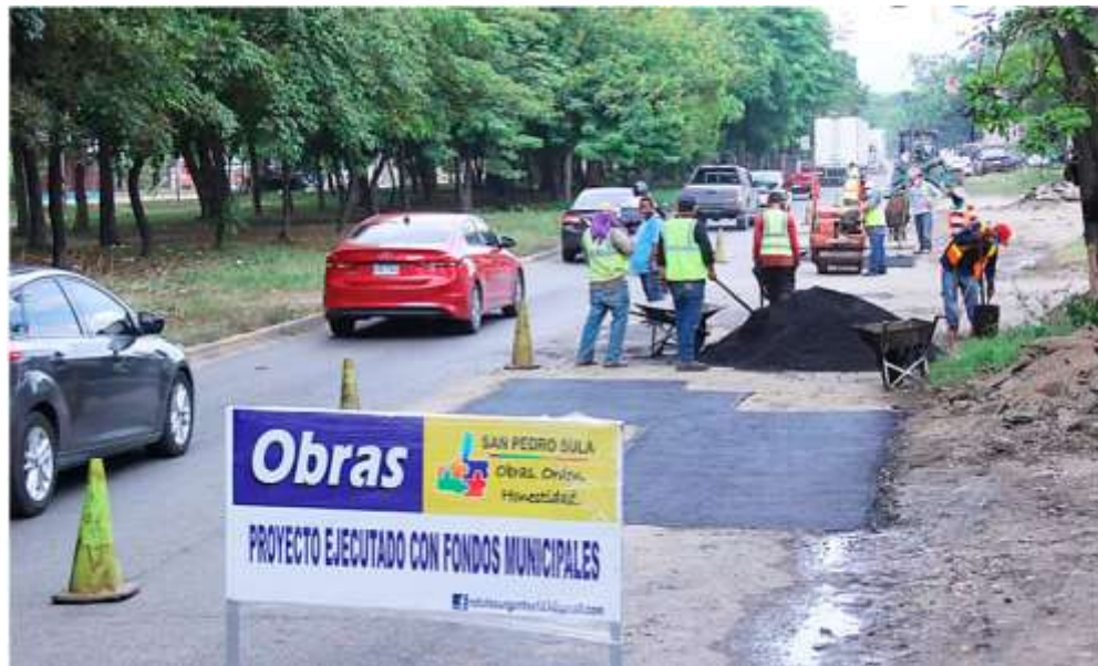
Ilustración 11- Reparación de tramo vial en San Pedro Sula
