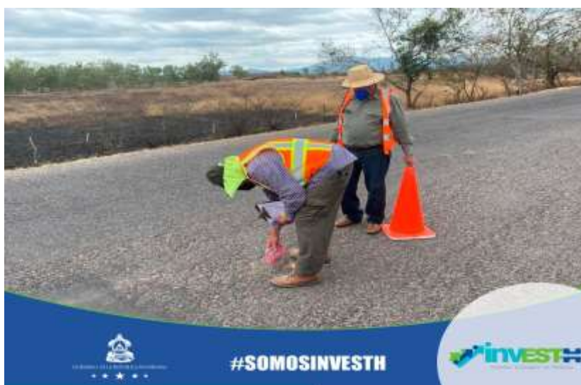
Ilustración 9- Reparación de pavimento INVEST-H
