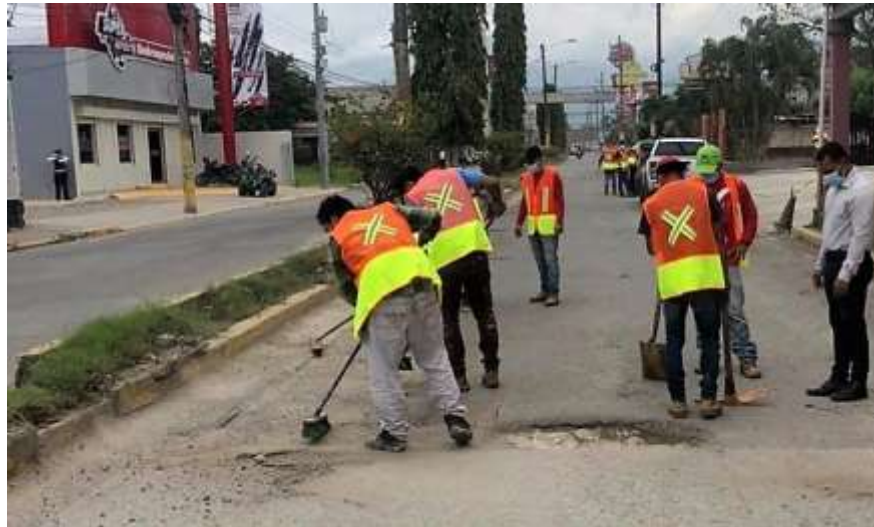
Ilustración 10- Bacheo realizado en la ciudad de El Progreso
