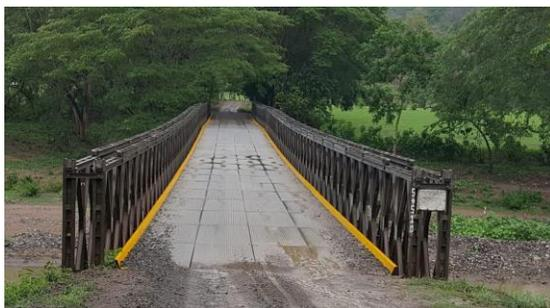
**Ilustración 1. Puente Provisional tipo Bailey Sobre el Río Grande de Otoro.**
