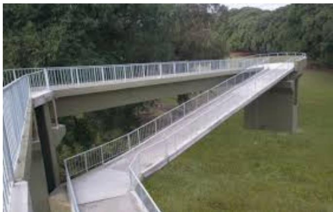
**SUPERESTRUCTURA:** Es la parte superior de un puente, que se construye sobre apoyos como son la losa, las vigas, bóveda, estructura metálica. Siendo los elementos estructurales que constituyen el tramo horizontal, que une y salva la distancia entre uno o más claros. Consiste en el tablero (losa) soporta directamente las cargas y las armaduras.; la superestructura está formada por dos partes:
