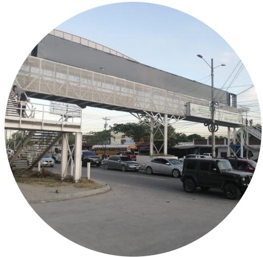
La estructura es completamente cerrada, se encuentra bastante oxidada y deteriorada. Parte de las gradas están destruida.
