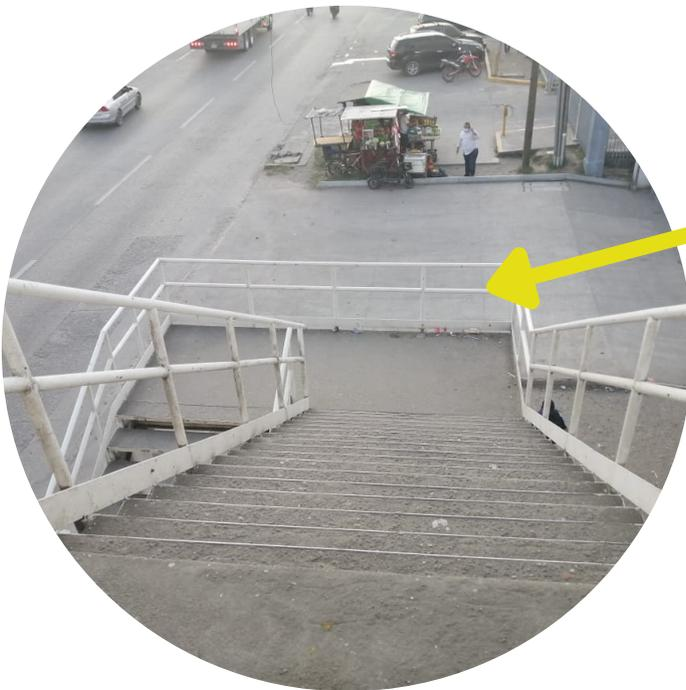
Hay un descanso de 4 m de longitud con un ancho de 1.80 m luego de 20 escalones y seguidamente otros 17 escalones hasta llegar al tablero.
