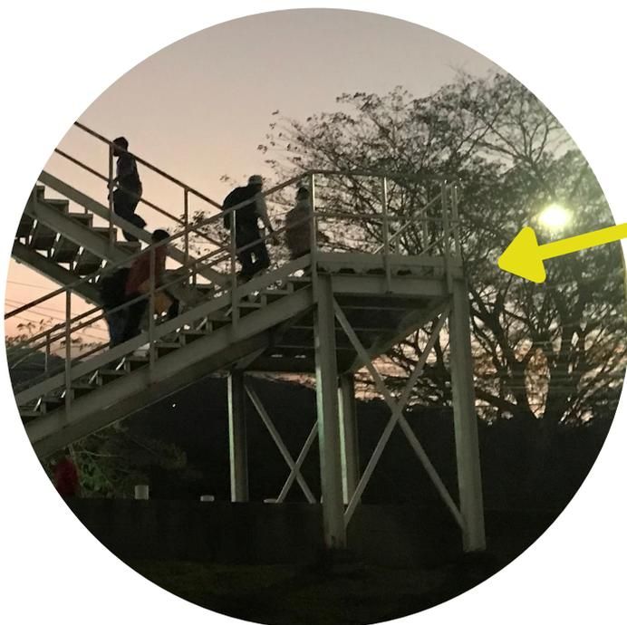
Hay un descanso de 4 m de longitud con un ancho de 1.65 m luego de 18 escalones y seguidamente otros 15 escalones hasta llegar al tablero.
