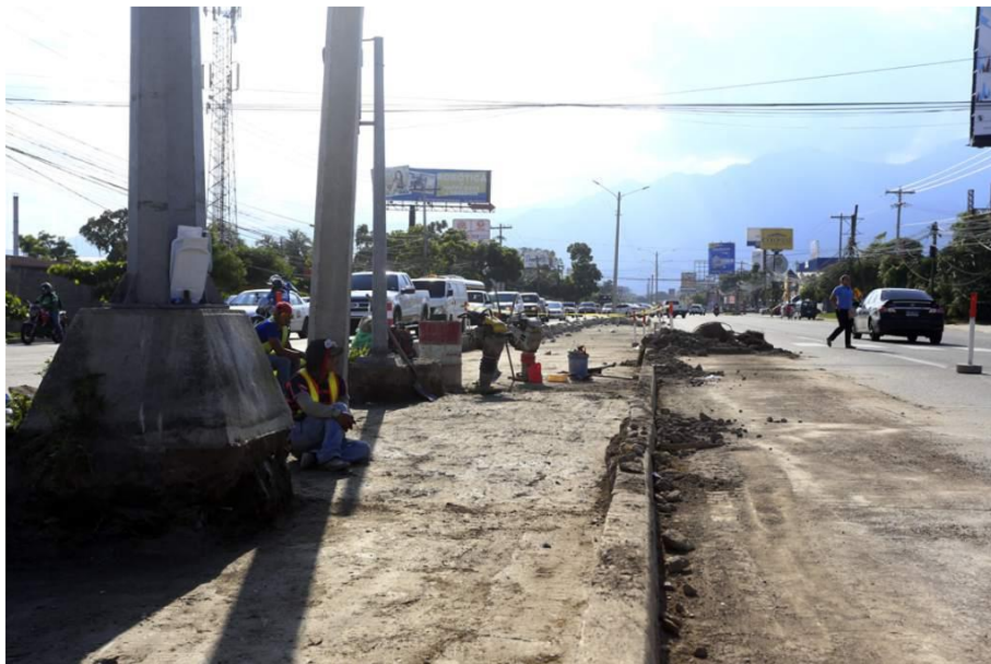
Anexo 4 Paso a desnivel bulevar del norte con acceso al Zapotal
