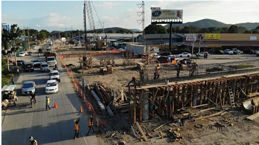
Anexo 5 Puente a desnivel 27 calle con bulevar del este
