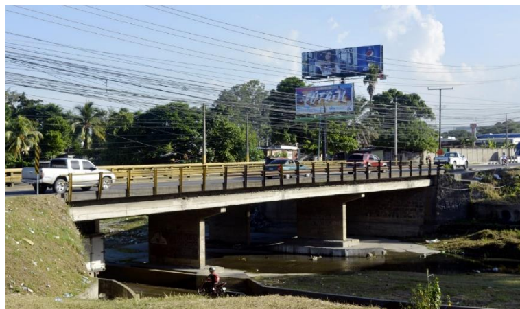
Ilustración 4 Puente de Rio Bermejo
