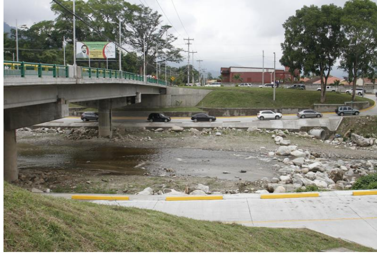
Ilustración 6 Puente Los Alpes
