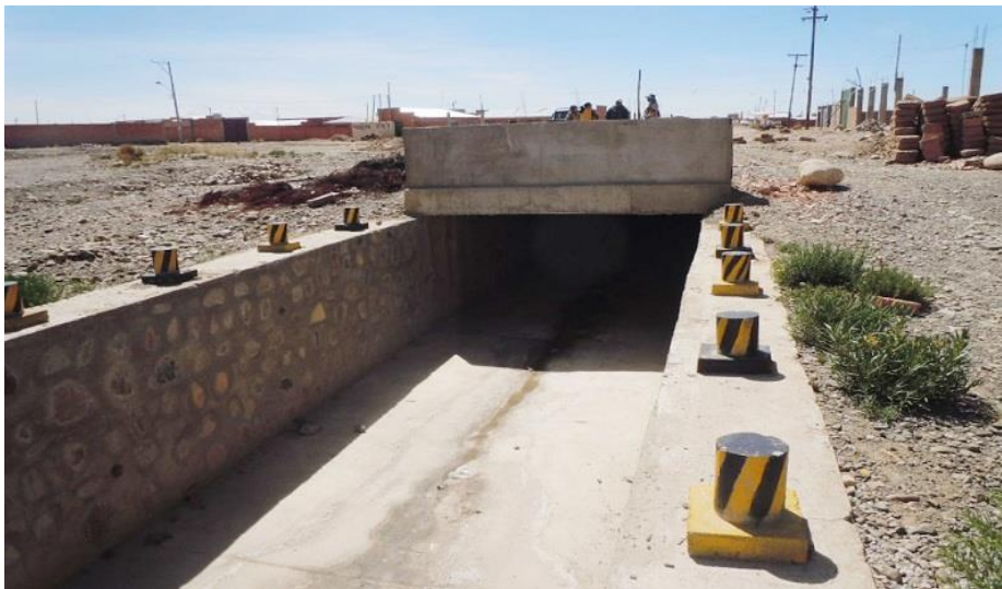
Ilustración 2. Construcción de drenaje pluvial en El Alto
