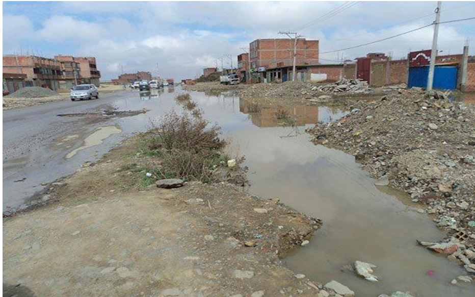
Ilustración 1. Inundación de calles en El Alto
