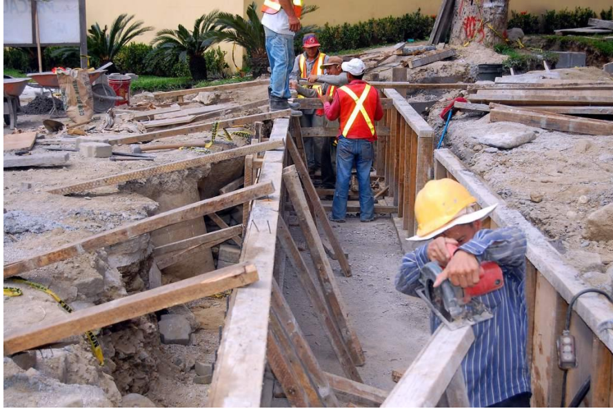
Ilustración 4. Pavimentación y construcción de colector de aguas lluvias
