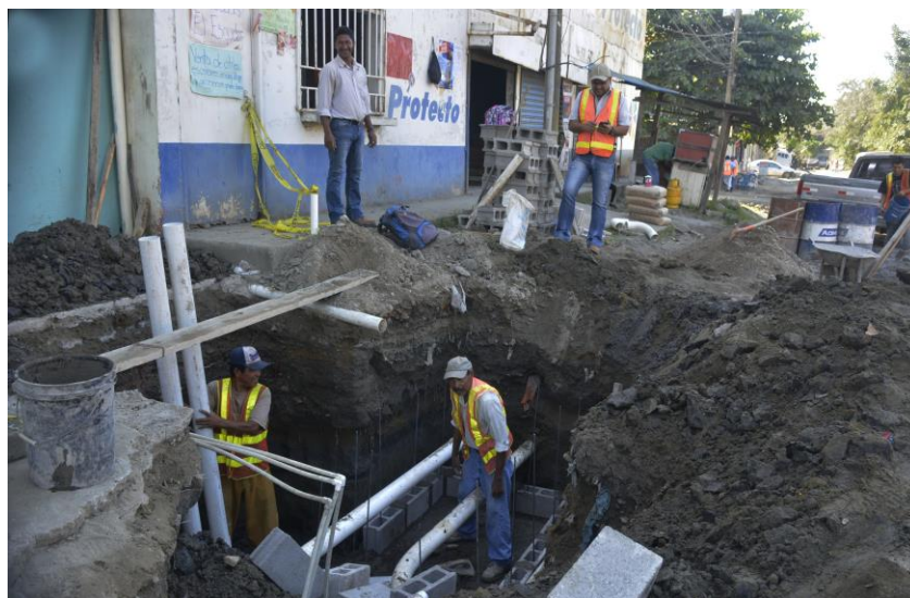
Ilustración 3. Construcción de colector de aguas lluvias
