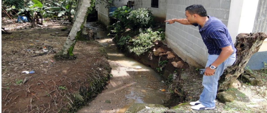
Ilustración 5. Embaulamiento de quebrada, Santa Cruz de Yojoa
